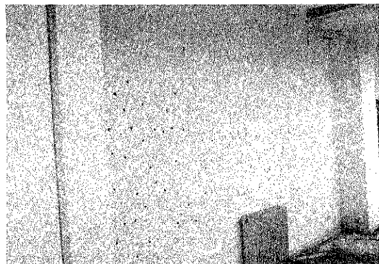
Sistema de reparación de fisuras con tapones, en unos muros que estaban plagados de fisuras de retracción.
