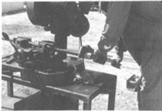
Foto 3. Puente del Centenario, en Sevilla. Manguito ERICO. Colocación del manguito.
