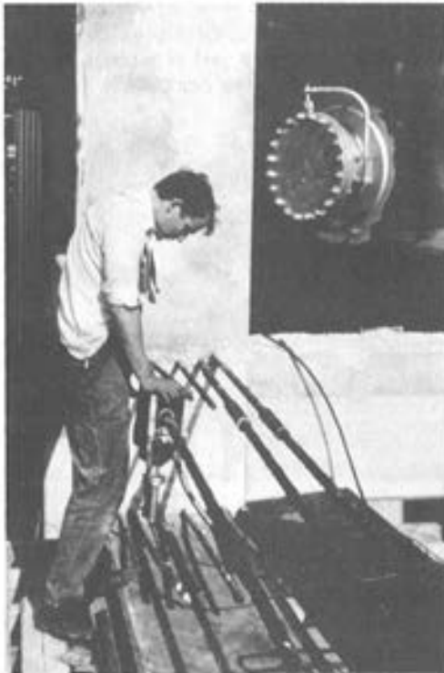
Foto 8. Manguitos ALCOR. Colocación en el tajo.
