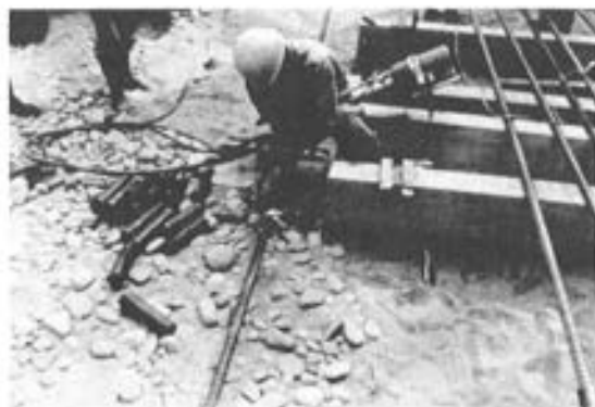
Foto 6. Manguitos ALCOR. Colocación a pie de obra.
