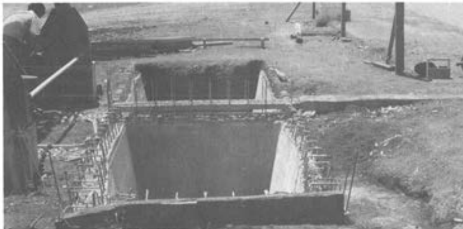
Continuación de la sección cajón del tramo en helicoide (brazo de estabilidad transversal) por debajo del terreno natural.
