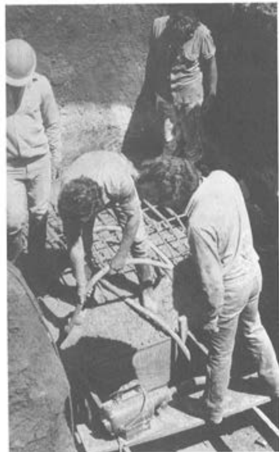
Hormigonado del brazo de estabilidad.
