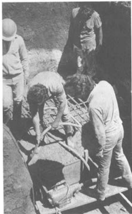
Hormigonado del brazo de estabilidad.
