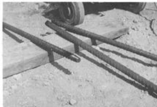
Foto 2. Puente del Centenario, en Sevilla. Extremo roscado.
