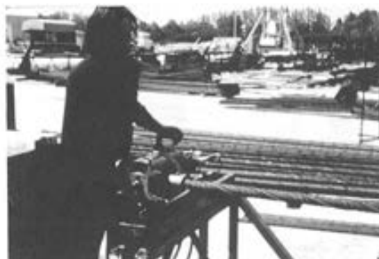
Foto 7. Manguito estampado. Colocación a pie de obra.
