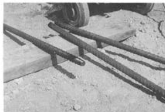
Foto 2. Puente del Centenario, en Sevilla. Extremo roscado.
