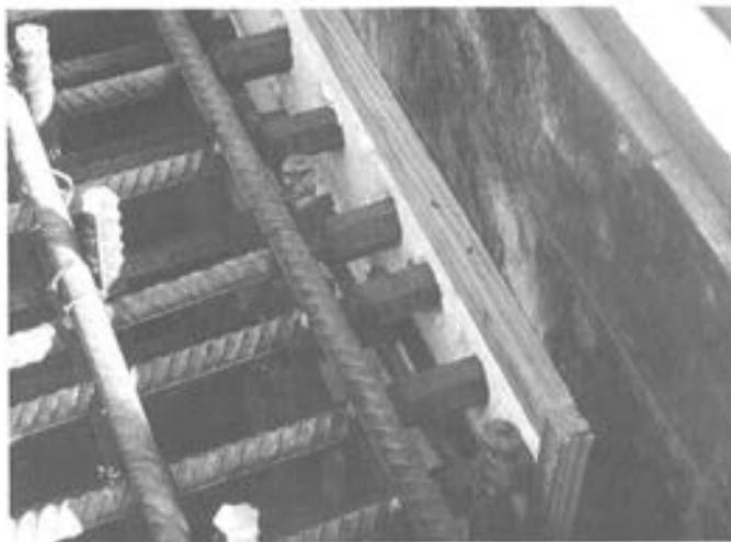
Foto 4. Puente del Centenario, en Sevilla. Encofrado.
