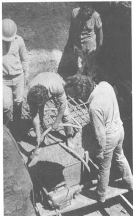
Hormigonado del brazo de estabilidad.
