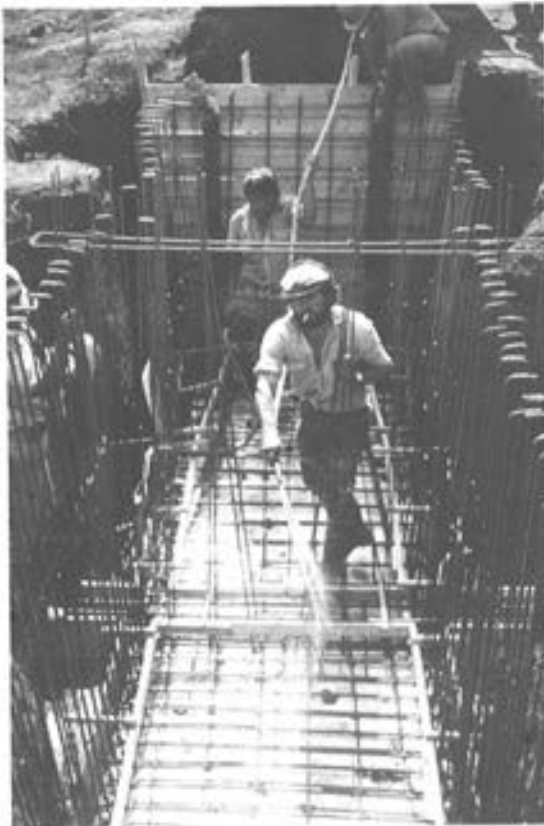
Etapa previa al hormigonado del brazo de continuidad de estabilidad transversal.
