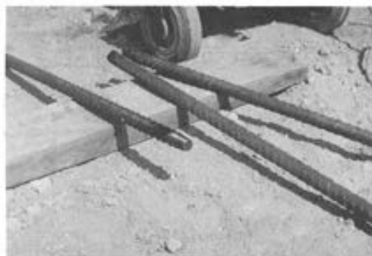
Foto 2. Puente del Centenario, en Sevilla. Extremo roscado.
