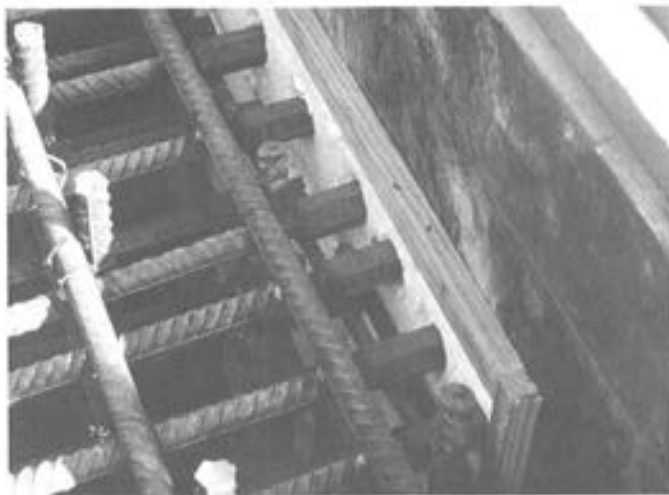
Foto 4. Puente del Centenario, en Sevilla. Encofrado.
