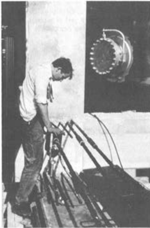
Foto 8. Manguitos ALCOR. Colocación en el tajo.
