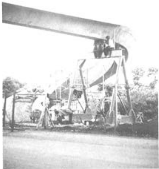
ETAPA 3. Ejecución de la losa superior y escalones.
