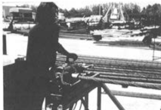
Foto 7. Manguito estampado. Colocación a pie de obra.
