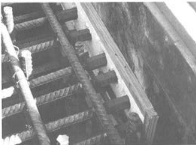
Foto 4. Puente del Centenario, en Sevilla. Encofrado.
