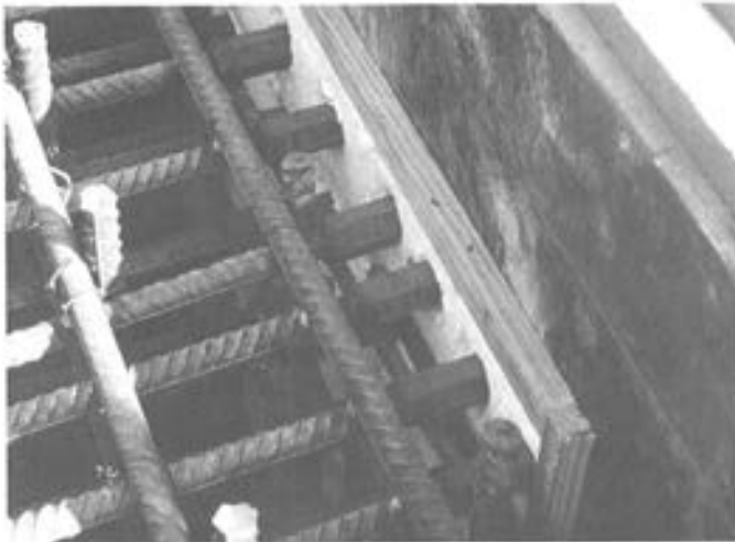
Foto 4. Puente del Centenario, en Sevilla. Encofrado.
