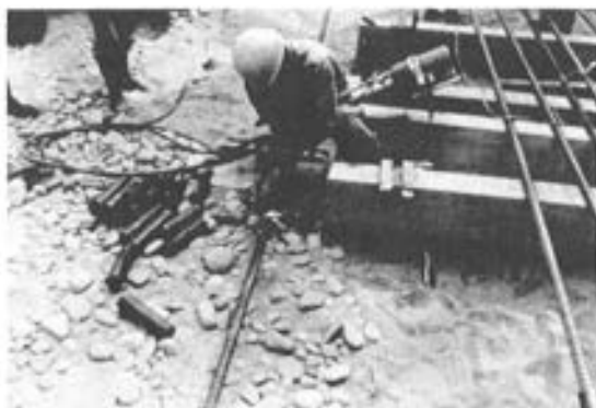
Foto 6. Manguitos ALCOR. Colocación a pie de obra.
