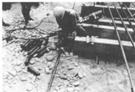
Foto 6. Manguitos ALCOR. Colocación a pie de obra.
