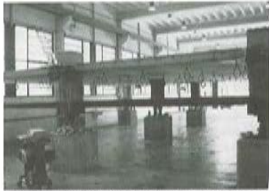
Fig. 12. Losa postensada preparada para realizar los ensayos.
