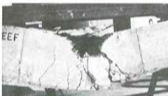
Foto 28. Viga 7 (distintas fases de rotura).
