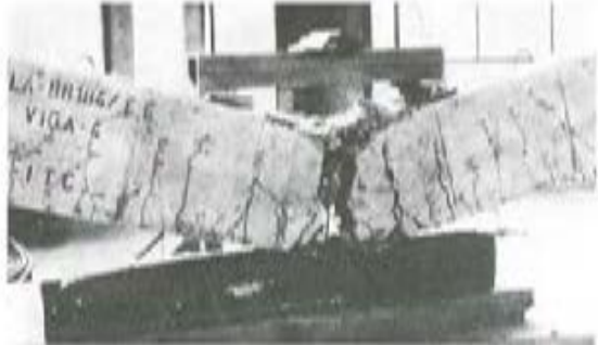
Foto 16, Viga 4 (rotura).
