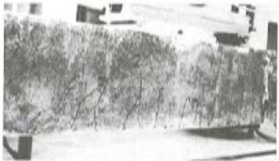
Foto 6. Viga 2 (escalón de rotura nominal).
