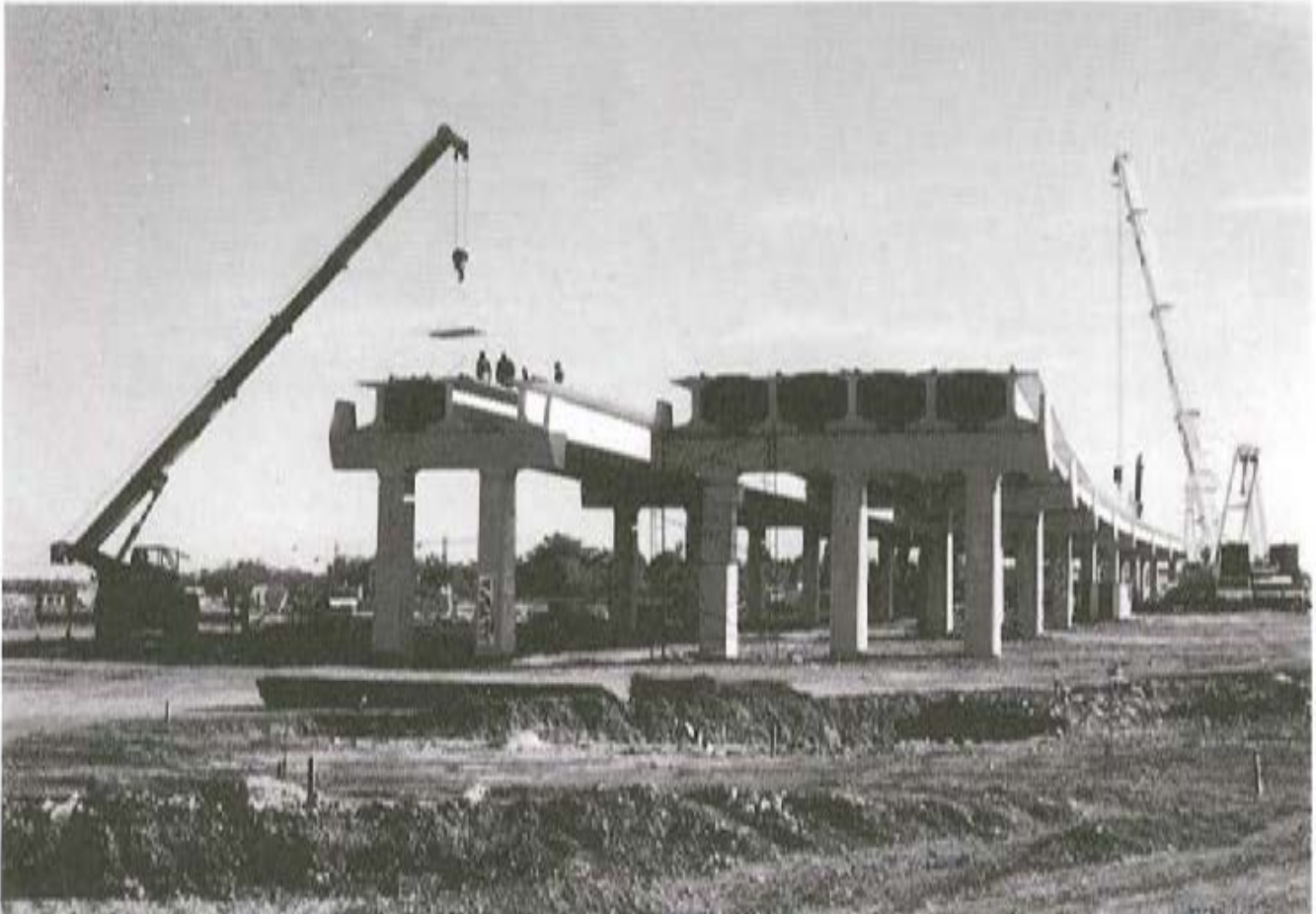
Viaducto para el Tren Alta Velocidad en Ciudad Real.
