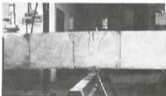
Foto 31. Viga 8 (escalón de rotura prevista).
