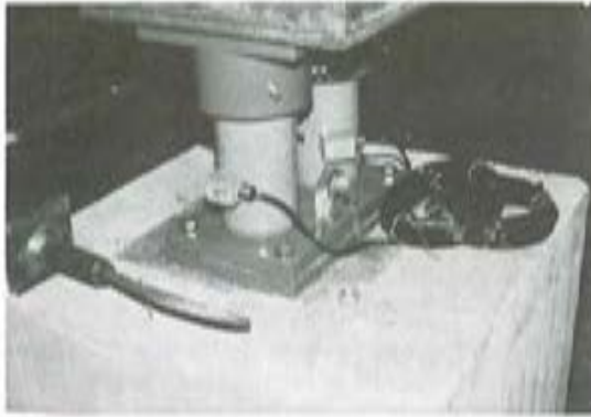
Fig. 6. Células de carga de 45.000 kp (2 unidades) en el pilar central.
