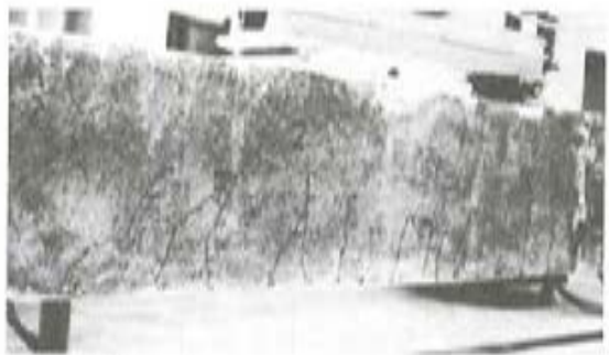
Foto 6. Viga 2 (escalón de rotura nominal).
