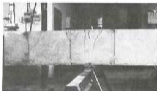
Foto 31. Viga 8 (escalón de rotura prevista).
