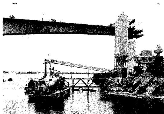
Foto 1. Carga del hormigón sobre mixer flotantes.
