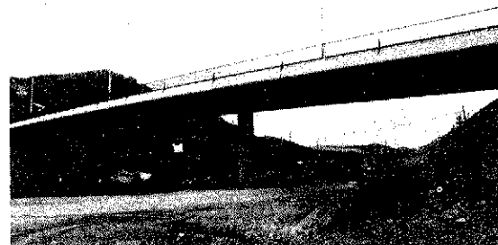
Foto 1. Circunvalación de Valencia - E1.
