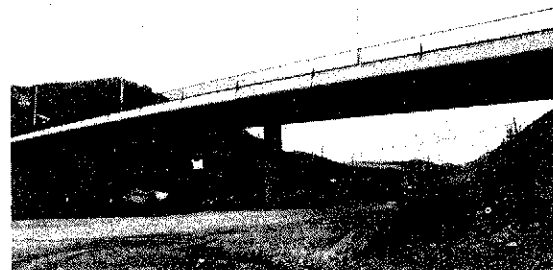
Foto 1. Circunvalación de Valencia - E1.
