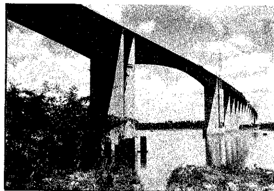
Foto 10. Vista general del puente.
