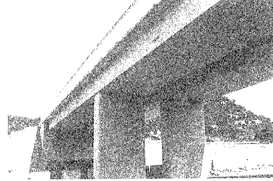
Fig. 20. Viga prefabricada de sección cajón.
