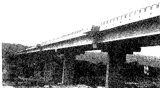
Fig. 32. Vista de la junta entre vanos prefabricados.
