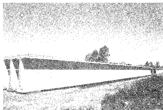
Fig. 18. Viga prefabricada de sección doble T.
