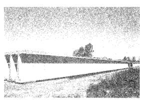
Fig. 18. Viga prefabricada de sección doble T.
