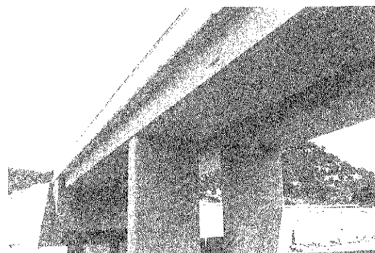
Fig. 20. Viga prefabricada de sección cajón.
