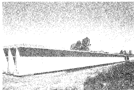
Fig. 18. Viga prefabricada de sección doble T.
