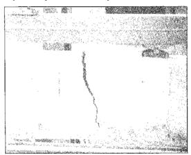
Foto 11. Fisura en viga V.7M.I.
