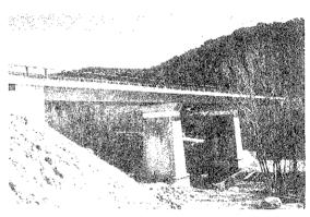
Fig. 21. Viga prefabricada de sección artesa.
