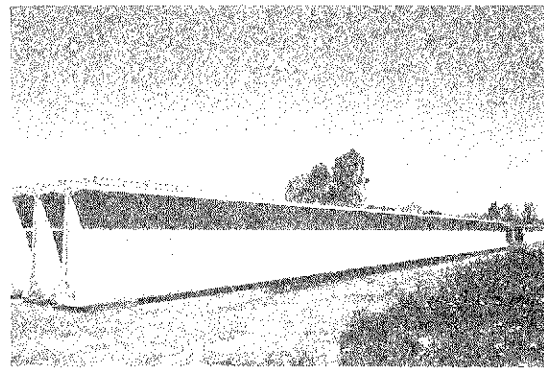
Fig. 18. Viga prefabricada de sección doble T.
