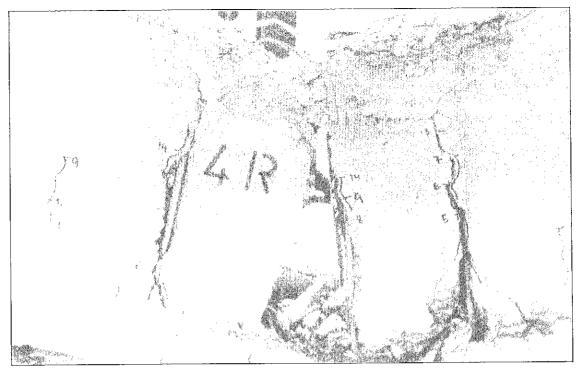
Foto 21. Agotamiento por tracción de la armadura original.
