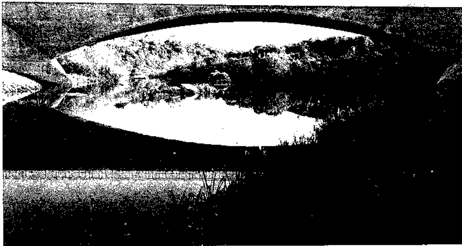
Fig. 3. Vista general del puente desde aguas arriba.
