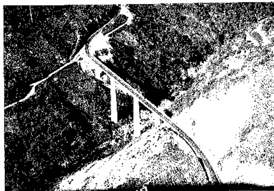
Fig. 4. Puente de Chantada. Vista general.
