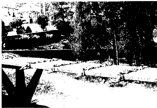
Fig. 4. Encofrado de juntas entre losas prefabricadas.
