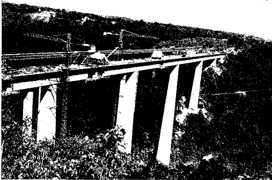
Fig. 7. El viaducto, en la operación de cierre de los centros de vano.
