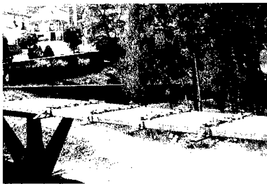
Fig. 4. Encofrado de juntas entre losas prefabricadas.
