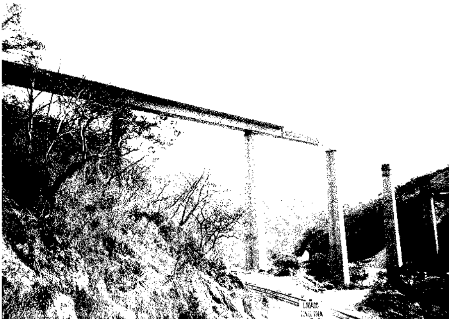
Vistas del viaducto Atenquique II, durante el empujado.
