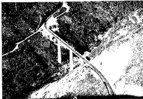
Fig. 4. Puente de Chantada. Vista general.
