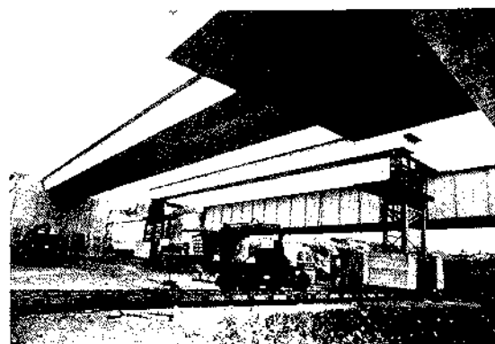
Foto 1. Proceso de montaje de vigas.
