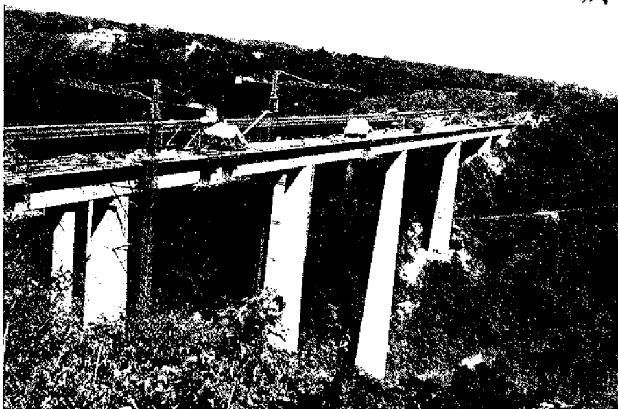
Fig. 7. El viaducto, en la operación de cierre de los centros de vano.
