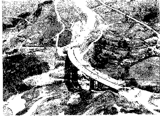
Fig. 8. Puente de Ontón. En fase avanzada de construcción.
