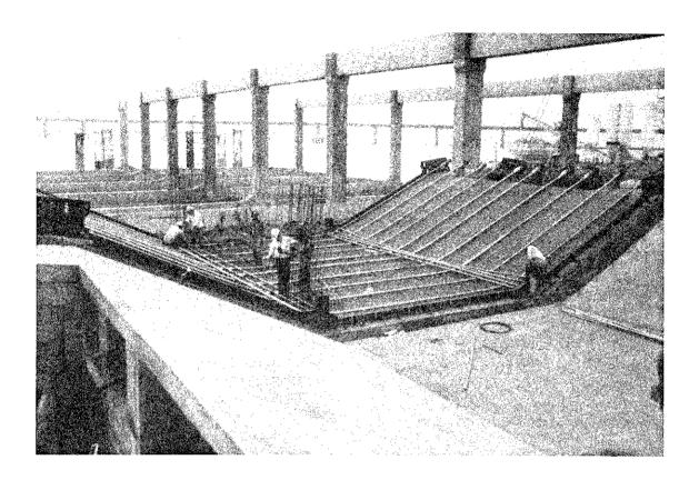
Prefabricación de dovelas: losas inferiores.
