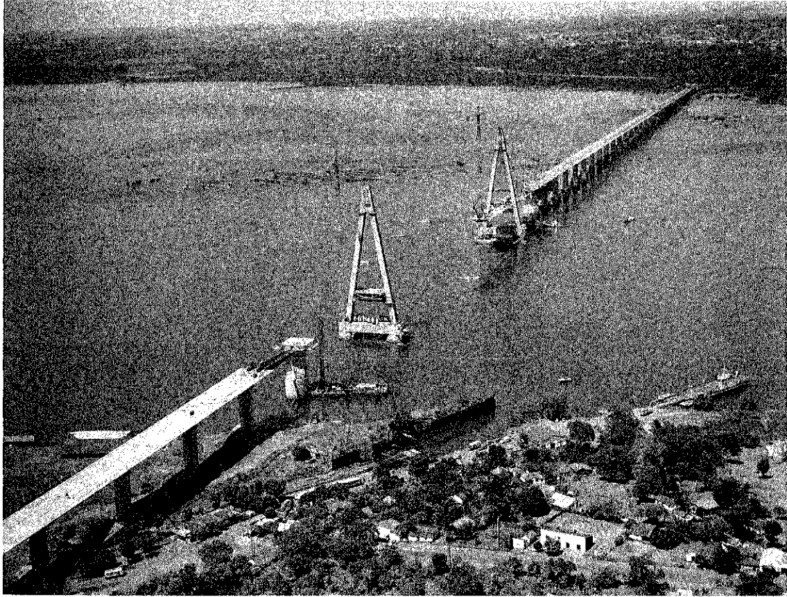
Vista general durante la construcción del puente.
