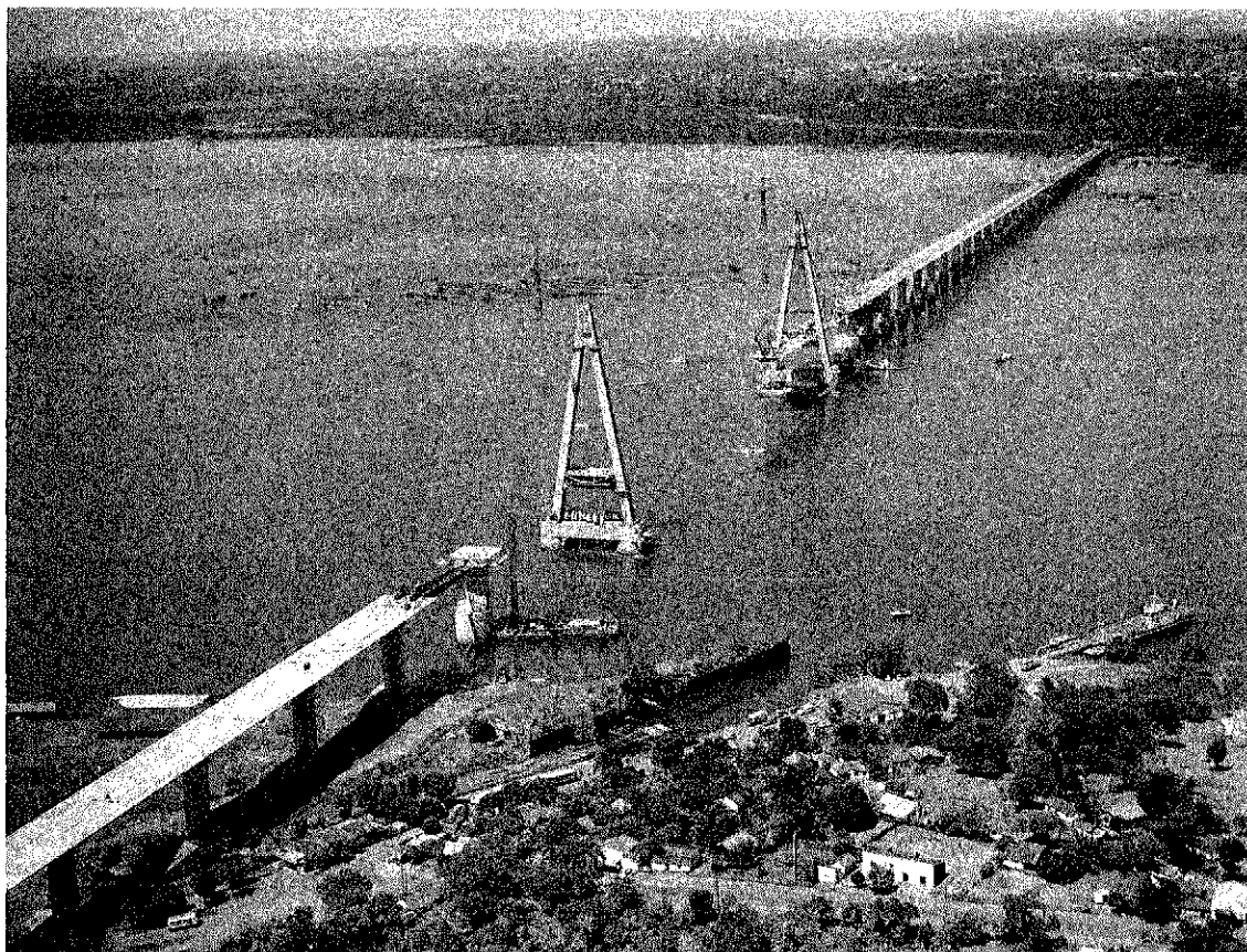
Vista general durante la construcción del puente.
