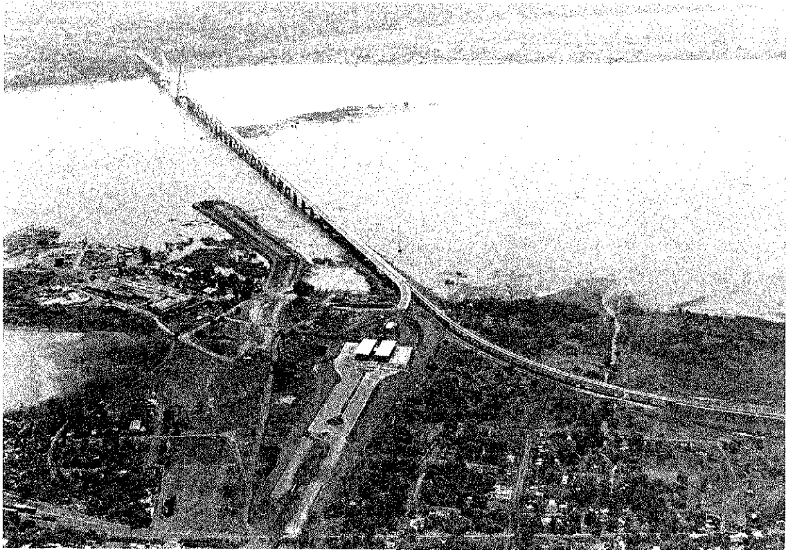
Vista desde el lado argentino: en primer plano: terraplenes, Centro de Frontera, Accesos carretero y ferroviario, ambos curvos. En el borde izquierdo, la planta de prefabricación de dovelas. (El terraplén que se introduce en el río, a la izquierda del puente, es una obra aparte: la toma de agua para la ciudad de Posadas).
