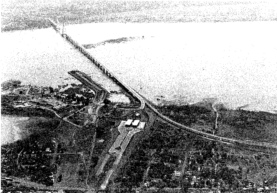
Vista desde el lado argentino: en primer plano: terraplenes, Centro de Frontera, Accesos carretero y ferroviario, ambos curvos. En el borde izquierdo, la planta de prefabricación de dovelas. (El terraplén que se introduce en el río, a la izquierda del puente, es una obra aparte: la toma de agua para la ciudad de Posadas).
