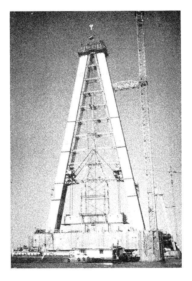
Pilón N.º 31: Izado hidráulico del travesaño premoldeado.
