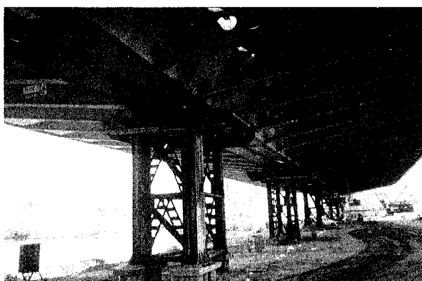
Foto 14. Apoyo del tablero en el estribo.
