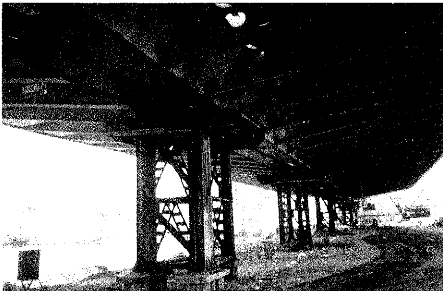
Foto 14. Apoyo del tablero en el estribo.
