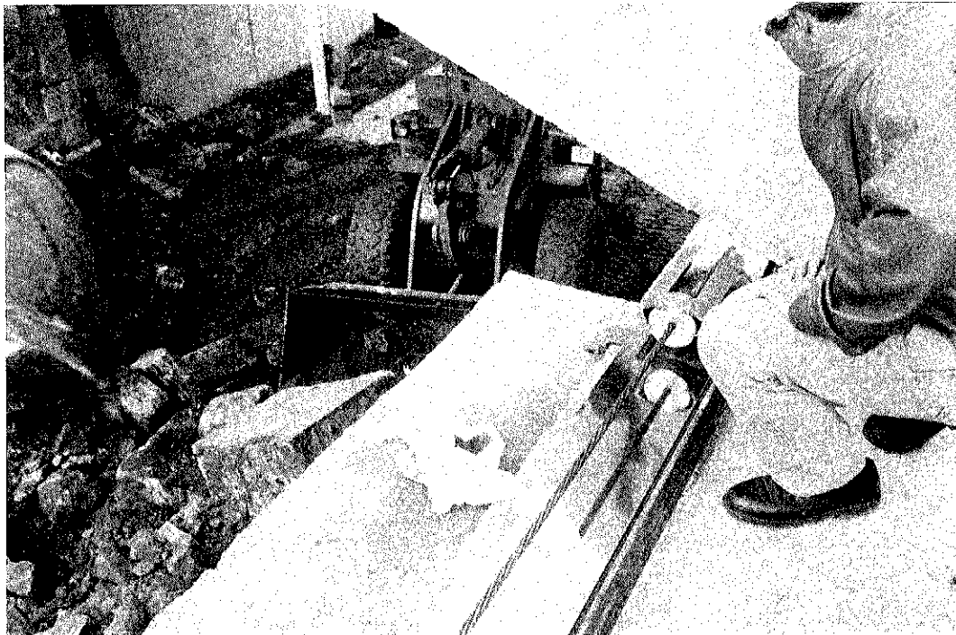
Fig. 17. Ripado del tablero. Puede verse en la parte inferior y sobre el patín de deslizamiento, el cable de arrastre. Simultáneamente, en la calzada inferior, se está procediendo al desescombro posterior a la demolición.
