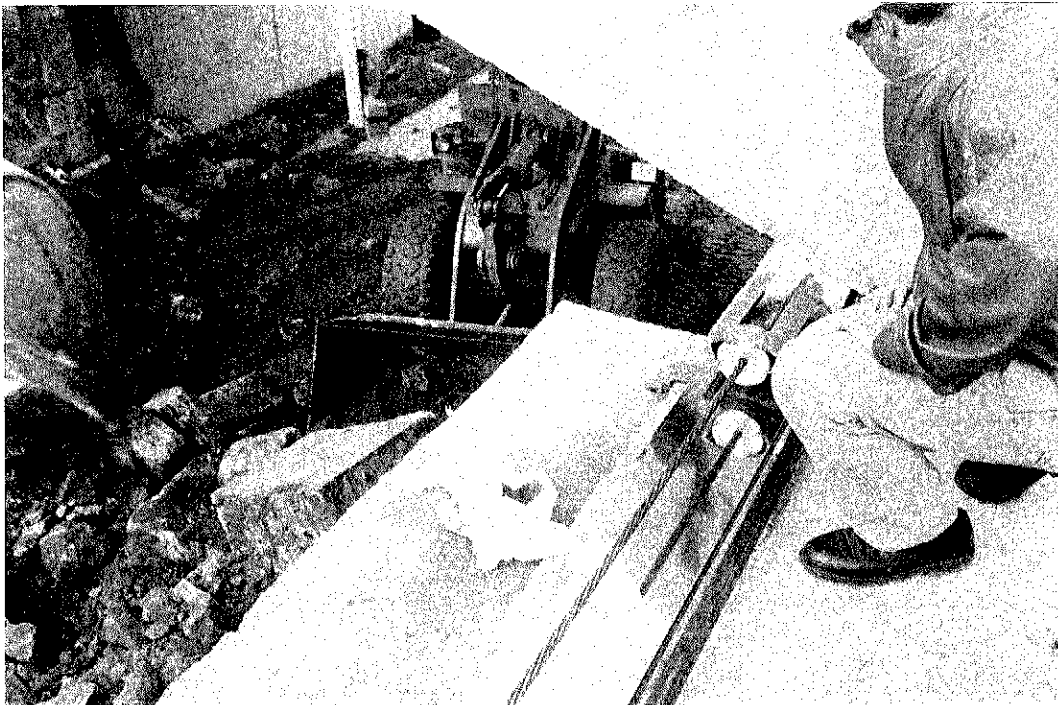
Fig. 17. Ripado del tablero. Puede verse en la parte inferior y sobre el patín de deslizamiento, el cable de arrastre. Simultáneamente, en la calzada inferior, se está procediendo al desescombro posterior a la demolición.
