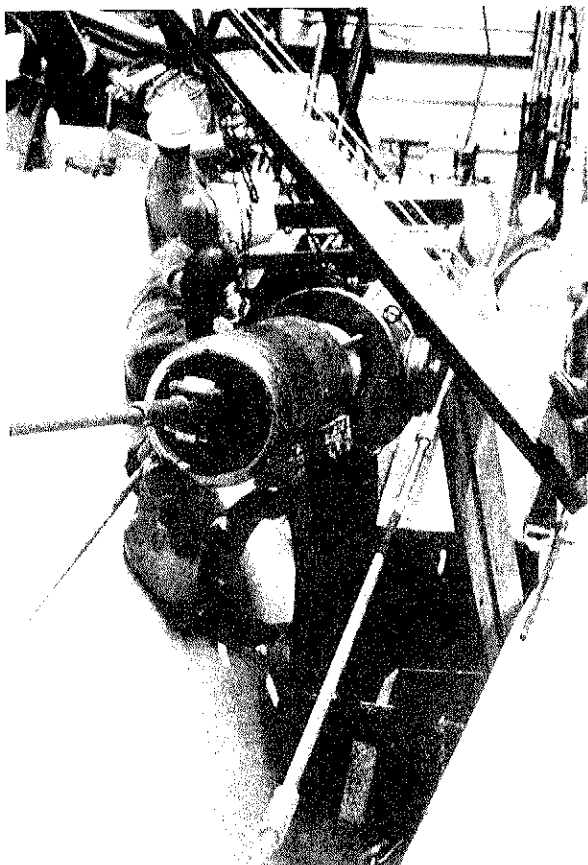
Foto 24. Desviador de dirección del cable.
