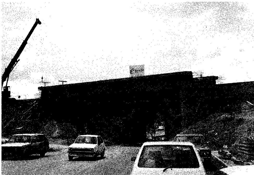
Fig. 5. Nuevo tablero construido al lado del pontón existente, soportado por unos tabiques provisionales de hormigón y en situación apropiada para el ripado a su posición definitiva.
