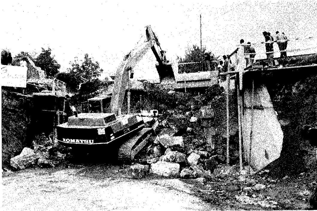
Fig. 16. Demolición del puente antiguo.
