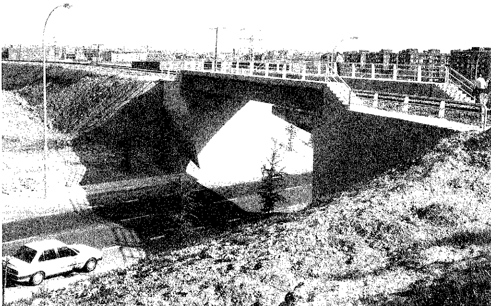
Fig. 7. Aspecto de la obra terminada, vista a la altura de la plataforma del Ferrocarril.
