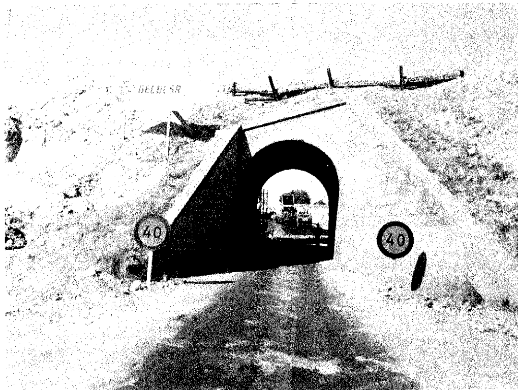
Fig. 2. Antiguo pontón existente bajo el terraplén del Ferrocarril.
