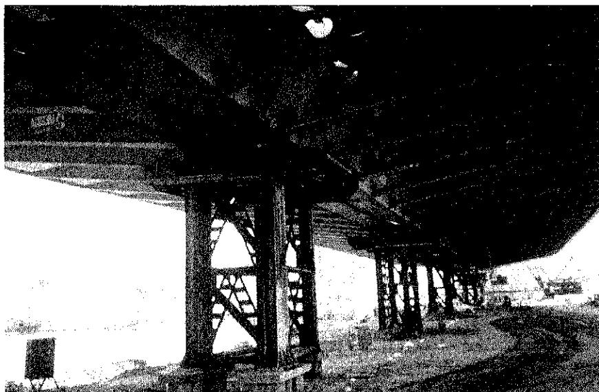
Foto 14. Apoyo del tablero en el estribo.
