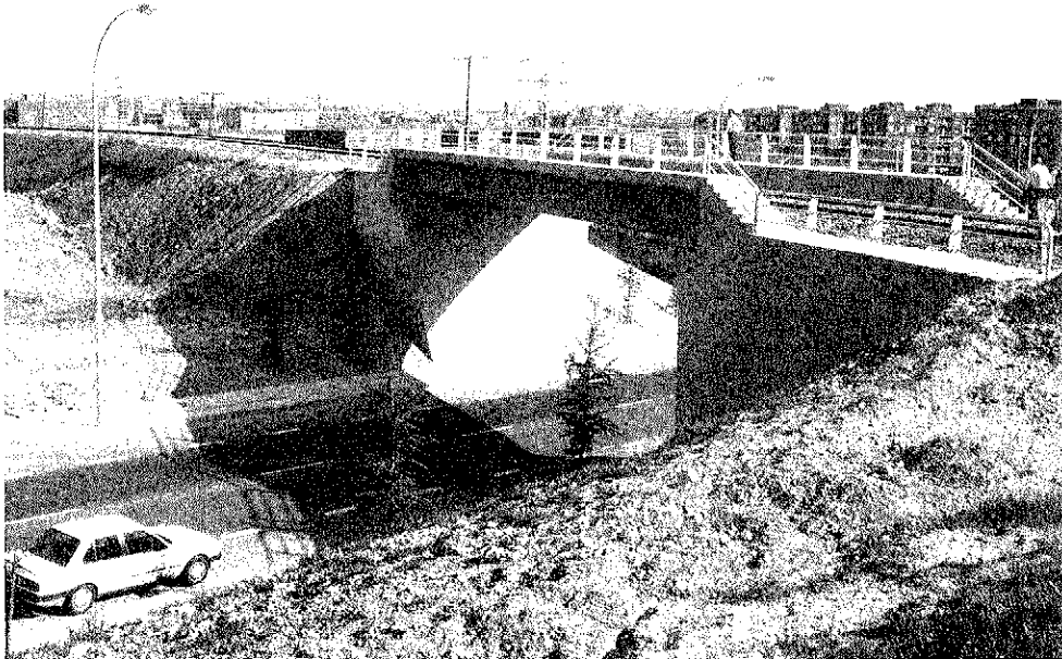
Fig. 7. Aspecto de la obra terminada, vista a la altura de la plataforma del Ferrocarril.
