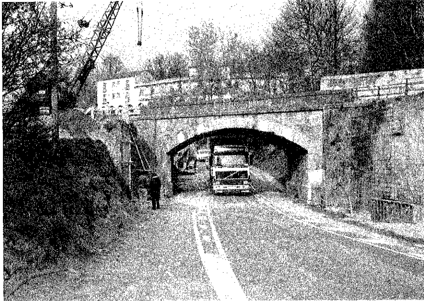
Fig. 9. Antiguo puente para el Paso Superior del F.C. sobre la Carretera N-630.
