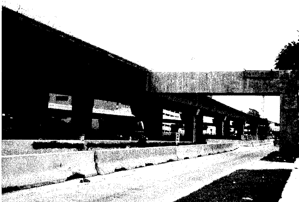
Foto 2. Vista general de un ramal de la "Y" de San Antonio, Texas.
