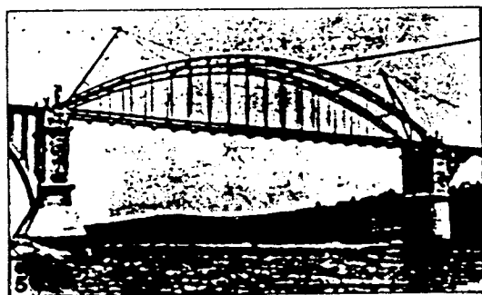
Arco central del puente del Pedrido, en construcción, Ría de Betanzos (La Coruña), 1940.
