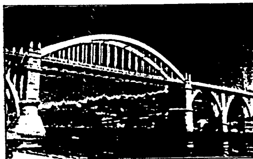
Arco central del Puente del Pedrido, termi- nado, 1940.
