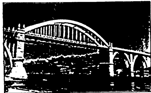
Arco central del Puente del Pedrido, terminado, 1940.
