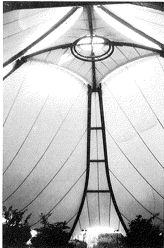
Fig. 73. Vista interior de la carpa bioclimática.
