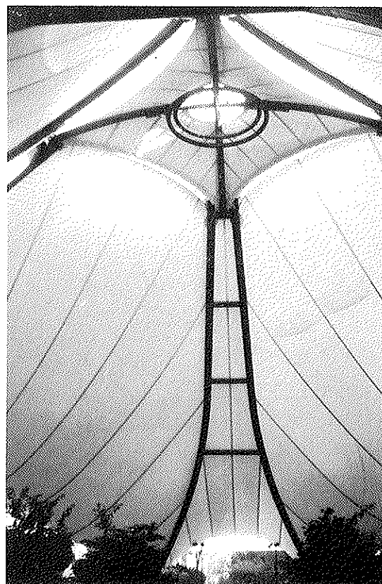
Fig. 73. Vista interior de la carpa bioclimática.
