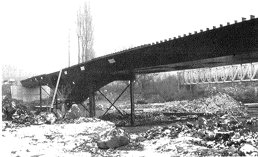
Foto 5. Montaje de los tramos laterales (Fase 3).
