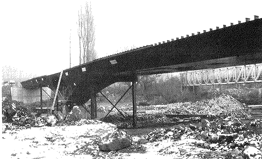
Foto 5. Montaje de los tramos laterales (Fase 3).
