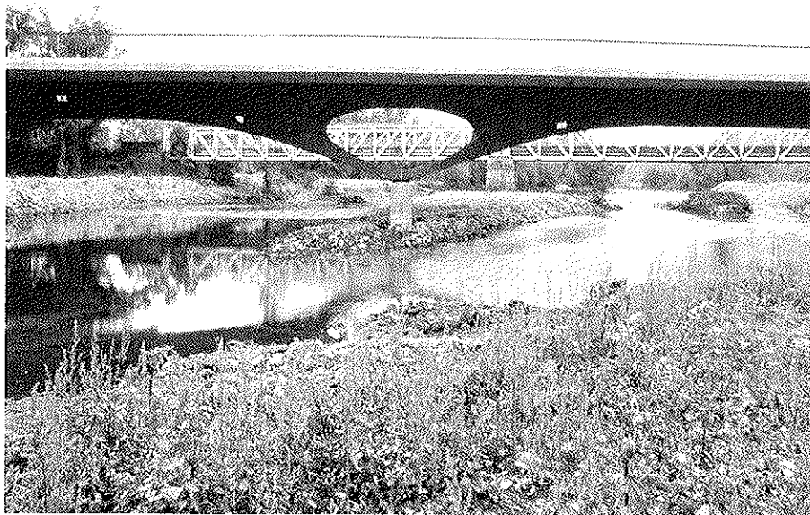
Foto 2. Detalle del alvéolo sobre pila.
