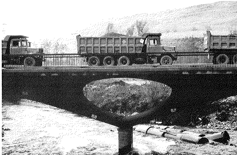
Foto 6. Detalle de la prueba de carga.
