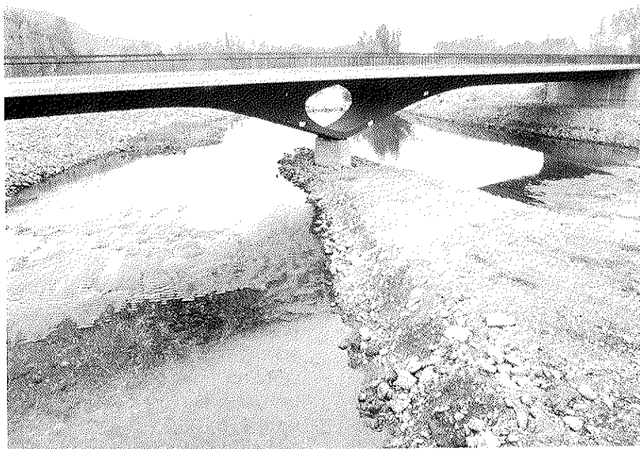
Foto 1. Vista general del puente.
