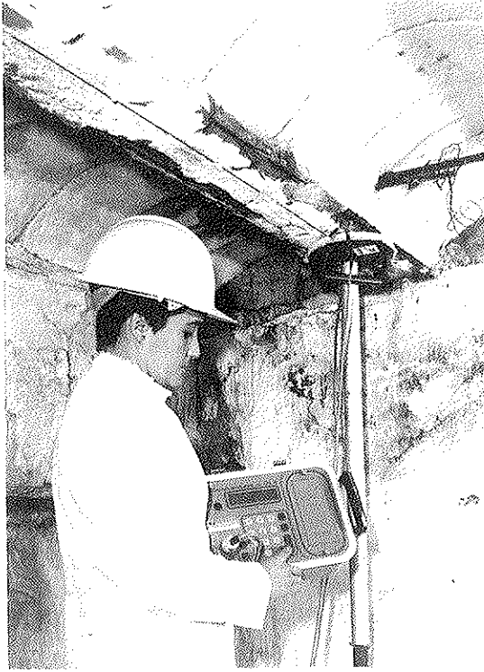
Fig. 14 Medida de la velocidad de corrosión en una vigueta con cemento aluminoso, de una plaza de toros.
