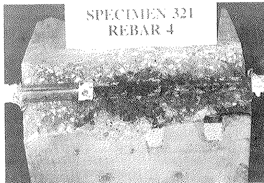
Fig. 9. Aspecto de una probeta con armadura corroída y sin cercos, después de realizar el ensayo y haber removido el recubrimiento de hormigón.
