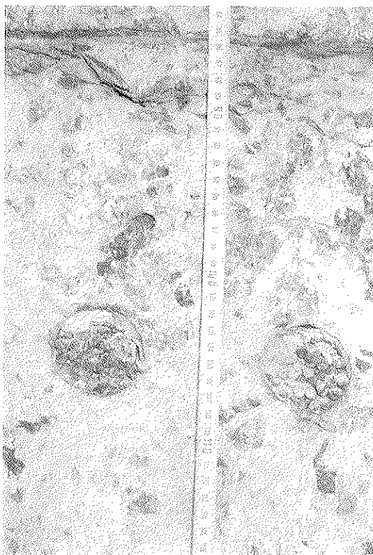
Fig. 7. Control de recubrimientos de armadura pasiva y excentricidades de las vainas, durante la demolición.
