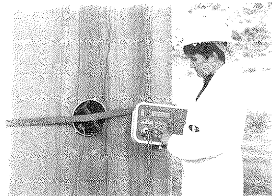
Fig. 2 Corrosímetro y sensor A, midiendo la velocidad de corrosión en la pila de un puente.
