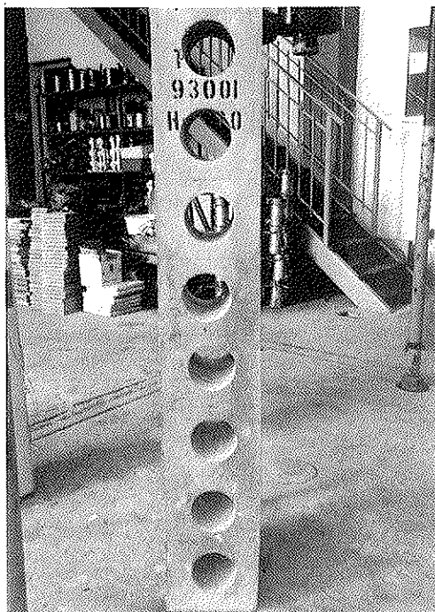
Foto 3. Testigos extraídos en un pilar tipo "T".
