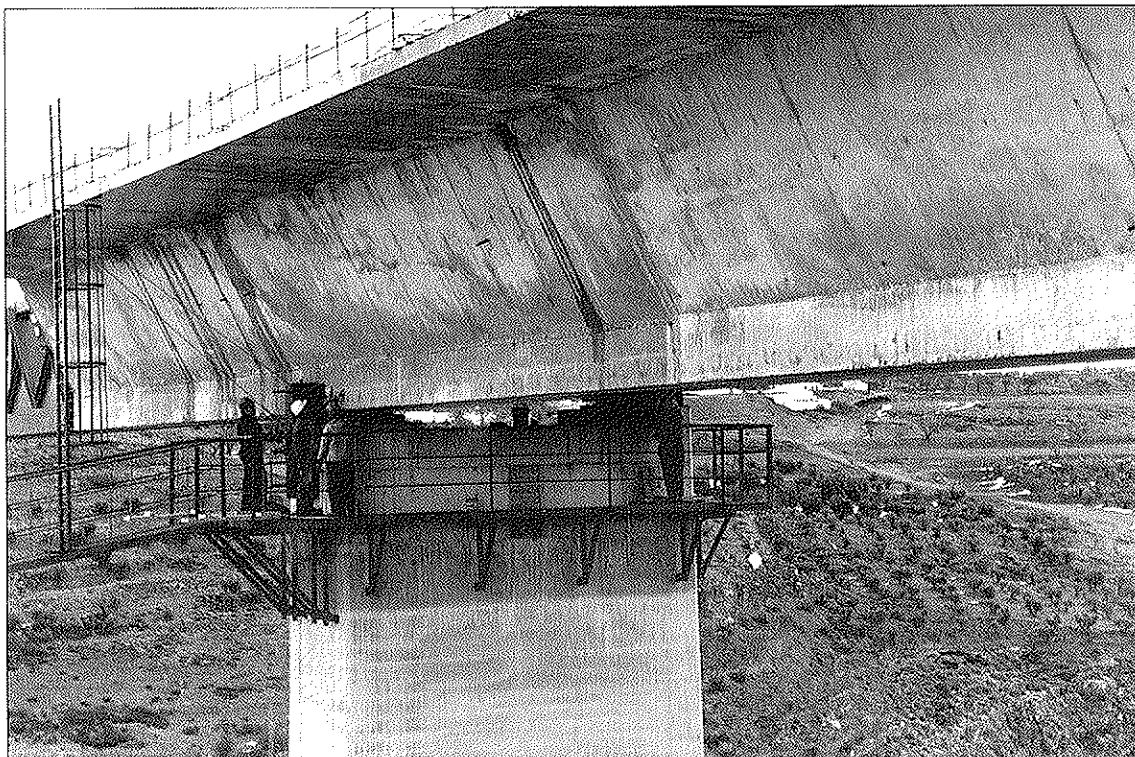
Foto 4. Paso del tablero por pila.
