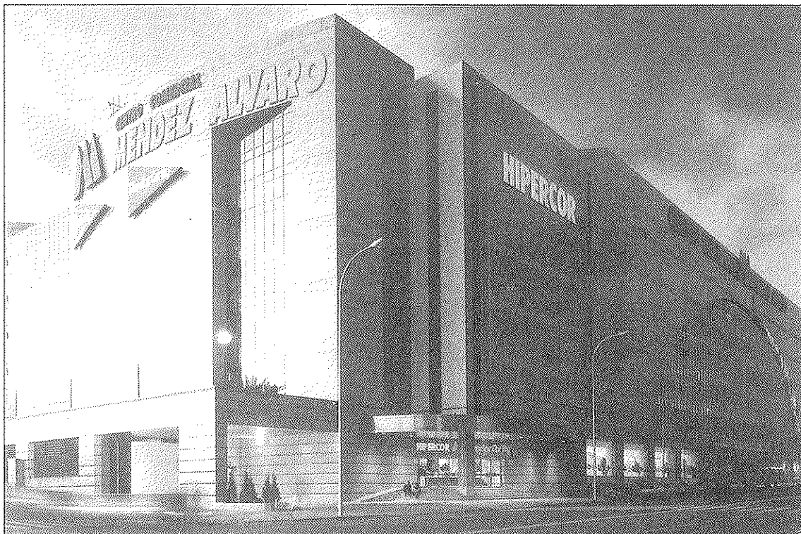
Foto 10. Centro Comercial Méndez Alvaro, en Madrid. Vigas postesadas con unidades 2400,6" y 1900,6".
