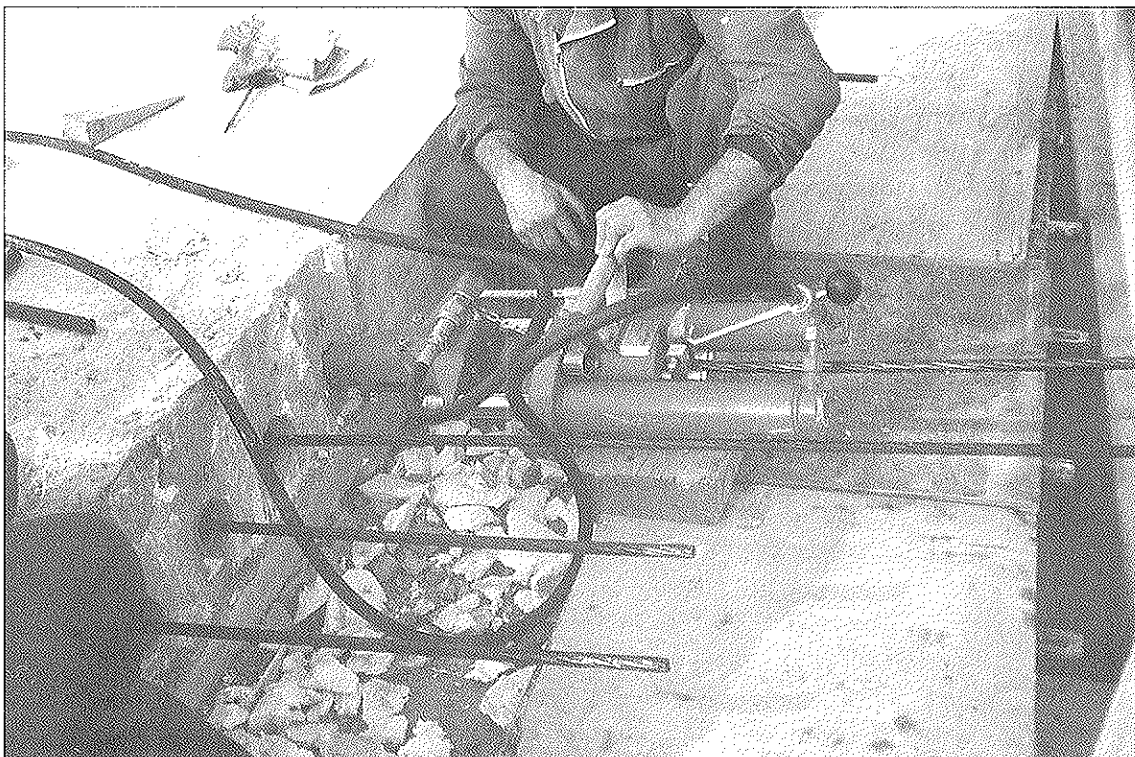
Foto 15. Detalle del tesado: gato U-24.
