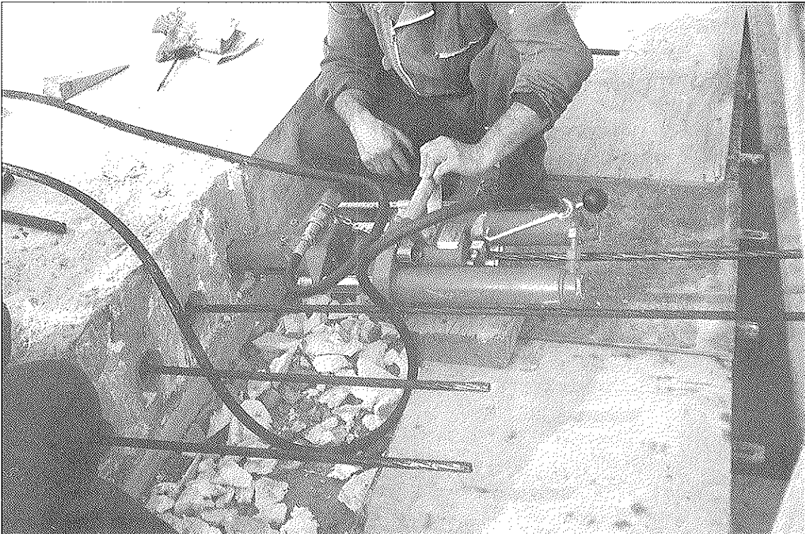
Foto 15. Detalle del tesado: gato U-24.
