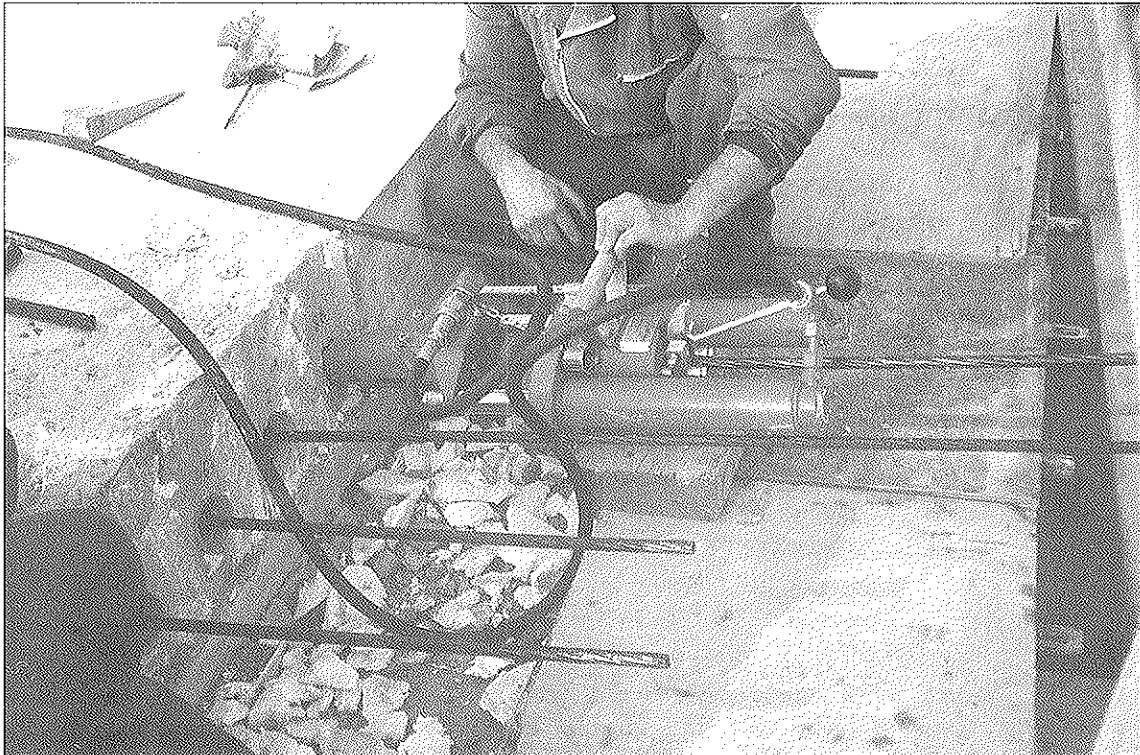
Foto 15. Detalle del tesado: gato U-24.
