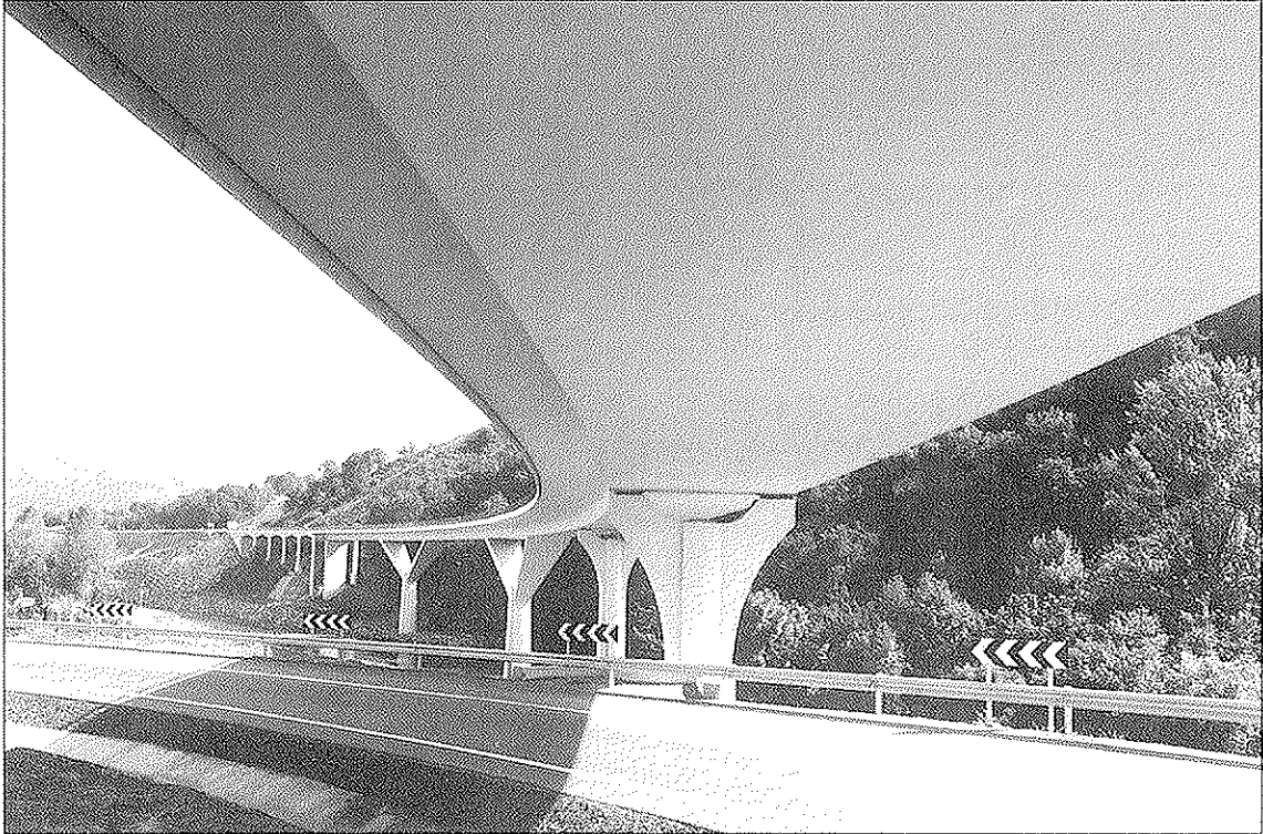
Foto 9. Puente sobre el río Piloña (Asturias). Unidades 1700,6".
