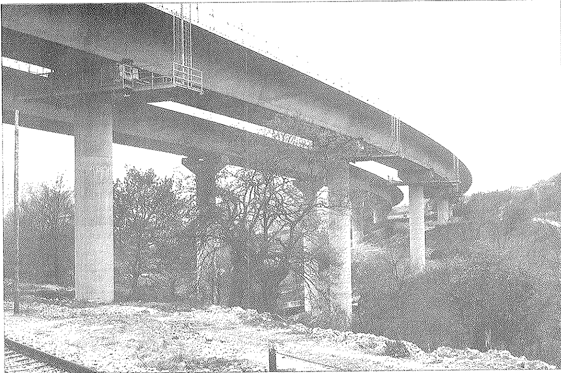
Foto 24. Viaducto de El Cueto, en Asturias. Puente curvo, empujado, de 344 m de longitud (luz máx.: 52 m.). Unidades de pretensado 24Ø0,6", 19Ø0,6", 15Ø0,6", y 12Ø0,6".
