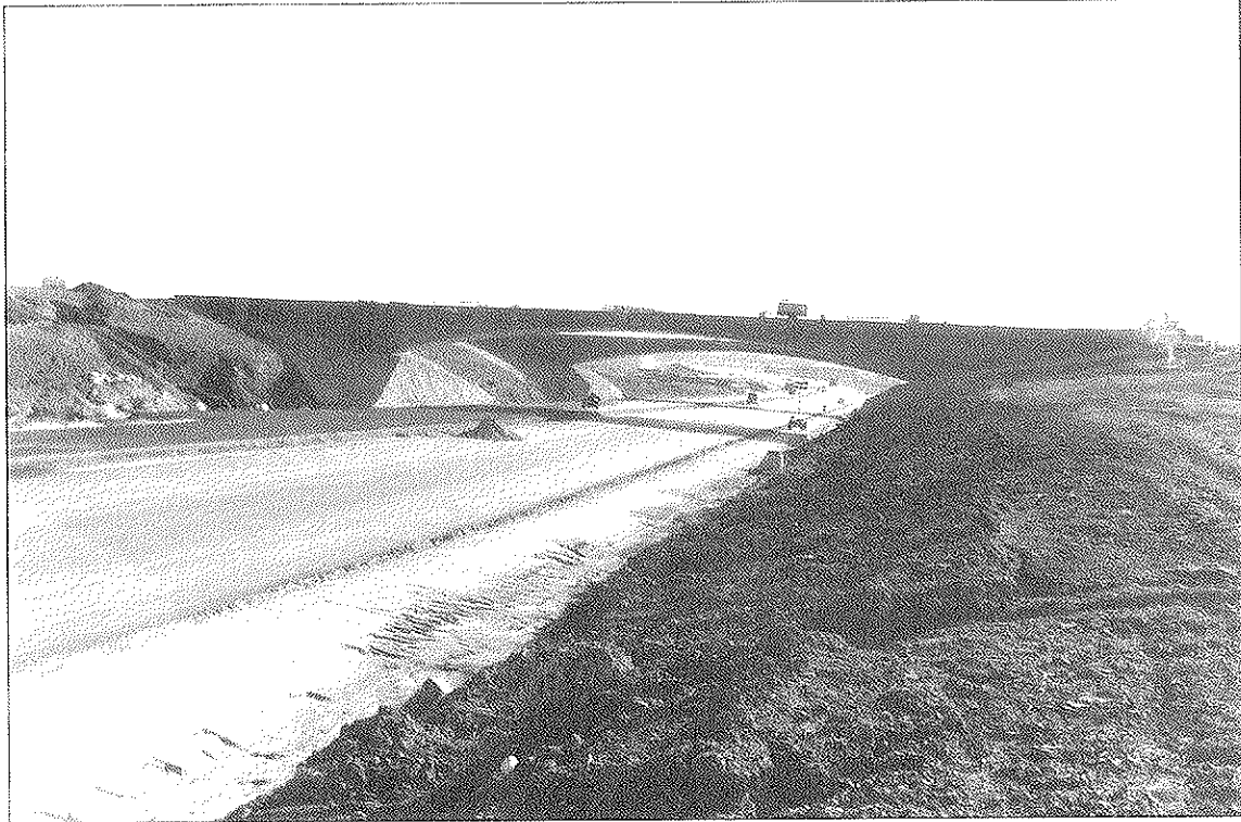
Foto 7. Puente en el Centro de Transportes de Coslada. Unidades 1900,6" y 1200,6".
