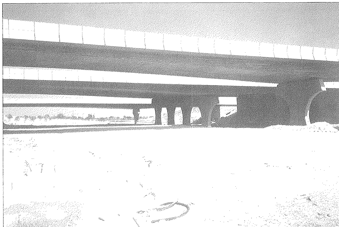
Foto 17. Distribuidor Oeste, en Madrid. Varias estructuras. Unidades 19Ø0,6", 12Ø0,6", 7Ø0,6", 24Ø0,5" y 12Ø0,5".
