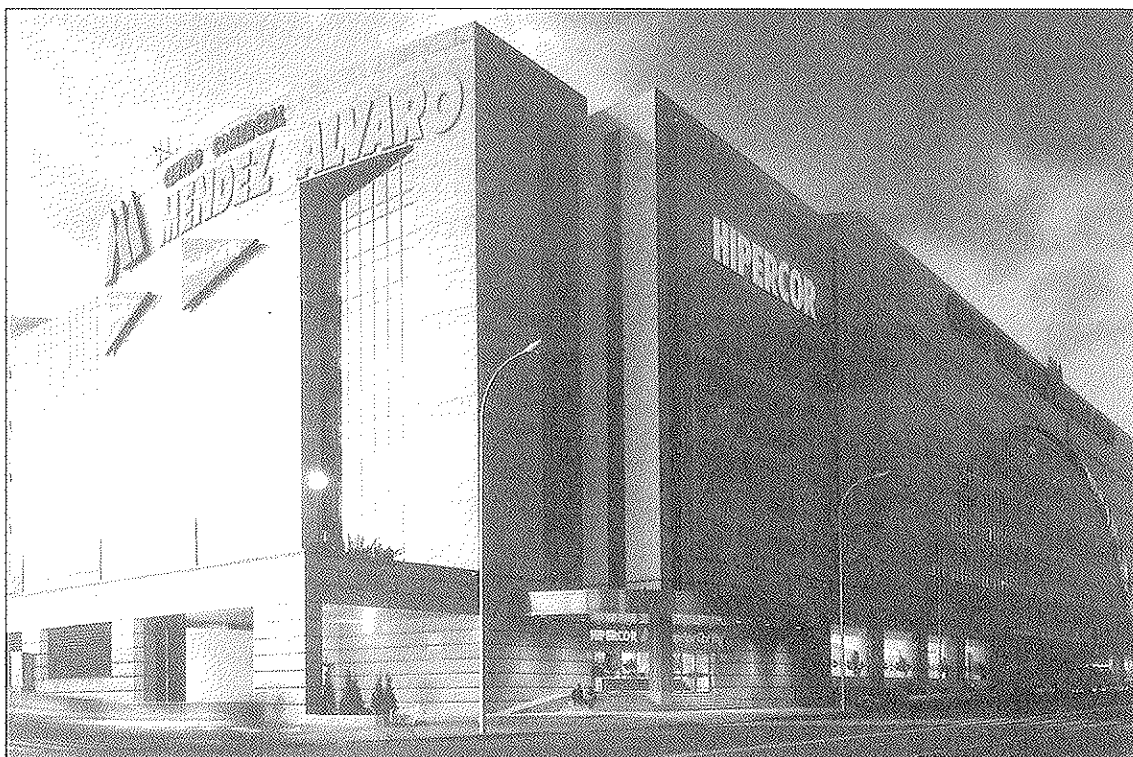
Foto 10. Centro Comercial Méndez Alvaro, en Madrid. Vigas postesadas con unidades 24Ø0,6" y 19Ø0,6".
