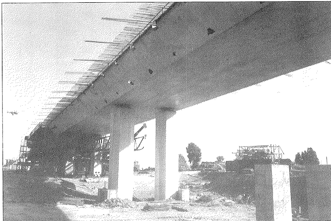
Foto 13. Puente IV sobre el río Guadiana, en Badajoz. Unidades 2400,6", 1900,6" y 1200,6".
