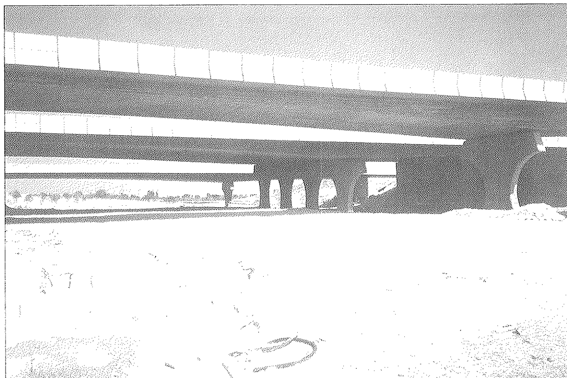
Foto 17. Distribuidor Oeste, en Madrid. Varias estructuras. Unidades 1900,6", 1200,6", 700,6", 2400,5" y 1200,5".
