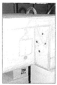
Foto 4.: Cajetín formado con porexpan, para la posterior instrumentación de un cerco próximo a traviesa de apoyo.
