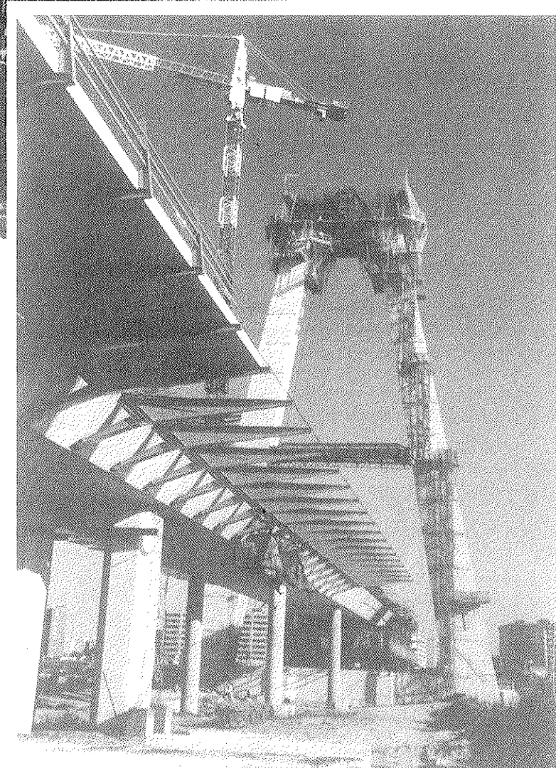
Figura 5. Montaje de ferralla y encofrados interiores.
