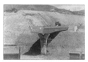
Foto 1. Viga lateral, de trazado parabólico, montada sobre pila prefabricada tipo «Palmera»
