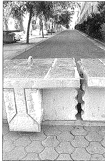
Foto 9.: Aspecto de la dovela con desviador.
