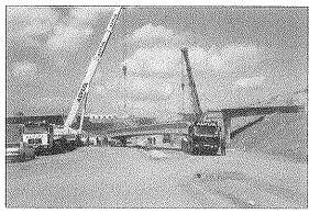
Foto 2. Llegada a obra del tramo central, una vez montados los laterales y las placas transversales correspondientes
