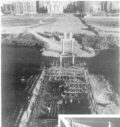
Figura 5. Montaje de ferralla y encofrados interiores.
