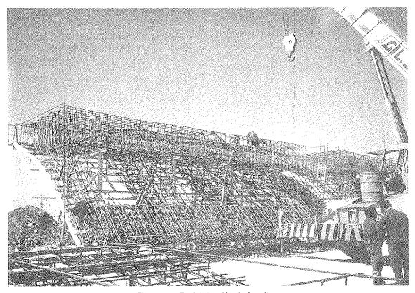
Figura 8. Prefabricación de ferralla.
