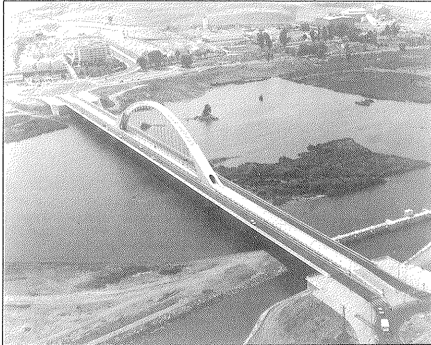
Fig. 8. Vista del puente terminado.
