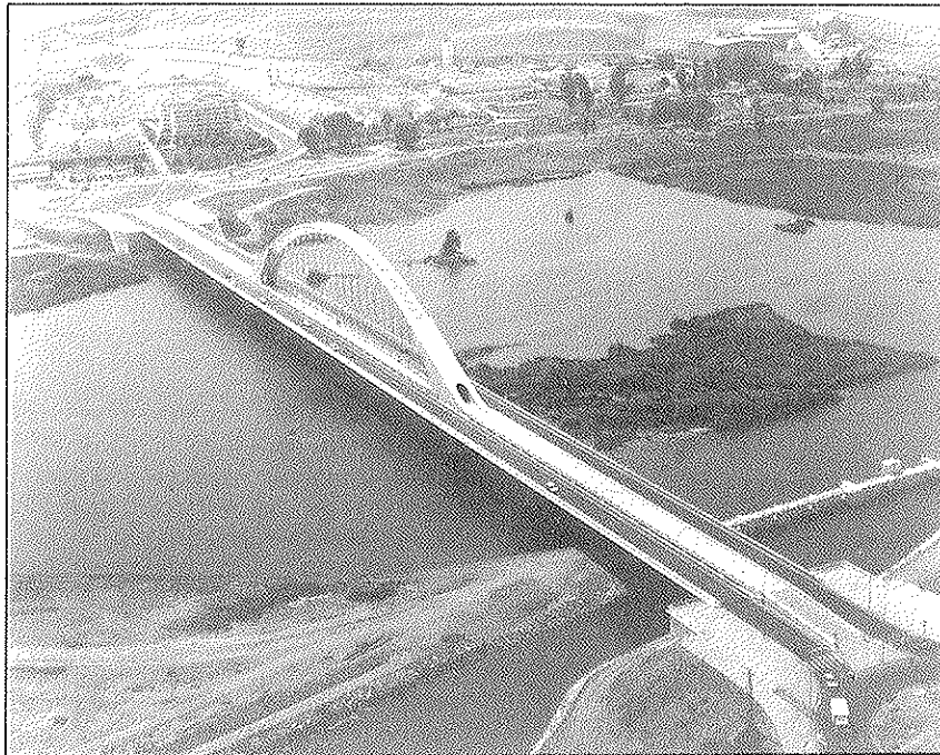
Fig. 8. Vista del puente terminado.
