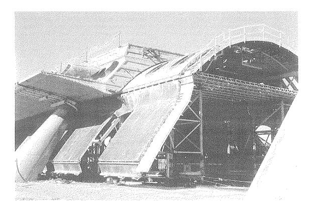
Figura 7. Carro porta encofrado.
