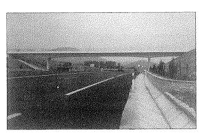
Foto 8. Vista general del puente, totalmente construido con la autovía en servicio. Se aprecia la esbeltez propia de la viga continua de canto variable. Una vez concluida la obra, no se distinguen las juntas de construcción entre los tres tramos de la viga principal.
