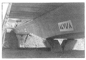
Foto 5. Viga principal, totalmente montada.
