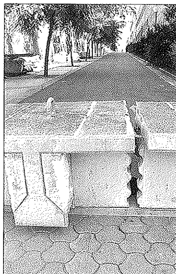
Foto 9.: Aspecto de la dovela con desviador.
