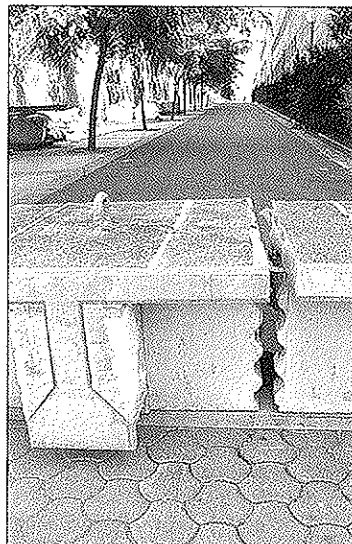
Foto 9.: Aspecto de la dovela con desviador.
