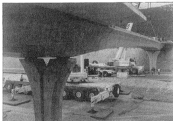
Foto 6. Viga principal y pilas, vistas desde otro ángulo.
