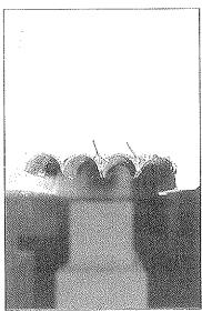
Foto 3.: Detalle de los tubos de desviación del pretensado (Máximo; cuatro cordones 0,6" por lado de la viga).
