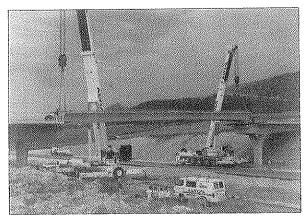
Foto 3. Fase de montaje del tramo central, mediante dos grúas de 400 t de potencia.
