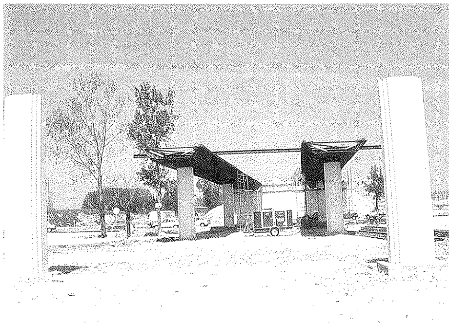
Fig. 26. Fase de Montaje.
