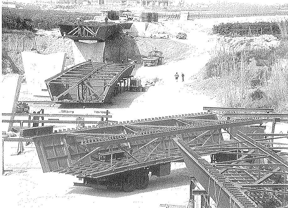
Fig. 9. Fase de Montaje.
