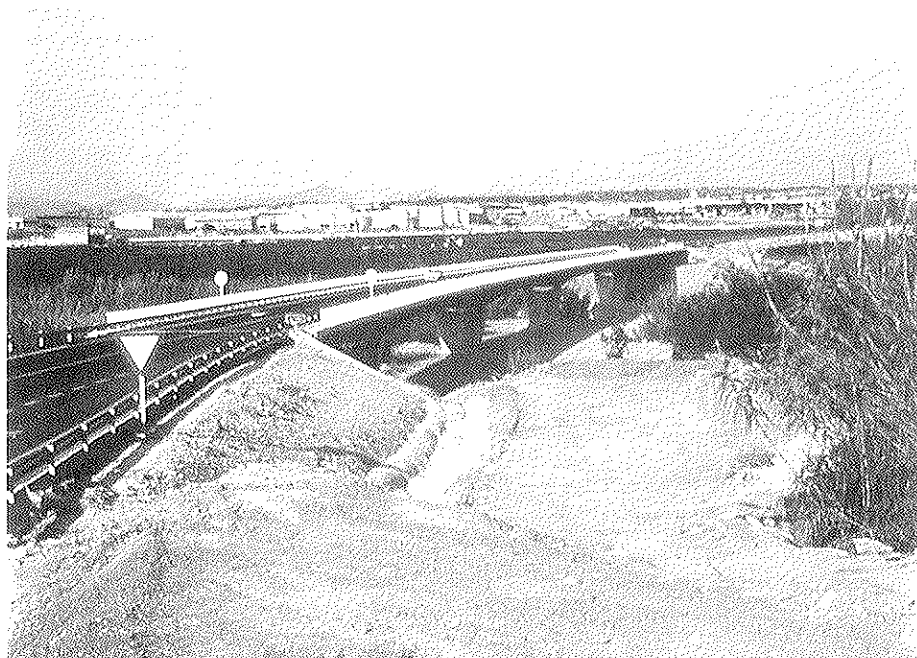
Fig. 1. Vista General del Puente.
