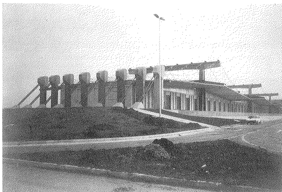
Figura 1. Vista general de la nave.
