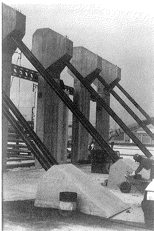
Figura 11. Vista posterior de los contrafuertes.
