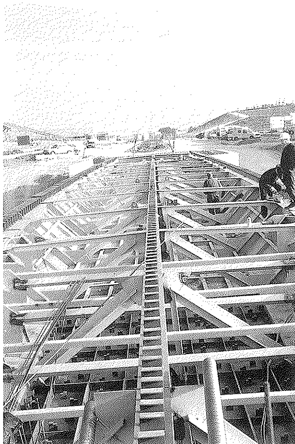
Fig. 14. Tablero metálico en obra.
