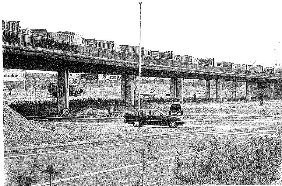
Fig. 28. Alzado Lateral durante Prueba de Carga.
