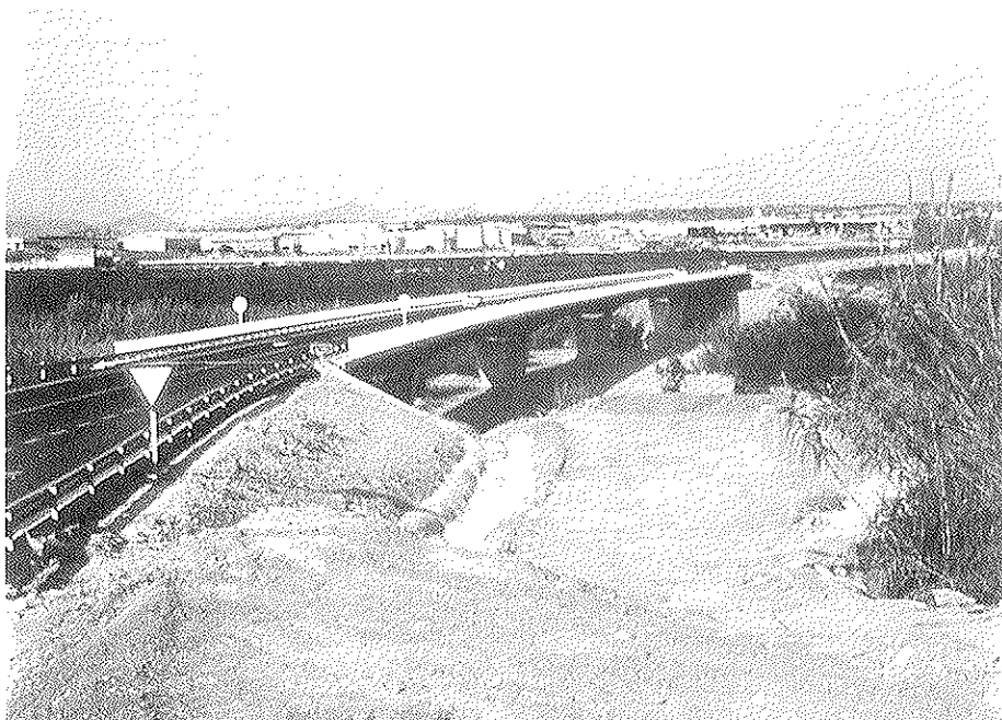
Fig. 1. Vista General del Puente.
