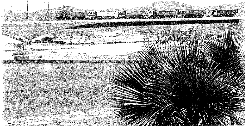
Fig. 16. Prueba de carga.
