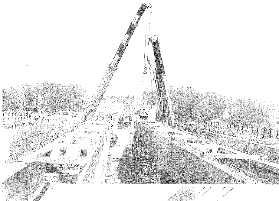
Fig. 16. Montaje con grúa de varios tramos del puente.
