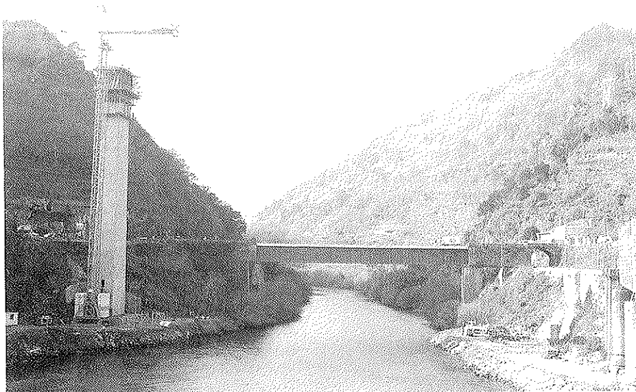
Figura 5. Montaje de encofrado para dovela de cabeza de pila 4.
