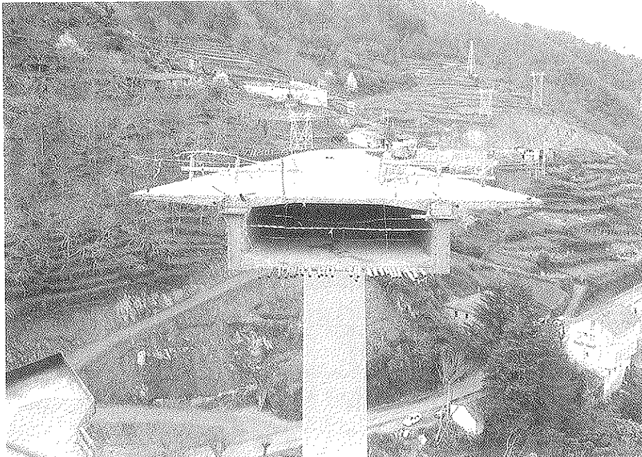
Figura 6. Frente de voladizo de pila 4, terminado.
