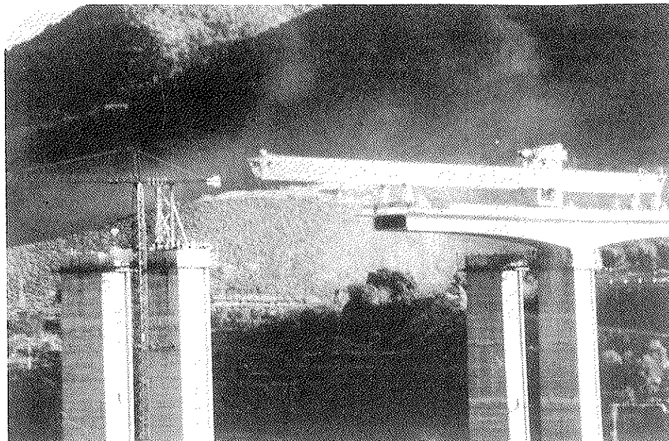
Fig. 15. Avance en voladizo.
