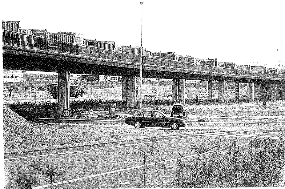
Fig. 28. Alzado Lateral durante Prueba de Carga.
