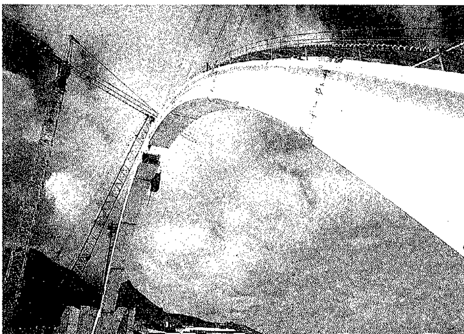
Figura 8. Montaje arco metálico. Fase anterior al cierre.
