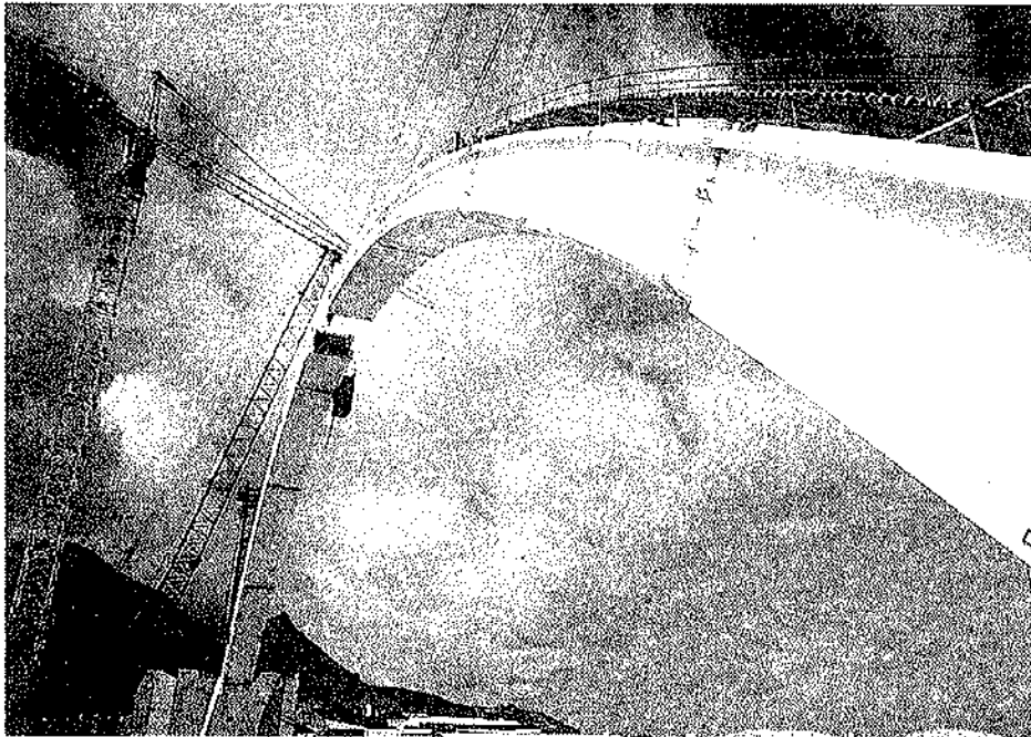
Figura 8. Montaje arco metálico. Fase anterior al cierre.
