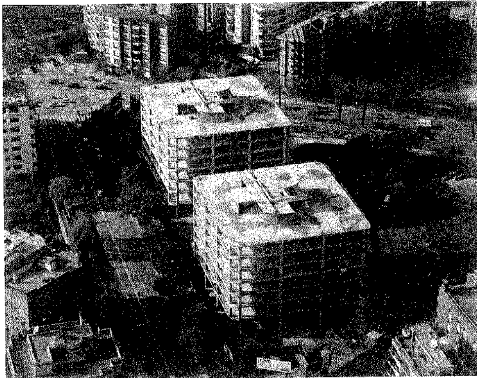
Fig. 1. Vista general del Edificio Mapfre, Vía Augusta, en Barcelona, en la fase de terminación de la estructura.
