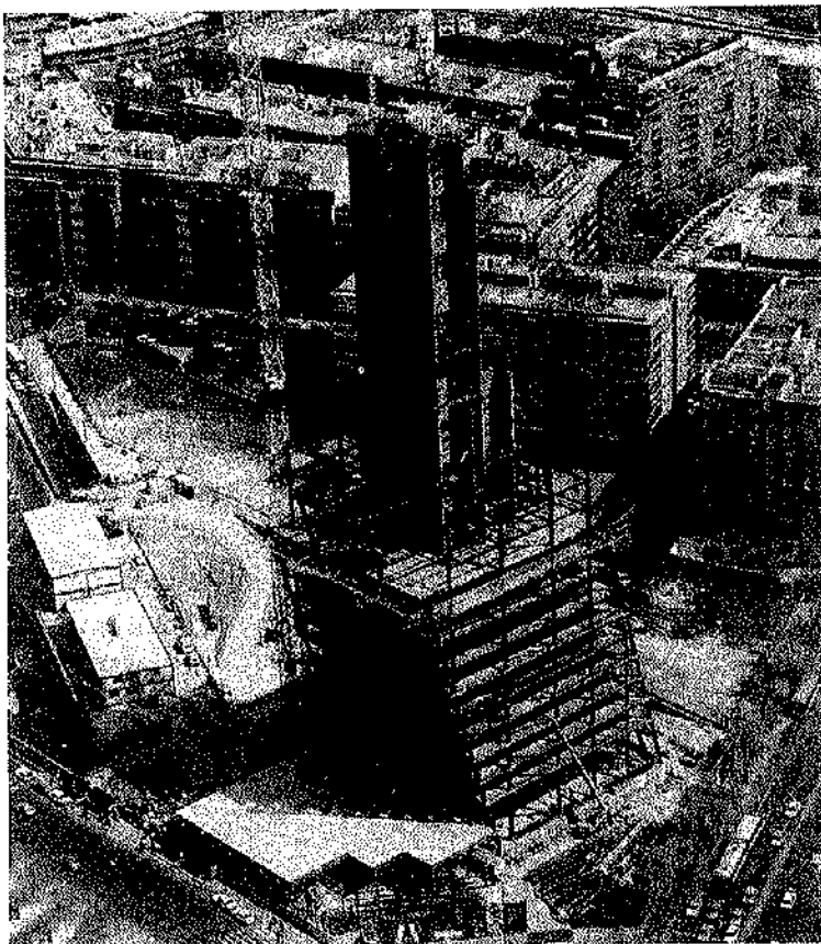
Fig. 8. Montaje estructura metálica.
