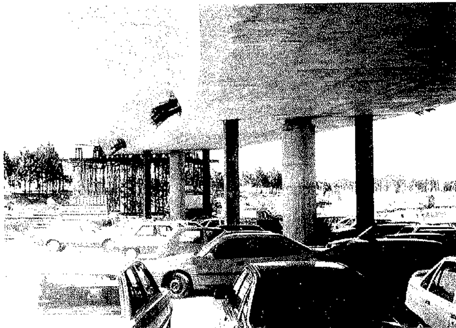
Fig. 5. Puntales en pilas 3 y 4 durante la construcción.
