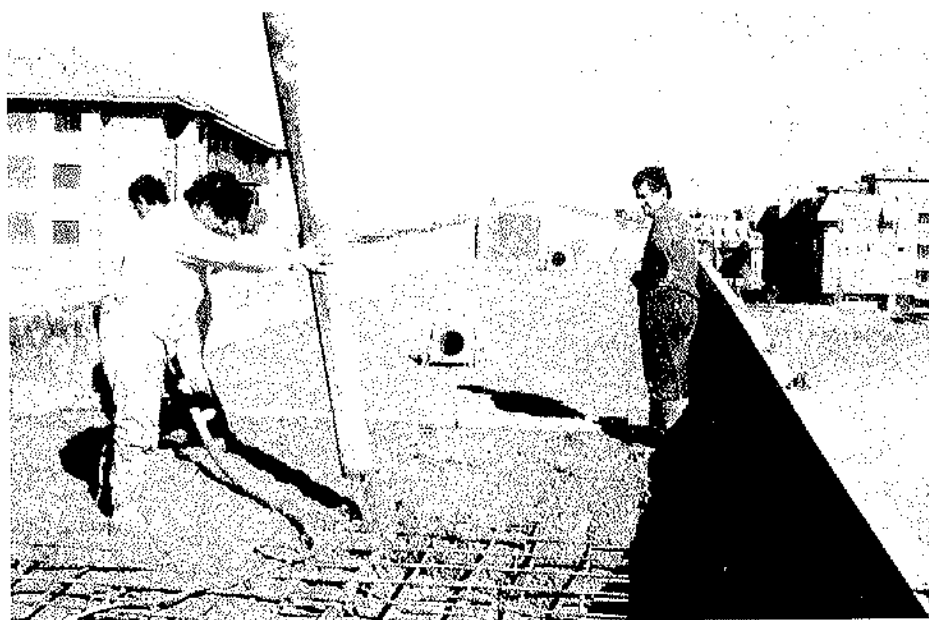
Fig. 11. Hormigonado del tablero.
