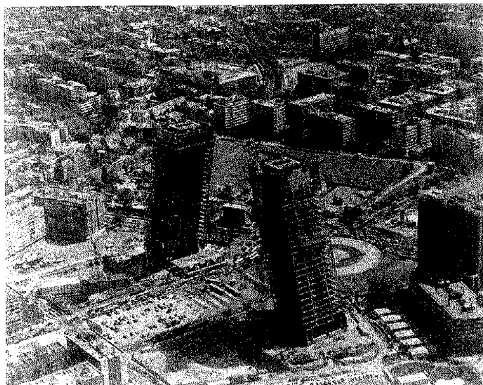
Fig. 1. Vista estructura terminada.
