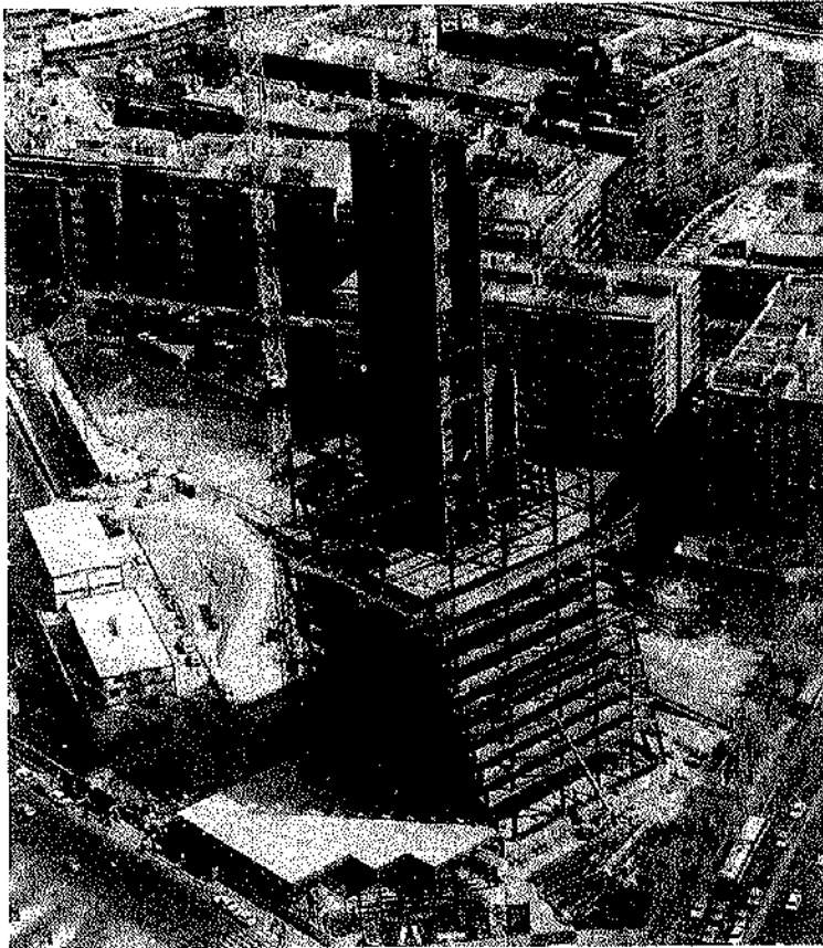
Fig. 8. Montaje estructura metálica.
