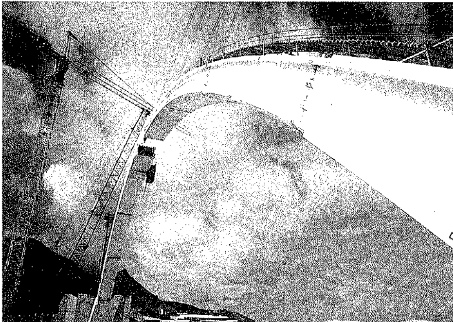
Figura 8. Montaje arco metálico. Fase anterior al cierre.
