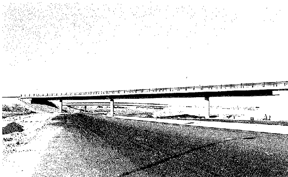
Fig. 8. Vista general de la E-1.
