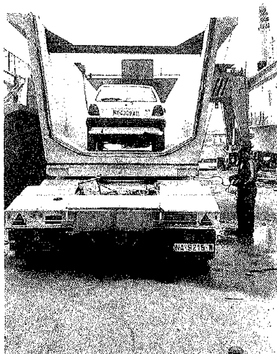
Foto 1. Preparación del transporte de una viga para un acueducto en Calanda (Teruel). Longitud: 25 m. Sección \approx 6 \text{ m}^2 .
