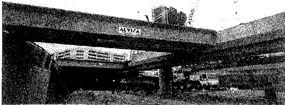
Fig. 4. Montaje de las vigas prefabricadas sobre la viga de apoyo.
