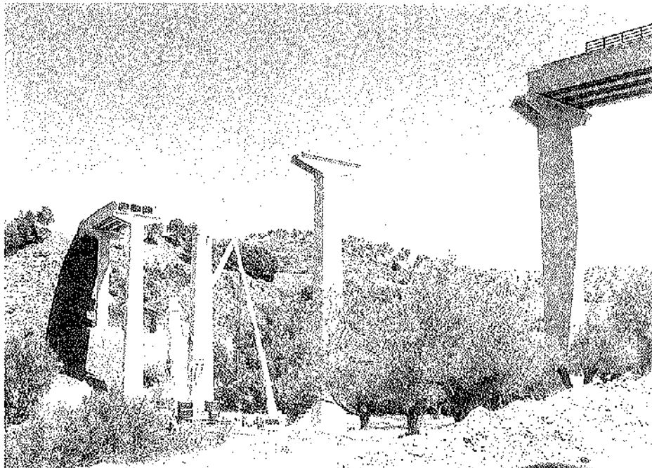
Foto 20. Aspecto del viaducto de Montoro durante el montaje de una de sus pilas prefabricadas.
