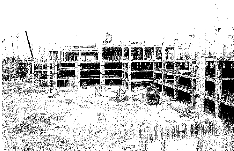
Fig. 10. Edificio prefabricado, con estructura de nudos rígidos.
