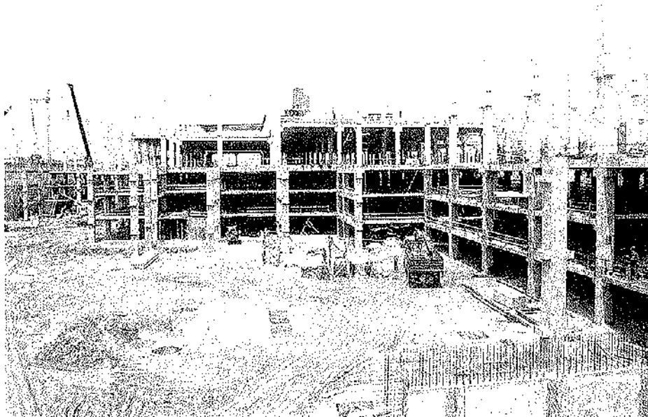
Fig. 10. Edificio prefabricado, con estructura de nudos rígidos.
