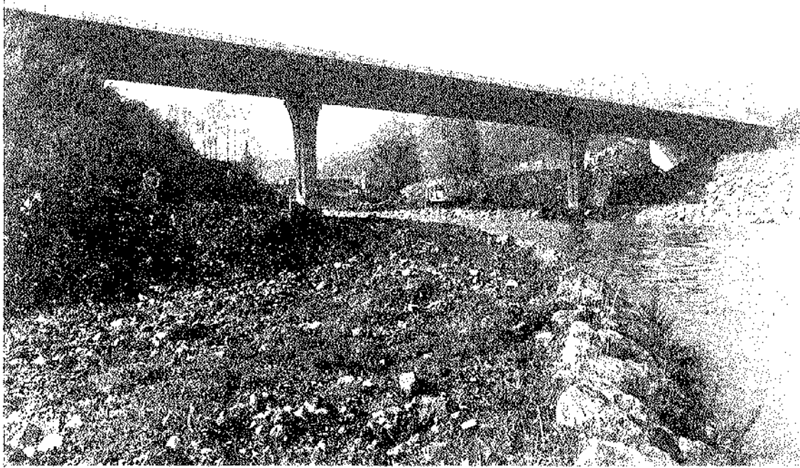
Fig. 5. Paso sobre el río Cadagua, en Zalla (Vizcaya). Luces 25/30/25, canto de viga 1,30 m, ancho tablero 13 m.
