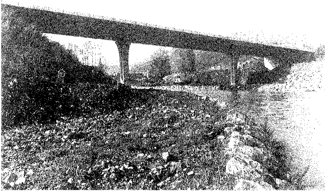
Fig. 5. Paso sobre el río Cadagua, en Zalla (Vizcaya). Luces 25/30/25, canto de viga 1,30 m, ancho tablero 13 m.
