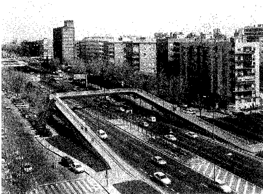
Fig. 7. Vista aérea de la pasarela.
