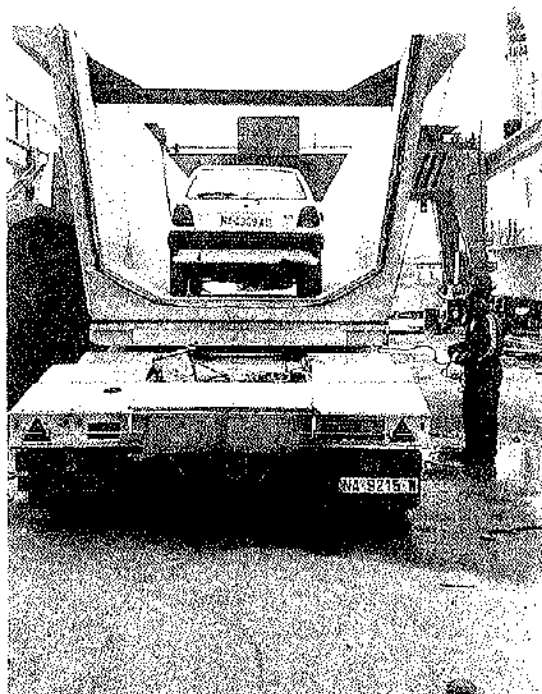
Foto 1. Preparación del transporte de una viga para un acueducto en Calanda (Teruel). Longitud: 25 m. Sección \approx 6 \text{ m}^2 .
