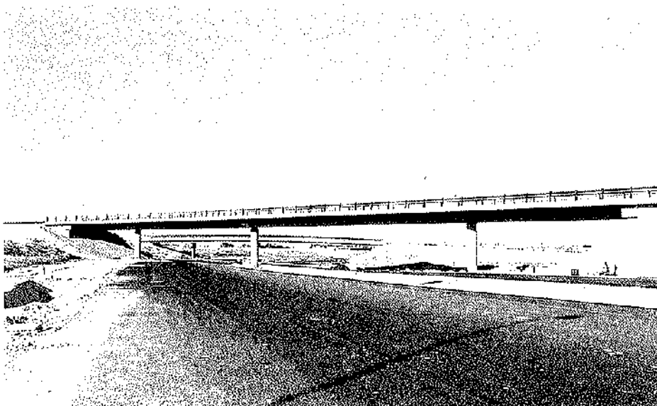
Fig. 8. Vista general de la E-1.
