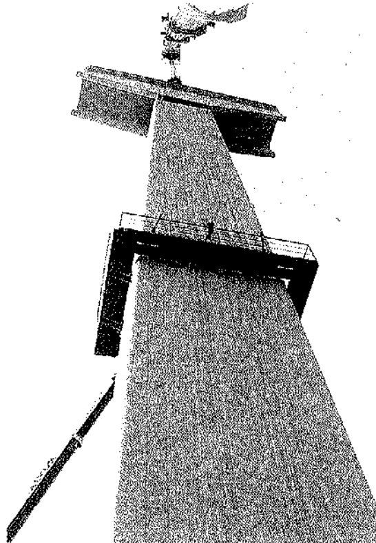
Foto 19. Pila prefabricada de 45 m de altura en el viaducto de Montoro (Córdoba).
