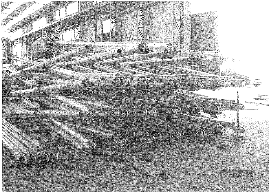
Fig. 29. Montaje de las primeras filas de barras.
