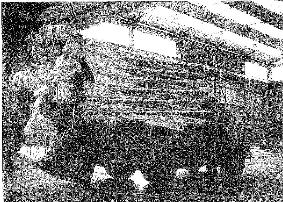
Fig. 38. Paquete plegado, con la cubierta incluida, preparado para su transporte a obra.
