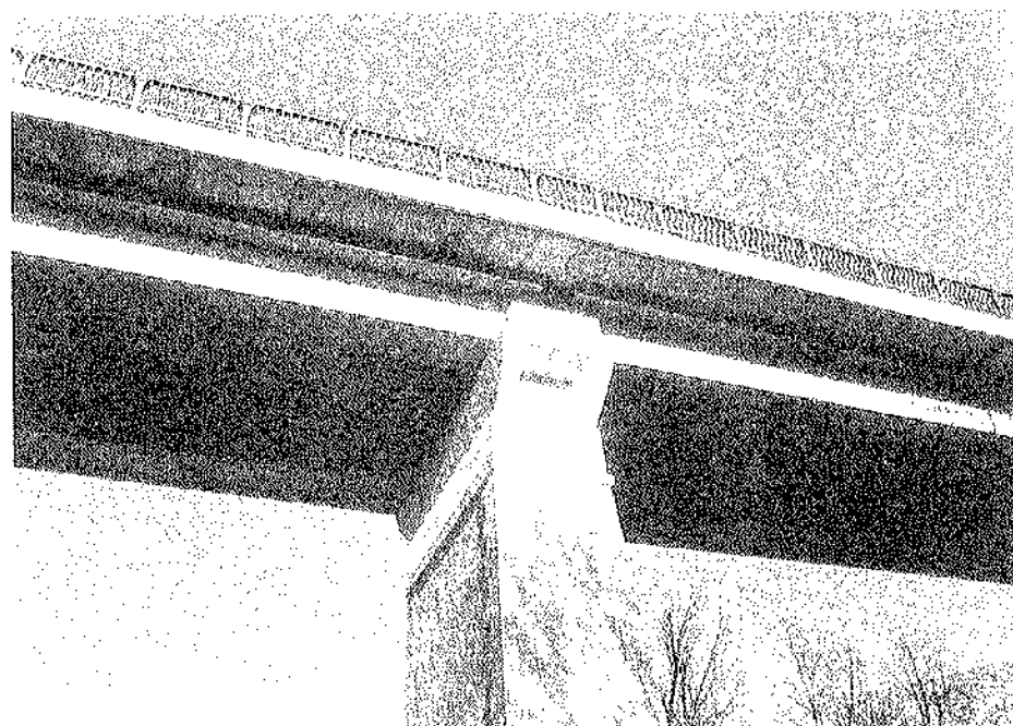
Figura 2. Detalle de dintel prefabricado por PACADAR.
