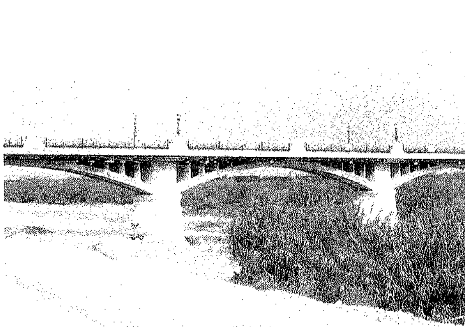
Figura 13. Puente rehabilitado terminado.
