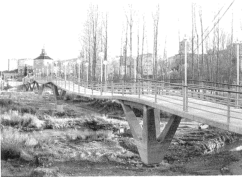
Foto 6. Pasarela en Almazán (Soria).
