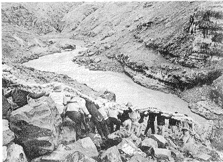
Foto 2. Reconstrucción moderna de un puente colgante en el Perú. Trasladando los cables. (Fotos 2 a 4 tomadas de National Geographic , Dec. 1973).
