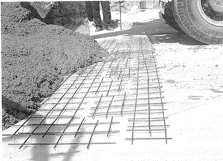
Foto nº 1. Mallazos situados en el suelo.
