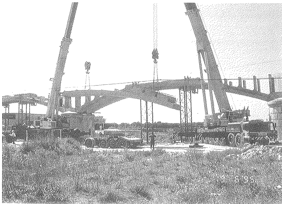
Fig. 4 Montaje de los semiarcos.
