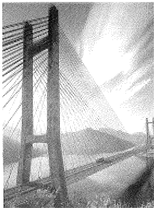
Foto 1. Puente sobre el embalse de Barrios de Luna. Luz: 440 m. Construcción 1979-1983.
