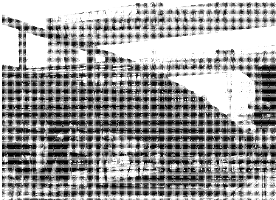
Fig. 3 Ferralla del arco en el parque de fabricación.
