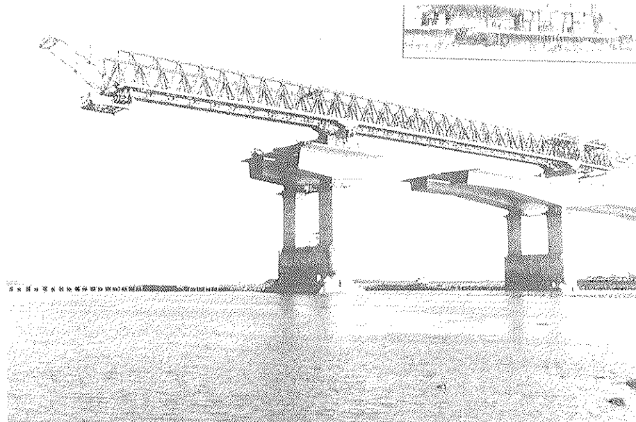
Fig. 9. 2º Puente de Severn.
