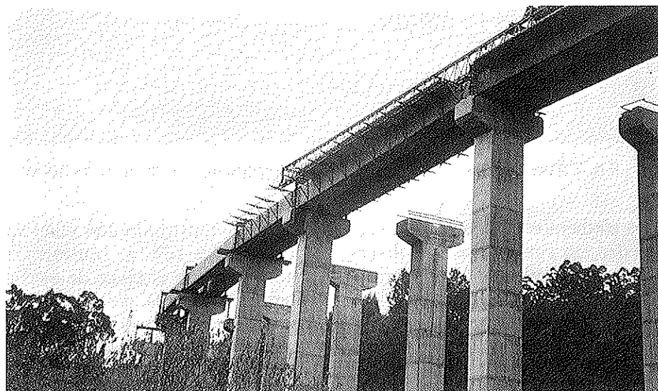
Fig. 9 Puente sobre el río Lambre. Vista general.
