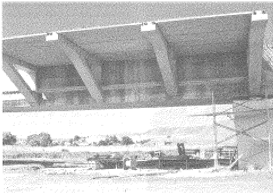
Fig. 6. Puentes sobre el río Tormes. Detalle de Jabalcones prefabricados.
