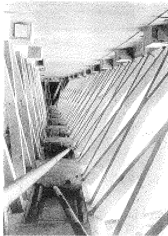
Fig. 15. Pretensado exterior. Puesto de Sylans.
