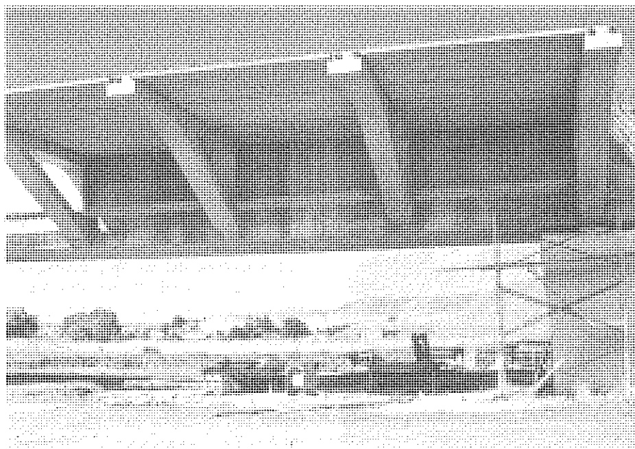
Fig. 6. Puente sobre el río Tormes. Detalle de Jabalcones prefabricados.
