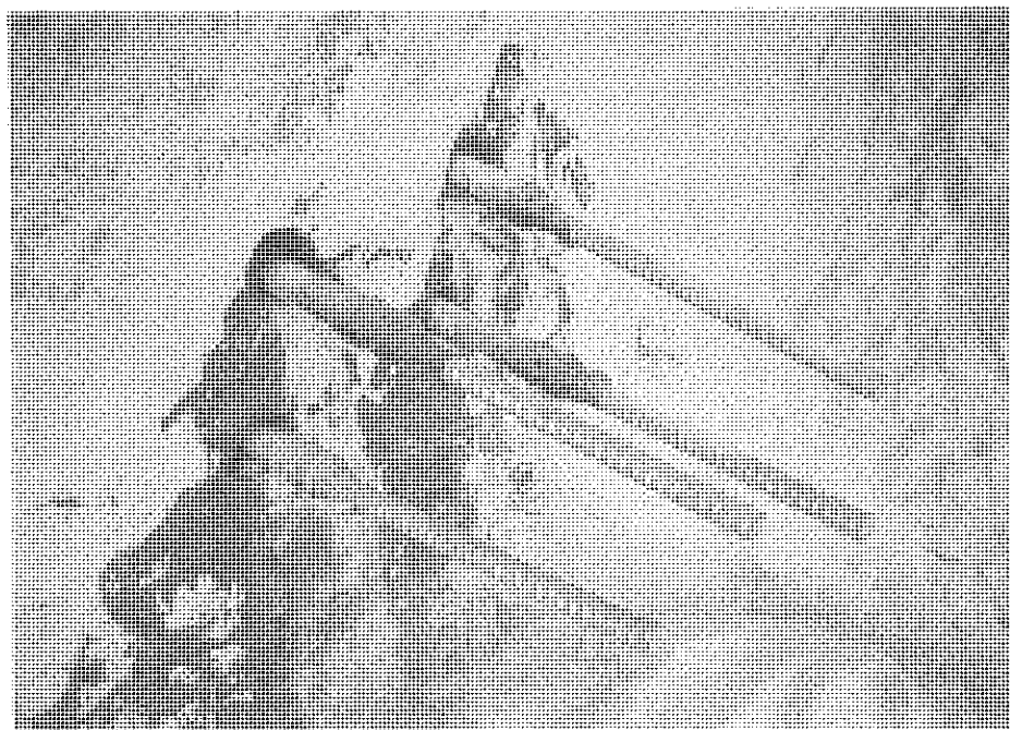
Fig. 11. Ejecución de los anclajes a roca.
