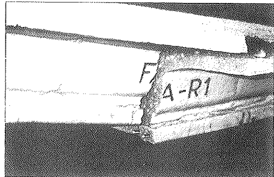
Forjado armado con refuerzo superior. Rotura por agotamiento de la armadura de tracción.
