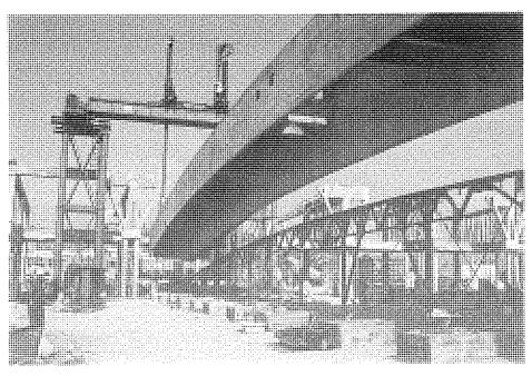
Foto 4. Vista del izado de las vigas.
