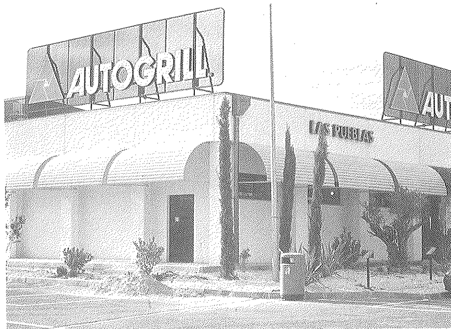
Fig. 8 Edificio terminado. Vista general.
