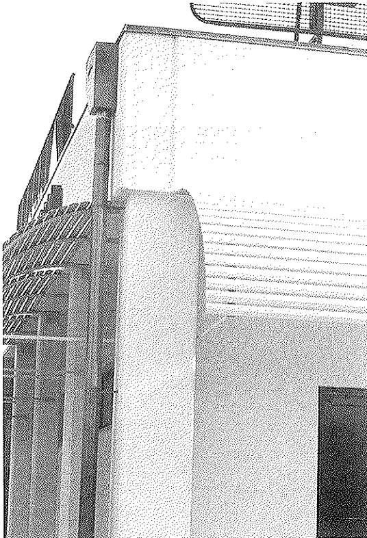
Fig. 9 Edificio terminado. Detalle.
