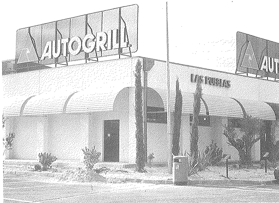
Fig. 8 Edificio terminado. Vista general.
