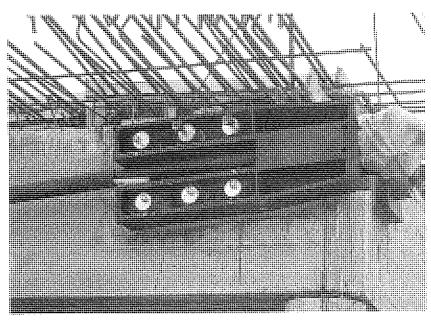
Fig. 9. Anclaje activo en viga extrema.
