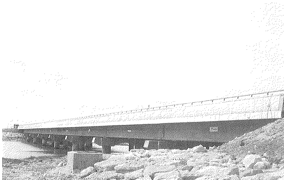
Fig. 12. Fotografía del puente completamente terminado.
