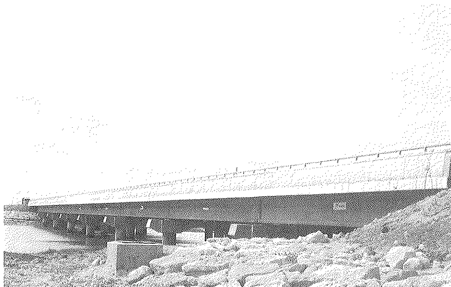
Fig. 12. Fotografía del puente completamente terminado.
