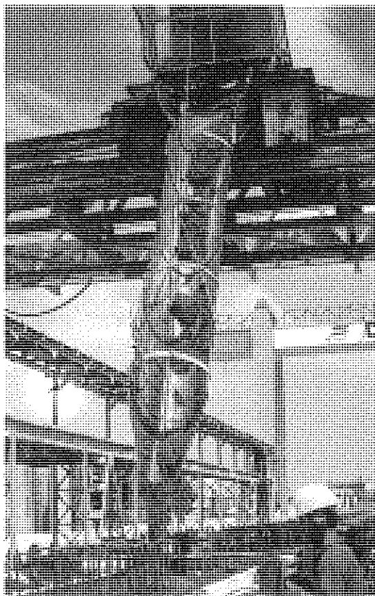
Fig. 8. Fotografías del proceso del hormigonado de las vigas con HAR.
