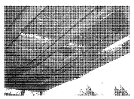
Fig. 11. Vista inferior de la ampliación de la losa.
