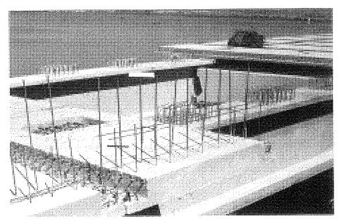
Fig. 7. Fotografía de las uniones entre losas y vigas en el tablero.
