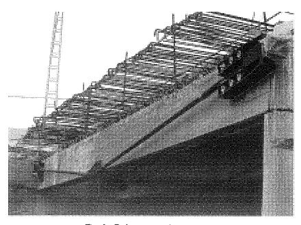
Fig. 8. Refuerzo en viga extrema.
