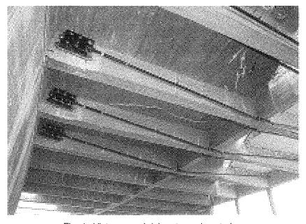
Fig. 4. Vista general del pretensado exterior.
