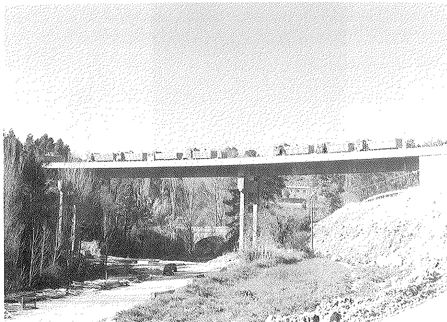
Fig. 27. Prueba de carga de la sección de apoyo en pilas. ¡El pretensado exterior funciona!
