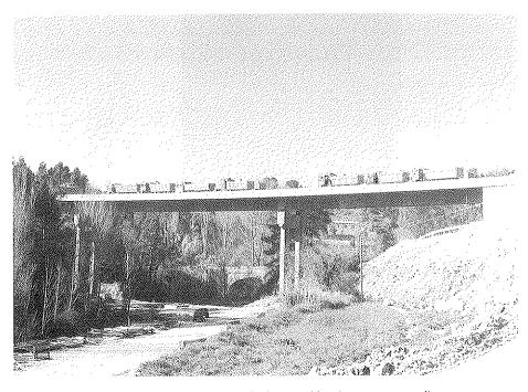
Fig. 27. Prueba de carga de la sección de apoyo en pilas. ¡El pretensado exterior funciona!
