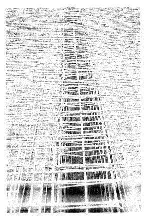
Fig. 17. Vista superior del alma antes del hormigonado. La ausencia de vainas permite una fácil puesta en obra del hormigón.
