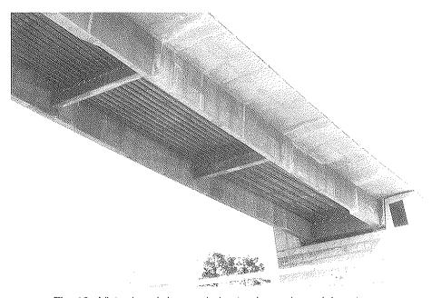
Fig. 18. Vista dorsal de una de las traviesas de anclaje extremo de los tendones de pretensado.
