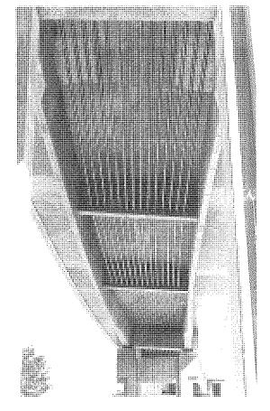
Fig. 8. Vista inferior del vano central. Nótese la curvatura en planta del tablero, el trazado poligonal del pretensado y las traviesas de desviación.
