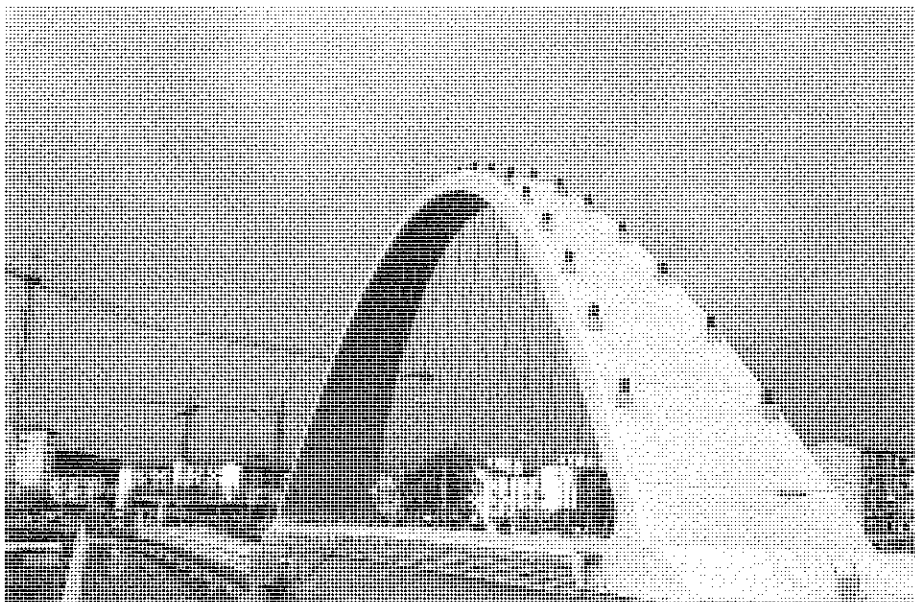
Fig. 4. Vista del puente acabado.
