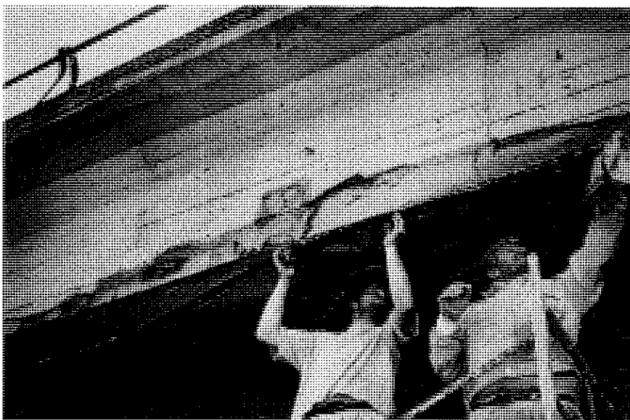
Figura 11. Aplicación de las láminas de material compuesto con resina epoxídica.
