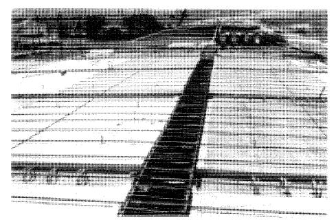
Figura 5. Nervio longitudinal antes de su hormigonado.
