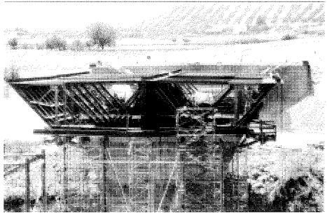
Figura 9. Colocación de los primeros tramos metálicos.
