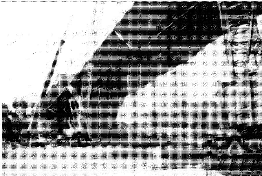
Figura 12. Vista general de la construcción.
