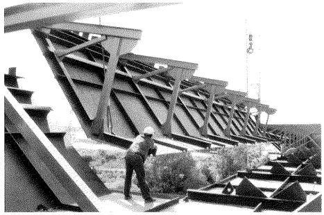
Figura 11. Ensamblaje de una dovela.
