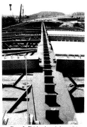
Figura 3. Platabanda central y nervios transversales pretensados.
