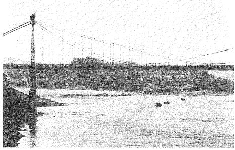
Foto 4. Puente colgante en China con sistema dual de cables (tomada de Mao Yisheng, *Puentes en China, antiguos y nuevos*, Beijing, 1980)
