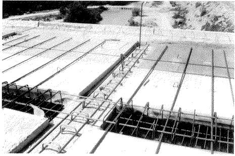
Figura 4. Placas prefabricadas apoyadas en nervios transversales.
