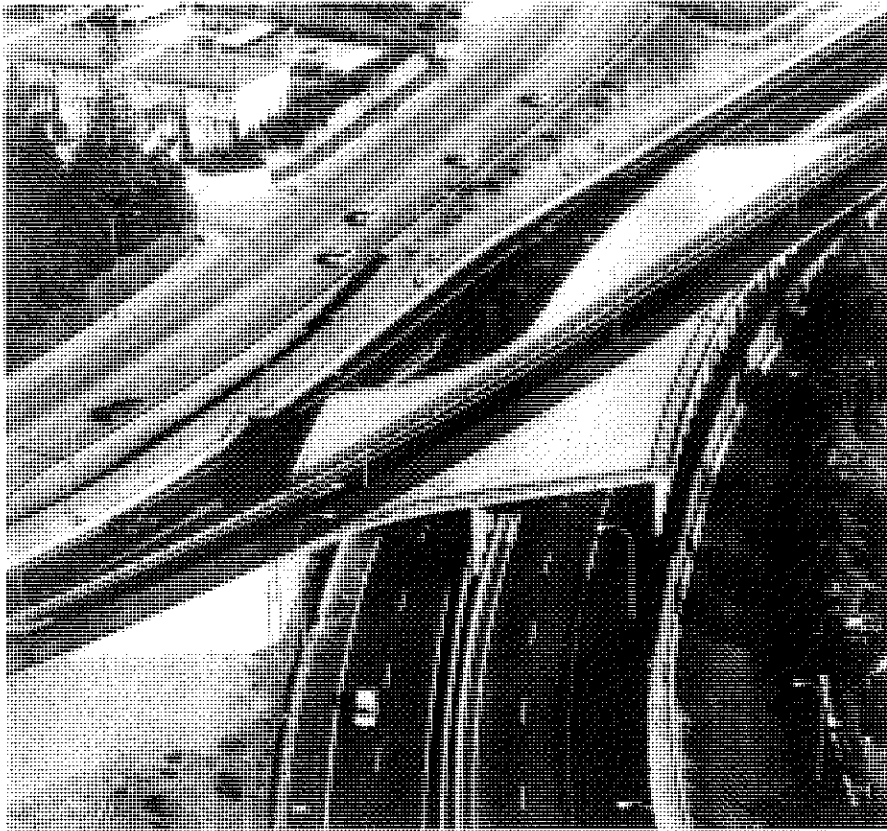
Figura 7. Vista aérea de la estructura sobre la Avenida de la Ilustración.
