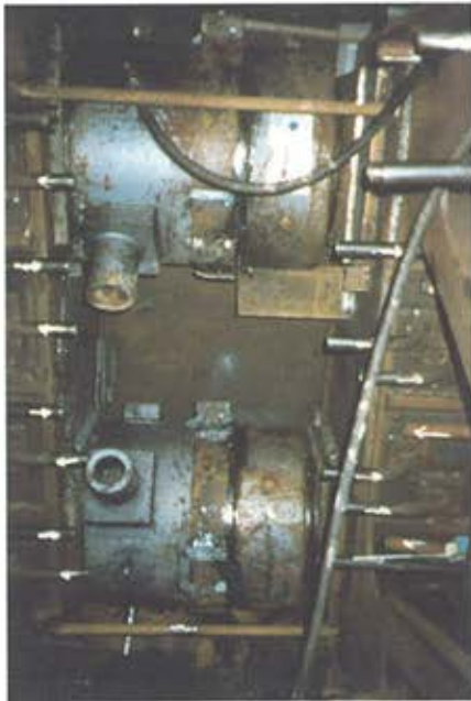
Figura 36. Gatos en el interior de la clave. Figure 36. Jacks inside the key member.
