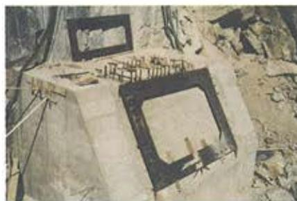
Figura 25. Estribo del arco con plantilla.
