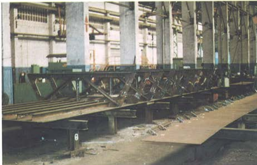
Figura 20. Fabricación de tableros. Figure 20. Deck segment manufacture.
