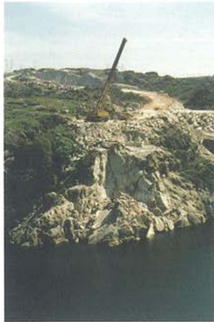
Figura 24. Excavación de los estribos. Figure 24. Abutment excavation.
