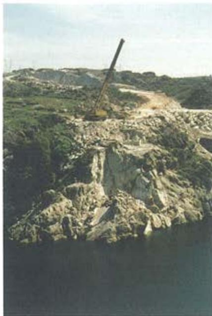
Figura 24. Excavación de los estribos.
