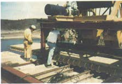
Figura 38. Colocación de forjados. Figure 38. Positioning deck slabs.
