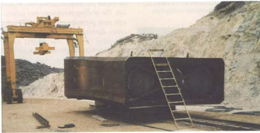
Figura 27. Tramo de arco en obra. Figure 27. Arch span on site.
