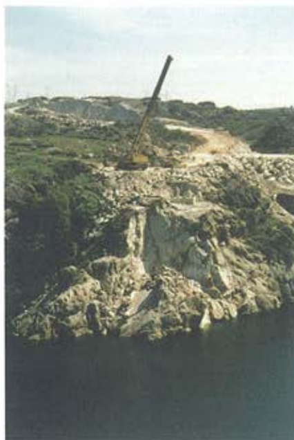
Figura 24. Excavación de los estribos. Figure 24. Abutment excavation.
