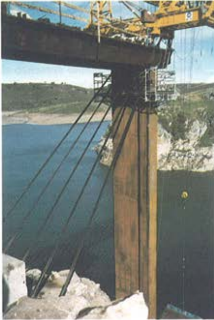
Figura 29. Retenidas ancladas a roca. Fig. 29. Back cables anchored to the rock.
