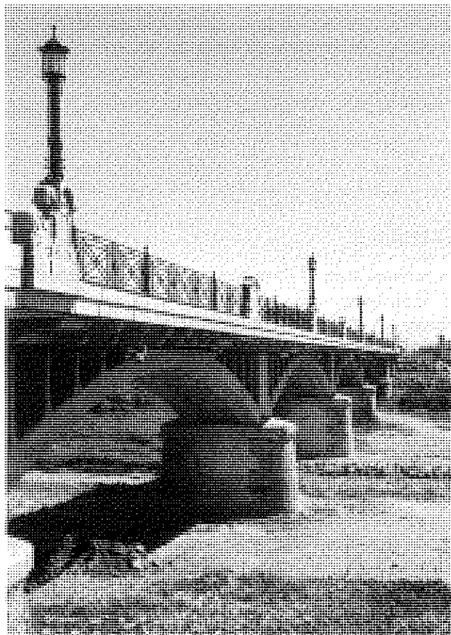
Figura 29. Aspecto final del puente.
