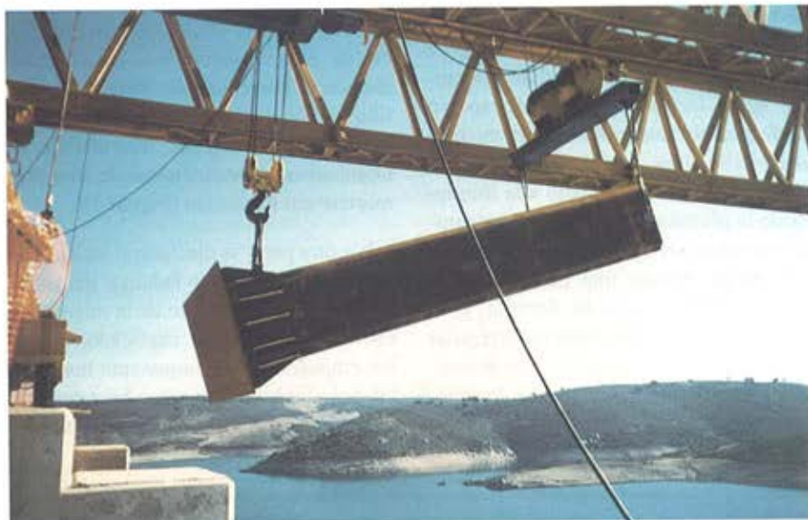
Figura 28. Lanzamiento de pila 1. Figure 28. Positioning pier 1.
