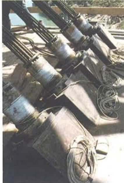
Figura 30. Anclaje de retenidas en el tablero.
