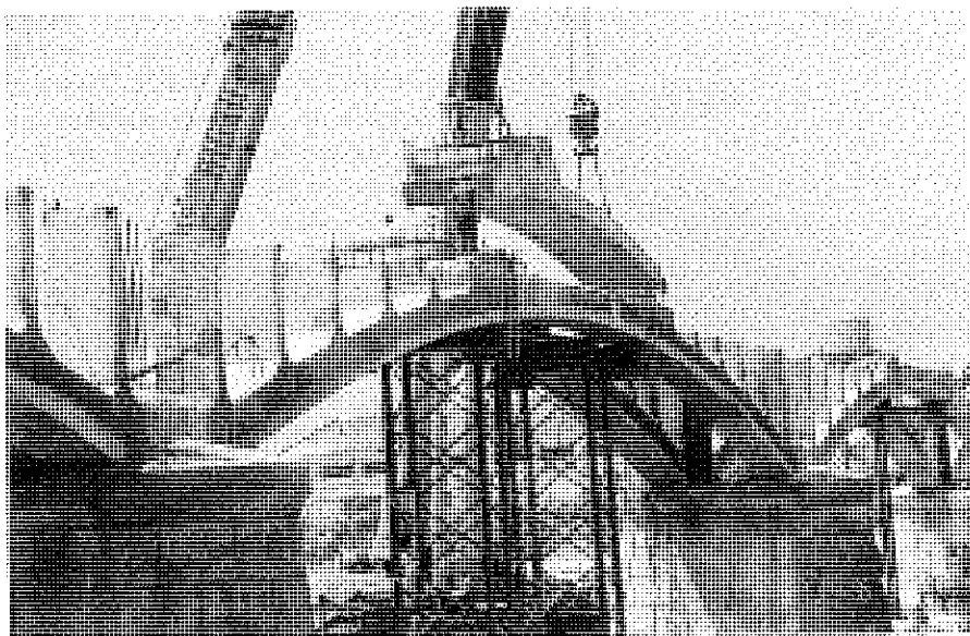
Figura 24. Montaje de arcos.
