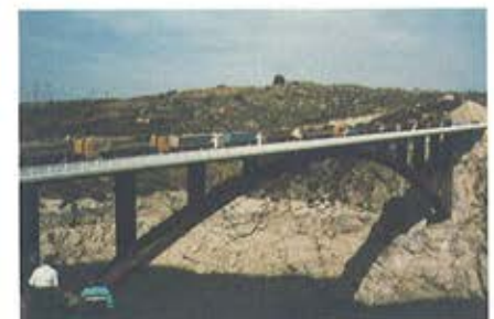
Figura 40 Prueba de carga. Figure 40 Load test.
