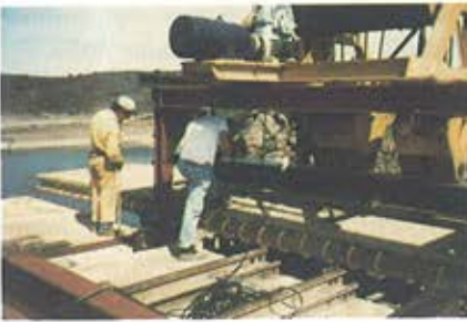
Figura 38. Colocación de forjados. Figure 38. Positioning deck slabs.
