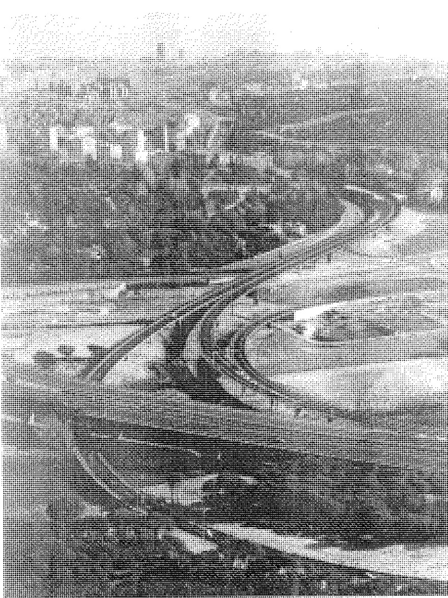
Figura 1 - Vista aérea del enlace de la Zarzuela.
