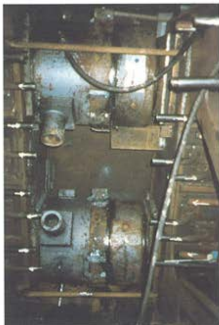
Figura 36. Gatos en el interior de la clave. Figure 36. Jacks inside the key member.
