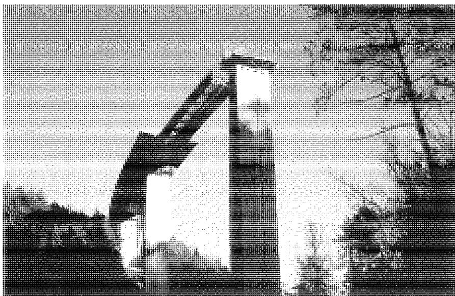
Figura 3. Viaducto en construcción. Empuje de tablero.
