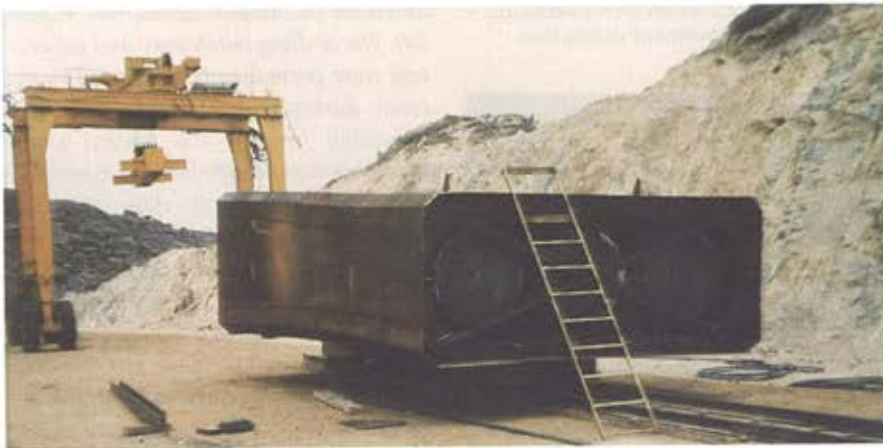
Figura 27. Tramo de arco en obra. Figure 27. Arch span on site.
