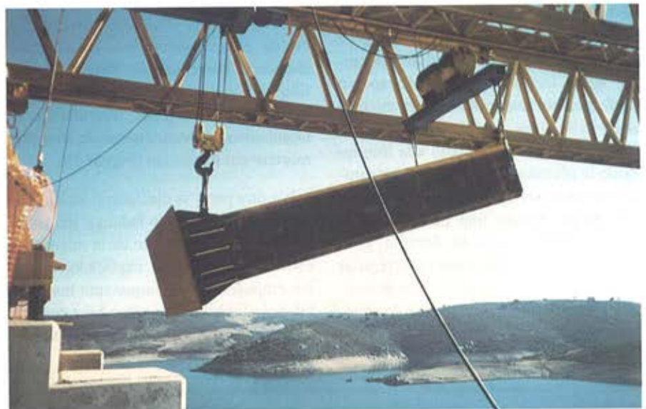
Figura 28. Lanzamiento de pila 1. Figure 28. Positioning pier 1.
