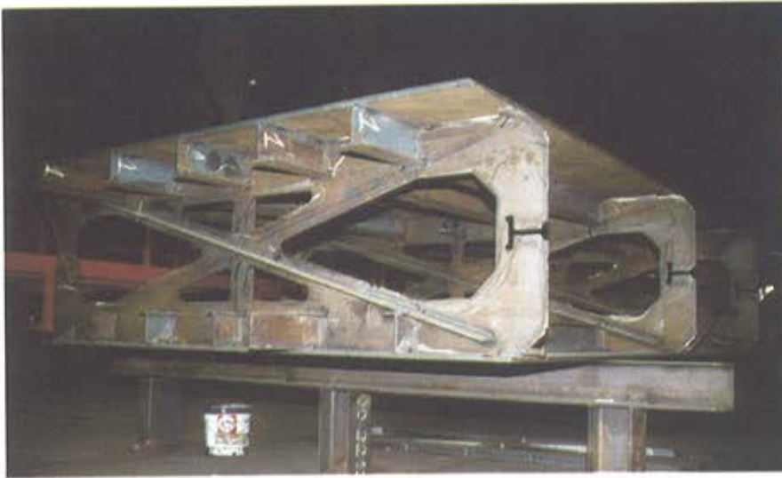
Figura 22. Fabricación de pilas. Figure 22. Pier production.
