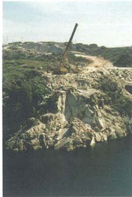
Figura 24. Excavación de los estribos. Figure 24. Abutment excavation.
