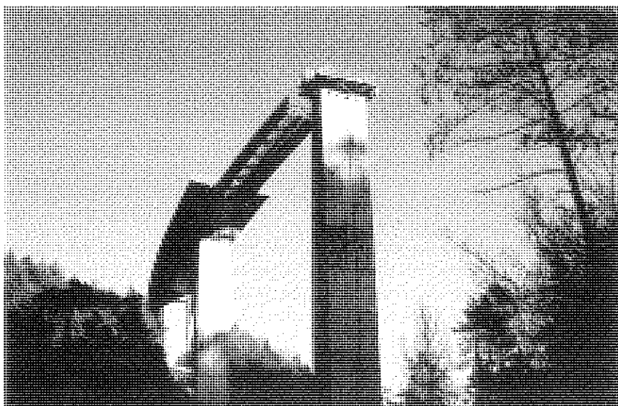
Figura 3. Viaducto en construcción. Empuje de tablero.
