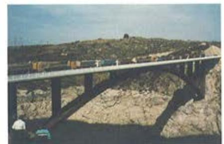
Figura 40 Prueba de carga.
