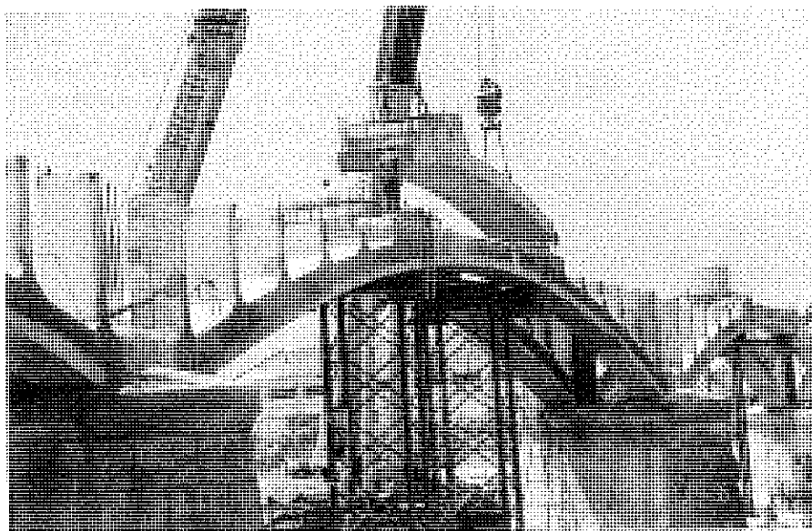
Figura 24. Montaje de arcos.
