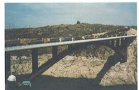
Figura 40 Prueba de carga. Figure 40 Load test.
