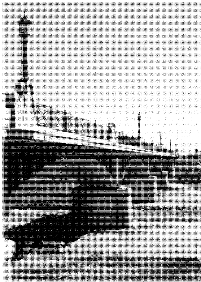
Figura 29. Aspecto final del puente.
