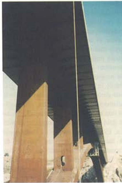
Figura 39. Vista del forjado desde abajo. Figure 39. View of the deck from below
