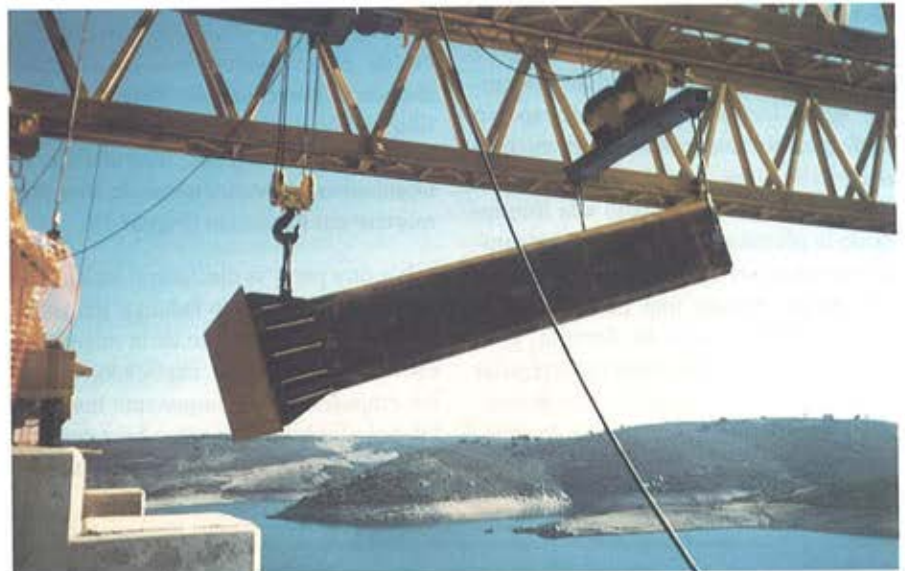
Figura 28. Lanzamiento de pila 1. Figure 28. Positioning pier 1.
