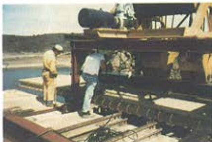
Figura 38. Colocación de forjados. Figure 38. Positioning deck slabs.
