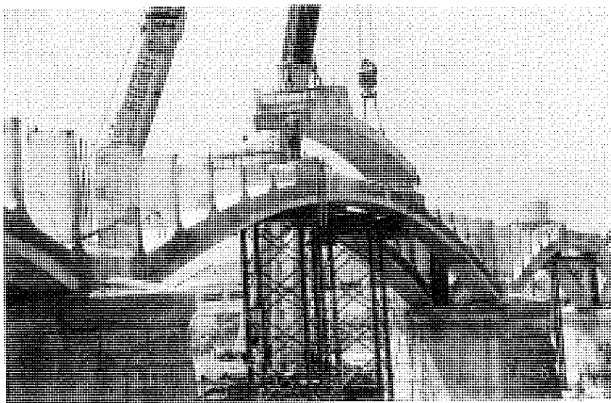
Figura 24. Montaje de arcos.
