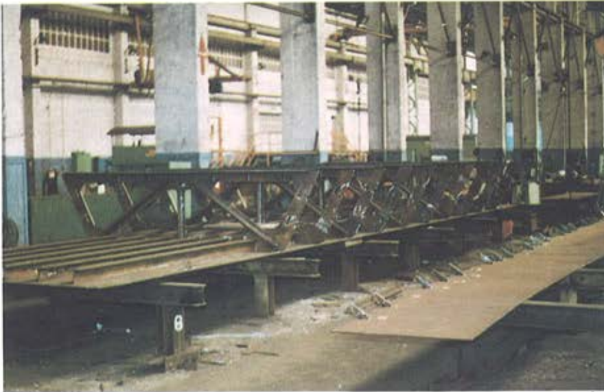
Figura 20. Fabricación de tableros. Figure 20. Deck segment manufacture.
