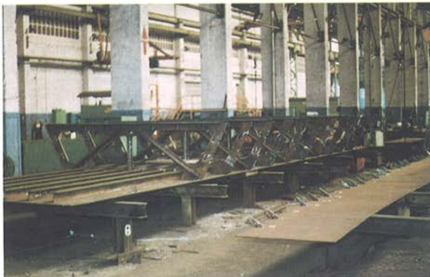
Figura 20. Fabricación de tableros. Figure 20. Deck segment manufacture.
