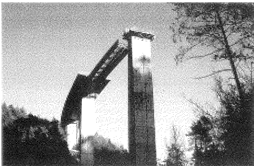
Figura 3. Viaducto en construcción. Empuje de tablero.
