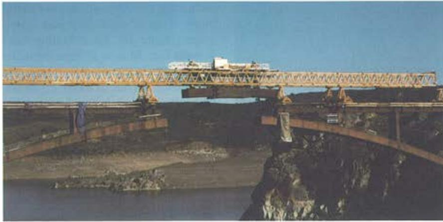
Figura 34. Lanzamiento del tramo de clave.
