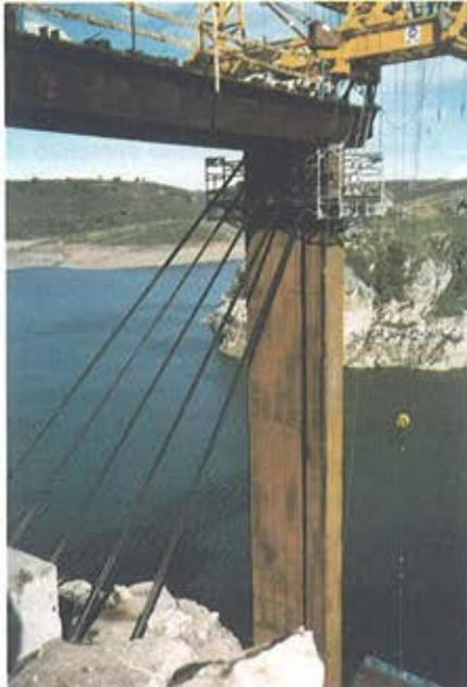
Figura 29. Retenidas ancladas a roca.
