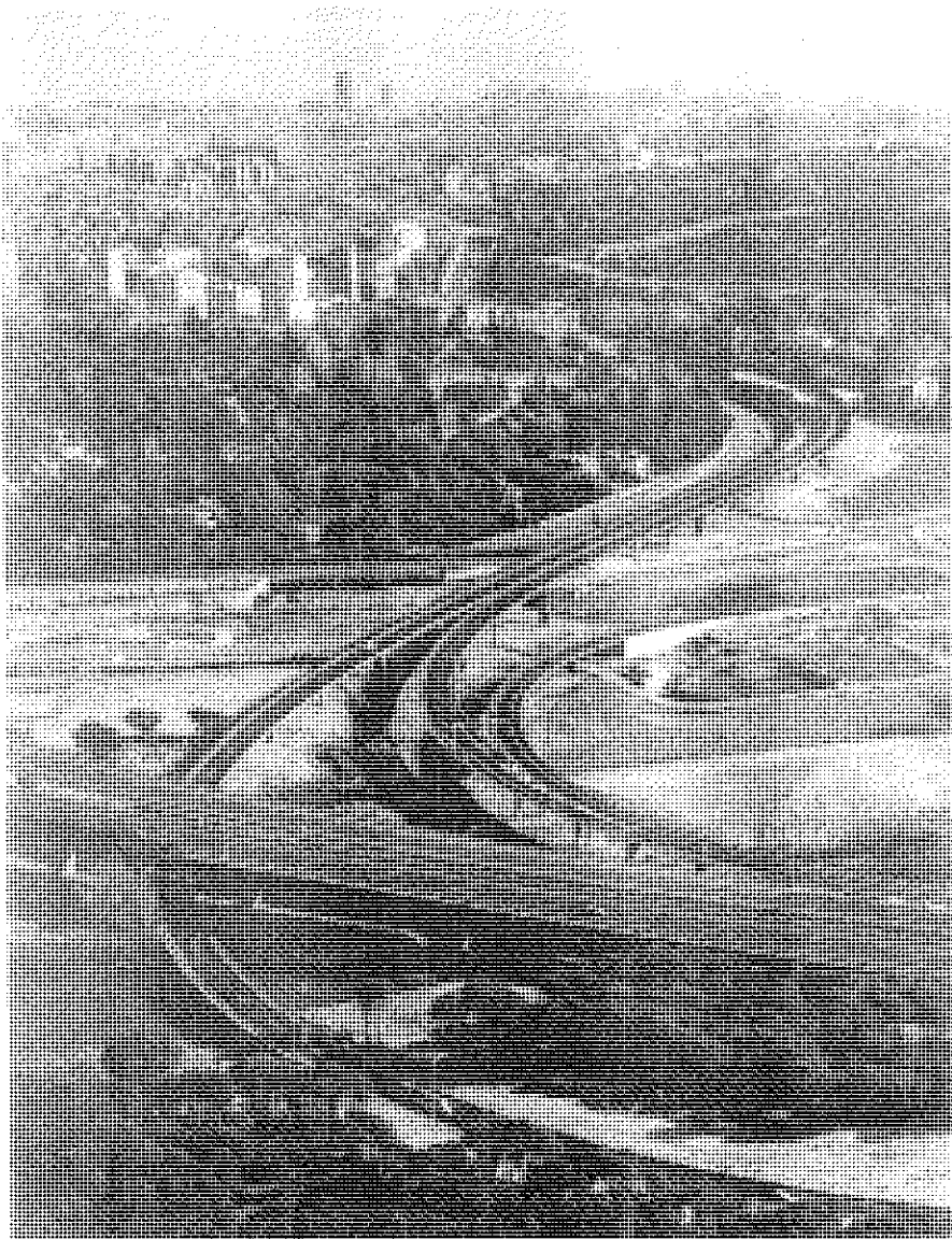
Figura 1 – Vista aérea del enlace de la Zarzuela.
