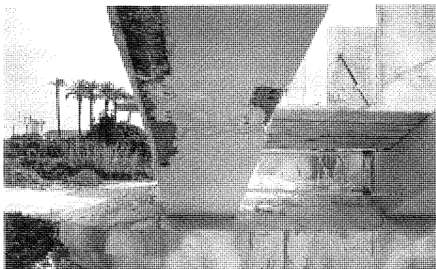
Figura 12. Estado de las pletinas inferiores.
