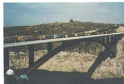
Figura 40 Prueba de carga. Figure 40 Load test.
