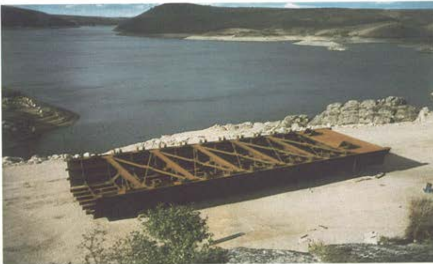
Figura 26. Tramo de tablero en obra. Figure 26. Deck span on site.
