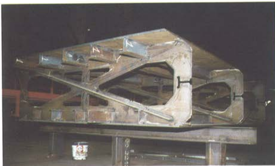
Figura 22. Fabricación de pilas. Figure 22. Pier production.
