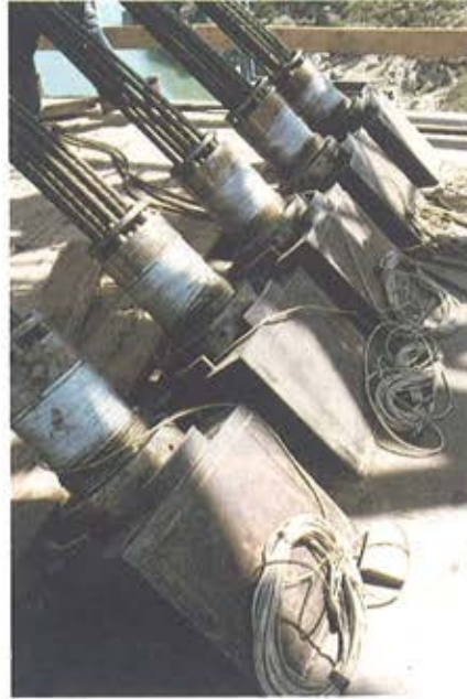
Figura 30. Anclaje de retenidas en el tablero. Figure 30. Anchorage for back cables at the deck.
