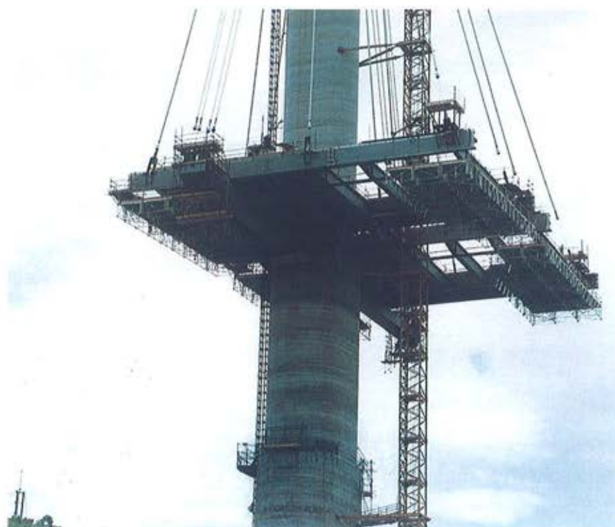
Figura 19. Montaje de viga separadora y primer panel. Figure 19. Erection of strut and first panel.
