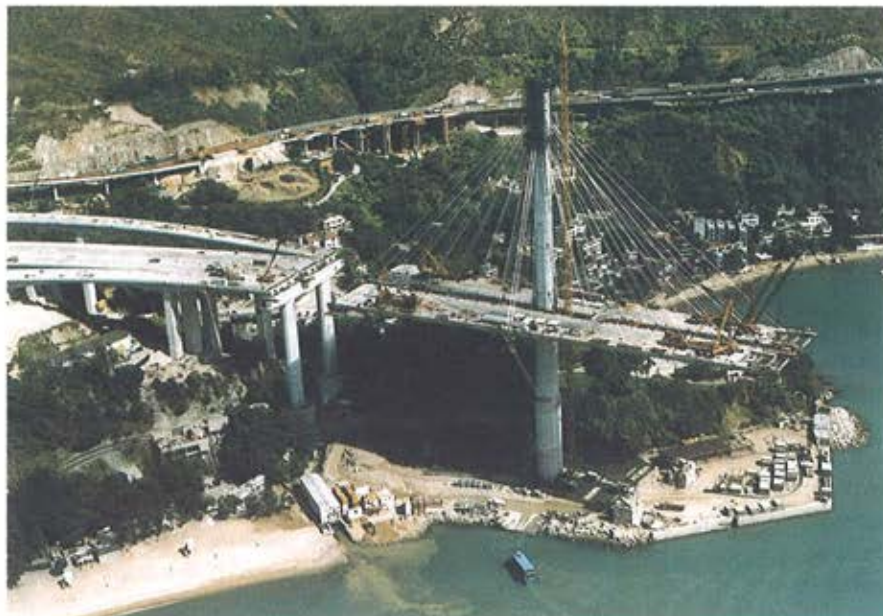
Figura 20. Mástil de Ting Kau. Construcción del tablero en voladizo. Figure 21. Ting Kau mast. Cantilever deck construction.
