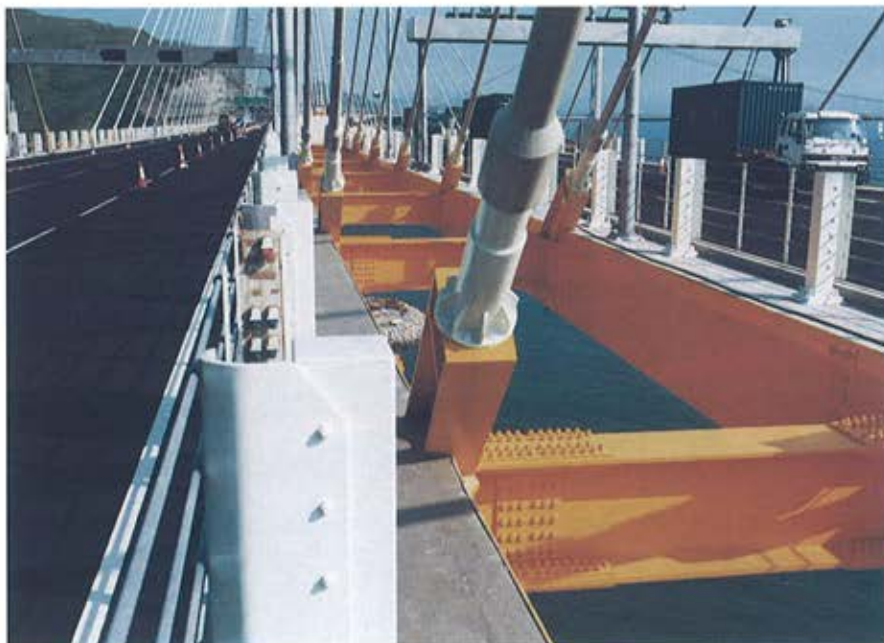
Figura 23. Vista del tablero terminado. Figure 23. View of finished deck.
