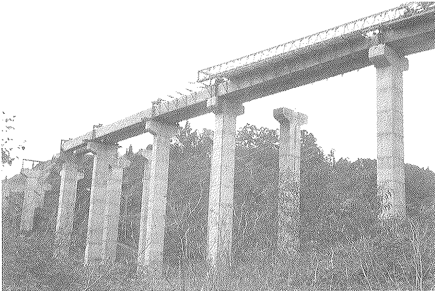
Fig. 5. Proceso de lanzamiento de vigas.
