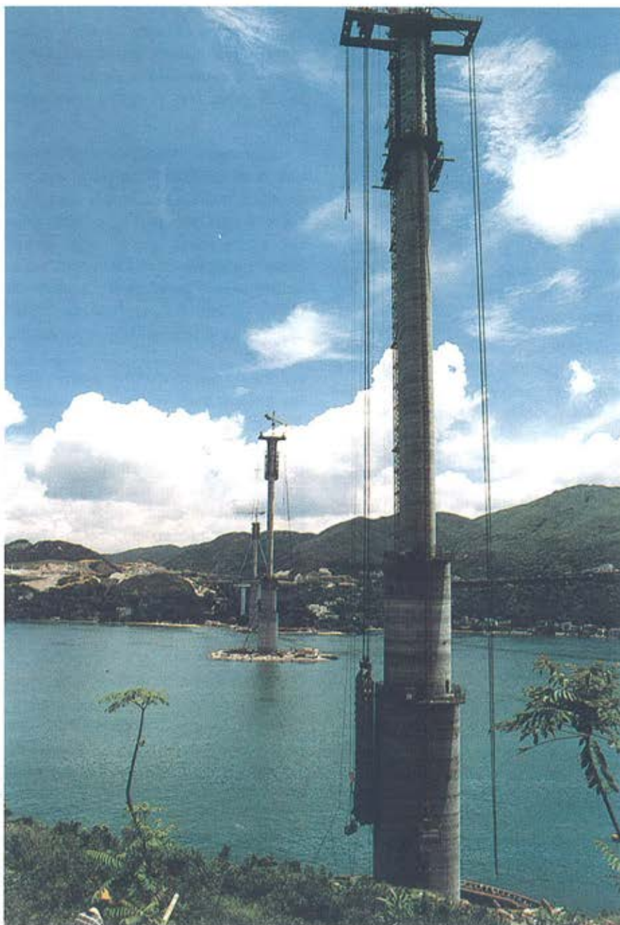
Figura 18. Izado de cabeza metálica y panel de arranque. Figura 18. Heavy lifting for steel head and starter panel.
