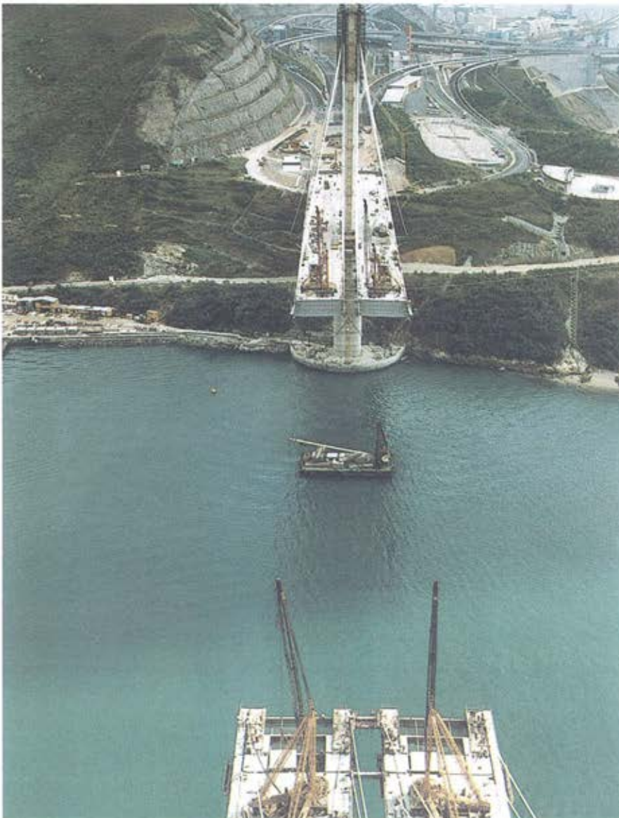
Figura 21. Montaje de paneles típicos. Figure 21. Typical deck panel erection.
