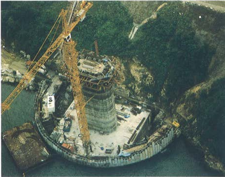
Figura 17. Mástil de Tsing Yi. Cimentación y deslizado del fuste. Figure 17. Tsing Yi mast. Foundation and shaft sliding.
