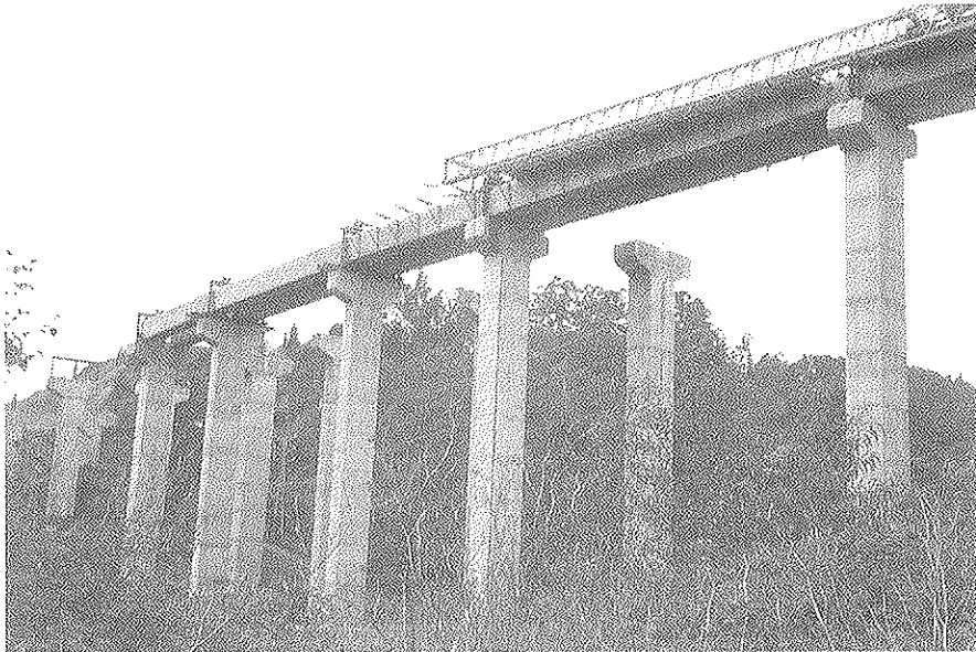
Fig. 5. Proceso de lanzamiento de vigas.
