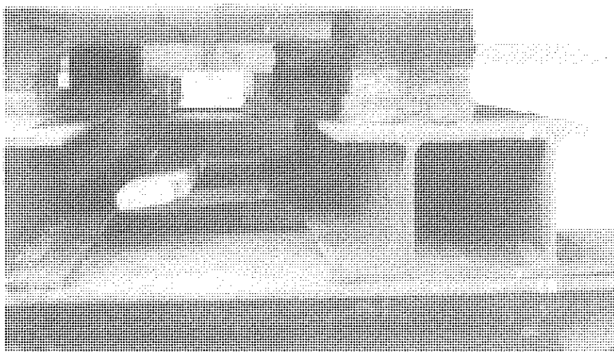
Fig. 12. Apoyo provisional en el instante del desapego.
