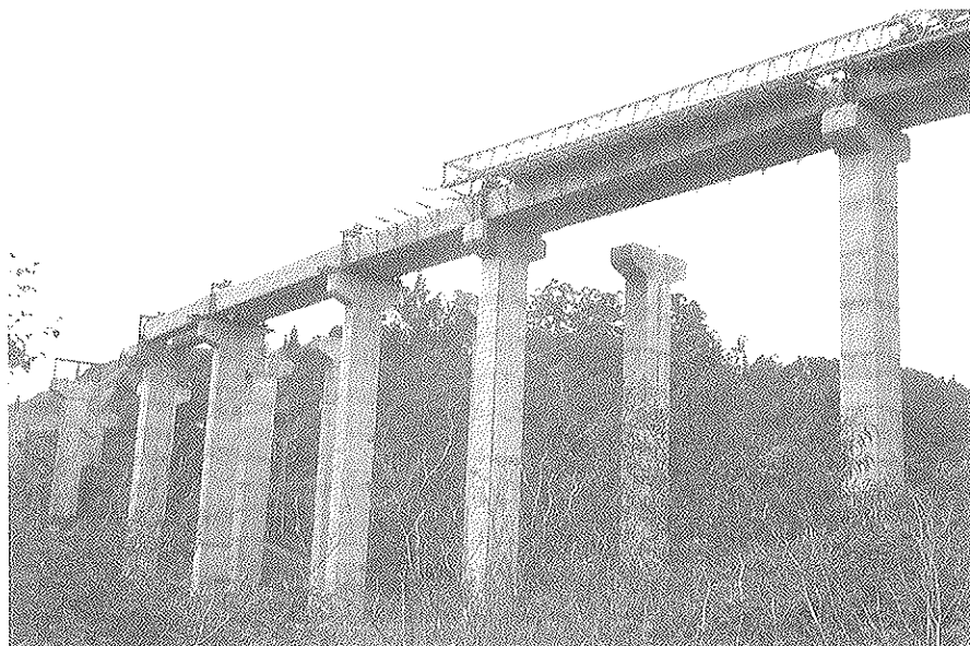
Fig. 5. Proceso de lanzamiento de vigas.
