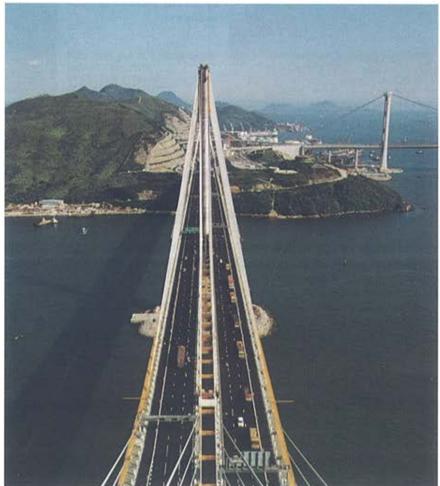
Figura 24. Vista aérea desde el mástil de Ting Kau. Figure 24. Upper view from Ting Kau mast.
