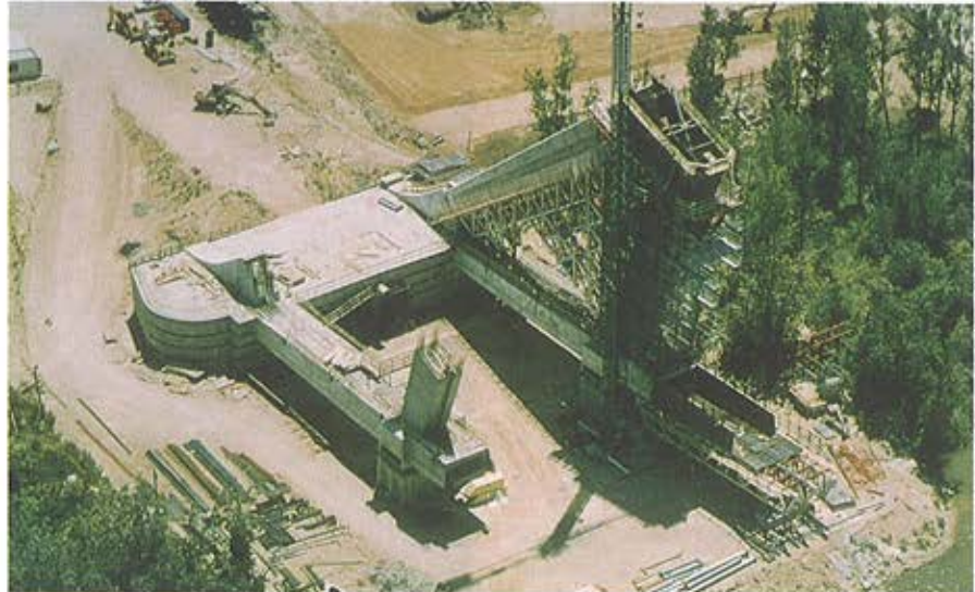
Foto 2. El contrapeso, y los arranques de las células laterales, con la de aguas abajo en fase avanzada de construcción ya que sólo se empleó un equipo de cimbra y carro de mástil. Figure 2. The counterweight and the beginning of the lateral cells. The downstream cell is more advanced than the upstream one, because only one equipment for centering was used.
