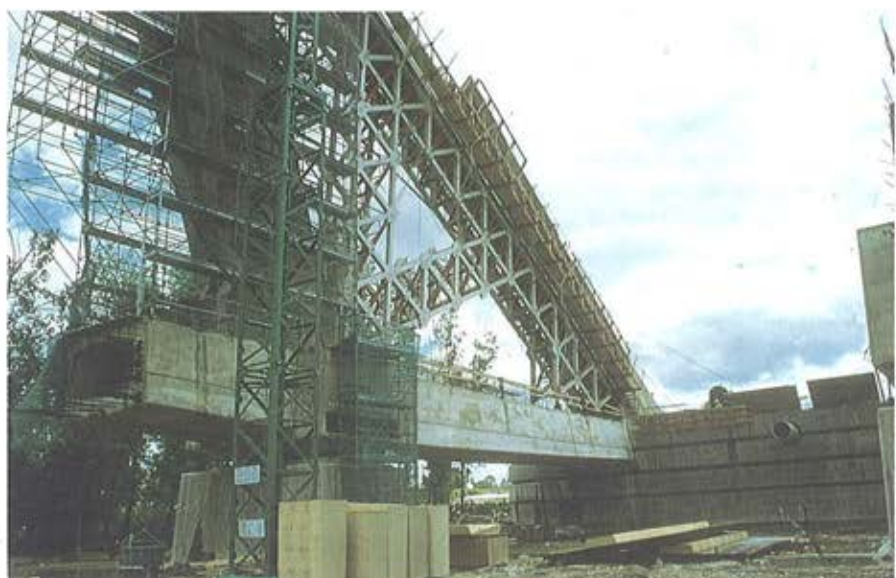
Foto 4. Vista de la cimbra de la vela inclinada.
