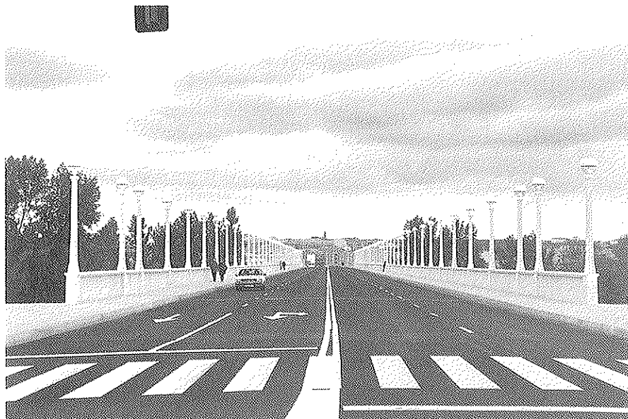
Figura 11. Vista superior de la plataforma terminada.
