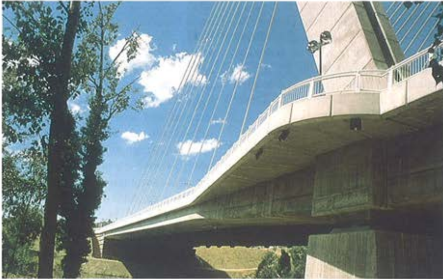
Figura 13. Vista del borde del tablero en la base del mástil. Figure 13. View of the edge of the deck in the zone of the pylon.
