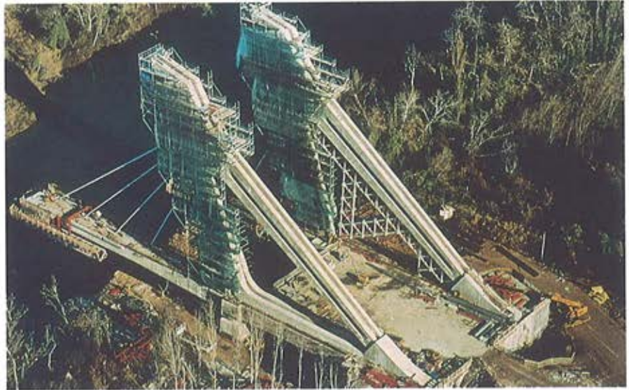
Foto 5. Construcción de nervios de borde por avance en voladizo sobre carros móviles, fabricando dovelas de 9 metros de longitud.
