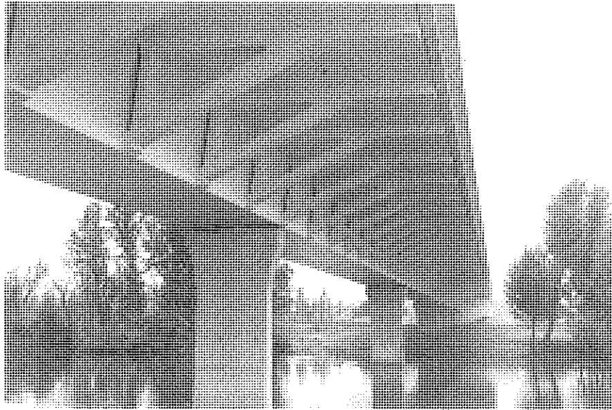
Figura 13. Vista inferior lateral del puente.
