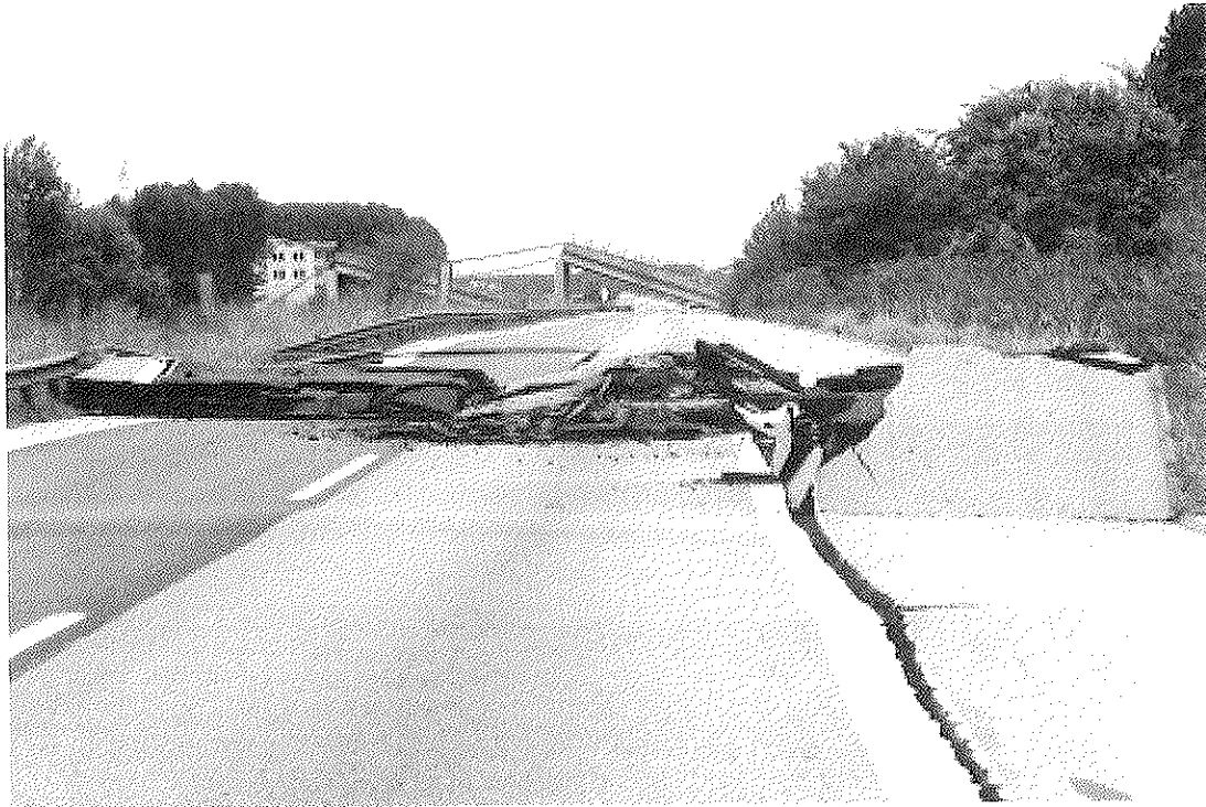
Foto 24. Traza de la falla que deteriora la calzada de una carretera.
