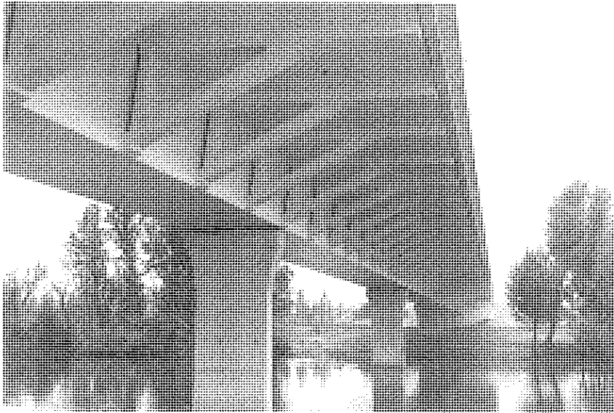
Figura 13. Vista inferior lateral del puente.
