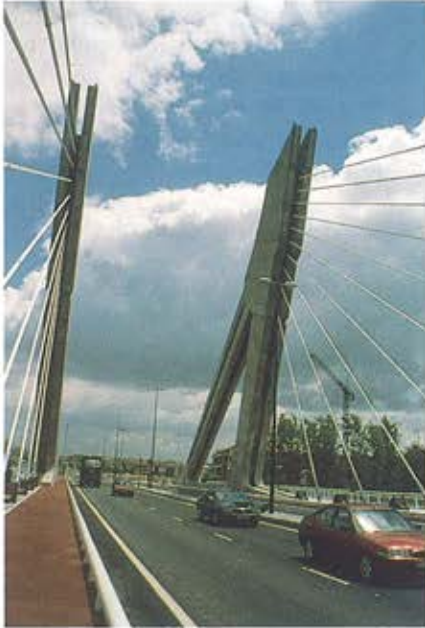
Figura 11. Los pórticos de hormigón vistos desde el vano principal. En la cabeza del mástil el rehundido central permite integrar al máximo los tirantes que allí se anclan. Figure 11. The elevated concrete frames seen from the main span. In the head of the inclined pylons, the central groove helps to visually integrate the stays that are anchored there.
