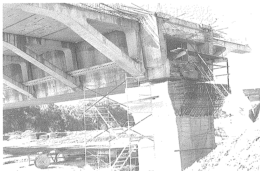
Figura 10. Pastilla de apoyo del tablero en estribos.
