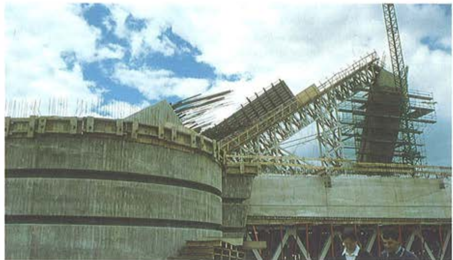
Foto 3. La superficie del contrapeso con el nervio de borde del tablero y los arranques de velas inclinadas. Figure 3. The counterweight's surface with the border girder of the deck and the springing of the inclined sail.
