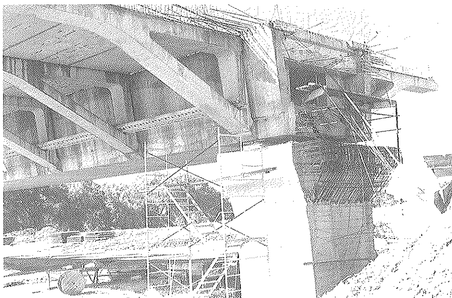
Figura 10. Pastilla de apoyo del tablero en estribos.
