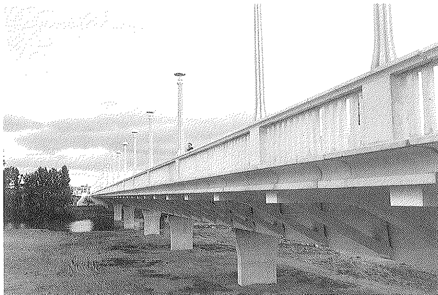
Figura 12. Vista general del puente.
