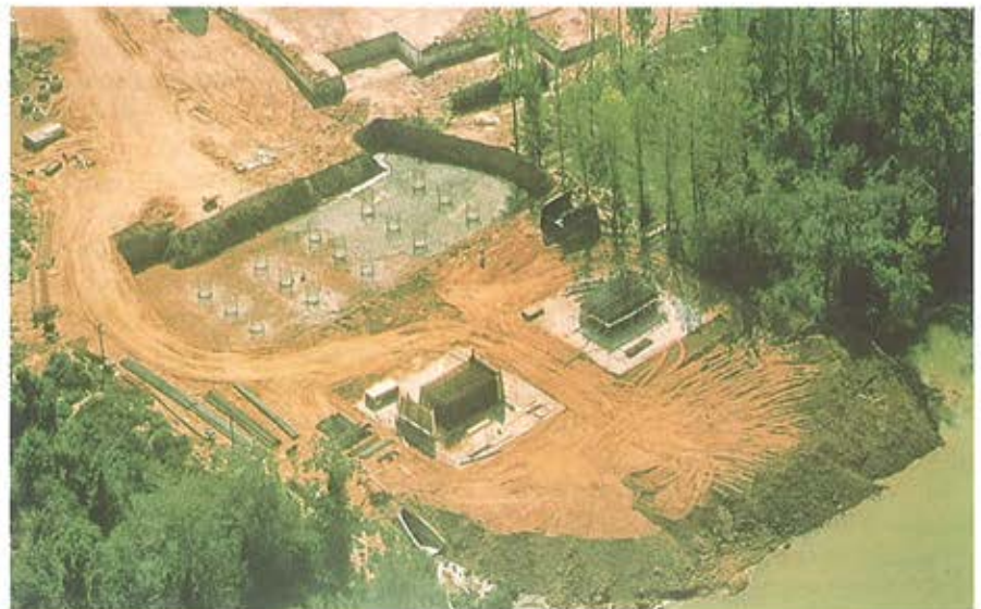
Foto 1. Cimentación del contrapeso y armadura de los plintos de pilas en la margen izquierda del río.
