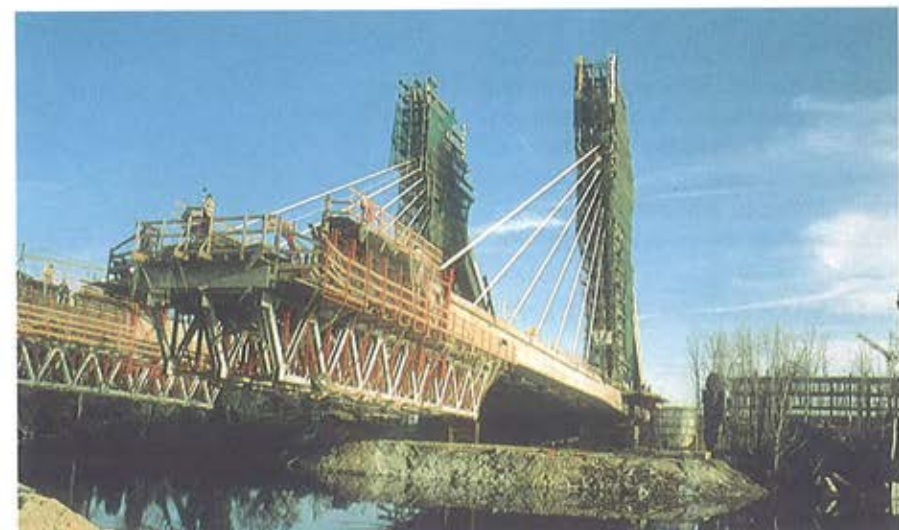
Foto 7. Carros de avance vistos desde la margen derecha.
