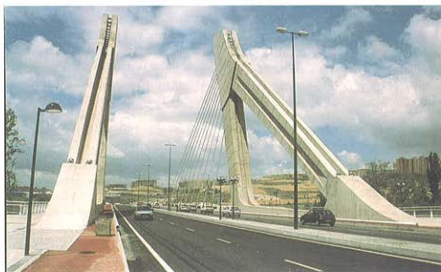
Figura 10. Pórticos triangulares de la margen izquierda. El efecto estético de los rehundidos de las velas queda patente. Figure 10. Triangular frames of the left bank. The aesthetic effect of the grooves in the surfaces of the sails is clearly shown.
