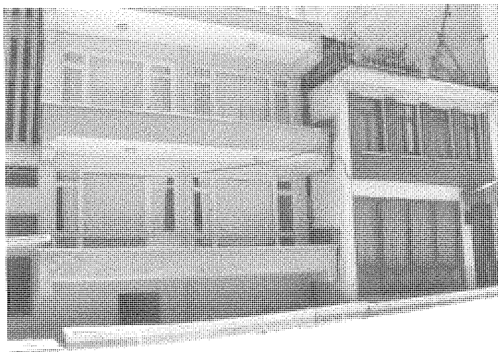
Foto 1. Edificio hundido cerca de 50 cm en Adapazarı por licuefacción del suelo.
