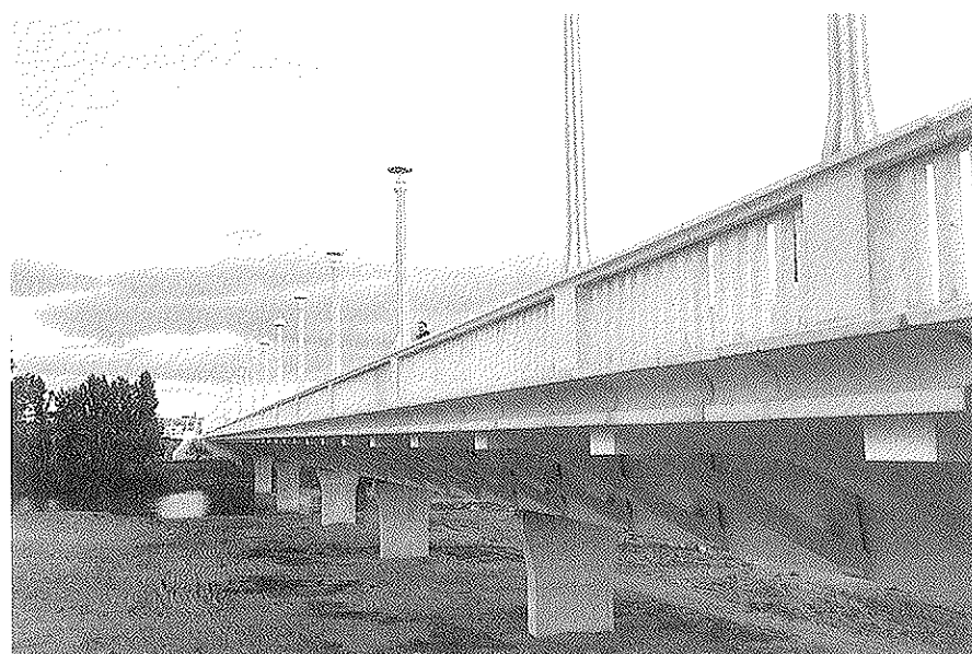
Figura 12. Vista general del puente.
