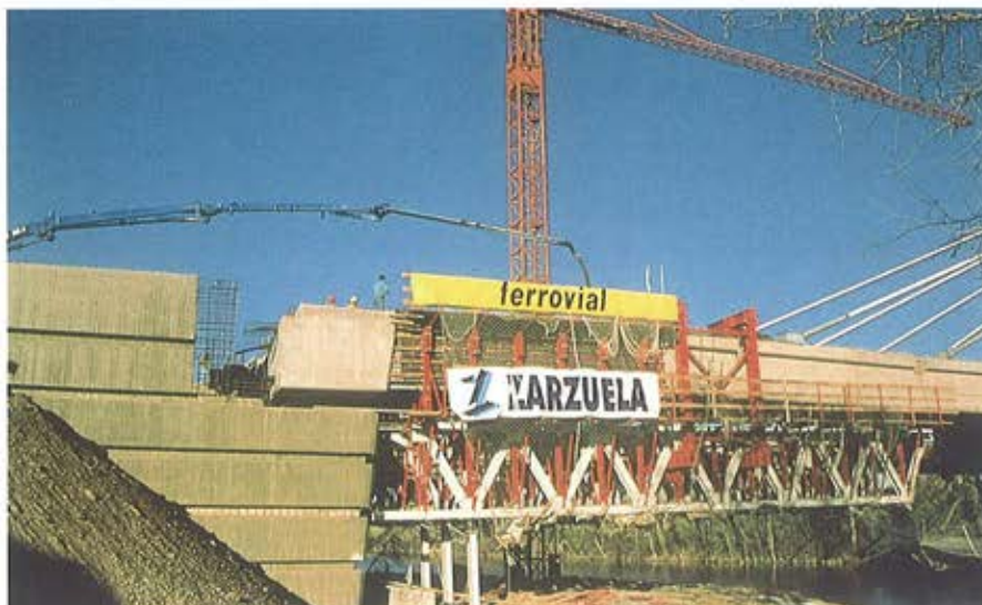
Figura 8. Llenado de la última dovela, que contacta con el diafragma de apoyo sobre el estribo de margen derecha. Figure 8. Erection of the last segment of girder, connecting with the transverse diaphragm placed over the abutment of the right bank.
