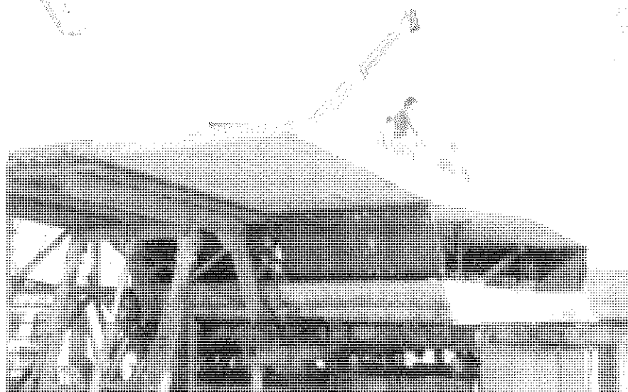
Figura 17. Retirada de dovela de posición de contramolde.
