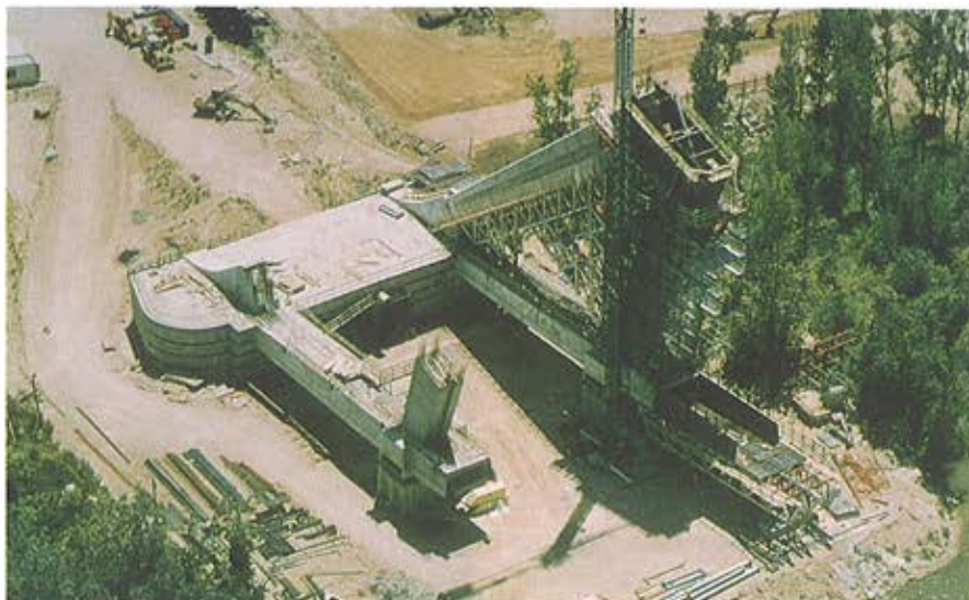
Foto 2. El contrapeso, y los arranques de las células laterales, con la de aguas abajo en fase avanzada de construcción ya que sólo se empleó un equipo de cimbra y carro de mástil.
