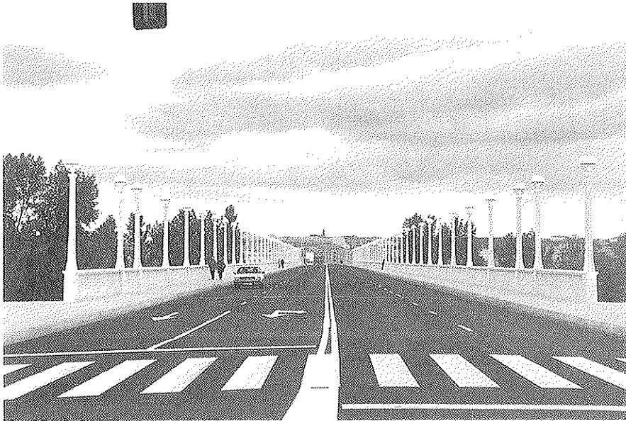
Figura 11. Vista superior de la plataforma terminada.
