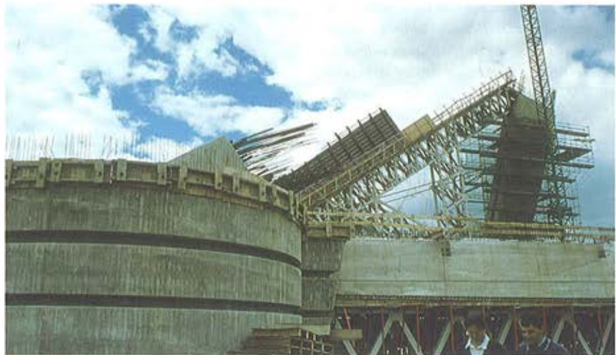
Foto 3. La superficie del contrapeso con el nervio de borde del tablero y los arranques de velas inclinadas.
