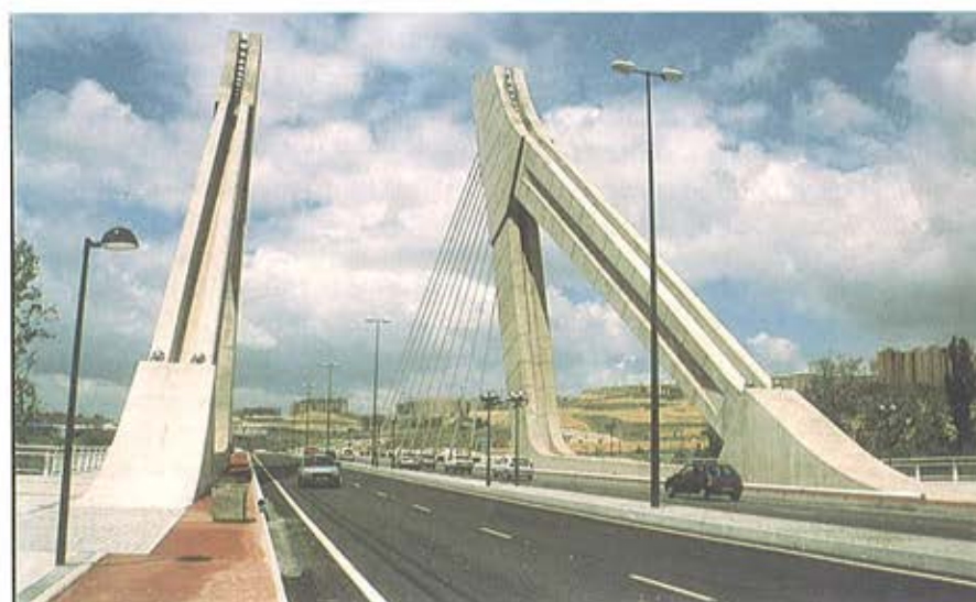
Figura 10. Pórticos triangulares de la margen izquierda. El efecto estético de los rehundidos de las velas queda patente. Figure 10. Triangular frames of the left bank. The aesthetic effect of the grooves in the surfaces of the sails is clearly shown.
