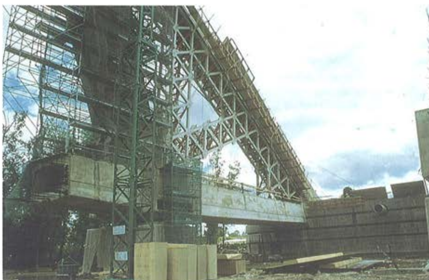
Foto 4. Vista de la cimbra de la vela inclinada.
