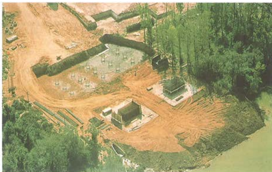
Foto 1. Cimentación del contrapeso y armadura de los plintos de pilas en la margen izquierda del río. Figure 1. Foundation of the counterweight and reinforcement of the piers at the left bank of the river.
