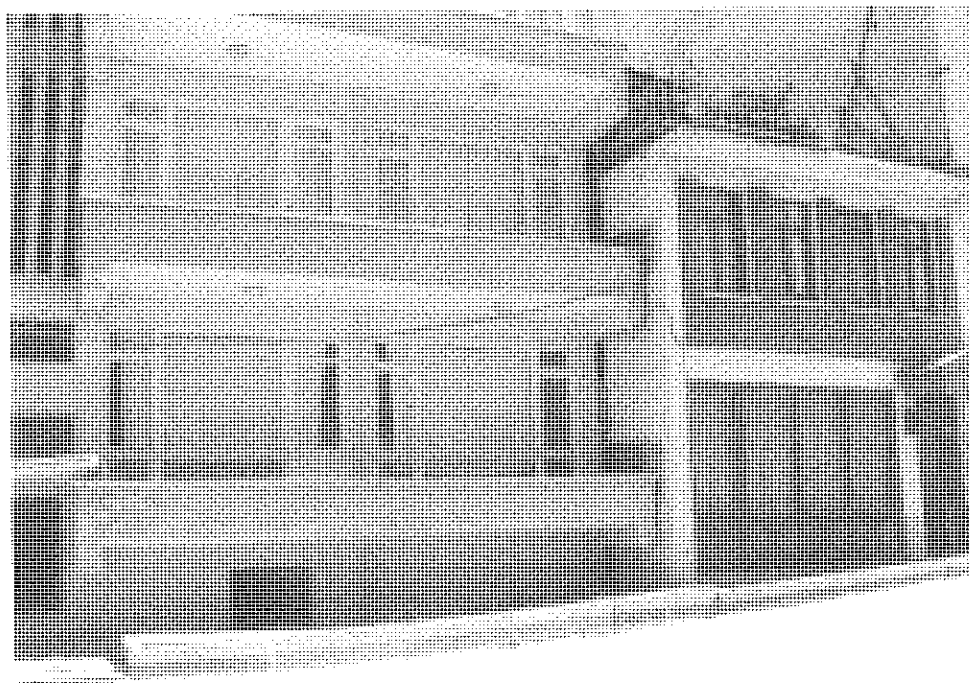
Foto 1. Edificio hundido cerca de 50 cm en Adapazari por licuefacción del suelo.
