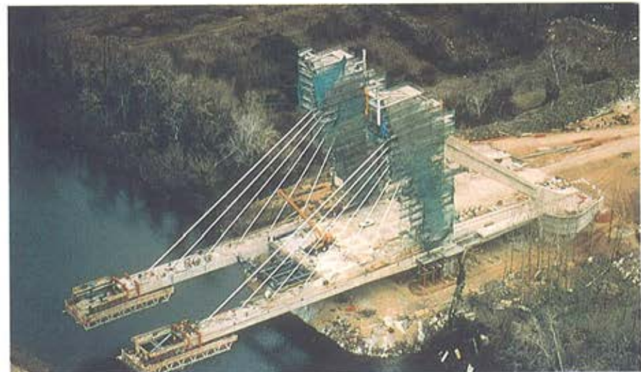
Foto 6. Avance en voladizo con carros. Se aprecian los tubos dispuestos en las nuevas dovelas para la salida de los tirantes.
