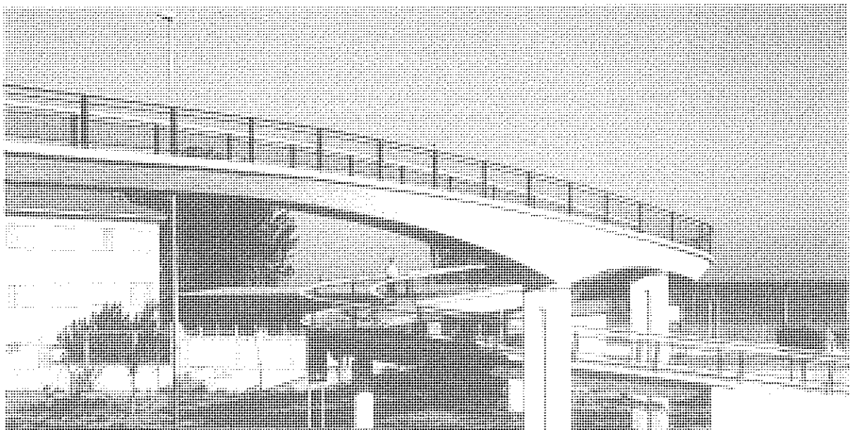
Figura 9. Detalle de la obra terminada.
