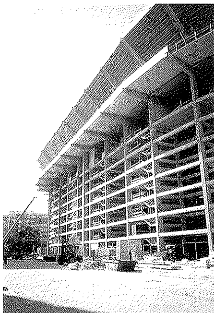
Foto 2. Vista exterior estructura acabada.
