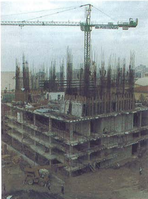
Estructura de base del edificio. Forjados para estacionamiento. Building basement structure. Parking floor slabs.
