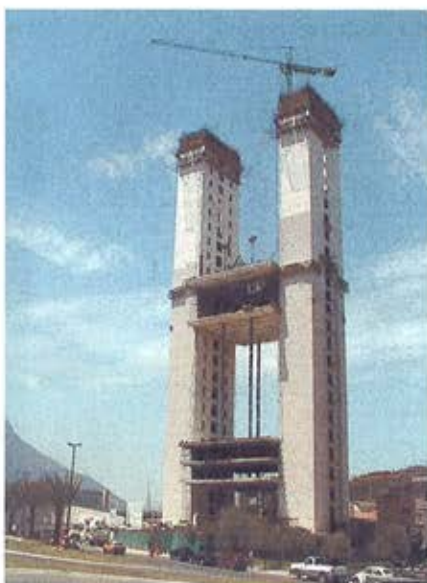
Figura 13. Izado de la primera estructura-puente, formada por el conjunto de jácenas metálicas y dos forjados. La última imagen corresponde a la construcción de los primeros forjados colgados.
