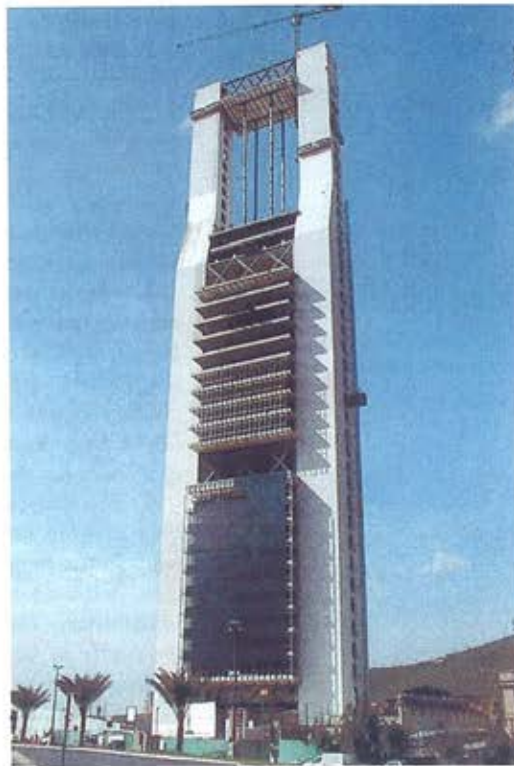
Figura 14.- Imágenes de varias fases de construcción, en las que puede apreciarse la simultaneidad de operaciones de obra (construcción de núcleos de hormigón, izado de conjunto de estructura-puente, construcción de forjados colgados, montaje de cerramiento, formado por muro-cortina, etc.)
