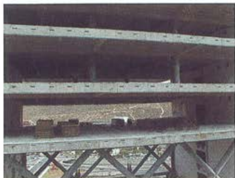
Figura 15. Una planta con excepcional diafanidad. En el espacio comprendido entre los núcleos de hormigón no existe un solo elemento estructural vertical (Tirante o pilar).
