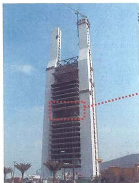
Figura 5. Estructura puente, formada por jácenas metálicas en celosía. Figure 5. Bridge structure, formed by steel trusses.
