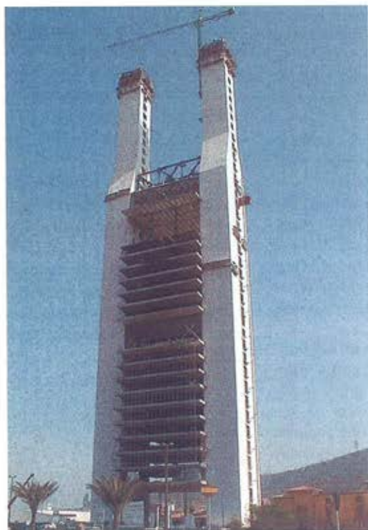
Figura 14.- Imágenes de varias fases de construcción, en las que puede apreciarse la simultaneidad de operaciones de obra (construcción de núcleos de hormigón, izado de conjunto de estructura-puente, construcción de forjados colgados, montaje de cerramiento, formado por muro-cortina, etc.)
