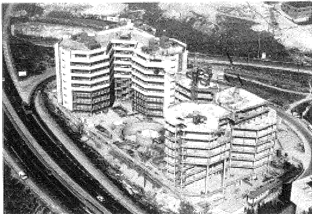
Figura 8. Edificio Mirasierra (Madrid). Arquitecto: J.M. García Peral. Proyecto estructural: J.L. Bellod y J. Rui-Wamba (ESTEYCO, S.A.)
