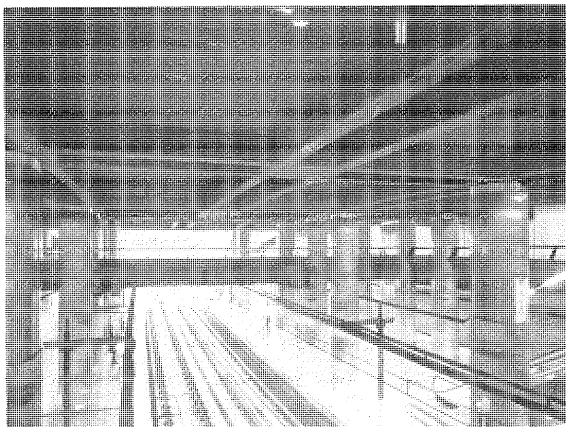
Figura 3. Estructura de hormigón postesado en la Estación de Ferrocarril Príncipe Pío, de Madrid. Proyecto estructural: Carlos Fernández Casado, S.L.
