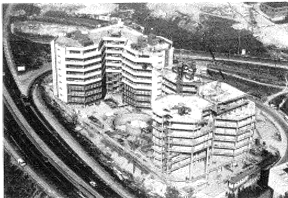
Figura 8. Edificio Mirasierra (Madrid).
