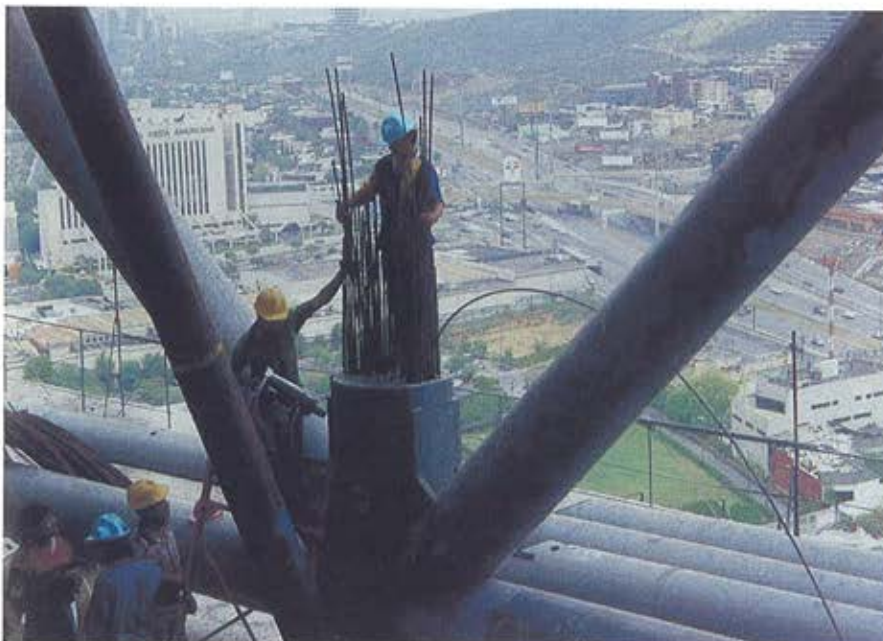
Figura 10. Tesado de un tirante, mediante gato unifamiliar Figure 10. Stressing a stay, using monostrand jack
