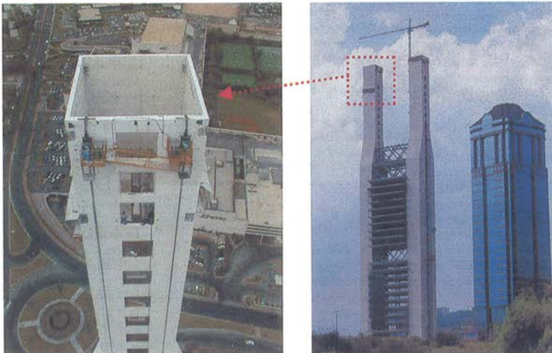
Figura 11. Núcleos de hormigón. La figura de la izquierda, corresponde a la coronación de uno de los núcleos, a la cota +166 m sobre el nivel de la calle. Pueden apreciarse dos aparatos preparados para el izado de la estructura-puente suspendida mediante cables.
