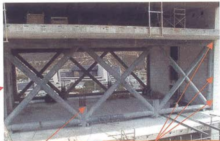
Anclaje superior de tirante homogeneizado Upper anchorage of homogenized stay
