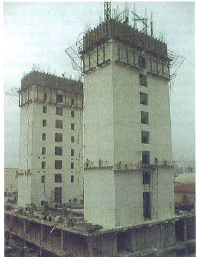
Inicio de la construcción de los núcleos. Beginning construction of concrete cores.
