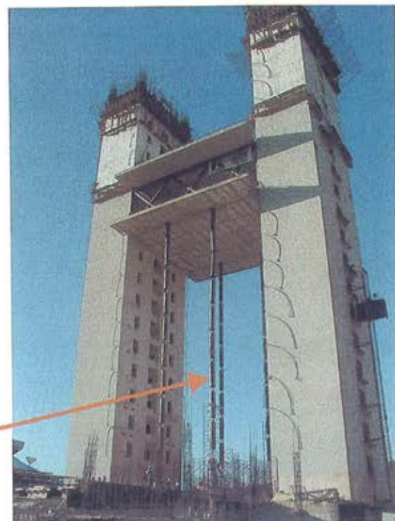
Figura 8.- Tirantes homogeneizados. Tubos metálicos exteriores. Figure 8.- Homogenized stays. External steel pipes.
