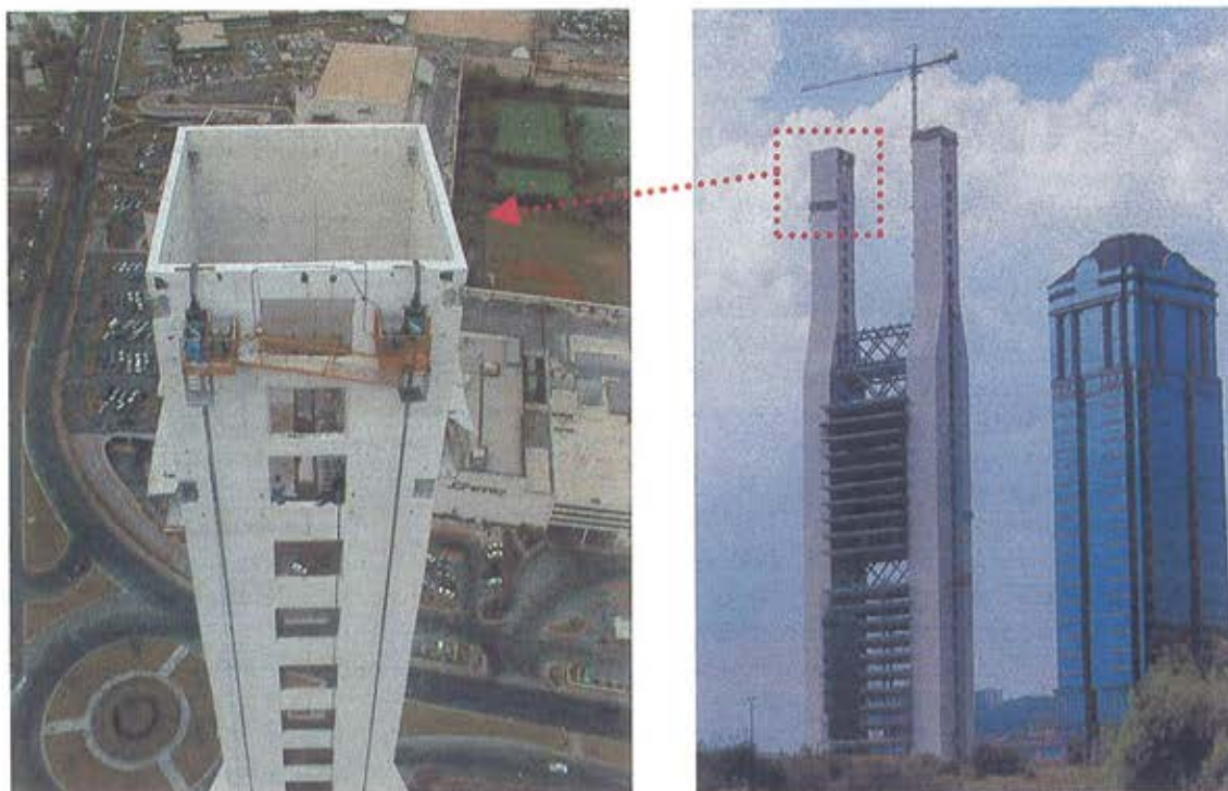
Figura 11. Núcleos de hormigón. La figura de la izquierda, corresponde a la coronación de uno de los núcleos, a la cota +166 m sobre el nivel de la calle. Pueden apreciarse dos aparatos preparados para el izado de la estructura-puente suspendida mediante cables.
