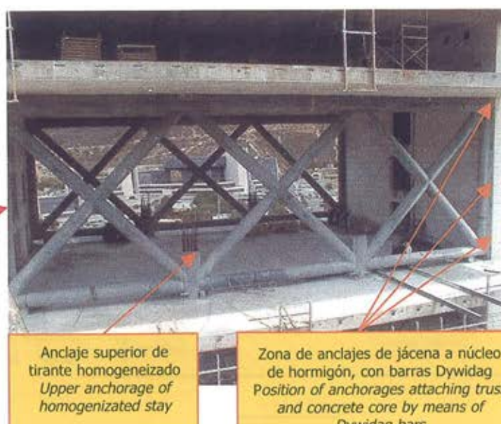
Figura 5. Estructura puente, formada por jácenas metálicas en celosía. Figure 5. Bridge structure, formed by steel trusses.
