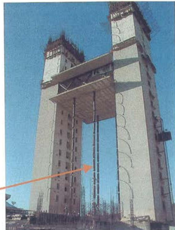
Figura 8.- Tirantes homogeneizados. Tubos metálicos exteriores. Figure 8.- Homogenized stays. External steel pipes.
