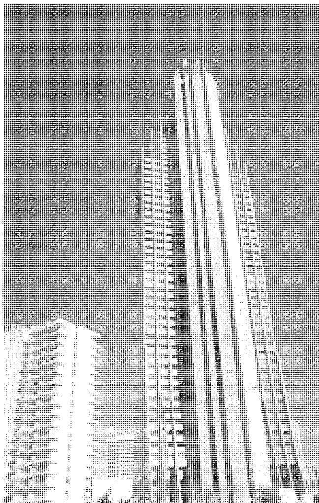
Figura 17. Bali III (52 pisos y record actual de altura en España). (Arqts. A. Escario, F. Sanchís y R. Luelmo + CYPE Ingenieros Estudios y Proyectos, S.A.)
