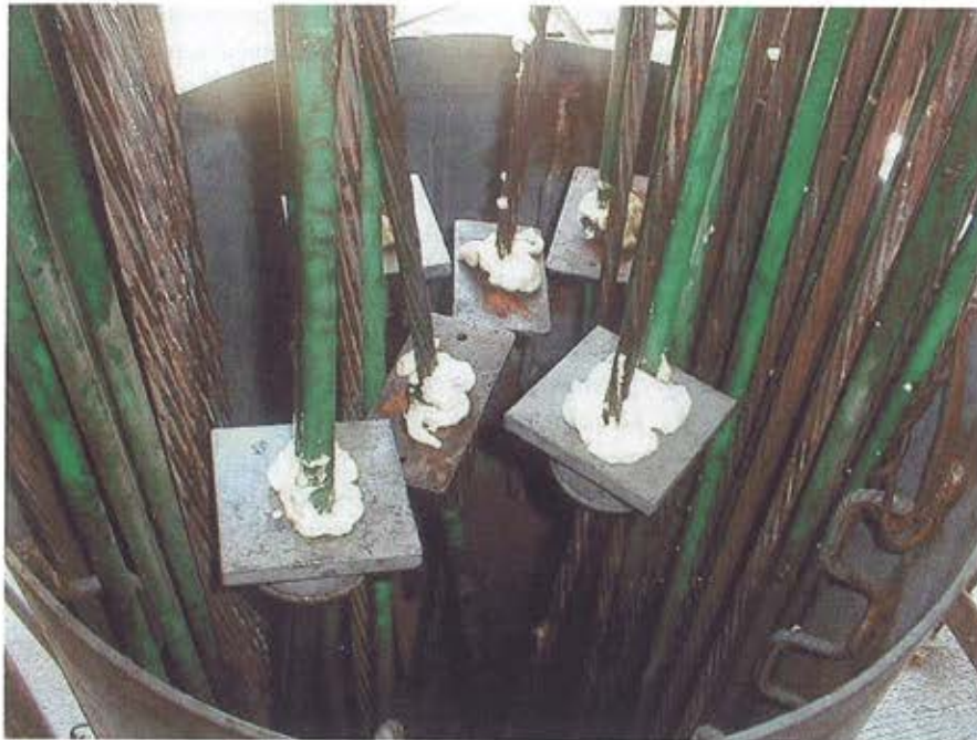
Figura 9. Cordones que constituyen un tirante. Pueden distinguirse los cordones no adherentes (envueltos en vaina, de color verde) de los adherentes (sin protección inicial). La imagen corresponde en una zona donde existe forjado, en que se han dispuesto 6 anclajes pasivos.
