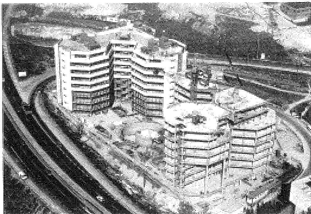
Figura 8. Edificio Mirasierra (Madrid).
