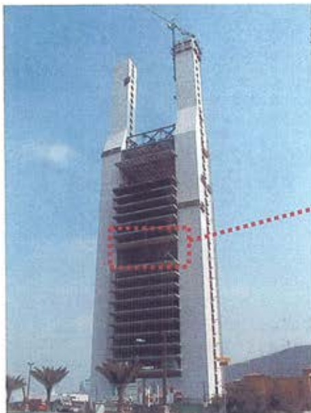
Figura 5. Estructura puente, formada por jácenas metálicas en celosía. Figure 5. Bridge structure, formed by steel trusses.
