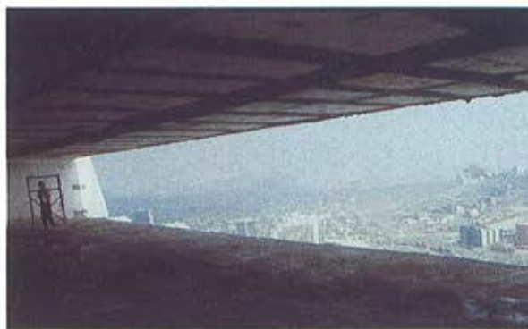
Figura 15. Una planta con excepcional diafanidad. En el espacio comprendido entre los núcleos de hormigón no existe un solo elemento estructural vertical (Tirante o pilar).
