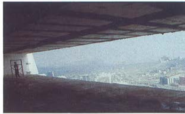
Figura 15. Una planta con excepcional diafanidad. En el espacio comprendido entre los núcleos de hormigón no existe un solo elemento estructural vertical (Tirante o pilar).
