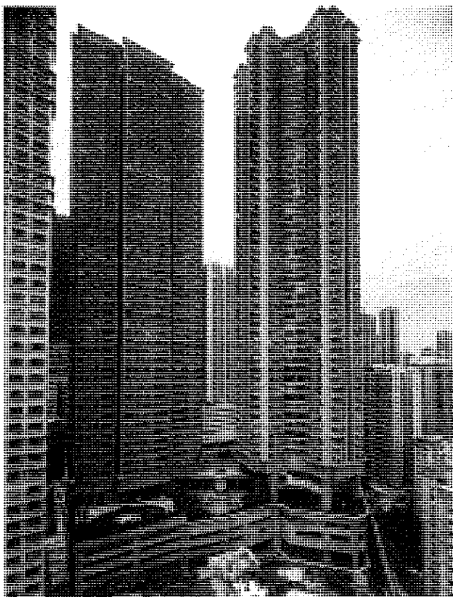
Figura 19. Robinson Place (Hong Kong). Arquitecto: Ng Chun Man & Associates. Proyecto estructural: Ng Chun Man & Associates.
