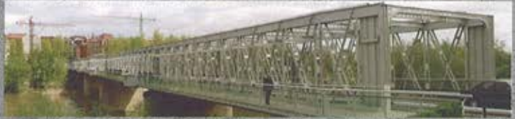
Restauración del Antiguo Puente de Hierro sobre el Duero, Zamora. Ruta de la Plata. Dirección General de Carreteras, Ministerio de Fomento
