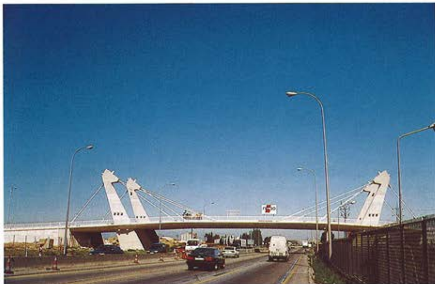
Figura 1. El puente desde el arcén de la N-IV. Figure 1. Bridge from N-IV shoulder
