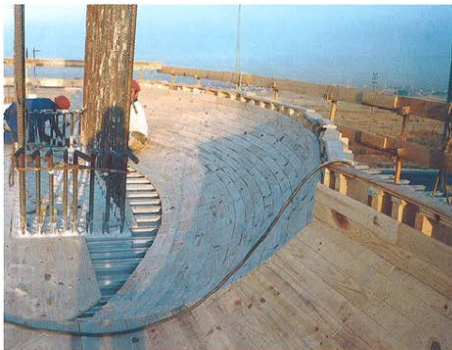
Figura 10. Detalle del encofrado. Figure 10. Formwork detail.
