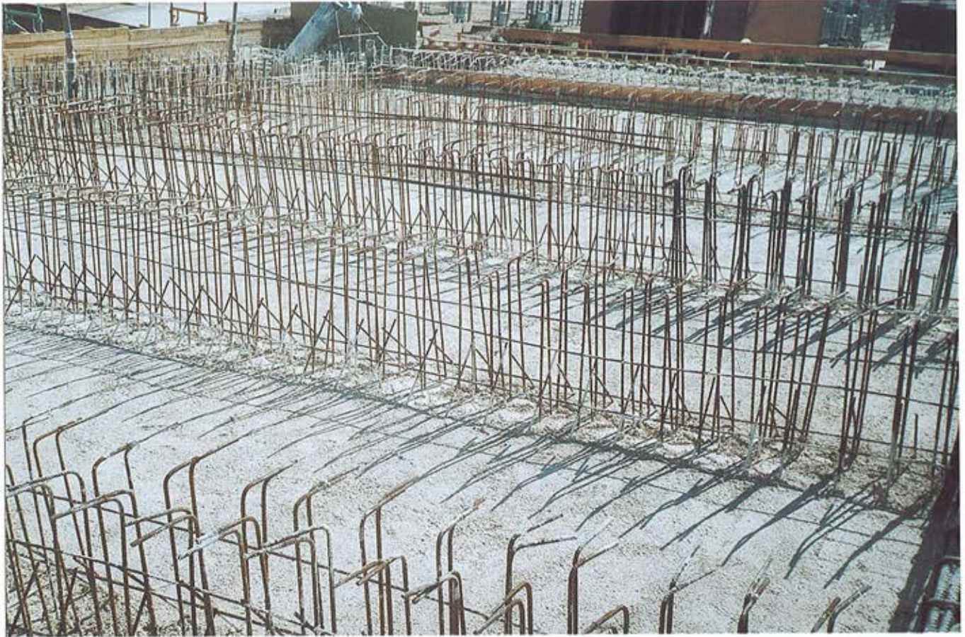
Figura 18. Hormigonado de la losa inferior del tablero. Figure 18. Deck bottom slab concrete pouring.
