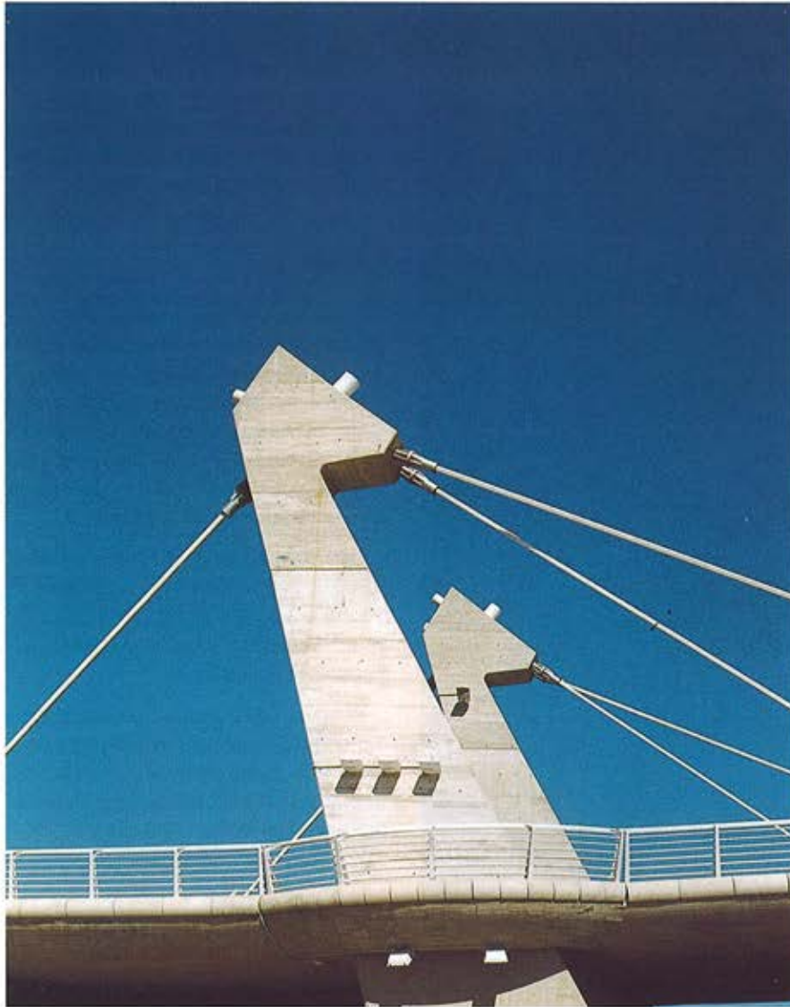
Figura 12. Vista de los fustes de una pila. Figure 12. View of Piers shaft.
