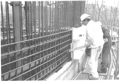
Figura 22. Apoyos de neopreno sobre la esctructura de hormigón de base del fuste, armaduras activas y pasivas pertenecientes a la parte inferior del fuste. Inicio del montaje del encofrado deslizante.
