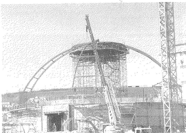
Figura 23. Montaje de las piezas metálicas que constituyen los meridianos de la cúpula sobre la estructura perteneciente al encofrado deslizante y unión, mediante soldadura, con la plataforma metálica apoyada sobre cimbra.
