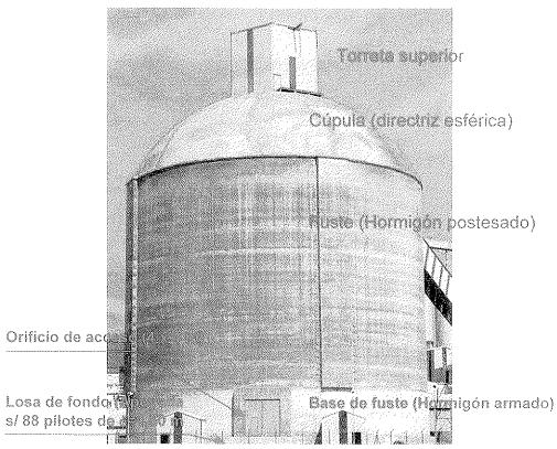
Figura 3. Estructura. Elementos fundamentales.
