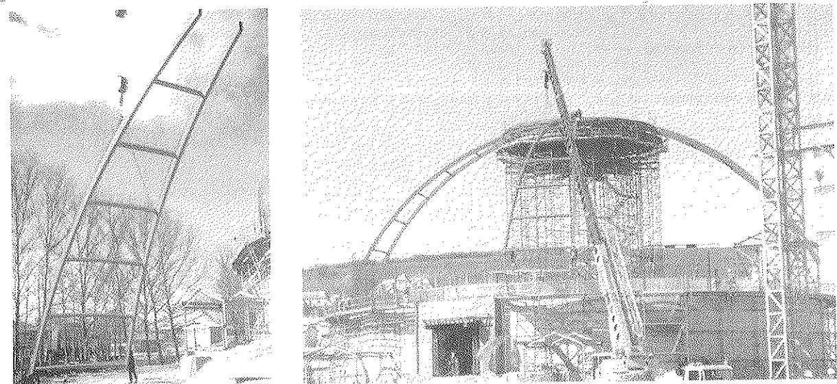
Figura 23. Montaje de las piezas metálicas que constituyen los meridianos de la cúpula sobre la estructura perteneciente al encofrado deslizante y unión, mediante soldadura, con la plataforma metálica apoyada sobre cimbra.
