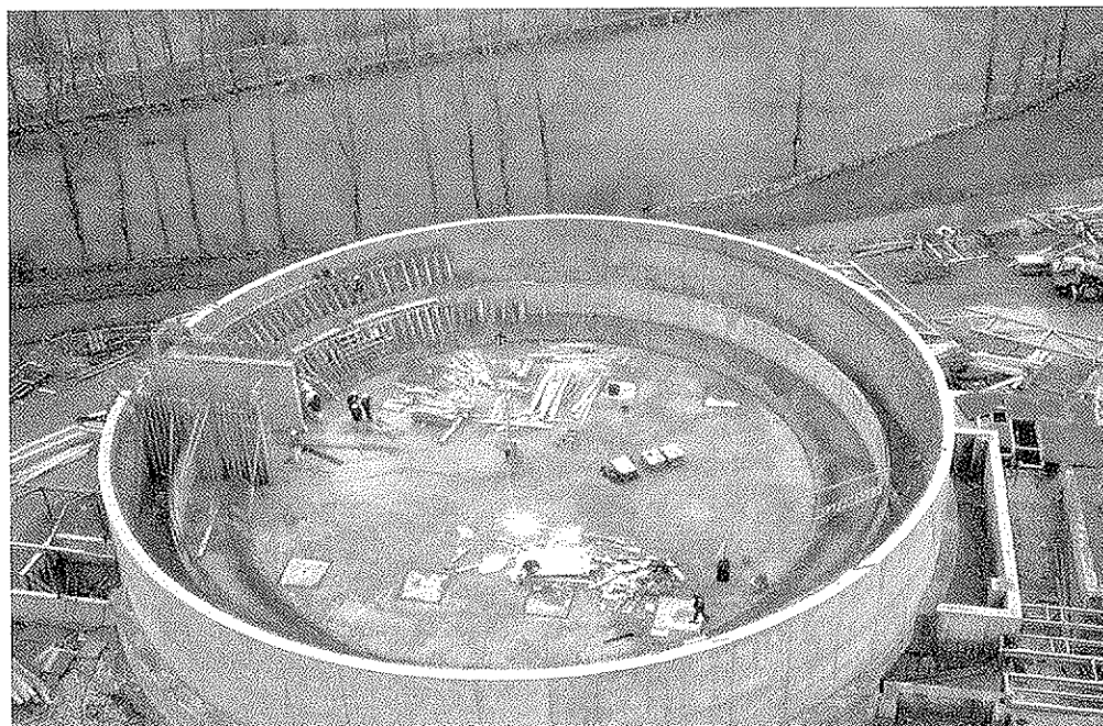
Figura 11. Estructura de base en construcción, en situación anterior al hormigonado de las paredes de forma troncocónica.
