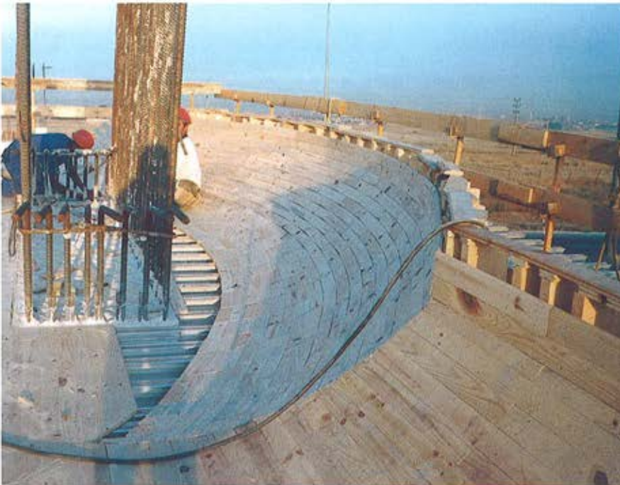
Figura 10. Detalle del encofrado. Figure 10. Formwork detail.
