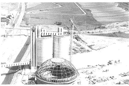
Figura 25. Construcción del fuste del silo, mediante el empleo del encofrado deslizante, que se elevarconjuntamente conla cúpula metálica.
