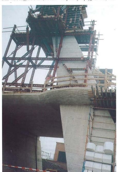
Figura 6. Vista de las plataformas en torno a las pilas. Figure 6. Platform view around the piers.
