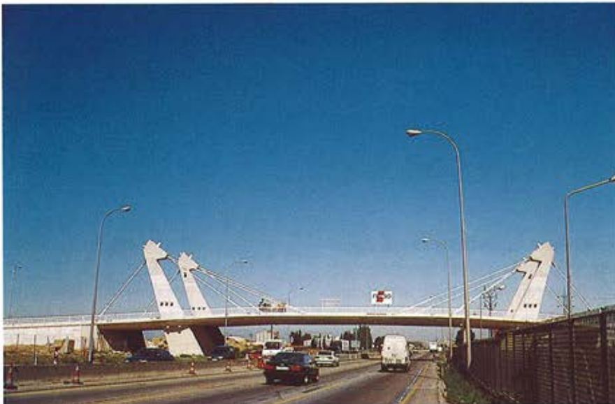
Figura 1. El puente desde el arcén de la N-IV. Figure 1. Bridge from N-IV shoulder
