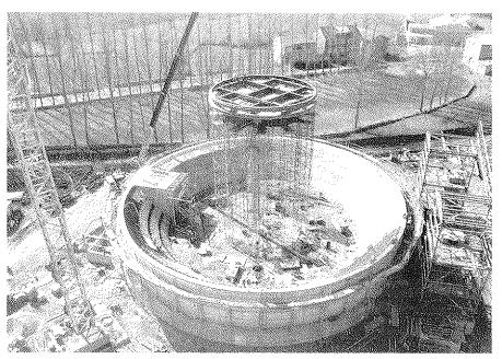
Figura 21. Montaje, sobre una cimbra apoyada en la losa de fondo, de la plataforma metálica que constituye la coronación de la cúpula de cubierta.
