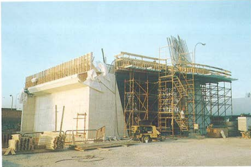
Figura 15. Estribo. Figure 15. Abutment.
