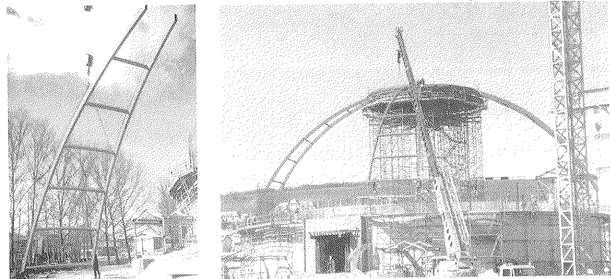
Figura 23. Montaje de las piezas metálicas que constituyen los meridianos de la cúpula sobre la estructura perteneciente al encofrado deslizante y unión, mediante soldadura, con la plataforma metálica apoyada sobre cimbra.
