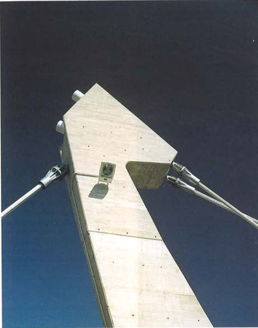
Figura 13. Detalle de capitel de pila. Figure 13. Pier head detail.
