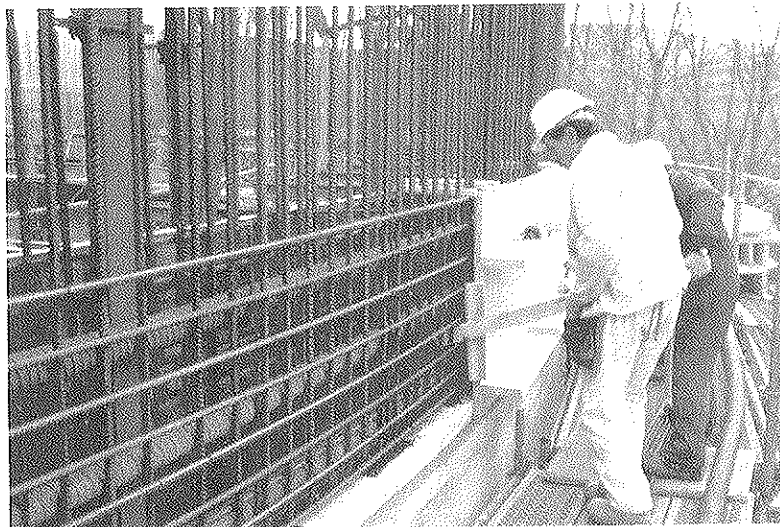
Figura 22. Apoyos de neopreno sobre la estructura de hormigón de base del fuste, armaduras activas y pasivas pertenecientes a la parte inferior del fuste. Inicio del montaje del encofrado deslizante.
