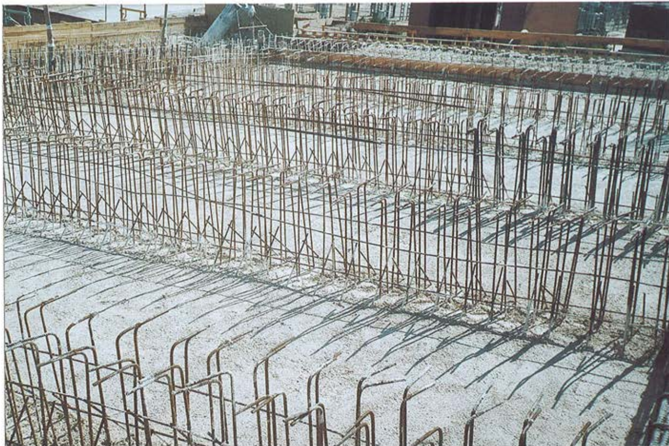
Figura 18. Hormigonado de la losa inferior del tablero. Figure 18. Deck bottom slab concrete pouring.
