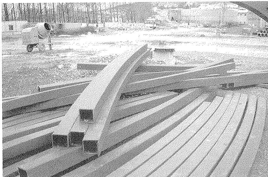
Figura 17. Piezas que constituyen las correas de cubierta, antes de su montaje.
