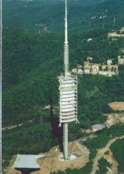
Torre de Comunicaciones de Collserola. Barcelona
