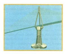
Figura 22. Perspectiva de la pila del puente Rion-Antirion.
