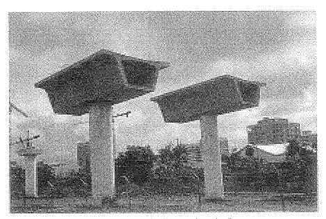
Figura 10. Dovelas fijas en cabeza de pila.
