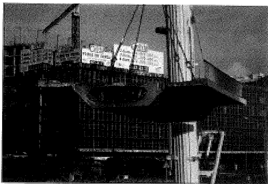
Figura 4. Pieza recién cortada durante el izaje.
