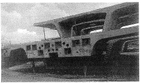
Figura 14. Vista de anclaje de pretensado en dovela de apoyo para vía doble.
