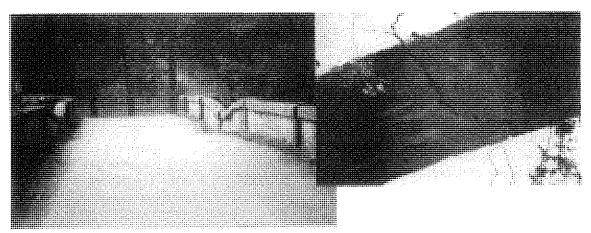
Figura 2. Descenso de apoyo. Grieta en la bóveda.
