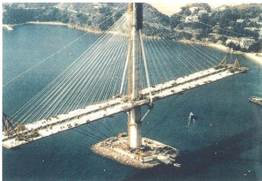
Figura 55. Detalle de la pila durante la construcción del puente de Ting Kau. Figure 55. Pylon detail during construction of Ting Kau bridge.
