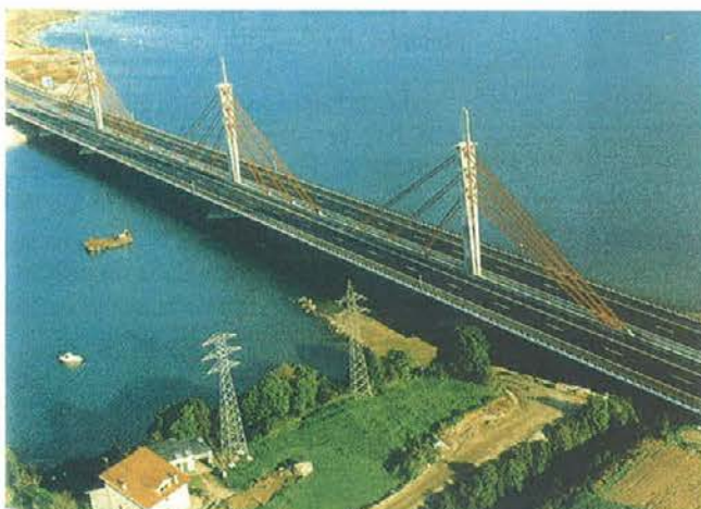
Figura 23. Vista del viaducto de Colindres. Figure 23. View of Colindres viaduct.
