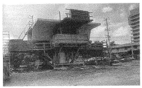
Figura 17. Hormigonado de la dovela fija en cabezas de pila.
