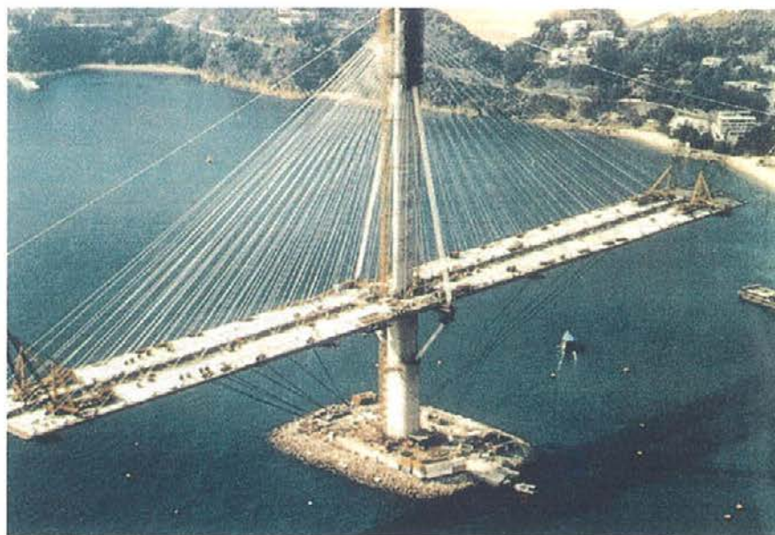
Figura 55. Detalle de la pila durante la construcción del puente de Ting Kau.
