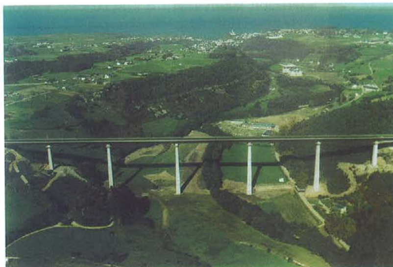
Viaducto de San Timoteo en la CN-632 (Asturias, España) con tablero de estructura mixta acero-hormigón.
