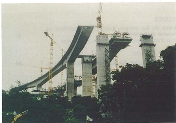
Viaductos de acceso al puente Ting Kau (Hong Kong) de hormigón pretensado contruidos por voladizos sucesivos.
