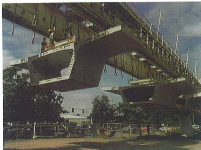
Viaducto para el ferrocarril urbano de Hato Rey (Puerto Rico) con dovelas prefabricadas de hormigón y pretensado exterior.
