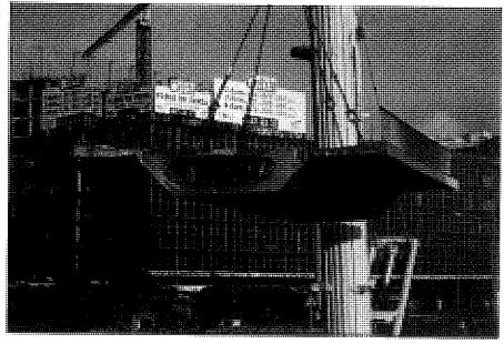
Figura 4. Pieza recién cortada durante el izaje.
