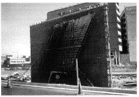
Figura 9. Vista del encofrado y parte del armado de una pila central. En la parte inferior se ve el encofrado del cajetín de anclaje (1).
