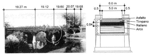
Fig. 1 Vista y sección transversal del puente original.
