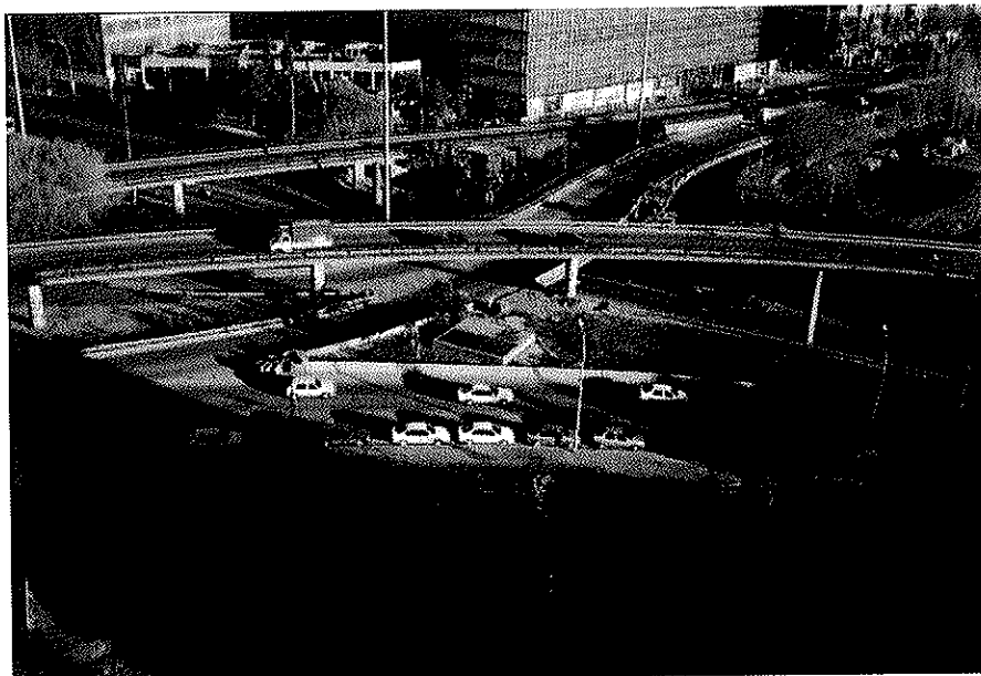
Figura 2. Viaductos aún en servicio.
