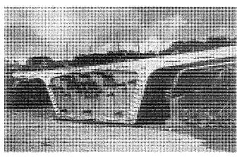
Figura 8. Dovela de apoyos de vía doble.
