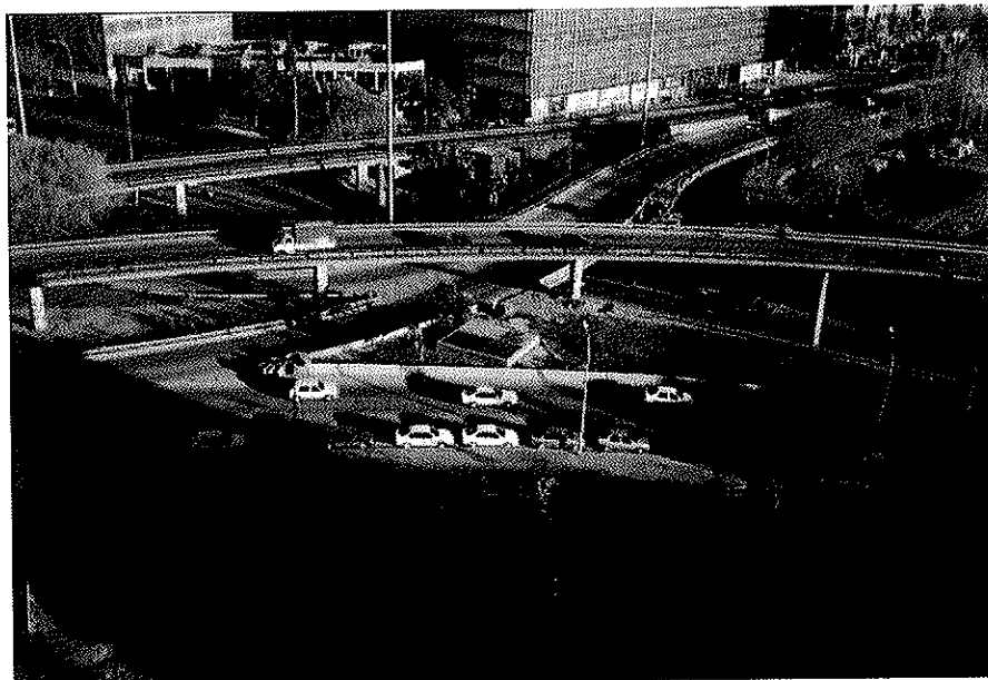
Figura 2. Viaductos aún en servicio.
