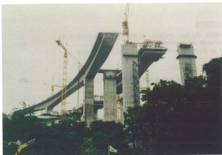
Viaductos de acceso al puente Ting Kau (Hong Kong) de hormigón pretensado construidos por voladizos sucesivos.
