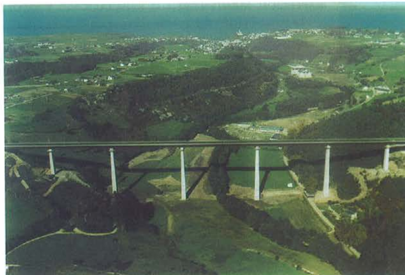
Viaducto de San Timoteo en la CN-632 (Asturias, España) con tablero de estructura mixta acero-hormigón.
