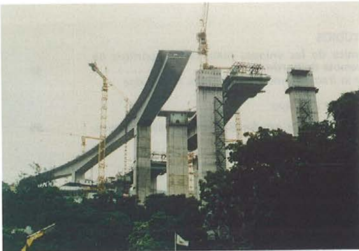
Viaductos de acceso al puente Ting Kau (Hong Kong) de hormigón pretensado construidos por voladizos sucesivos.
