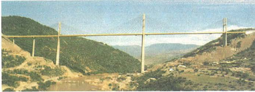
Figura 31. Vista del puente de Mezcala (México). Figura 31. View of Mezcala bridge (México).
