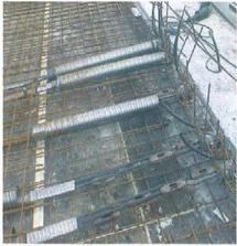
Figura 10. Detalles acoplador mono torón. Figure 10. Details of a conpler for one tendon.
