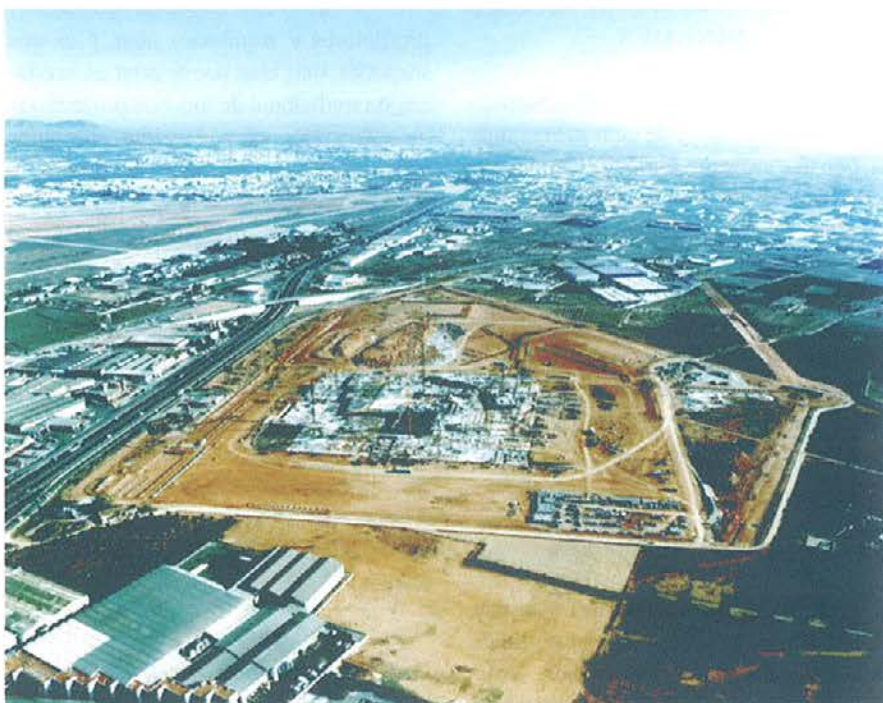
Figura 1. Vista aérea de la estructura del centro comercial y límites de la parcela. Figure 1. Top view of the structure.
