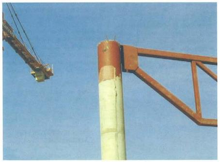
Figura 4. Detalle cabeza pilar con collarín.
