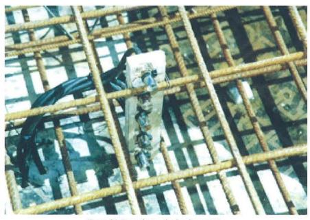
Figura 26. Transductor de desplazamiento. Figure 26. Measuring of deformations.
