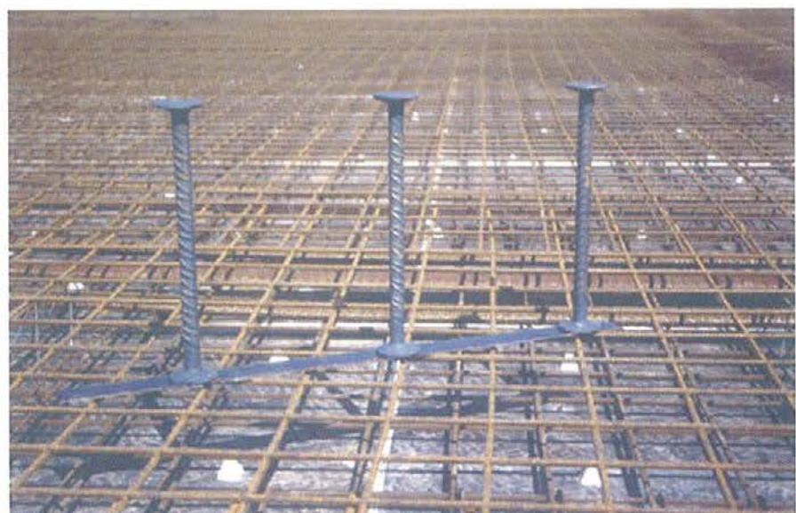
Figura 13. Armadura de punzonamiento. Figure 13. Punching shear reinforcement.
