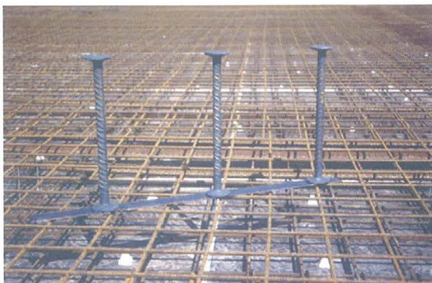
Figura 13. Armadura de punzonamiento. Figure 13. Punching shear reinforcement.
