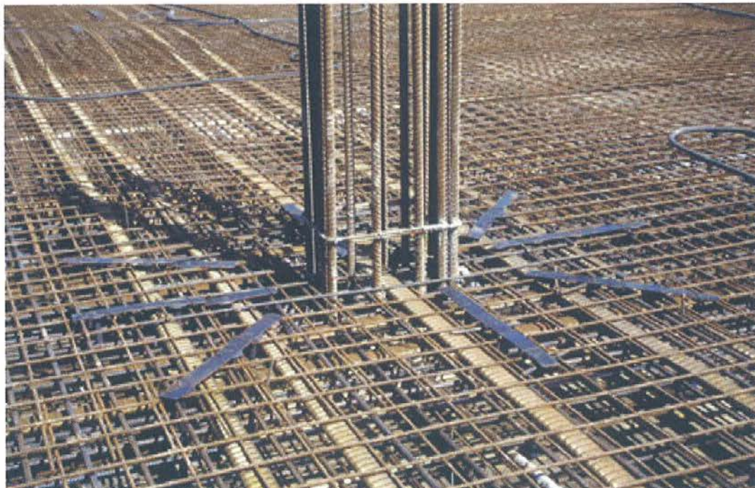
Figura 12. Colocación armadura de punzonamiento. Figure 12. Punching shear reinforcement.
