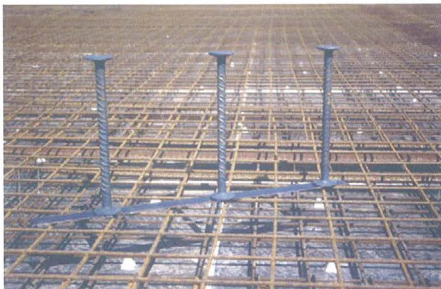
Figura 13. Armadura de punzonamiento. Figure 13. Punching shear reinforcement.
