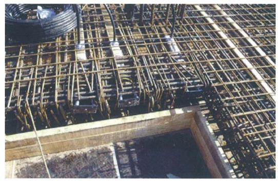
Figura 9. Foto de hueco cerca de pilar con cables de pretensado. Figure 9. Details of on opening of the slab.
