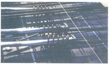
Figura 6. Detalles de transición metálica entre vaina plana y anclaje activo circular. Figure 6. Detall of transition between circular anchors and the plane case.
