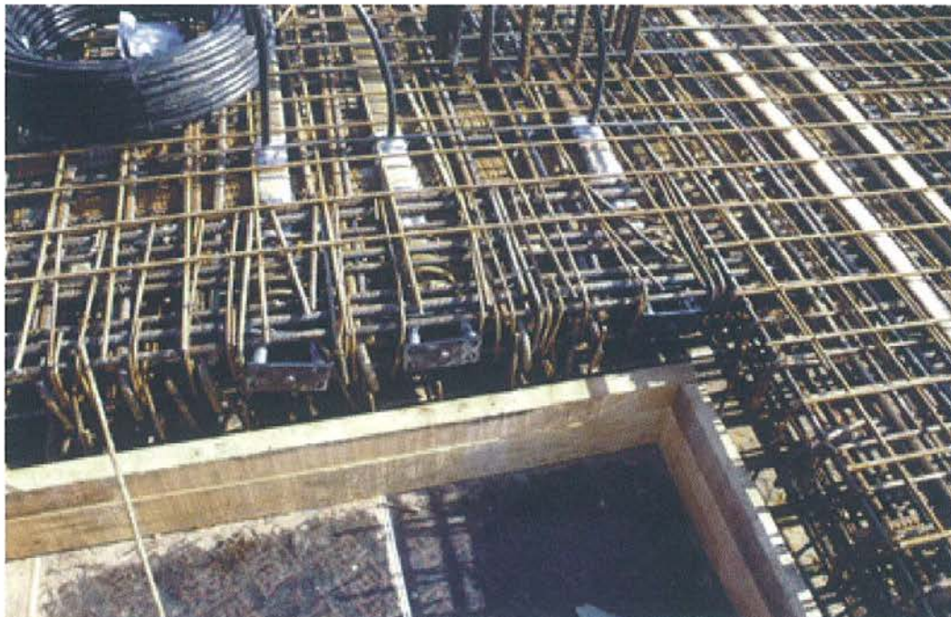
Figura 9. Foto de hueco cerca de pilar con cables de pretensado. Figure 9. Details of an opening of the slab.
