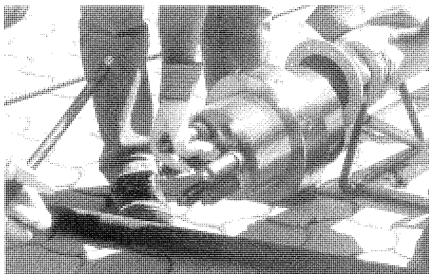
Fig. 8. Detalle del anclaje roscado de los cables.
