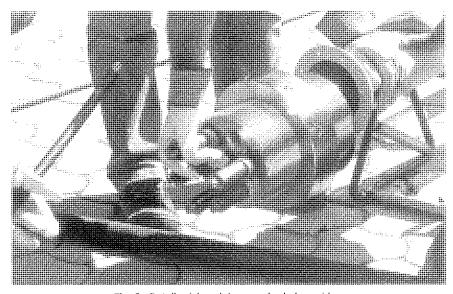
Fig. 8. Detalle del anclaje roscado de los cables.
