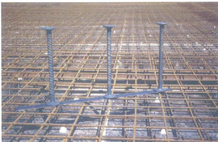
Figura 13. Armadura de punzonamiento. Figure 13. Punching shear reinforcement.
