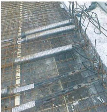
Figura 10. Detalles acoplador mono torón. Figure 10. Details of a coupler for one tendon.
