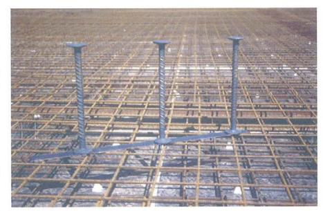
Figura 13. Armadura de punzonamiento. Figure 13. Punching shear reinforcement.
