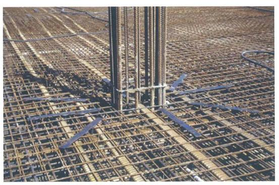
Figura 12. Colocación armadura de punzonamiento. Figure 12. Punching shear reinforcement.
