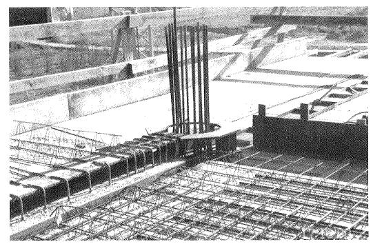
Fotografía 3. Zona con detalles dúctiles en jácena mixta y paso de armaduras de pilar mostrando anclaje mecánico ala superior semi-viga HEB.
