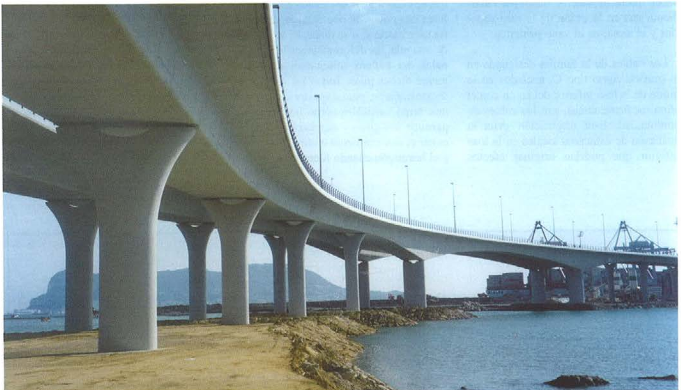
Foto 4. Tipos de pilas. Photo 4. Types of piers.
