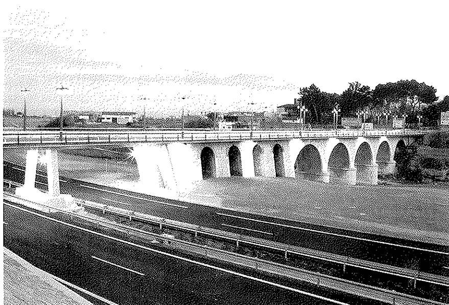
Figura 3. Vista general del puente tras la intervención.
