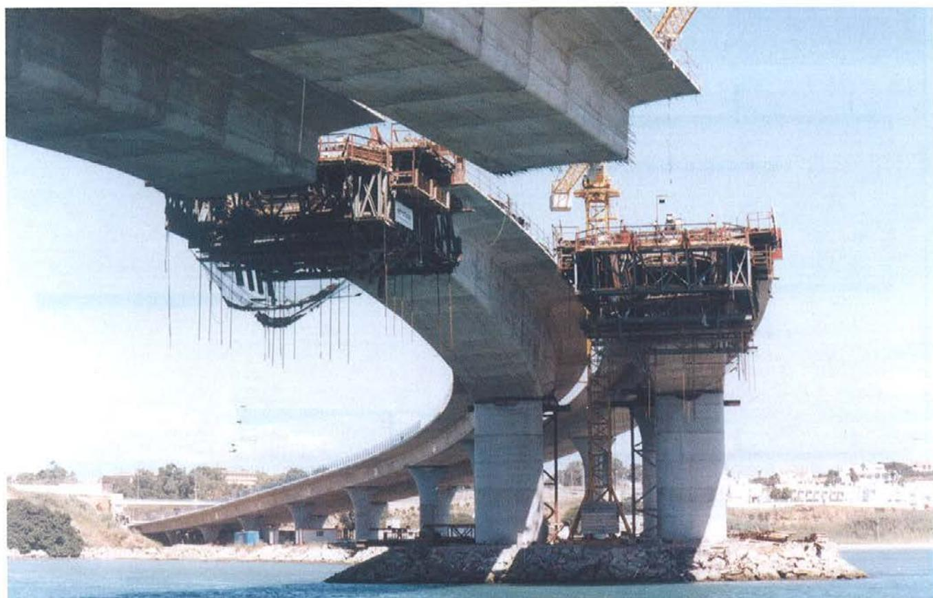
Foto 6. Construcción del vano central mediante voladizos sucesivos.
