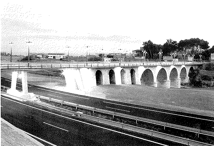
Figura 3. Vista general del puente tras la intervención.
