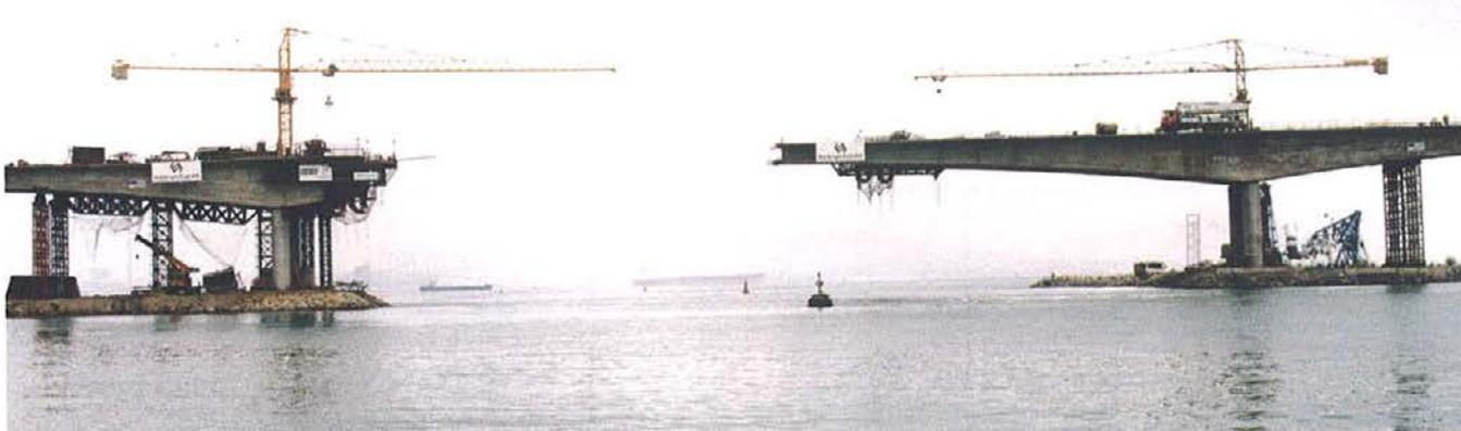
Foto 11. Construcción del semivano principal manteniendo la torre provisional en el vano adyacente.
