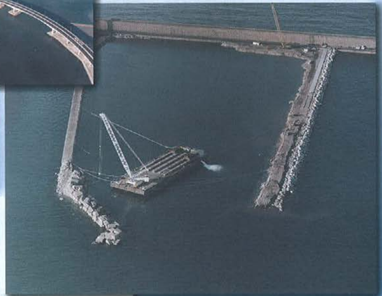
• Muelle de Minerales Puerto de Musel, Gijón, Asturias.
