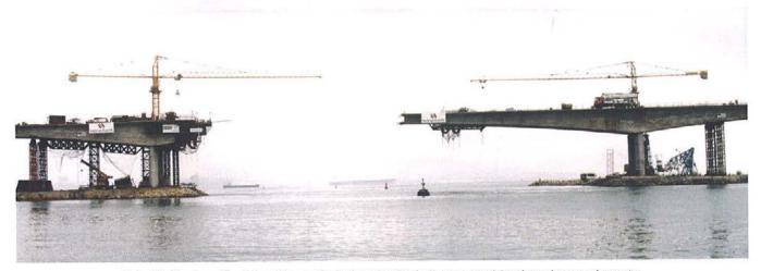
Foto 11. Construcción del semivano principal manteniendo la torre provisional en el vano adyacente.
