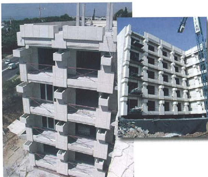
Cerramiento arquitectónico para Hotel NH. Marbella. Málaga.
