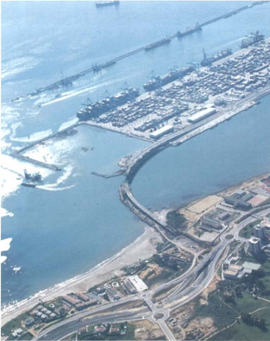
Foto 1. Vista aérea del puente del Navío en la bahía de Algeciras. Photo 1: Aerial view of the Navío bridge in the Algeciras bay.
