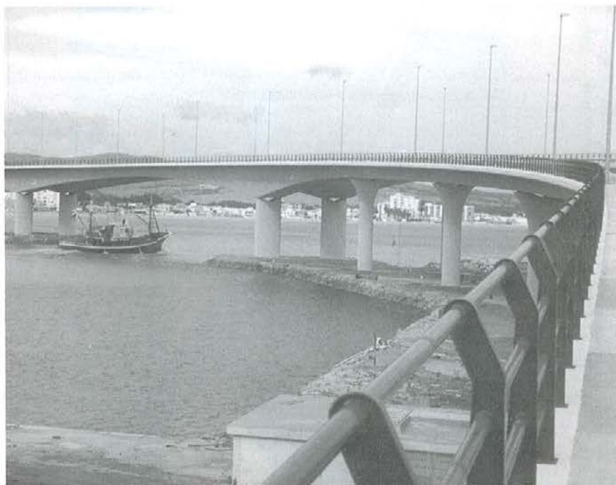
Foto 3. Detalle del vano principal, de 125 metros de luz. Photo 3. Central span of 125 meters.
