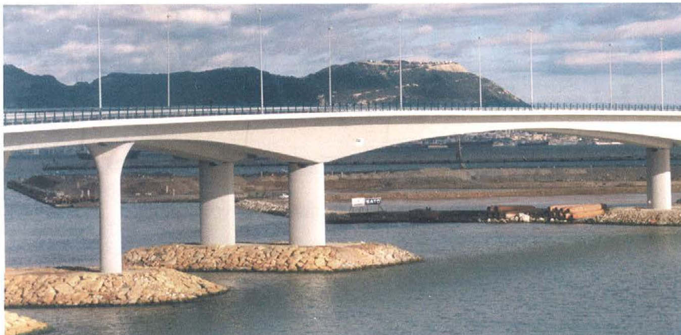
Foto 12. Detalle del canal de navegación con el puente terminado. Photo 12. View of the navigation, s channel.
