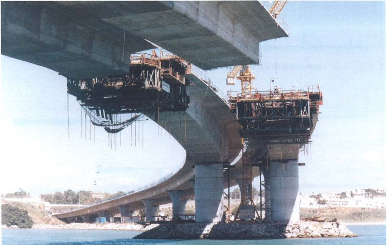
Foto 6. Construcción del vano central mediante voladizos sucesivos. Photo 6. Construction of the main span by balanced cantilevers.
