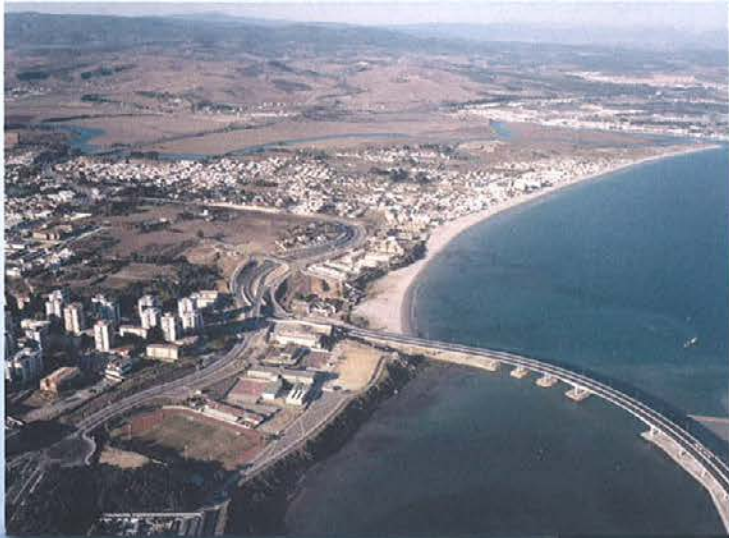
• Acceso Norte al Puerto de Algeciras. Cádiz.
