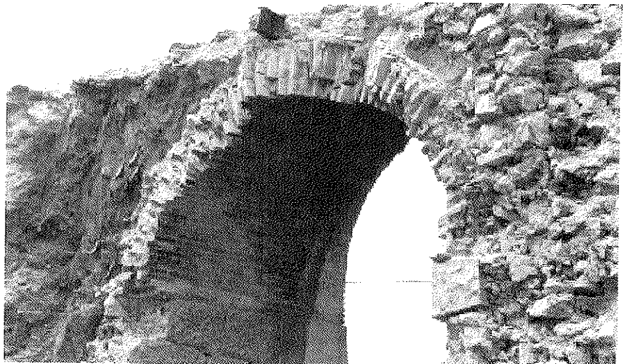
Figura 5. Elementos del puente durante las obras de demolición de la bóveda menor extrema.
