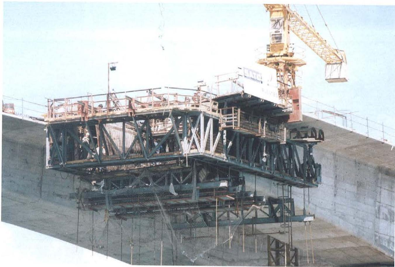
Foto 9. Detalle del carro de avance en voladizo.
