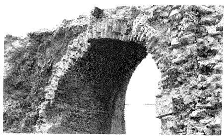
Figura 5. Elementos del puente durante las obras de demolición de la bóveda menor extrema.
