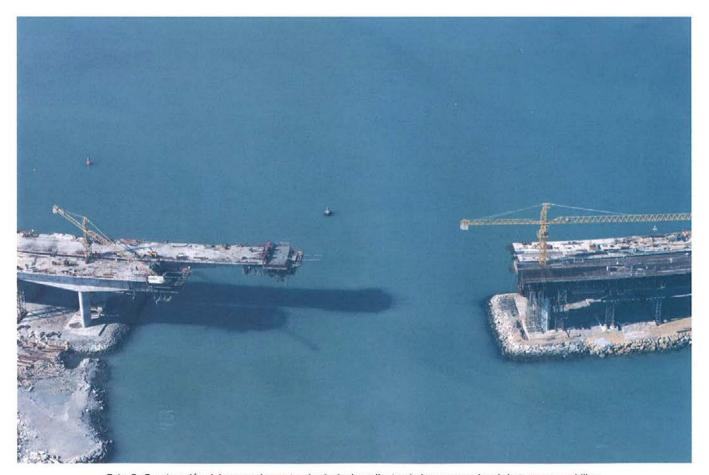
Foto 8. Construcción del vano adyacente al principal mediante cimbra convencional de torres y cuchillos.
