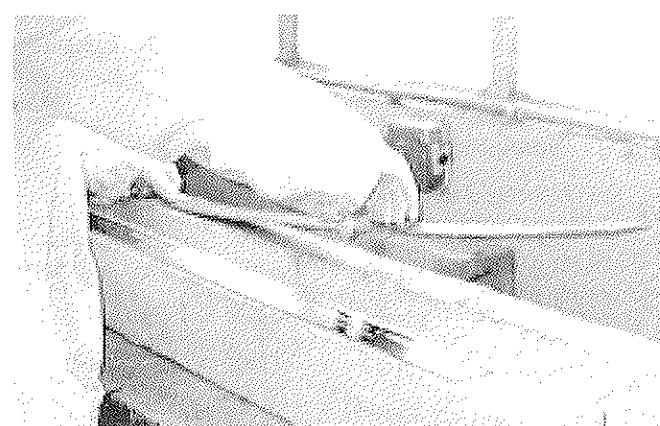
Fotografía 3: Refuerzo de la viga mediante el producto laminado.
