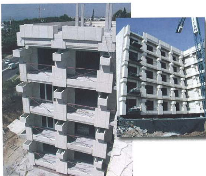
Cerramiento arquitectónico para Hotel NH. Marbella. Málaga.
