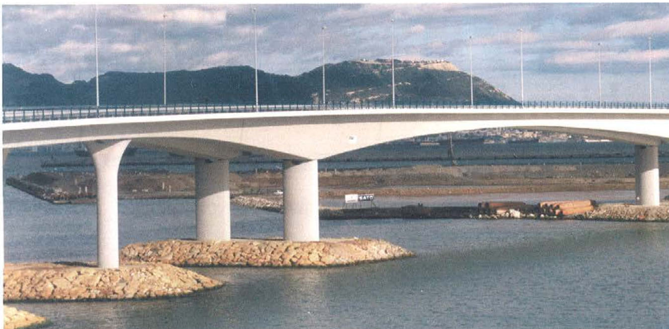
Foto 12. Detalle del canal de navegación con el puente terminado. Photo 12. View of the navigation channel.
