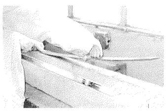
Fotografía 3: Refuerzo de la viga mediante el producto laminado.
