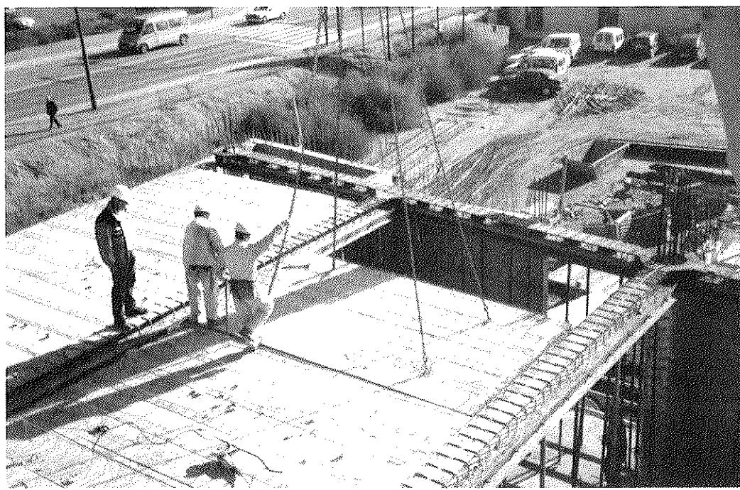
Fotografía 4. Montaje de prelosas apoyadas en jácenas mixtas. Luces 12 x 12 m.
