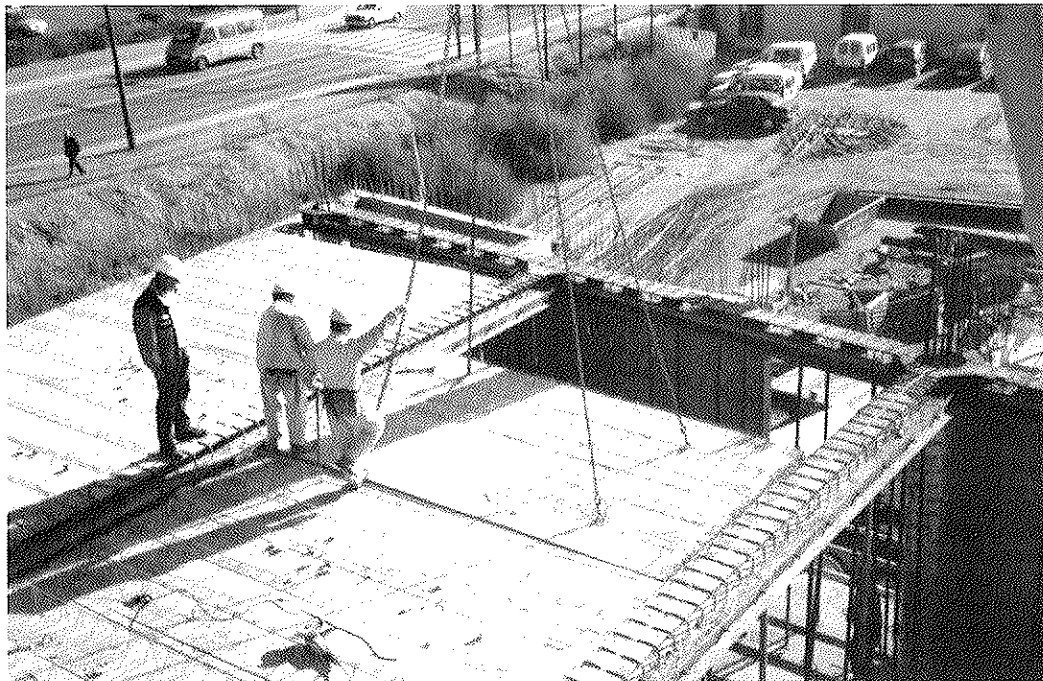
Fotografía 4. Montaje de prelasas apoyadas en jácenas mixtas. Luces 12 x 12 m.
