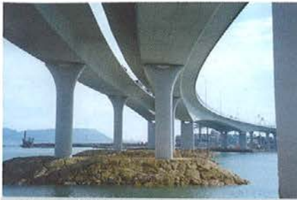
Foto de portada: Puente del navío en la bahía del Puerto de Algeciras
