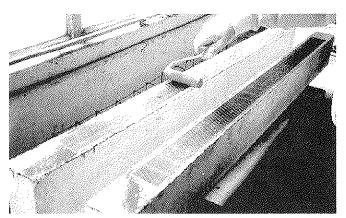
Fotografía 2: Refuerzo de la viga mediante tela de fibras embebida en resina.
