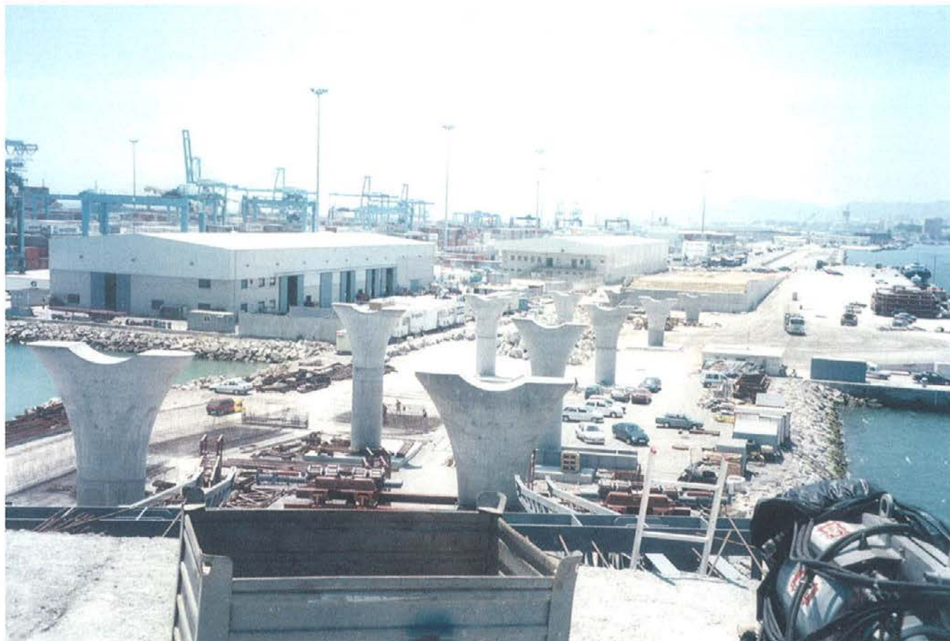
Foto 7. Vista general del comienzo de la construcción del puente en la ampliación del muelle del Navío. Photo 7. View of the construction process in the enlargement of the Navío quay.
