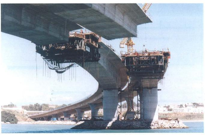
Foto 6. Construcción del vano central mediante voladizos sucesivos. Photo 6. Construction ot the main span by balanced cantilevers.
