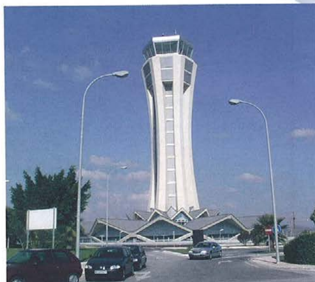
Torre de Control del Aeropuerto de Málaga.
