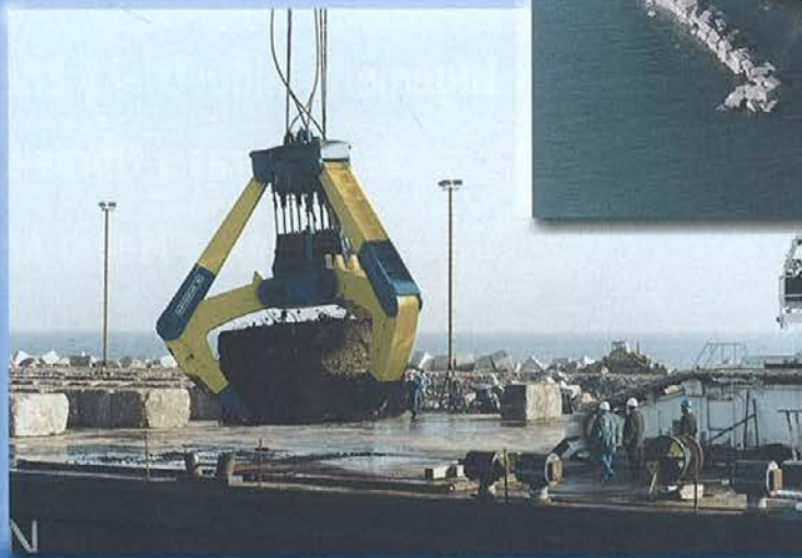
• Pinza Recuperación de Bloques de 90 Toneladas. Puerto de Gijón, Asturias.
