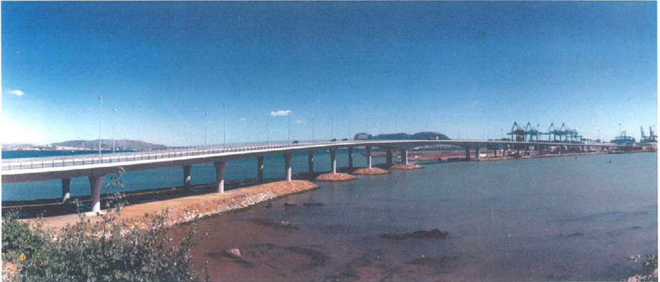
Foto 2. Vista longitudinal del puente del Navío. Photo 2. Vertical view of the Navío bridge.
