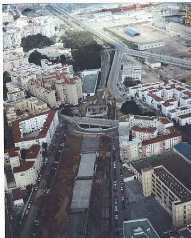
Soterramiento de vías. Cádiz.
