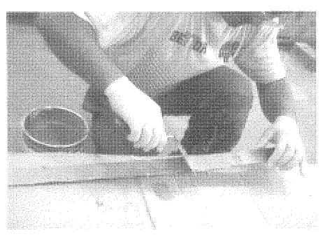
Figura 7. Aplicación de la resina epóxica sobre el laminado CFK.
