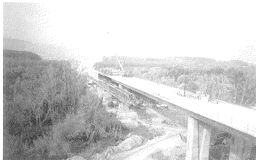
Fotografía 4.3.3-3 Vista del primer vano de 60 m ejecutado.
