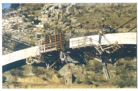
Foto 4. Vistas de los carros de avance. Picture 4. Views of travelling formwork.
