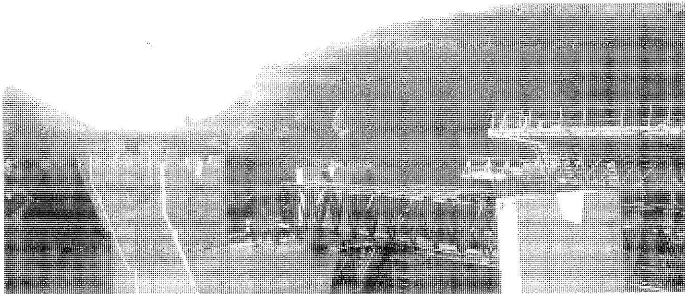
Fotografía 4.1.3-4 Vista de la "nariz" de la cimbra entrando en pila.
