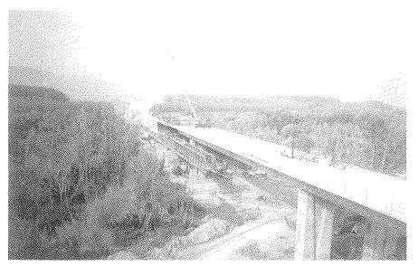
Fotografía 4.3.3-3 Vista del primer vano de 60 m ejecutado.
