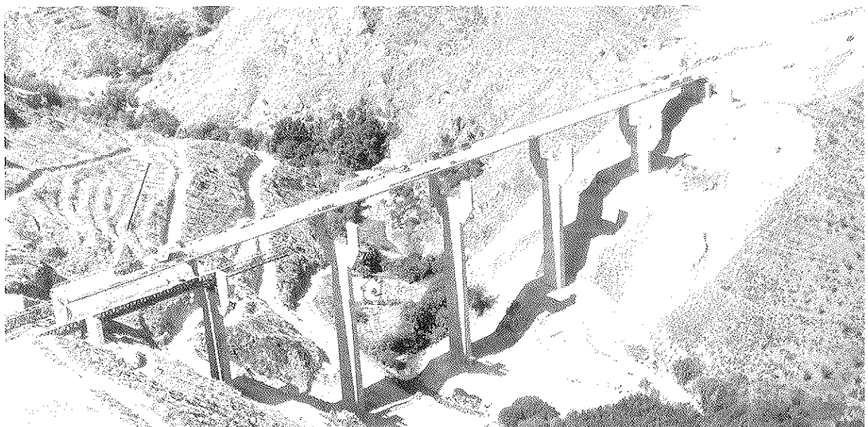
Fotografía 4.2.3-4 Vista aérea del inicio del segundo tablero.
