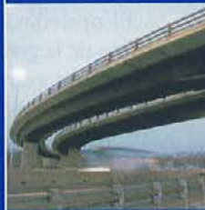
Puente sobre la N-IV y la M-30 de Madrid
