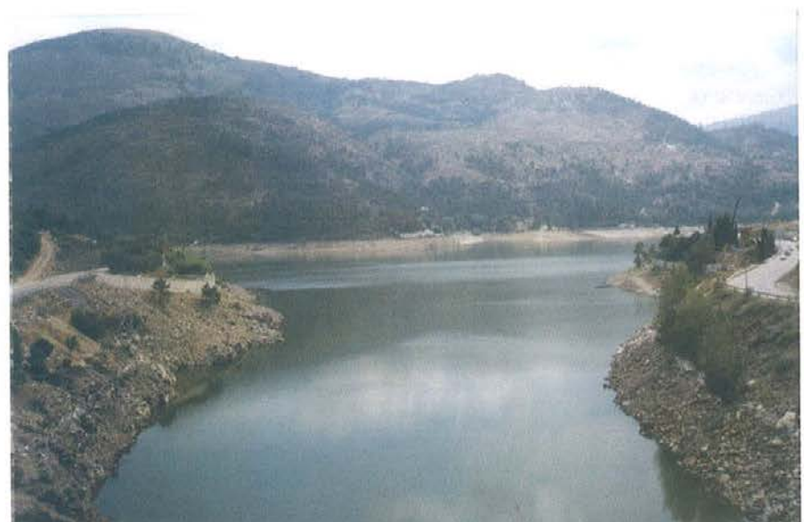
Foto 2. Vista del emplazamiento en una de las primeras visitas durante la redacción del proyecto.
