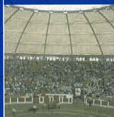
Cubierta de la Plaza de Toros de Pontevedra
