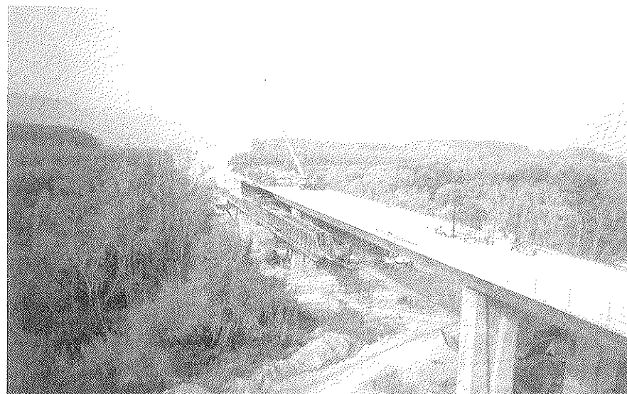
Fotografía 4.3.3-3 Vista del primer vano de 60 m ejecutado.
