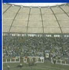
Cubierta de la Plaza de Toros de Pontevedra
