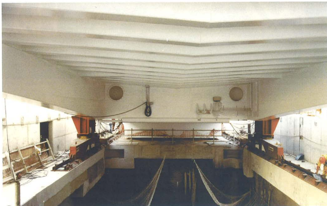
Fig. 25. Lanzamiento. Fig. 25. Launching.
