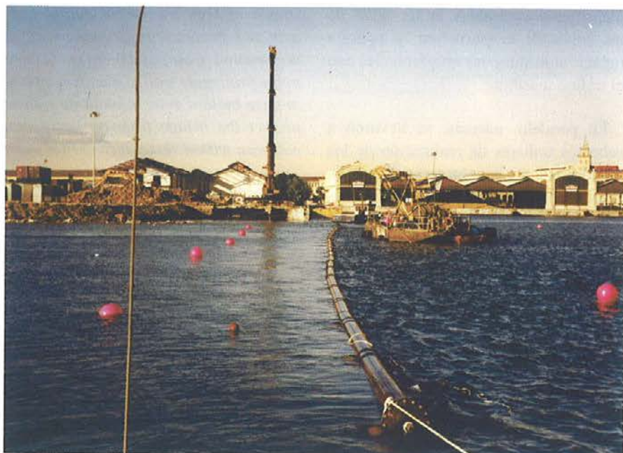
Fig. 17: Tendido tubería submarina. Fig. 17. Laying undersea pipes.
