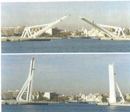
Foto de portada: Puente levadizo en el Puerto de Valencia
