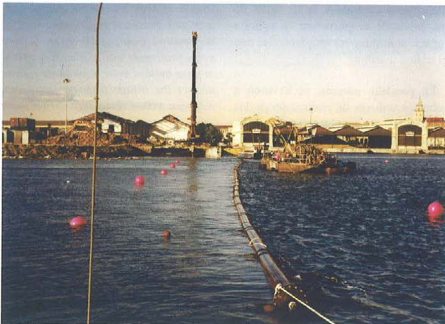
Fig. 17: Tendido tubería submarina. Fig. 17. Laying undersea pipes.
