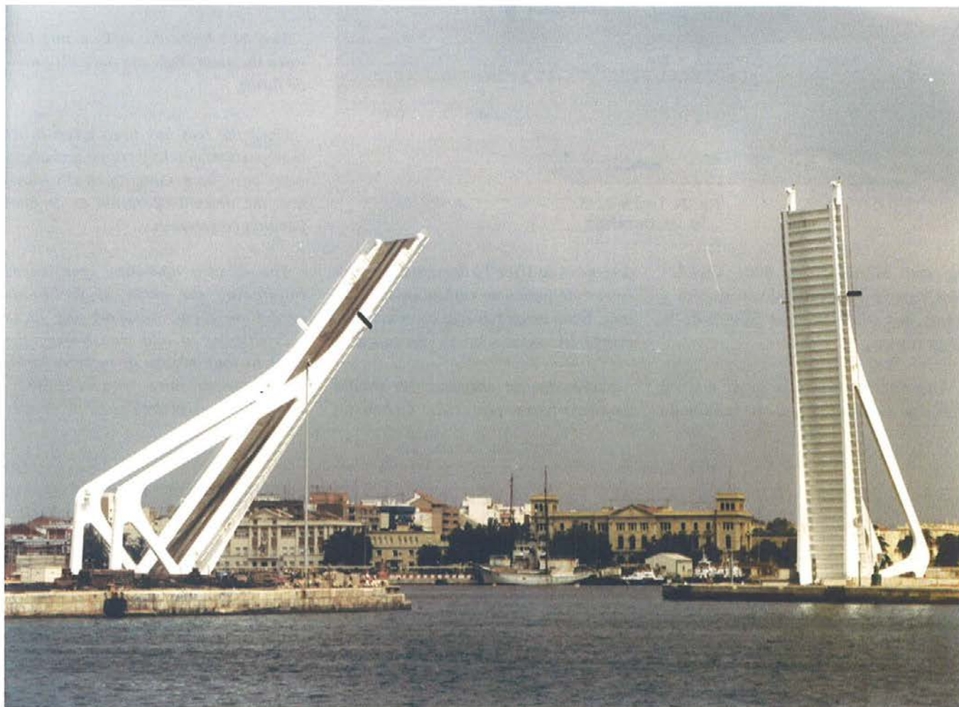
Fig. 26. Apertura de la hoja. Fig. 26. Leaf opening.
