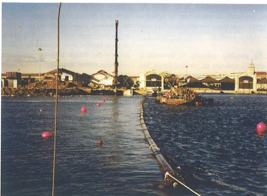
Fig. 17: Tendido tubería submarina. Fig. 17. Laying undersea pipes.
