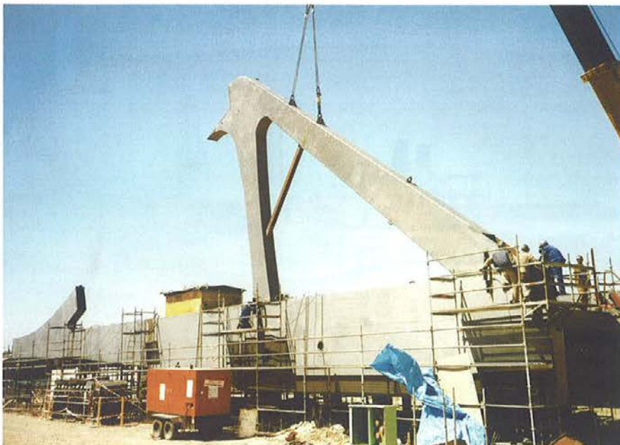
Fig. 23. Montaje en obra. Fig. 23. In-situ erection.
