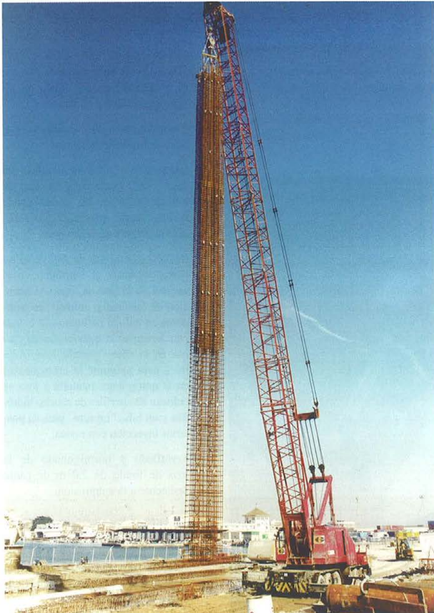
Fig. 18. Jaula de armaduras. Fig. 18. Reinforcement cage.
