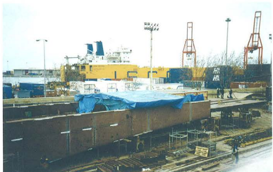
Fig. 22. Montaje en blanco en taller. Fig. 22. Factory pre-fitting.
