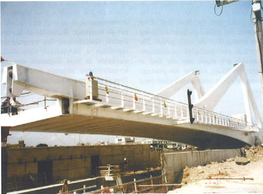
Fig. 24. Lanzamiento. Fig. 24. Launching.
