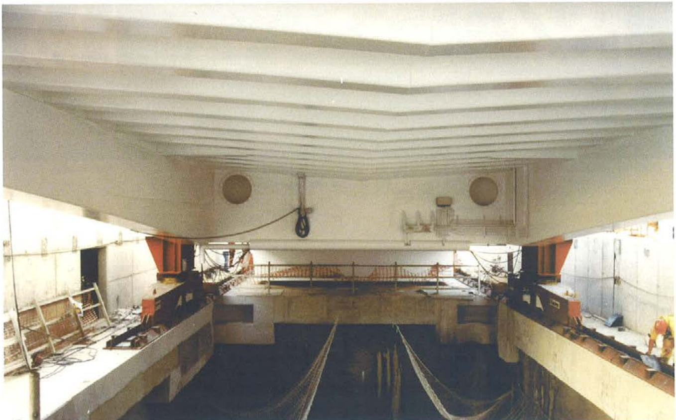
Fig. 25. Lanzamiento. Fig. 25. Launching.
