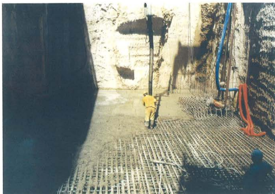
Fig. 21. Hormigonado losa de fondo. Fig. 21. Concreting the bottom slab.
