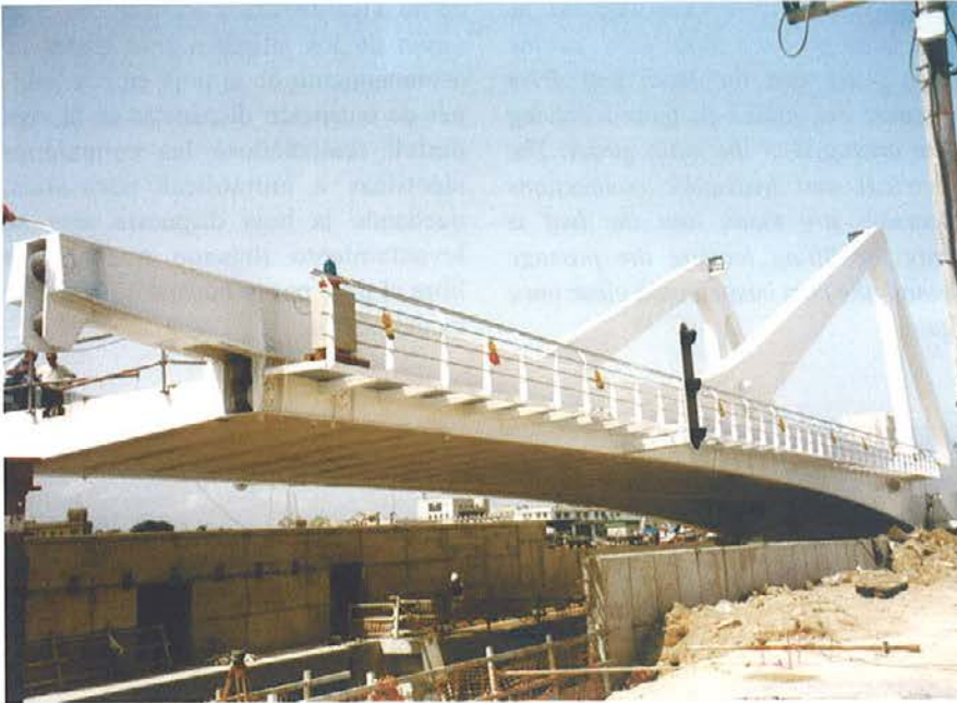
Fig. 24. Lanzamiento. Fig. 24. Launching.
