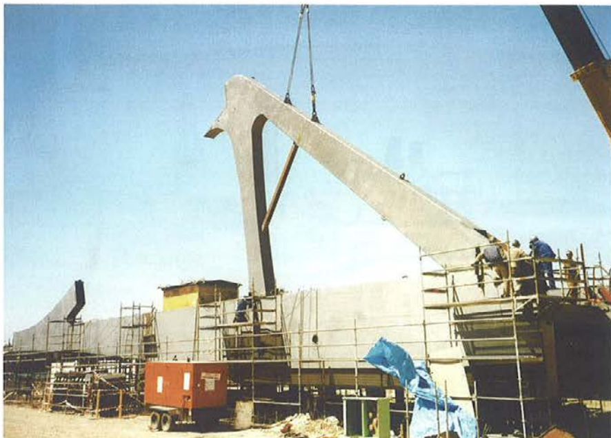
Fig. 23. Montaje en obra. Fig. 23. In-situ erection.
