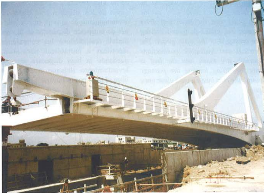
Fig. 24. Lanzamiento. Fig. 24. Launching.
