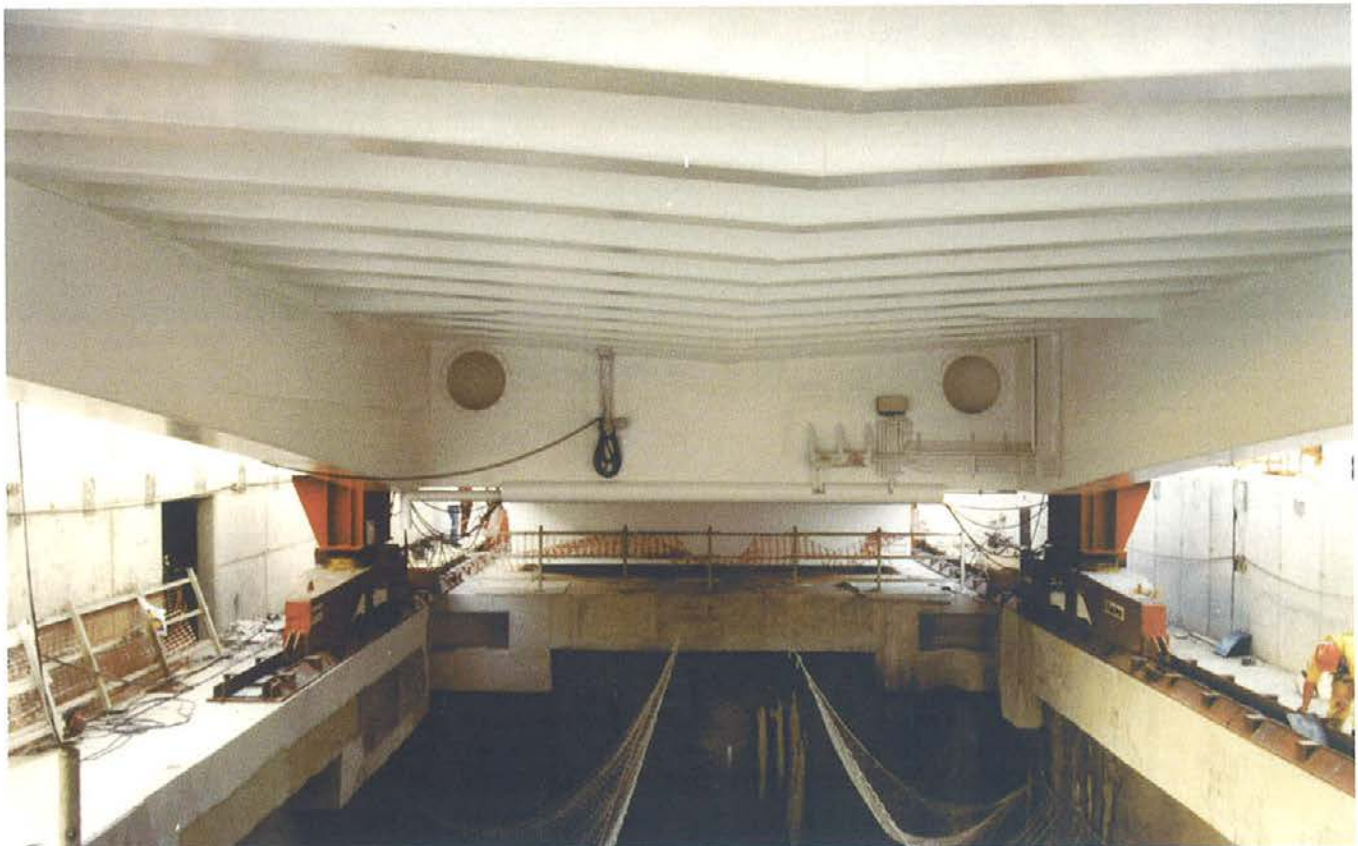
Fig. 25. Lanzamiento. Fig. 25. Launching.
