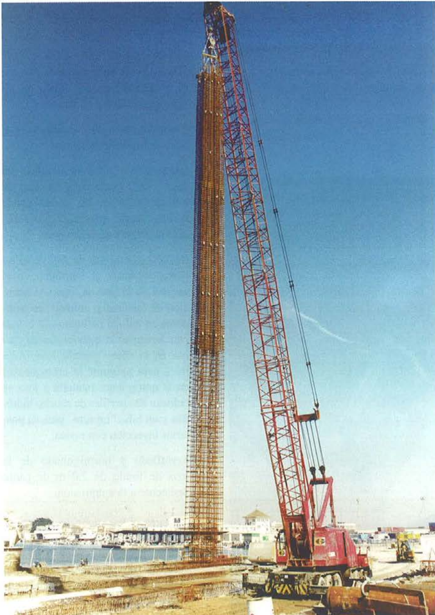
Fig. 18. Jaula de armaduras. Fig. 18. Reinforcement cage.
