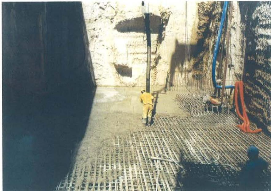
Fig. 21. Hormigonado losa de fondo.
