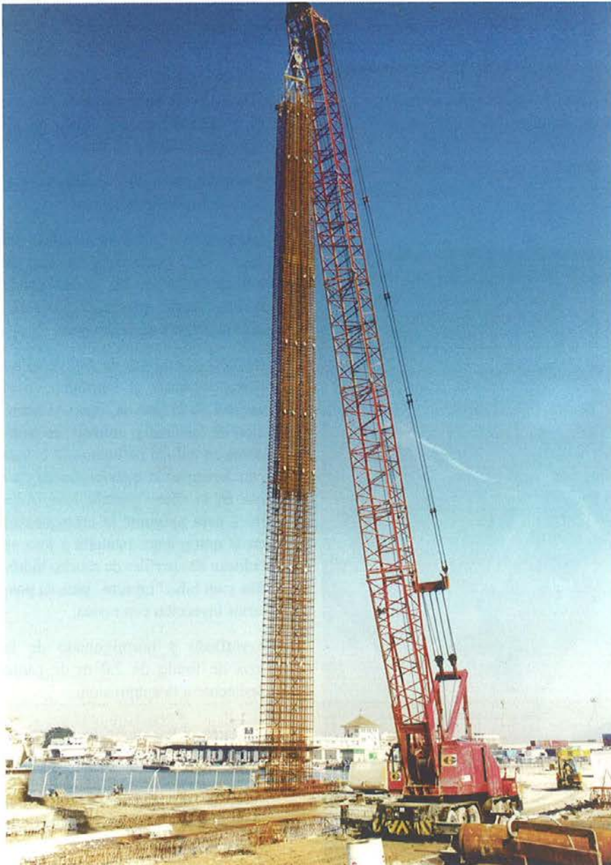
Fig. 18. Jaula de armaduras. Fig. 18. Reinforcement cage.
