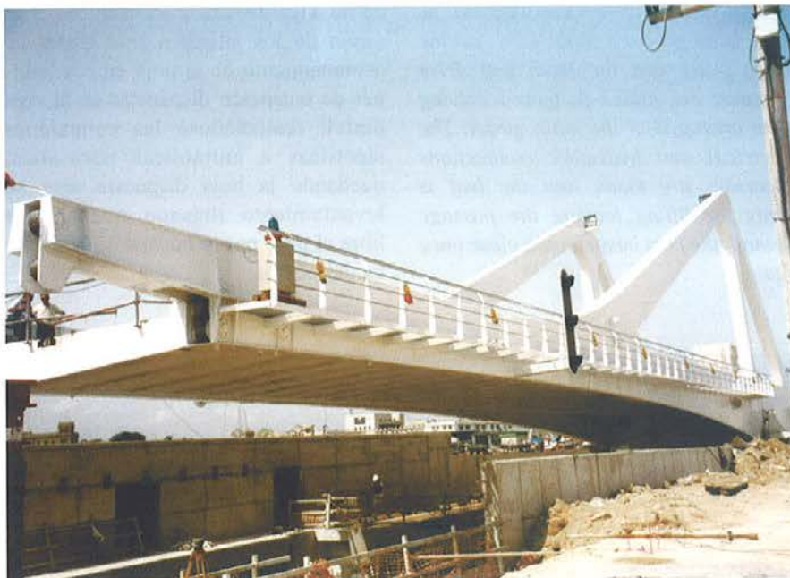
Fig. 24. Lanzamiento. Fig. 24. Launching.
