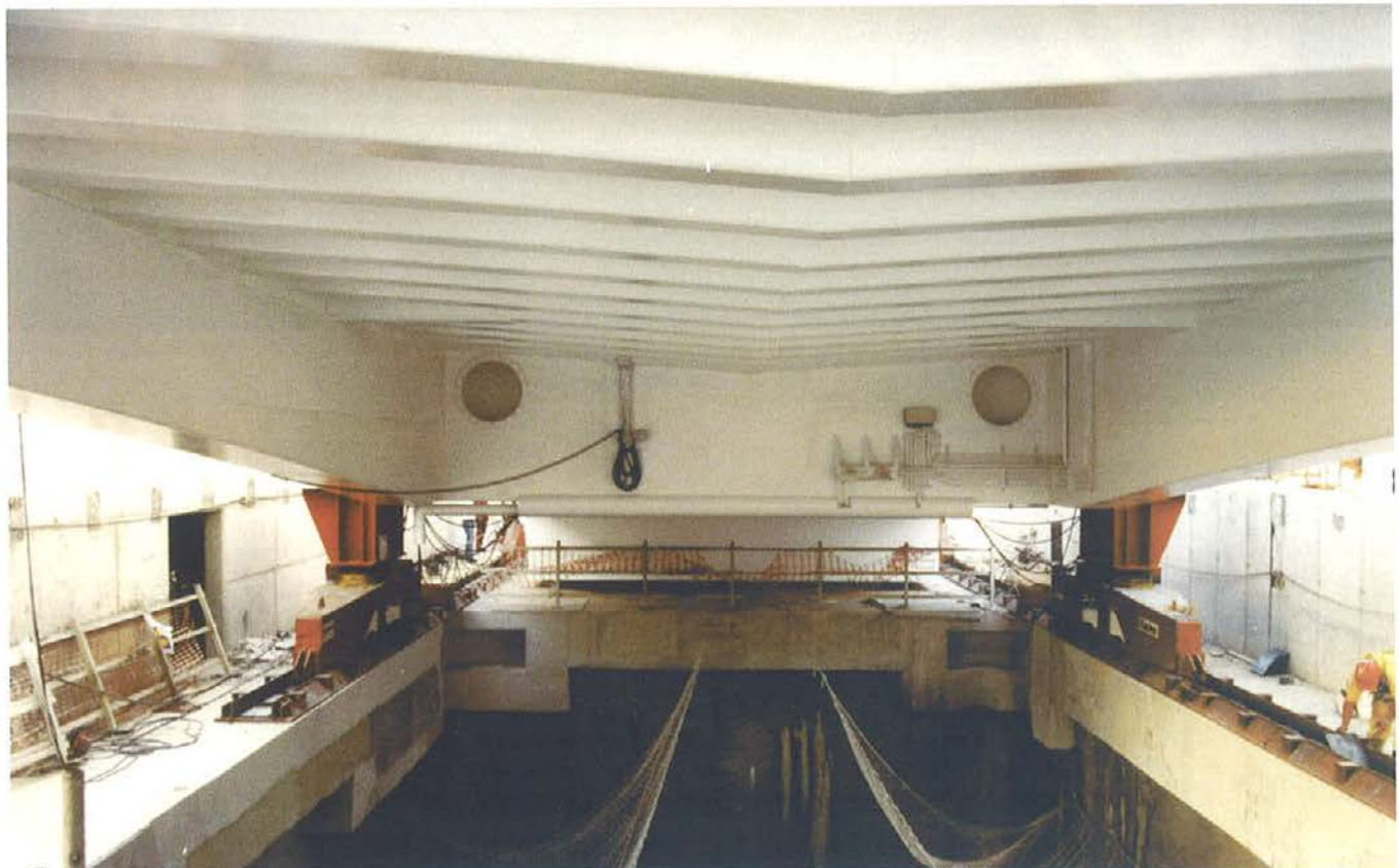
Fig. 25. Lanzamiento. Fig. 25. Launching.
