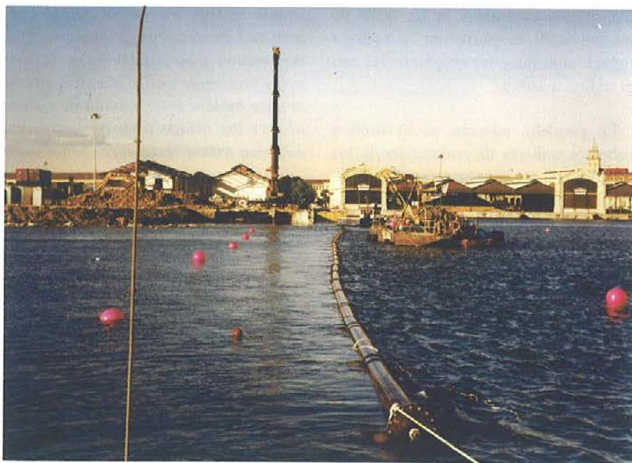
Fig. 17: Tendido tubería submarina.
