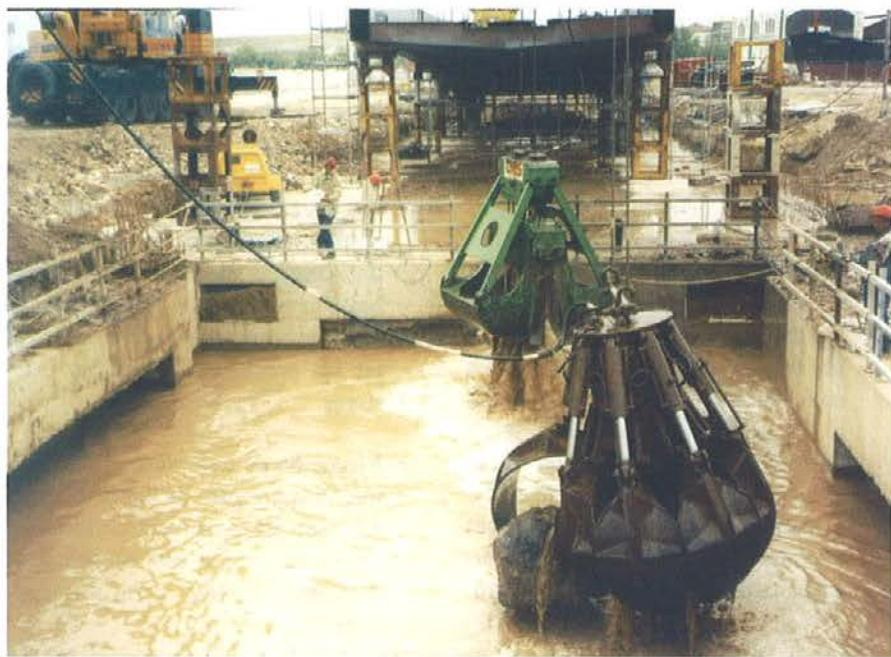
Fig. 19. Excavación interior foso.
