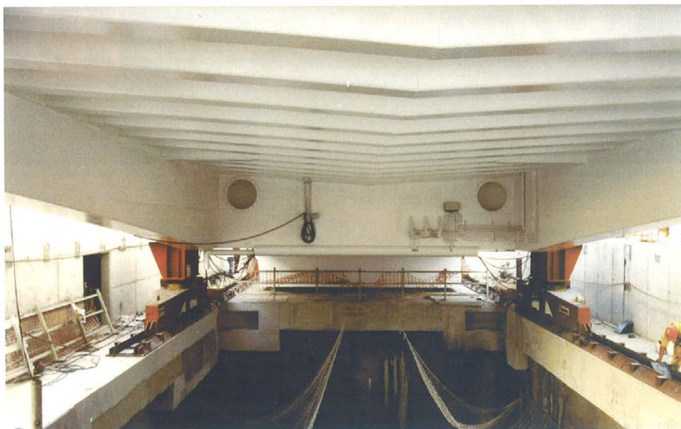
Fig. 25. Lanzamiento. Fig. 25. Launching.
