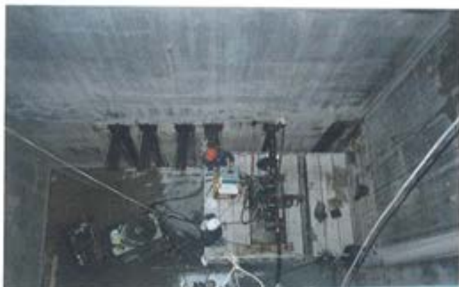
Figura 6.6.3.3 Enfilado tendones longitudinales 250 m
