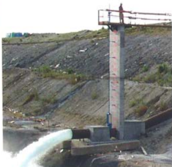
Figura 7.2.4. Sifón llenando la dársena.
