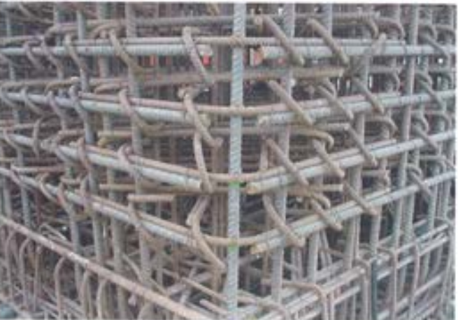
Figura 6.5.1. Disposición de las armaduras.
