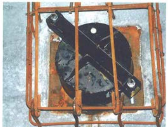
Figura 4.12. Anclaje preparado para el sellado.
