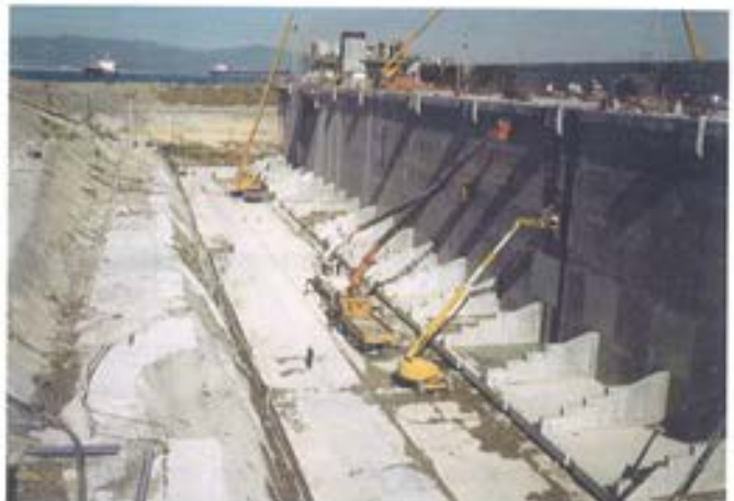
Figura 6.4.11. Inspección de paramentos.
