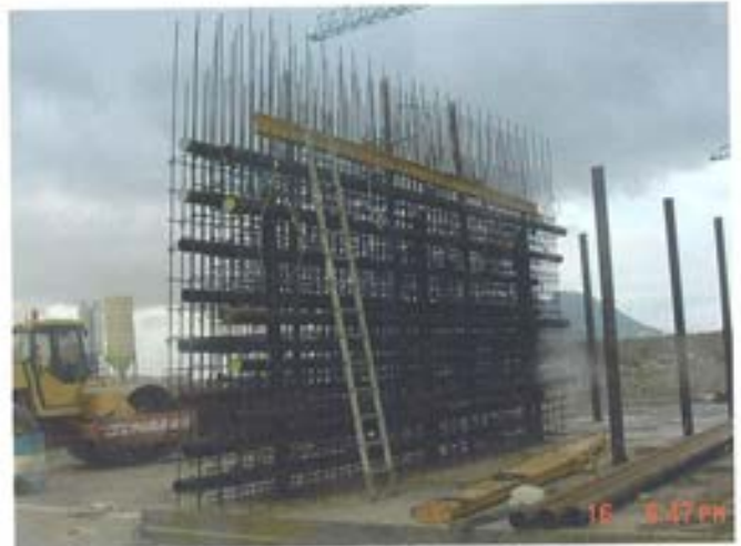
Figura 5.4.4. Prefabricación de cajas de armadura y tubos.
