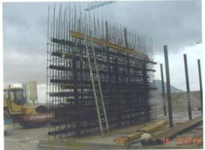
Figura 5.4.4. Prefabricación de cajas de armadura y tubos.
