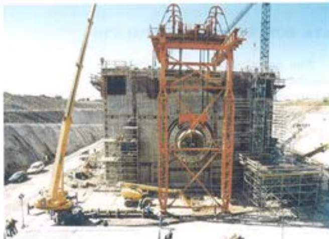
Figura 6.2.5. Rótula. Izado del resto de elementos.
