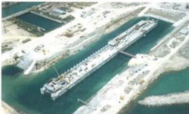
Figura 6.2.6. Puente de acceso.
