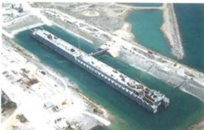
Figura 7.4.1 Dique en proceso de flotación.
