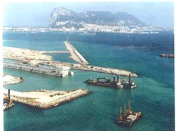
Figura 7.3.7. Dragas Razende Bol y equipo de perforación.
