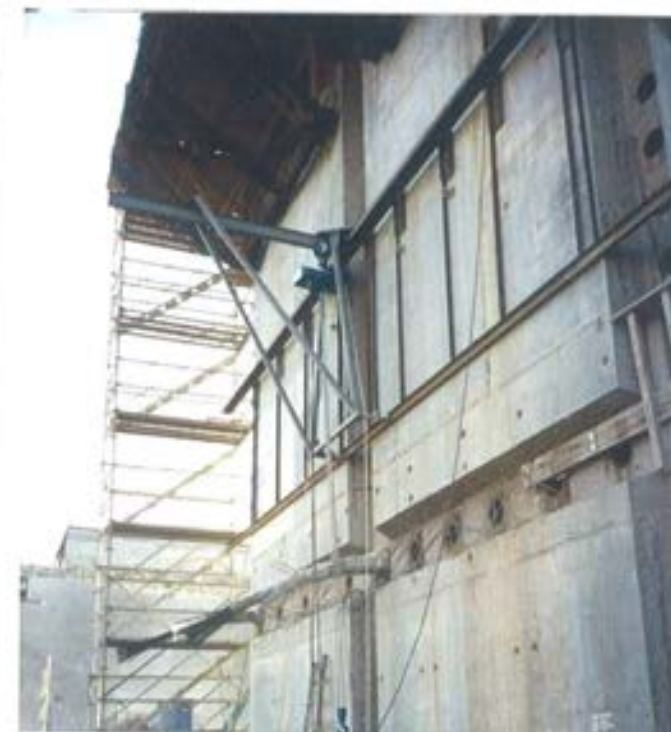
Figura 6.6.3.2. Utilaje para manipulación de gatos de tesado.
