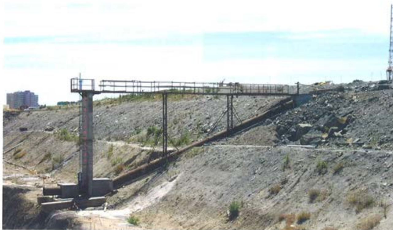
Figura 7.2.2 Sifón de llenado de la dársena.
