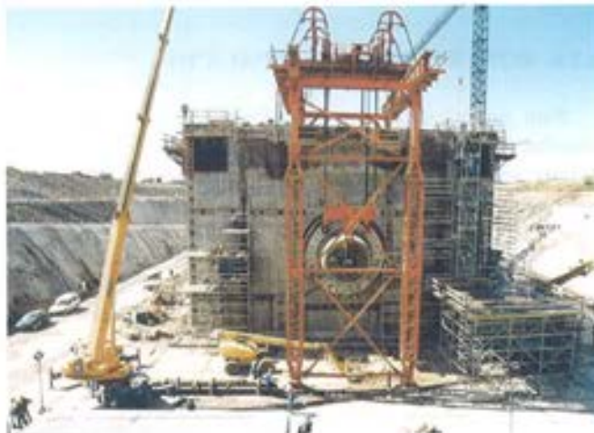
Figura 6.2.5. Rótula. Izado del resto de elementos.
