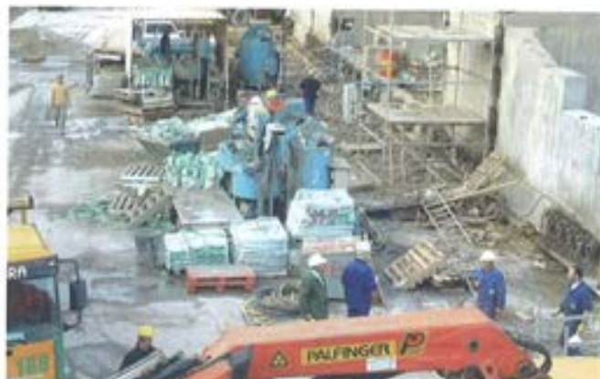
Figura 6.6.3.4. Equipos inyección cables longitudinales
