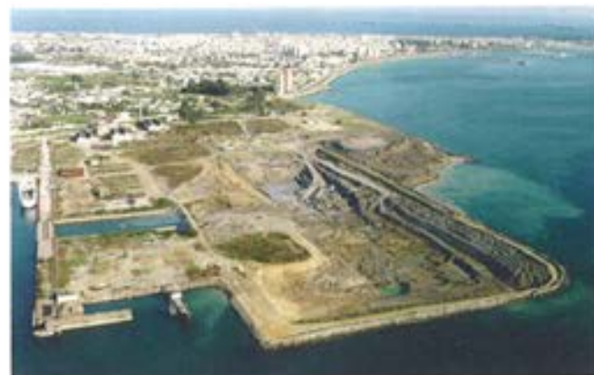
Figura 6.1.3. Excavación de la dársena.
