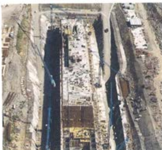
Figura 6.4.4. Evolución de los trabajos.
