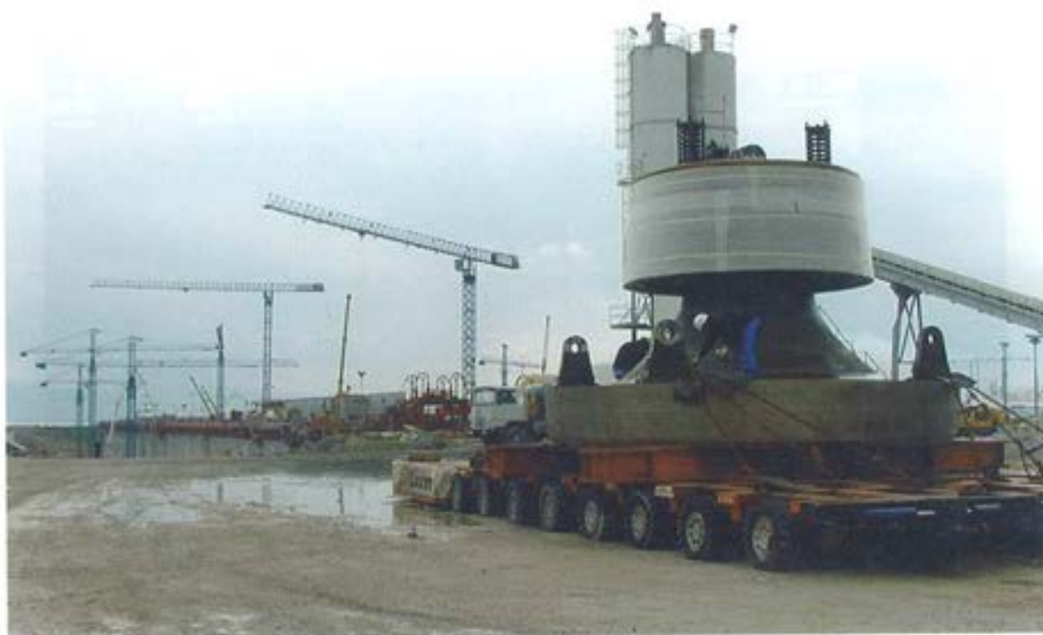
Figura 5.1.9. Transporte de la rótula.
