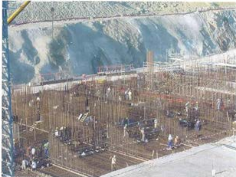
Figura 5.4.1. Aspecto general de los trabajos de armado.
