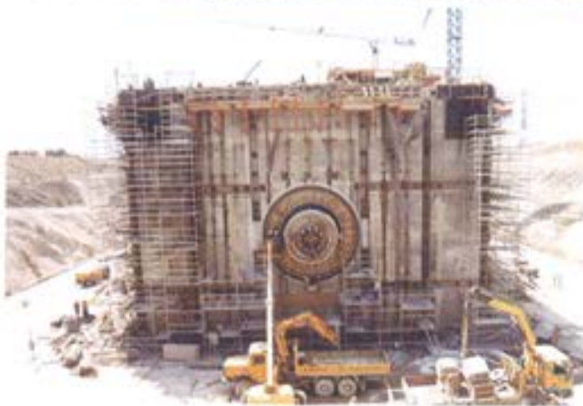
Figura 6.4.10. Sellado de anclajes de postesado.
