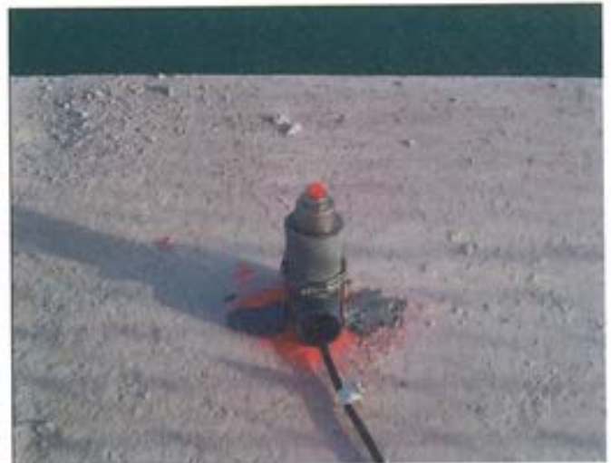
Figura 5.7.8. Sensores de presión hidrodinámica dispuestos en cubierta.
