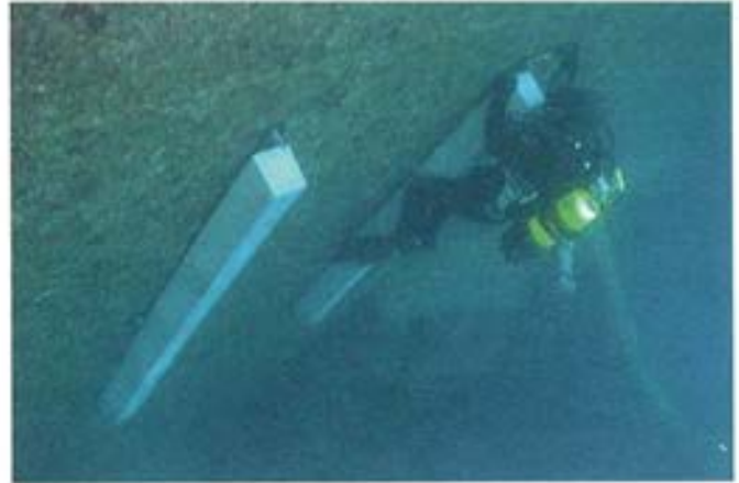
Figura 7.6.3. Instalación de los ánodos de sacrificio.
