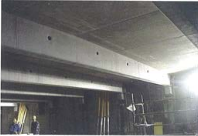
Figura 6.4.9. Vigas y prelosas prefabricadas.
