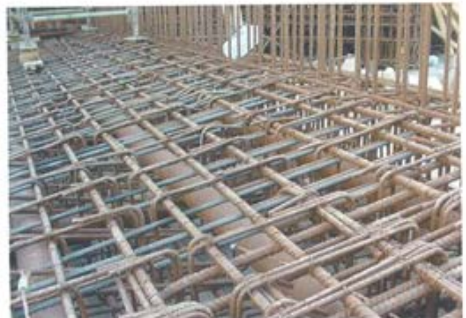
Figura 5.4.5. Vigas prefabricadas con sus tubos de pretensado.
