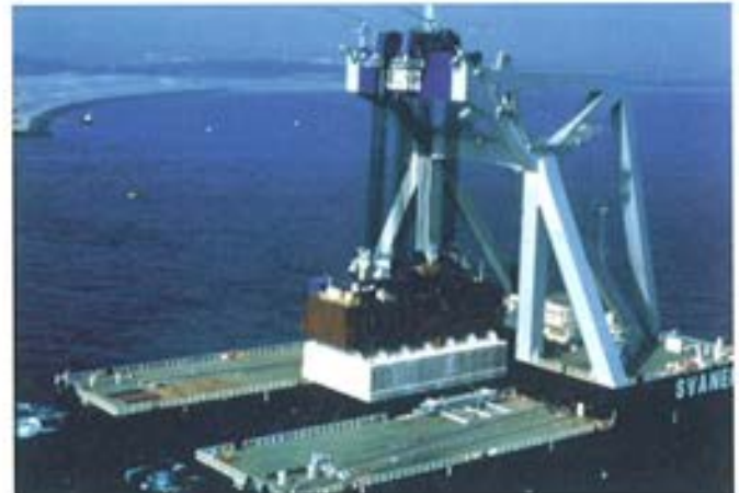
Figura .9.6. Grandes cajones para cimentación de puentes.
