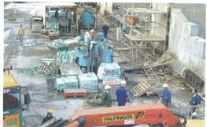
Figura 6.6.3.4. Equipos inyección cables longitudinales
