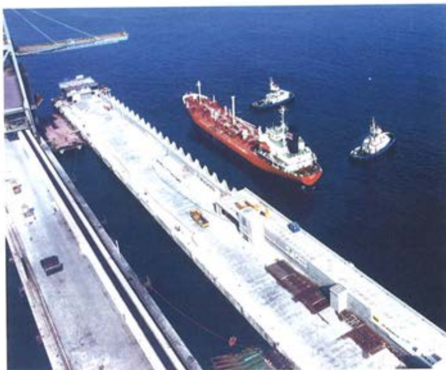
Figura 5.3.2. Lastrado con barco tanque en Algeciras.
