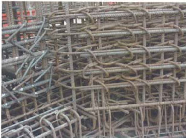
Figura 5.4.2. Horquillas y cercos de armado transversal.
