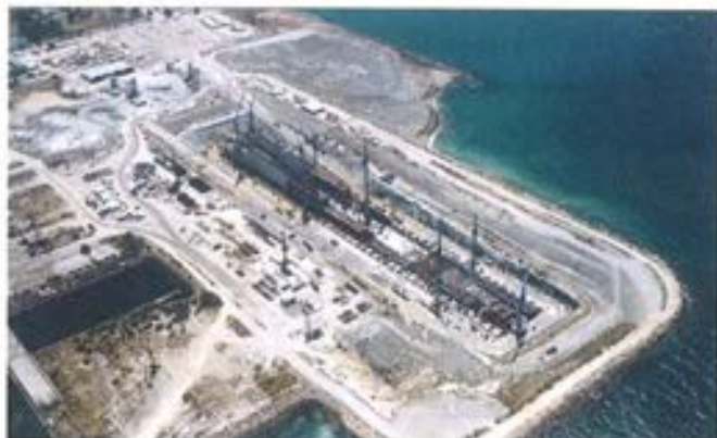
Figura 6.2.7. Vista general de las instalaciones.
