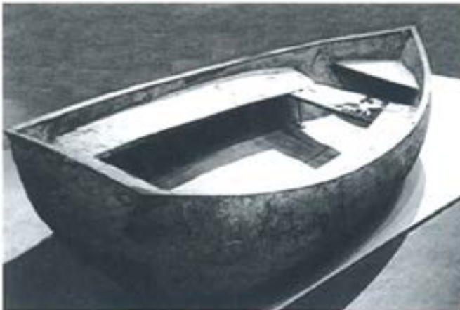
Figura 1.3. Barco de "Lambot".
