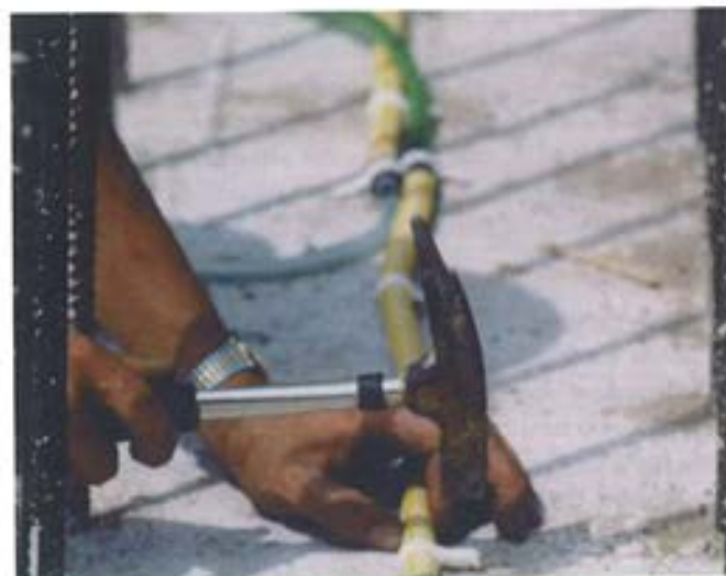
Figura 5.5.4. Detalle de sujeción de la manguera en una junta de hormigonado.
