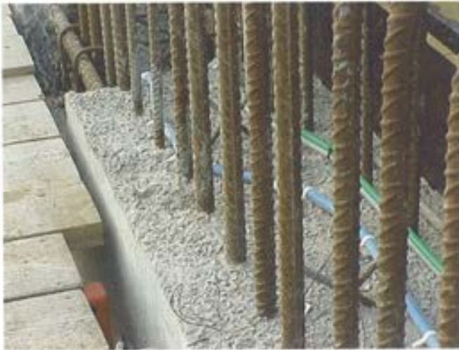
Figura 6.5.7. Junta de hormigonado.
