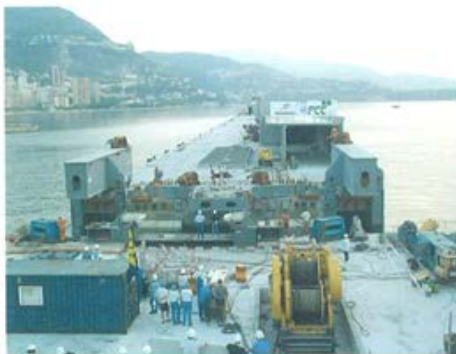
Figura 7.5.12. El dique en la fase de alineación a unos 10 m de distancia.
