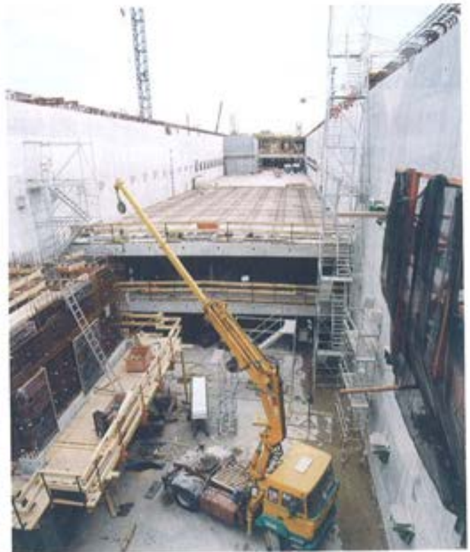
Figura 6.5.3. Encofrado de losas.
