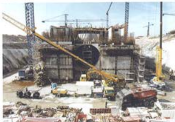
Figura 6.4.7. Hormigonado de la rótula.
