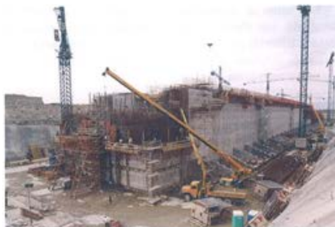
Figura 6.5.8. Ferralla y encofrado zona rótula.
