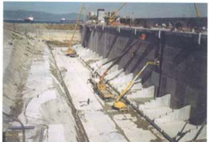
Figura 6.4.11. Inspección de paramentos.
