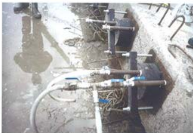
Figura 4.11. Anclaje preparado para la inyección al vacío.
