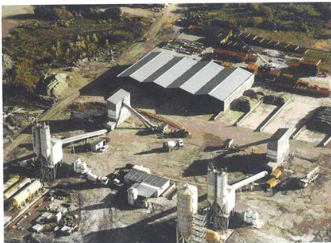
Figura 3.2.2 Vista aérea de las dos plantas de hormigón Skako y zona de acopio de áridos con el techado correspondiente a los áridos finos.
