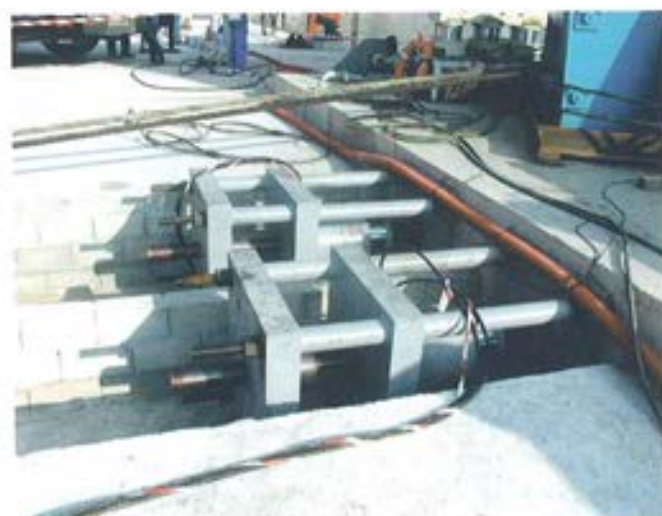
Figura 7.5.8. Dos mesas de un lado del sistema de retención.
