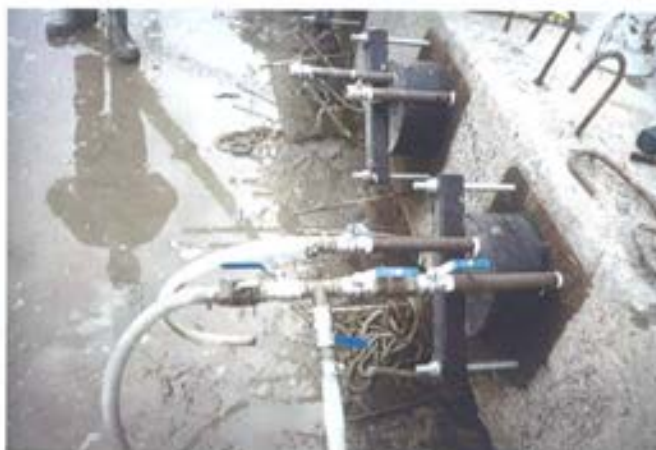
Figura 4.11. Anclaje preparado para la inyección al vacío.
