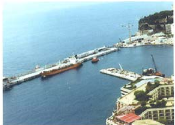
Figura 7.5.11. Lastrado del dique en Mónaco antes de la conexión.
