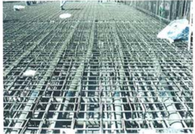
Figura 4.2. Vaina formada por tubos rígidos de acero.
