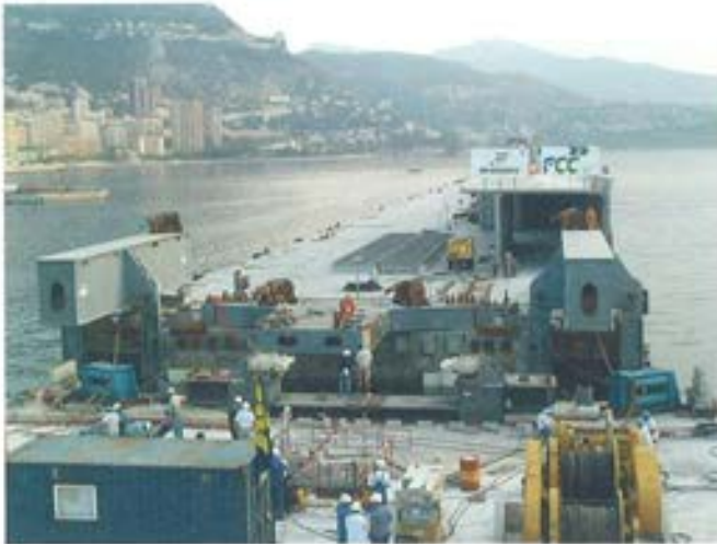
Figura 7.6.1. Elementos auxiliares instalados para la conexión del dique.
