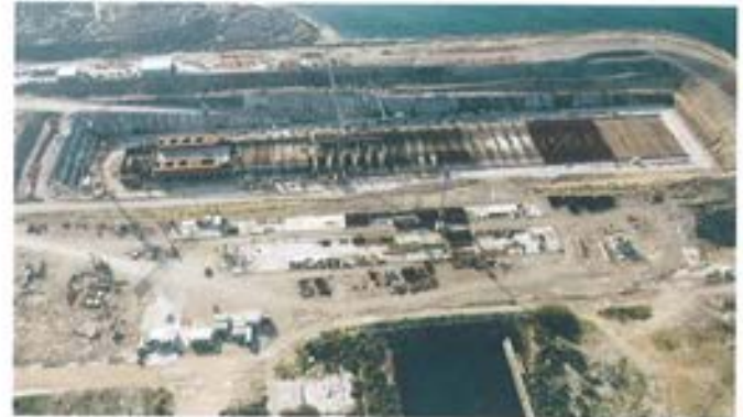
Figura 6.2.2. Parques de ferralla.
