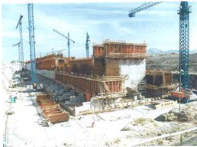
Figura 6.5.2. Encofrado trepante para los muros.
