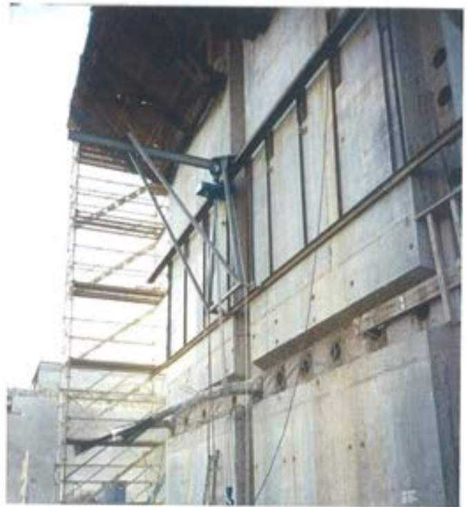
Figura 6.6.3.2. Utilaje para manipulación de gatos de tesado.
