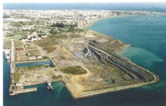
Figura 6.1.3. Excavación de la dársena.
