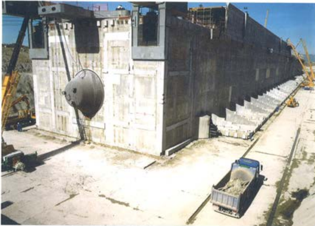
Figura 5.1.10. Protección de la rótula para el transporte.
