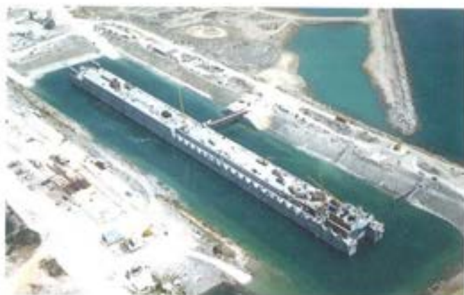
Figura 7.4.1 Dique en proceso de flotación.
