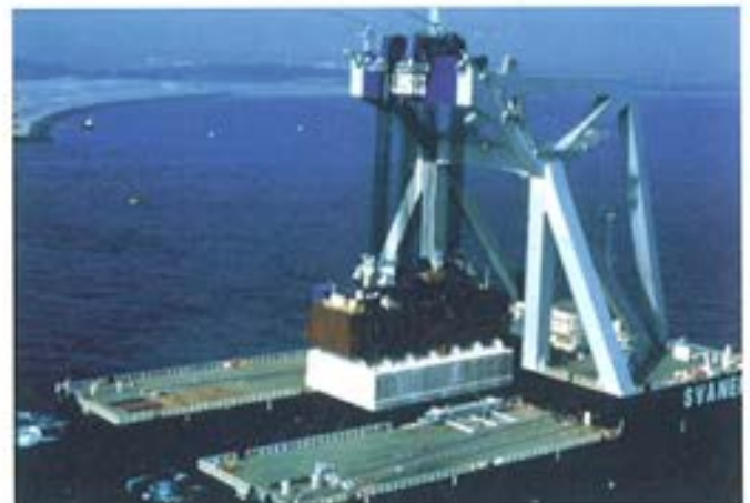
Figura .9.6. Grandes cajones para cimentación de puentes.
