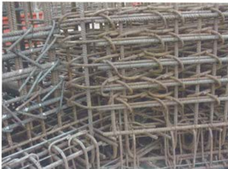
Figura 5.4.2. Horquillas y cercos de armado transversal.
