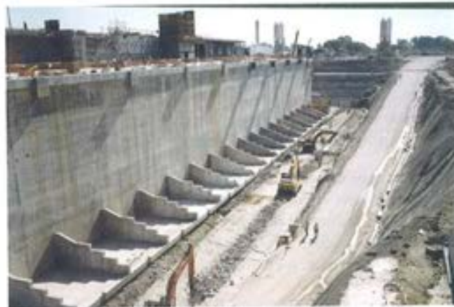
Figura 6.4.13. Retirada de instalaciones.
