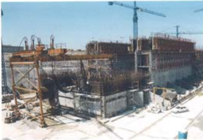
Figura 6.2.3. Rótula. Izado de elementos embebidos.
