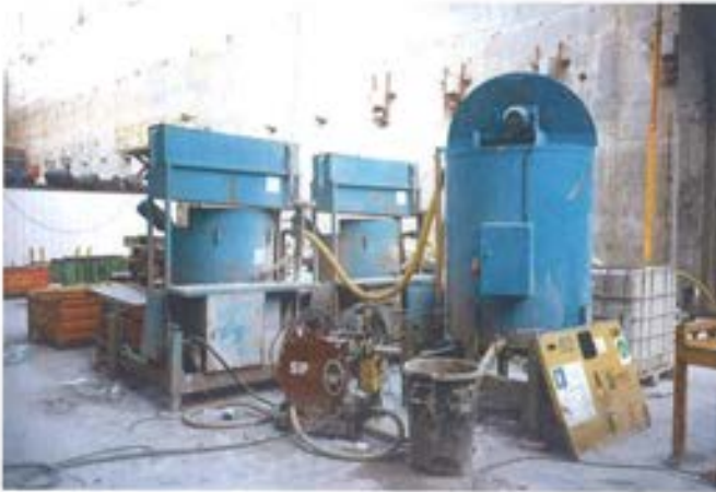
Figura 4.10. Equipo de inyección.
