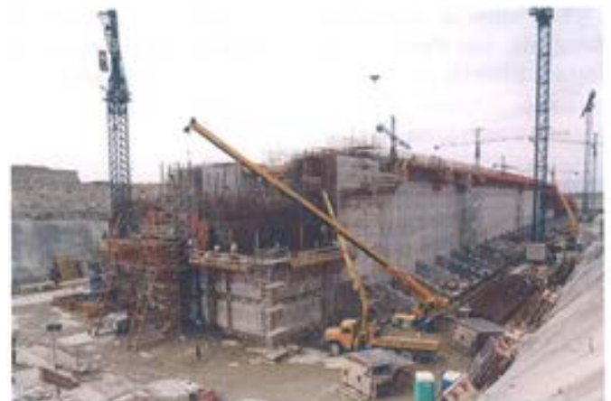
Figura 6.5.8. Ferralla y encofrado zona rótula.
