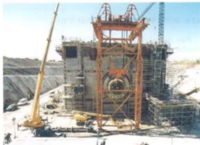
Figura 6.2.5. Rótula. Izado del resto de elementos.
