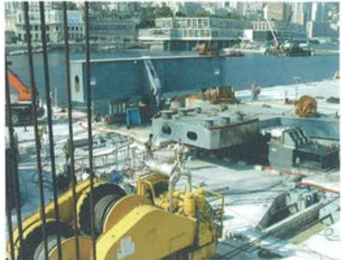
Figura 7.5.4. Vigas de posicionamiento (la viga central en primer término).
