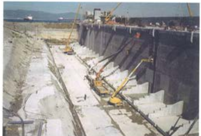
Figura 6.4.11. Inspección de paramentos.
