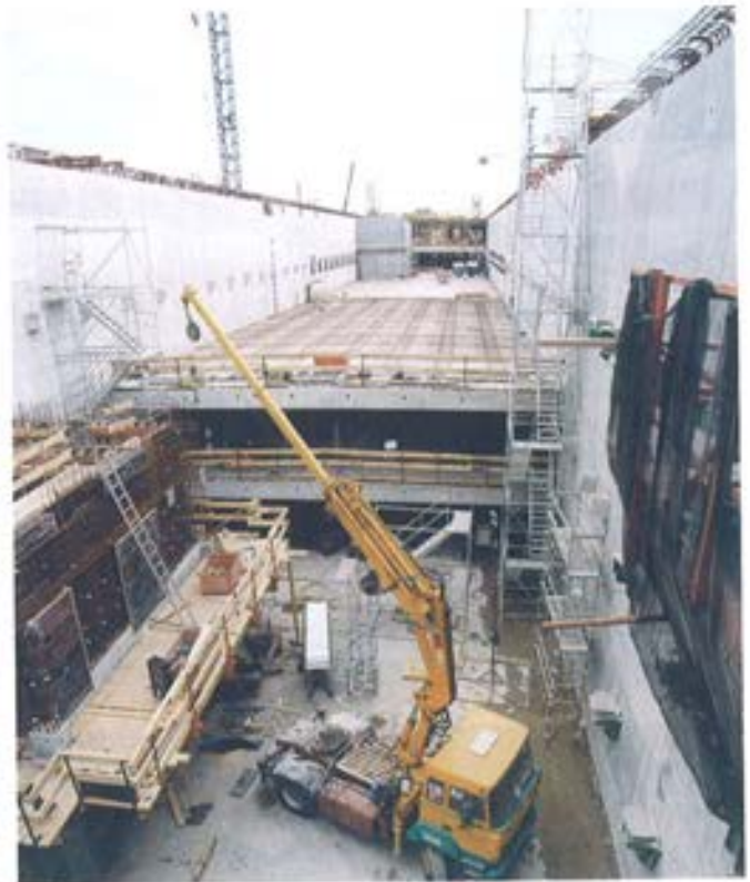
Figura 6.5.3. Encofrado de losas.
