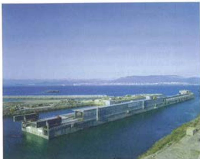
Figura 7.4.3. Operación de salida de la dársena.
