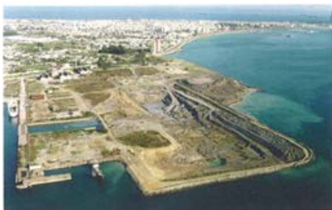
Figura 6.1.3. Excavación de la dársena.
