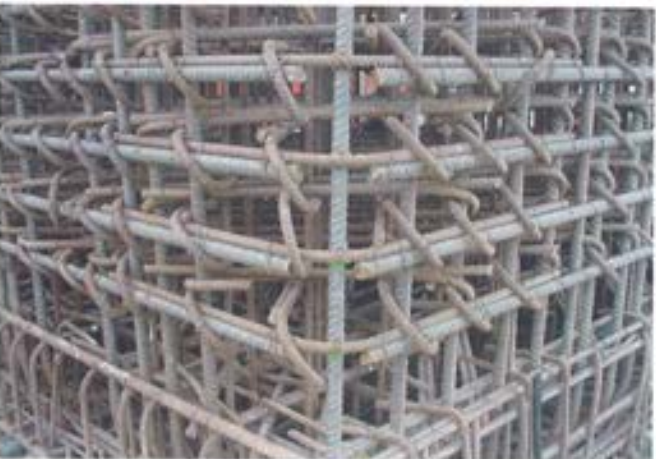
Figura 6.5.1. Disposición de las armaduras.
