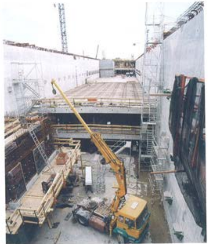
Figura 6.5.3. Encofrado de losas.
