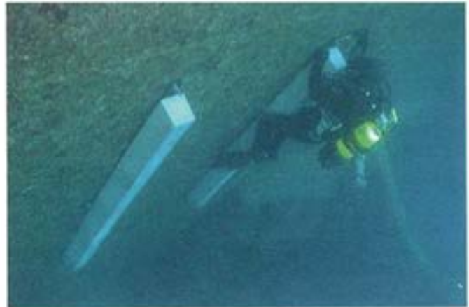
Figura 7.6.3. Instalación de los ánodos de sacrificio.
