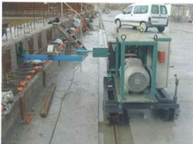
Figura 6.6.3.1. Enfiladora sobre carro de traslación.
