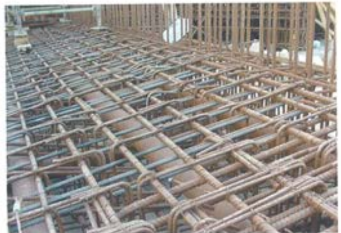
Figura 5.4.5. Vigas prefabricadas con sus tubos de pretensado.
