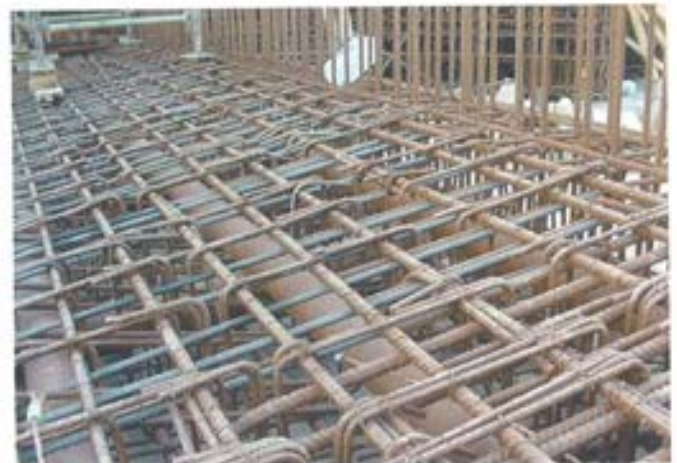
Figura 5.4.5. Vigas prefabricadas con sus tubos de pretensado.
