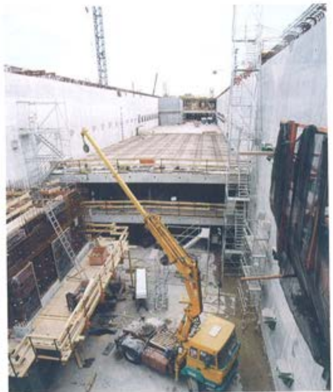
Figura 6.5.3. Encofrado de losas.
