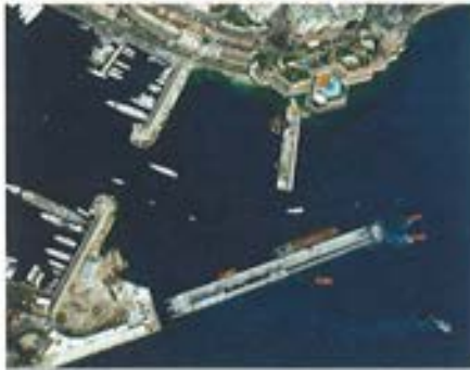
Foto portada: Vista panorámica del puerto de Mónaco con el dique flotante en su maniobra de aproximación para colocación en su posición final.
