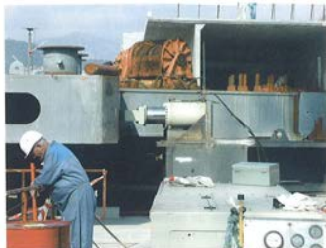
Figura 7.5.6. Tres gatos horizontales actuando sobre la viga central.
