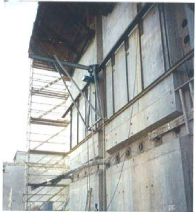
Figura 6.6.3.2. Utilaje para manipulación de gatos de tesado.
