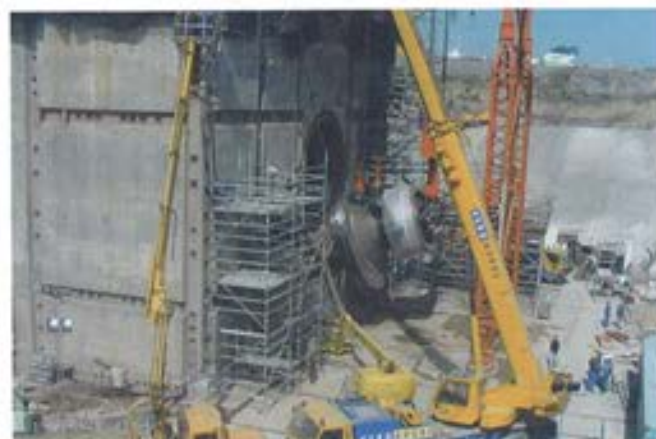
Figura 6.4.8. Montaje de la rótula.
