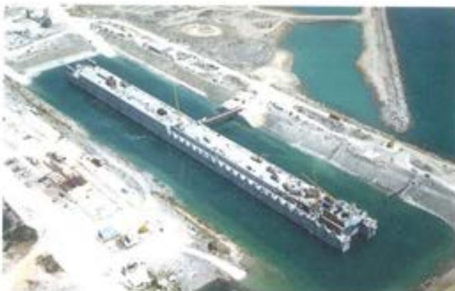
Figura 7.4.1 Dique en proceso de flotación.
