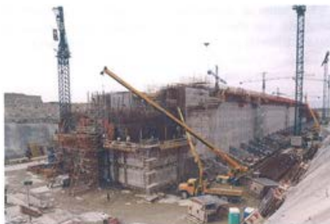
Figura 6.5.8. Ferralla y encofrado zona rótula.
