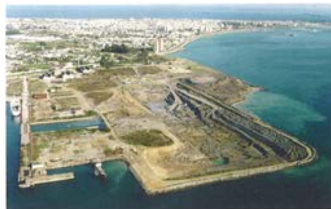
Figura 6.1.3. Excavación de la dársena.
