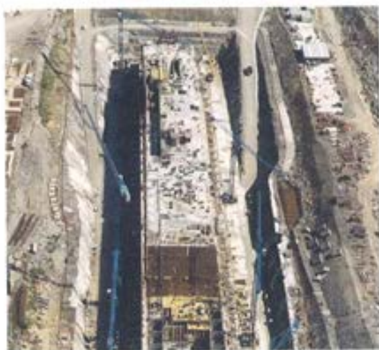
Figura 6.4.4. Evolución de los trabajos.
