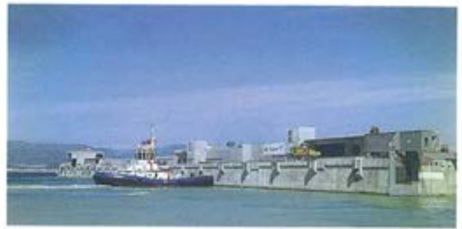
Figura 7.4.5. Maniobra de los remolcadores.
