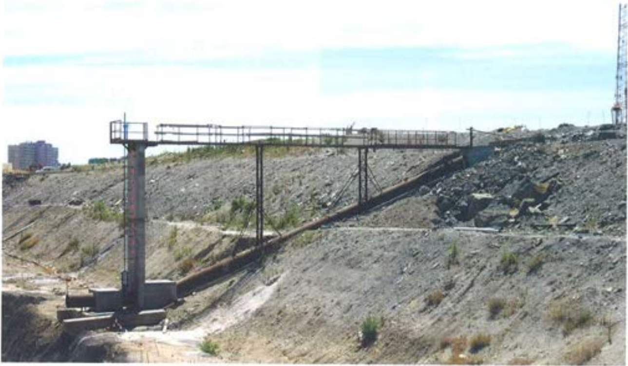
Figura 7.2.2 Sifón de llenado de la dársena.
