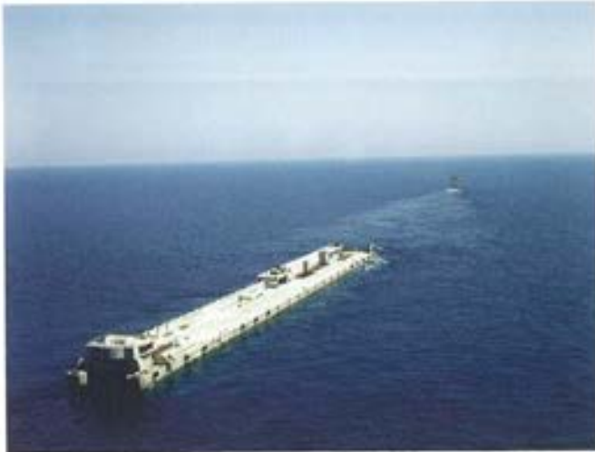
Figura 7.4.16. Transporte del dique.
