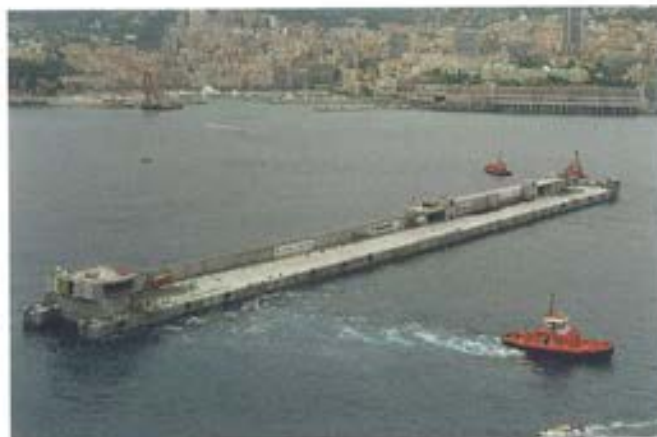
Figura 7.5.1. Maniobra de giro y posicionamiento del dique en Mónaco.
