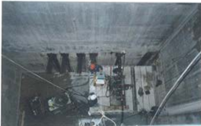
Figura 6.6.3.3 Enfilado tendones longitudinales 250 m
