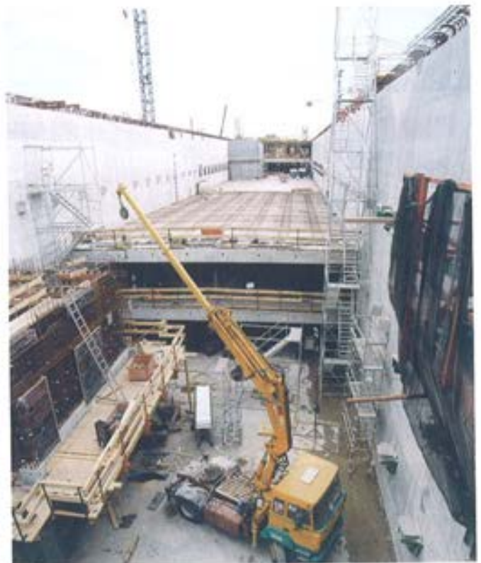
Figura 6.5.3. Encofrado de losas.
