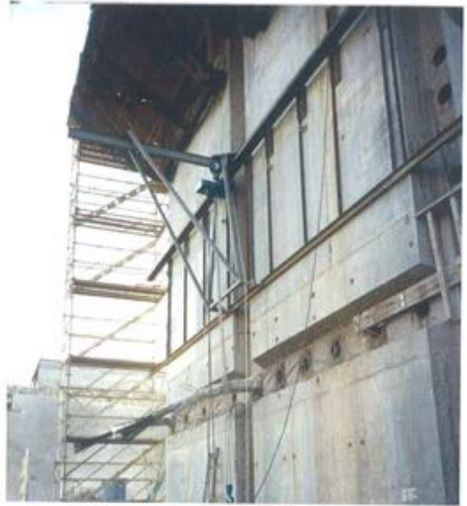
Figura 6.6.3.2. Utilaje para manipulación de gatos de tesado.
