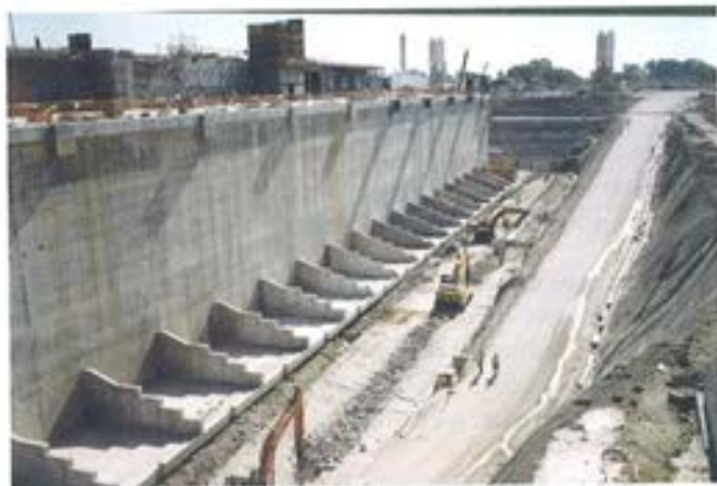
Figura 6.4.13. Retirada de instalaciones.
