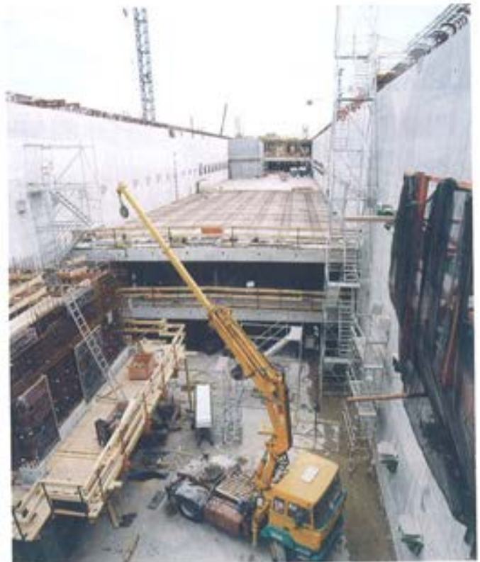
Figura 6.5.3. Encofrado de losas.
