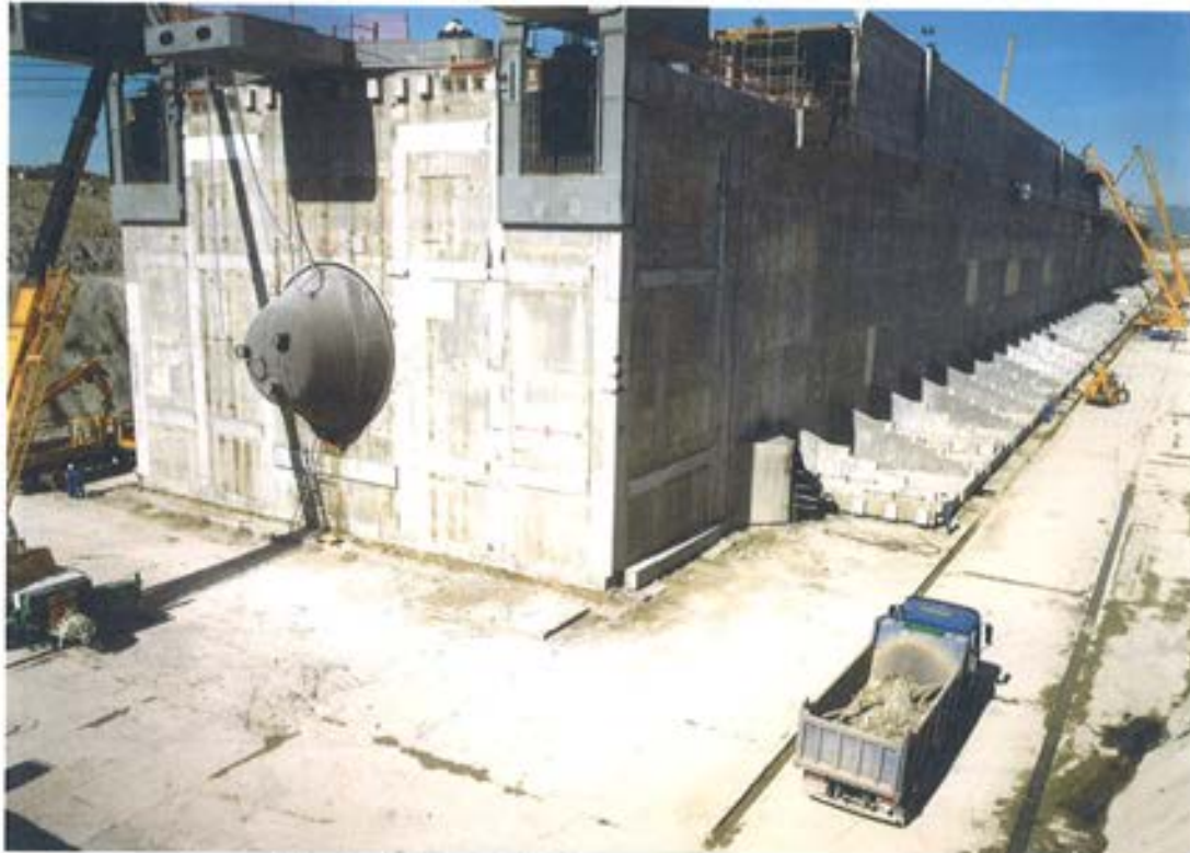
Figura 5.1.10. Protección de la rótula para el transporte.
