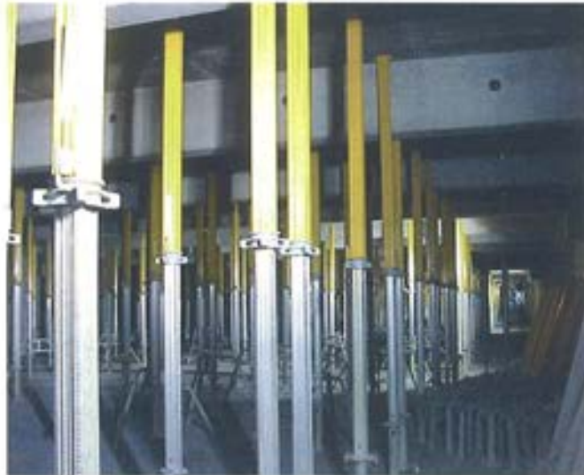
Figura 6.5.4. Apuntalamiento losa +3.
