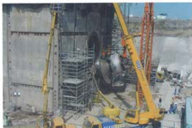
Figura 6.4.8. Montaje de la rótula.
