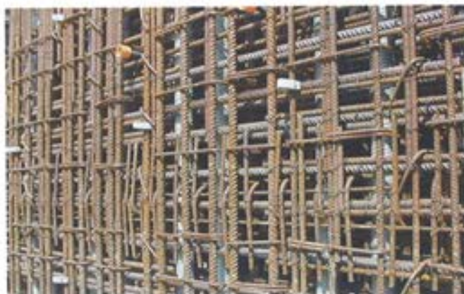
Figura 5.4.8. Armadura en volumen.
