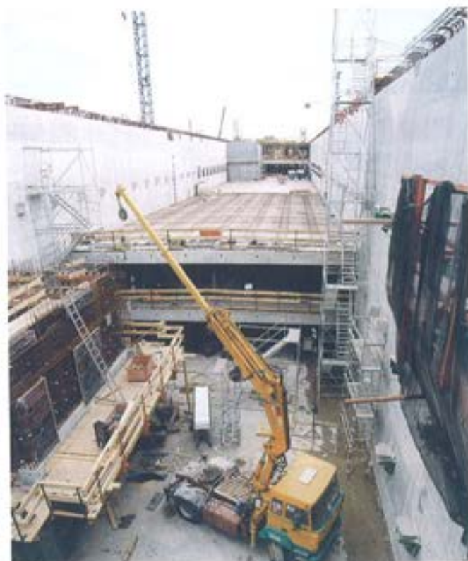
Figura 6.5.3. Encofrado de losas.
