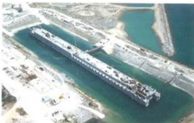
Figura 7.4.1 Dique en proceso de flotación.
