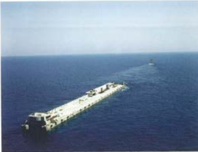
Figura 7.4.16. Transporte del dique.
