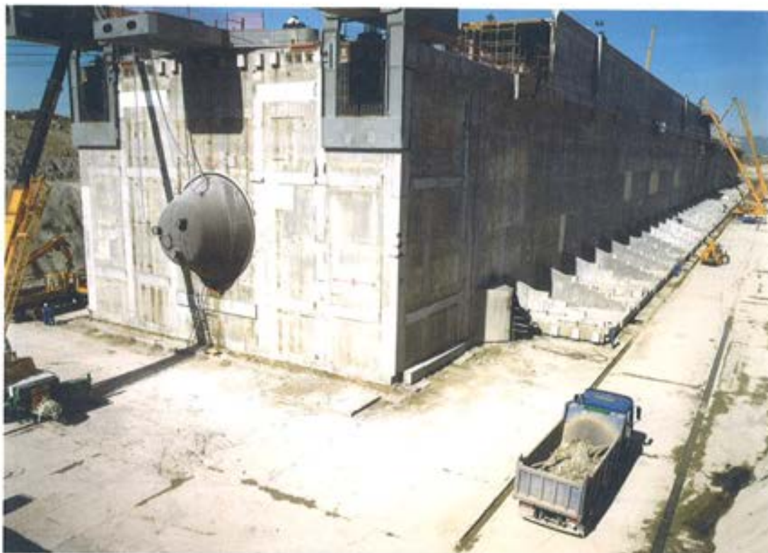
Figura 5.1.10. Protección de la rótula para el transporte.
