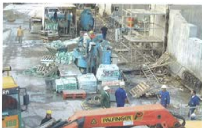
Figura 6.6.3.4. Equipos inyección cables longitudinales
