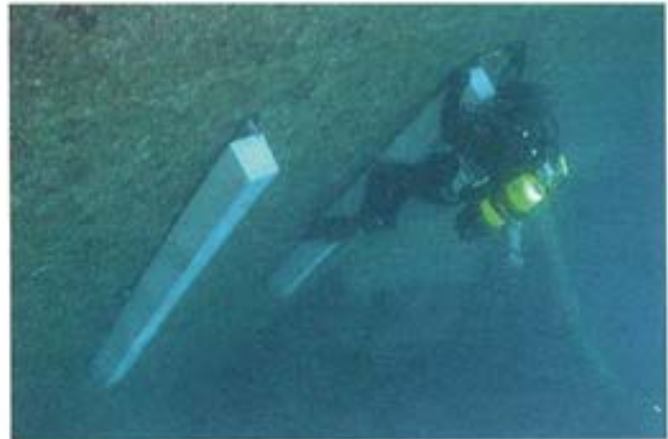
Figura 7.6.3. Instalación de los ánodos de sacrificio.
