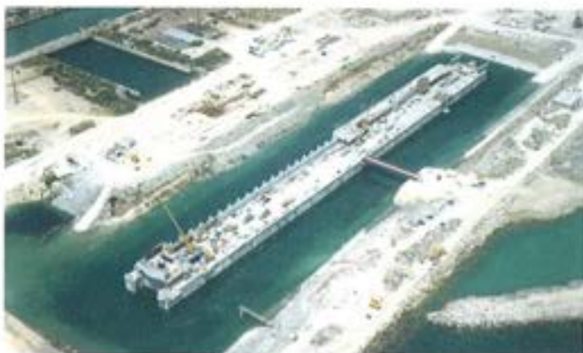
Figura 6.2.6. Puente de acceso.
