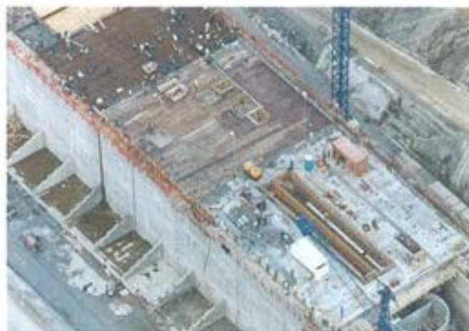
Figura 6.5.5. Curado con arpillerita y agua.
