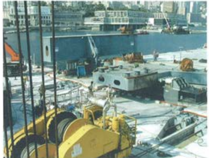
Figura 7.5.4. Vigas de posicionamiento (la viga central en primer término).
