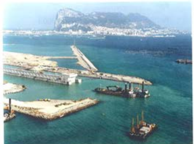
Figura 7.3.7. Dragas Razende Bol y equipo de perforación.
