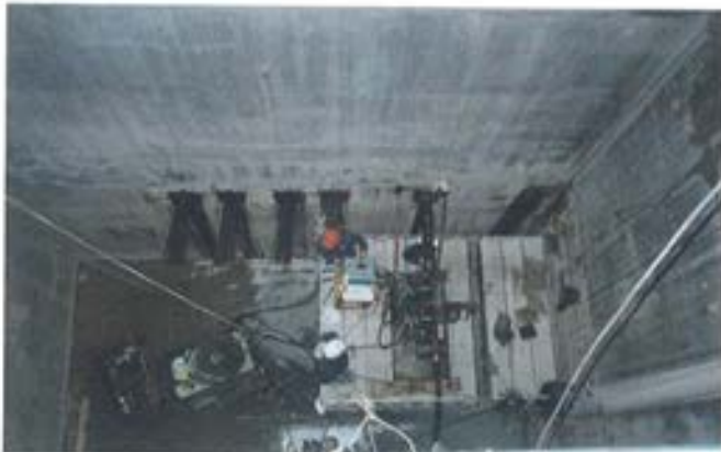
Figura 6.6.3.3 Enfilado tendones longitudinales 250 m
