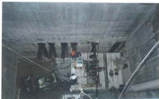
Figura 6.6.3.3 Enfilado tendones longitudinales 250 m
