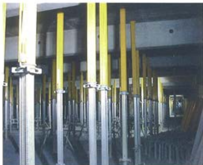
Figura 6.5.4. Apuntalamiento losa +3.
