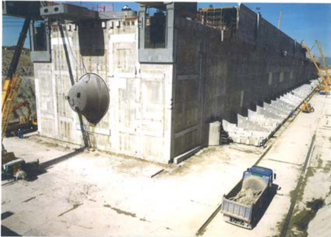
Figura 5.1.10. Protección de la rótula para el transporte.
