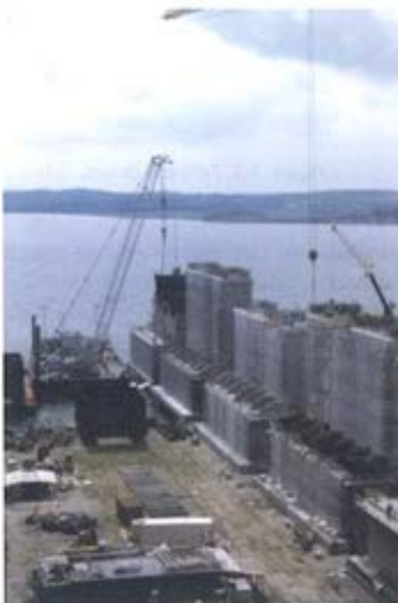
Figura. 9.5. Fabricación en seco de grandes Estructuras. Puente Storebaelt
