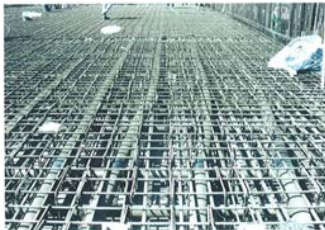
Figura 4.2. Vaina formada por tubos rígidos de acero.
