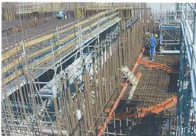
Figura 5.4.6. Pretensados en tres direcciones.
