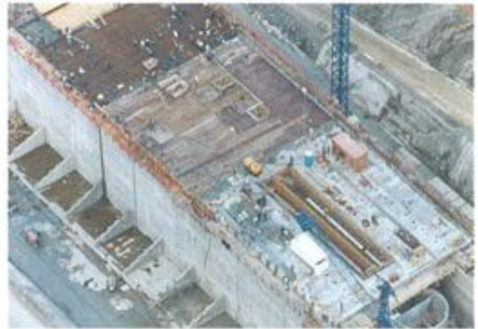
Figura 6.5.5. Curado con arpillerita y agua.
