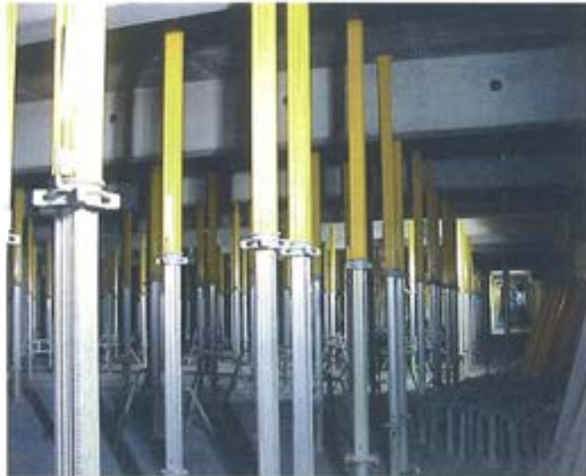
Figura 6.5.4. Apuntalamiento losa +3.
