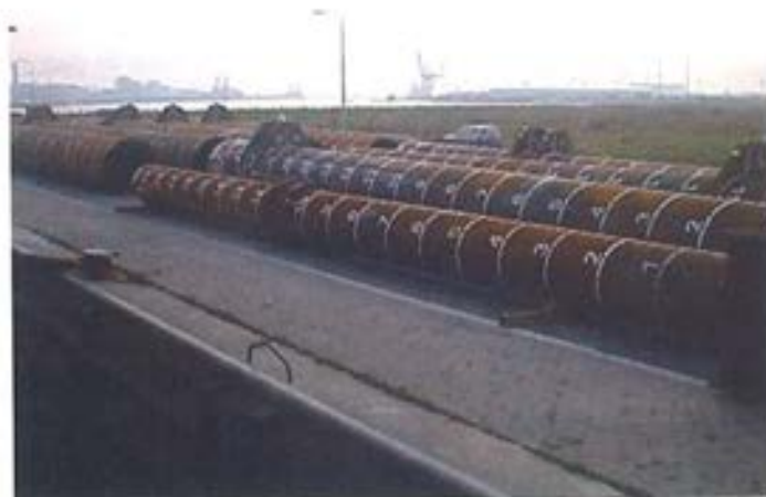
Figura 5.2.3. Vista del acopio de los pilotes metálicos para anclaje.
