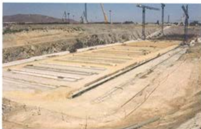
Figura 6.3.1. Cimentaciones provisionales.
