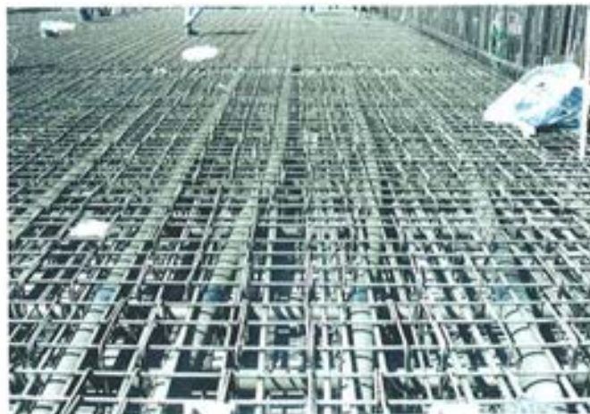
Figura 4.2. Vaina formada por tubos rígidos de acero.
