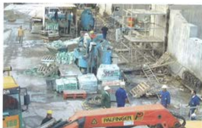
Figura 6.6.3.4. Equipos inyección cables longitudinales
