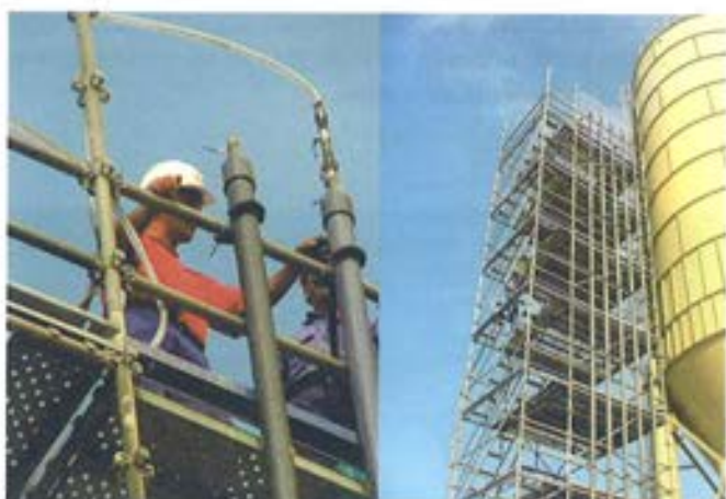
Figura 4.6. Ensayos tubo vertical.
