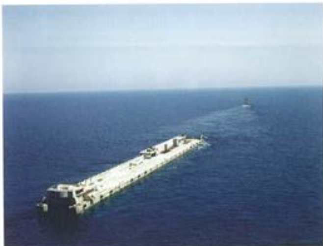
Figura 7.4.16. Transporte del dique.
