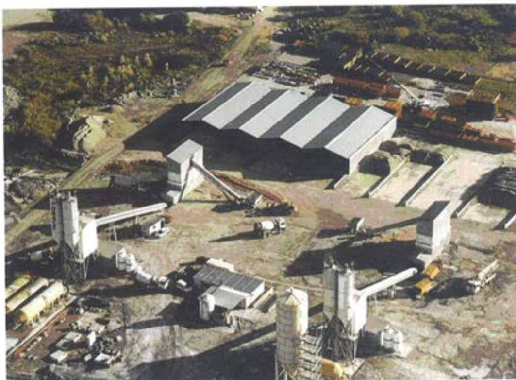
Figura 3.2.2 Vista aérea de las dos plantas de hormigón Skako y zona de acopio de áridos con el techado correspondiente a los áridos finos.
