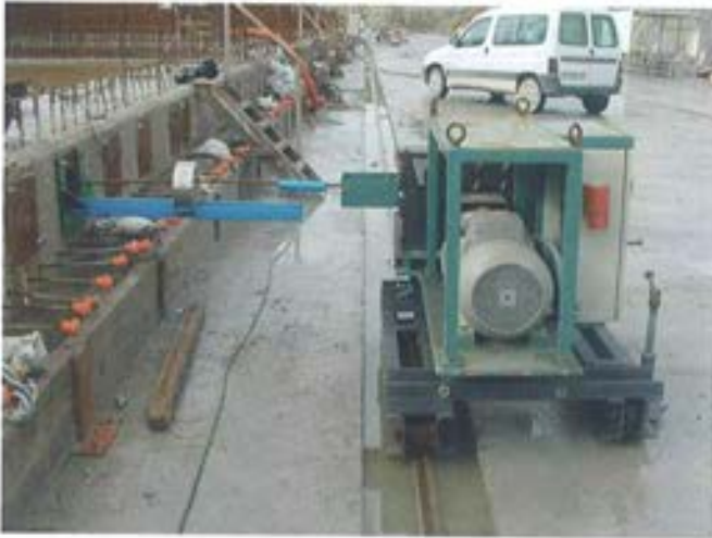
Figura 6.6.3.1. Enfiladora sobre carro de traslación.
