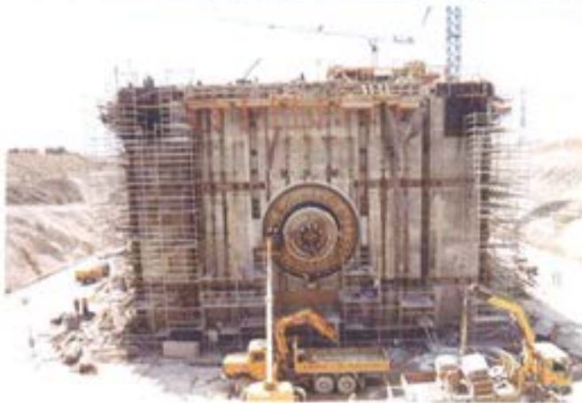
Figura 6.4.10. Sellado de anclajes de postesado.
