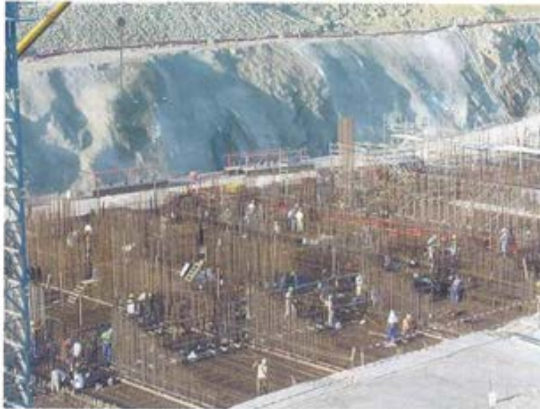
Figura 5.4.1. Aspecto general de los trabajos de armado.
