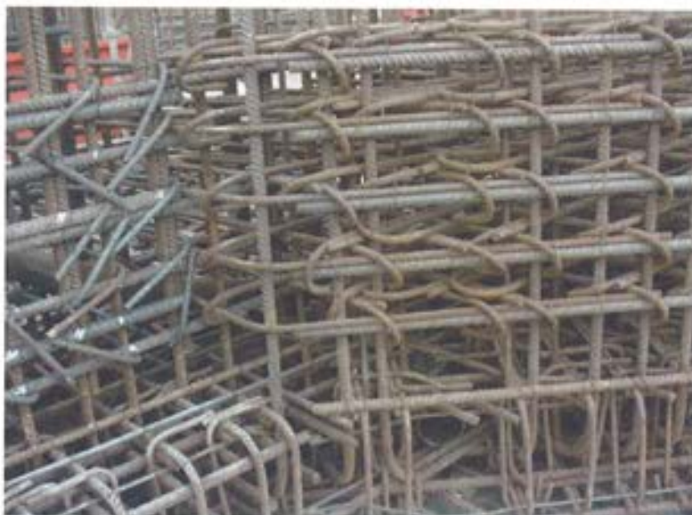
Figura 5.4.2. Horquillas y cercos de armado transversal.
