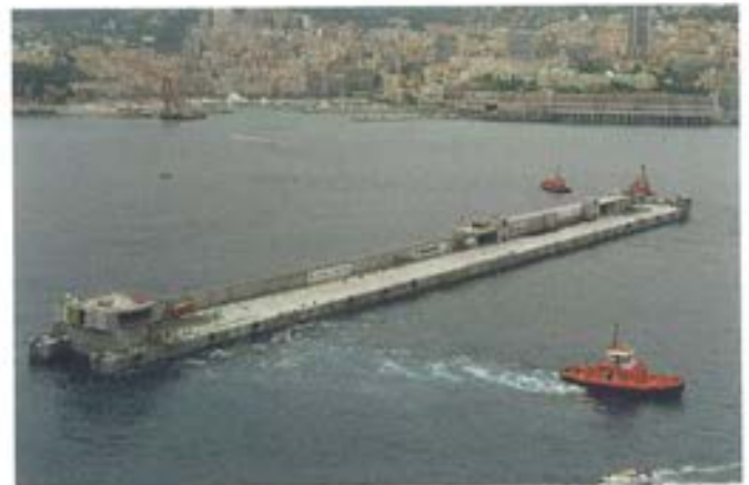
Figura 7.5.1. Maniobra de giro y posicionamiento del dique en Mónaco.
