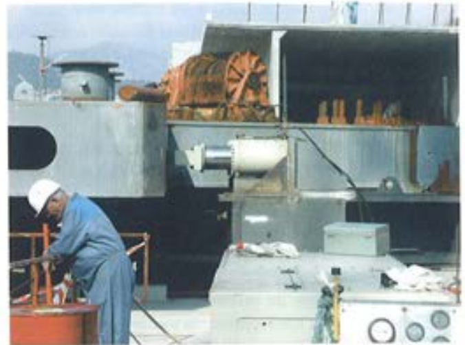
Figura 7.5.6. Tres gatos horizontales actuando sobre la viga central.
