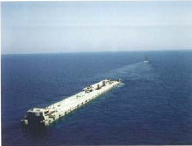
Figura 7.4.16. Transporte del dique.
