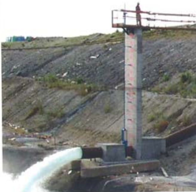
Figura 7.2.4. Sifón llenando la dársena.
