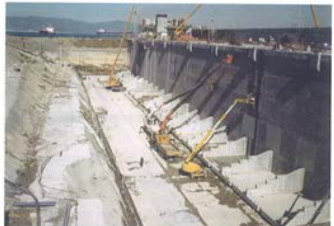
Figura 6.4.11. Inspección de paramentos.
