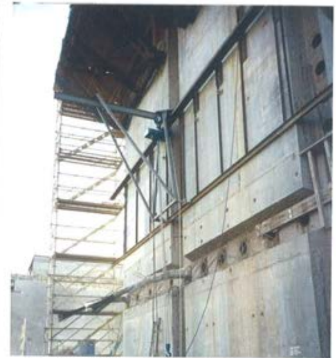
Figura 6.6.3.2. Utilaje para manipulación de gatos de tesado.
