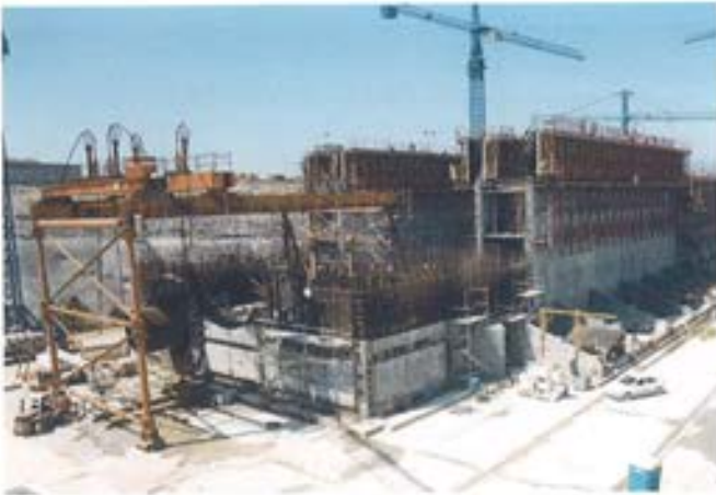
Figura 6.2.3. Rótula. Izado de elementos embebidos.
