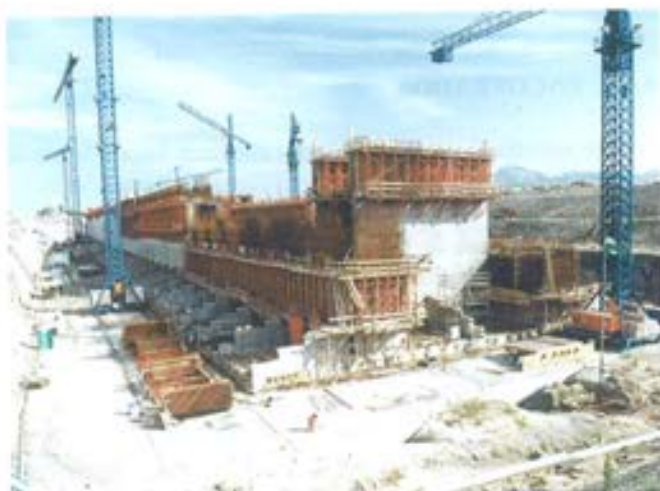
Figura 6.5.2. Encofrado trepante para los muros.
