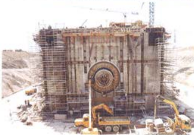
Figura 6.4.10. Sellado de anclajes de postesado.
