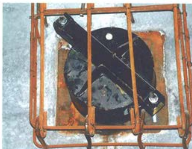
Figura 4.12. Anclaje preparado para el sellado.
