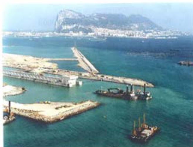
Figura 7.3.7. Draga Razende Bol y equipo de perforación.
