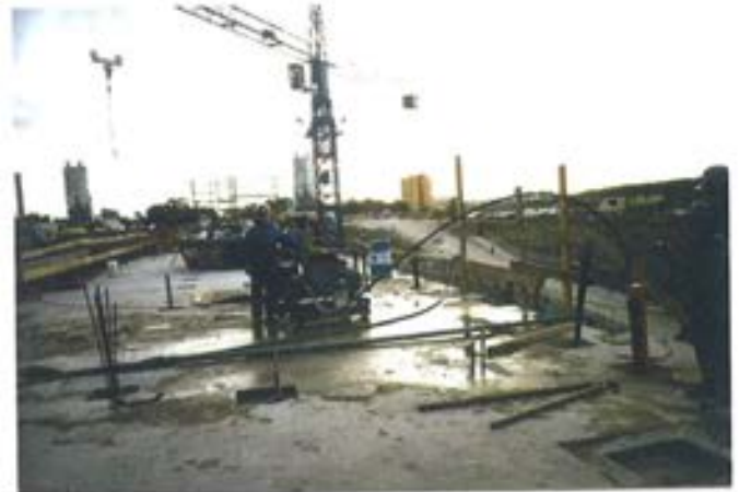
Figura 4.8. Enfilado cordón a cordón en bucles verticales.
