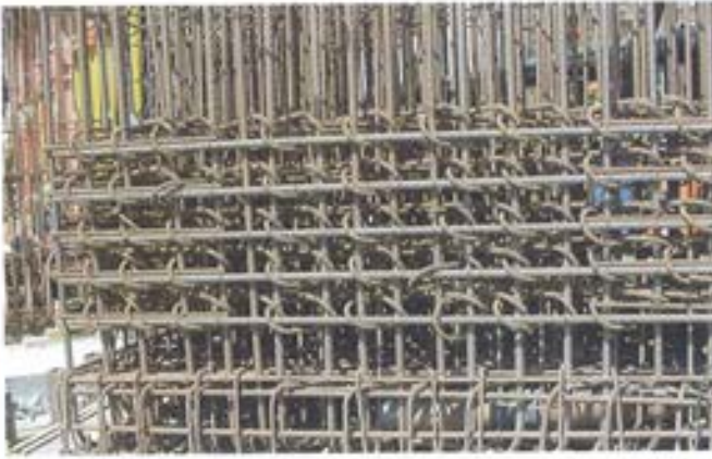
Figura 5.4.8. Armadura en volumen.
