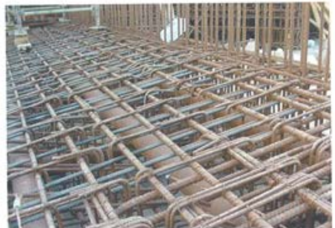
Figura 5.4.5. Vigas prefabricadas con sus tubos de pretensado.
