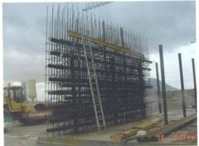
Figura 5.4.4. Prefabricación de cajas de armadura y tubos.
