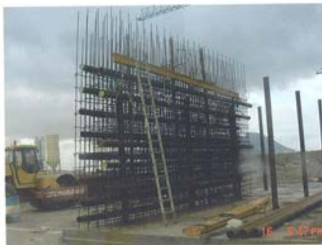
Figura 5.4.4. Prefabricación de cajas de armadura y tubos.
