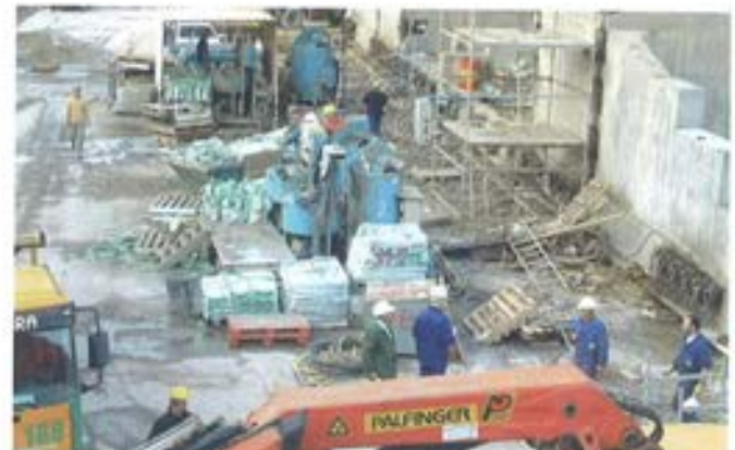
Figura 6.6.3.4. Equipos inyección cables longitudinales
