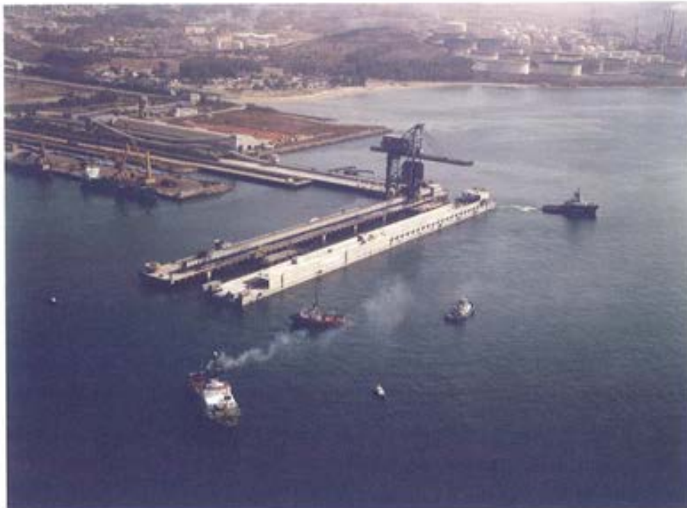
Figura 7.4.8. Atraque del dique en la Bahía de Algeciras.
