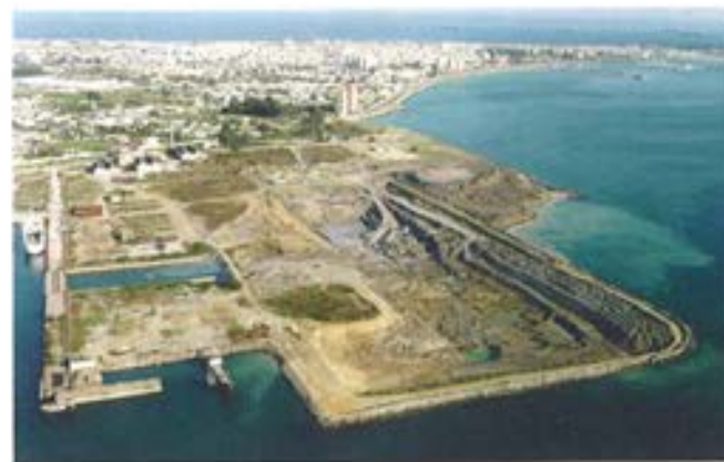
Figura 6.1.3. Excavación de la dársena.
