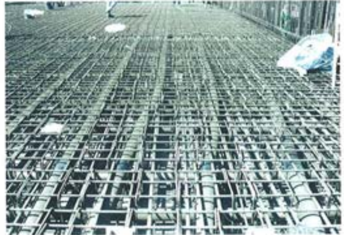
Figura 4.2. Vaina formada por tubos rígidos de acero.
