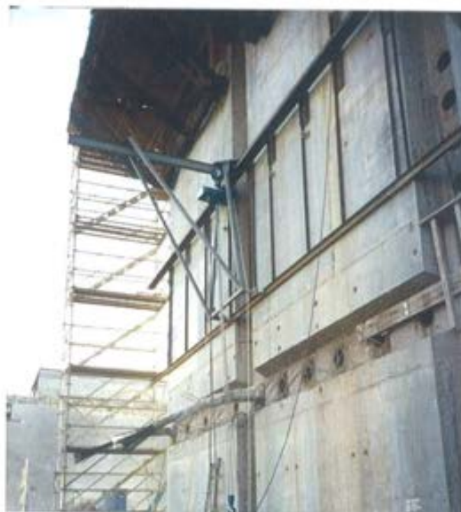
Figura 6.6.3.2. Utilaje para manipulación de gatos de tesado.
