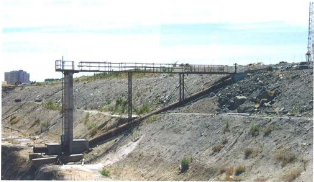
Figura 7.2.2 Sifón de llenado de la dársena.
