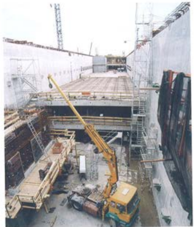
Figura 6.5.3. Encofrado de losas.
