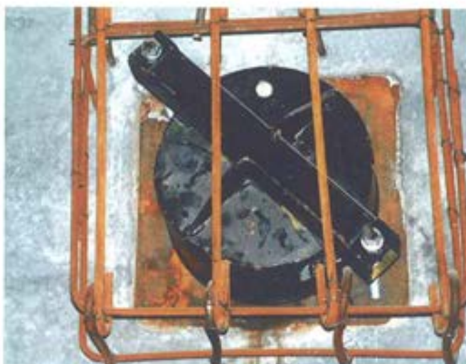
Figura 4.12. Anclaje preparado para el sellado.
