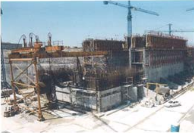
Figura 6.2.3. Rótula. Izado de elementos embebidos.
