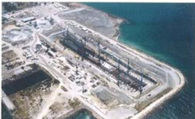
Figura 6.2.7. Vista general de las instalaciones.
