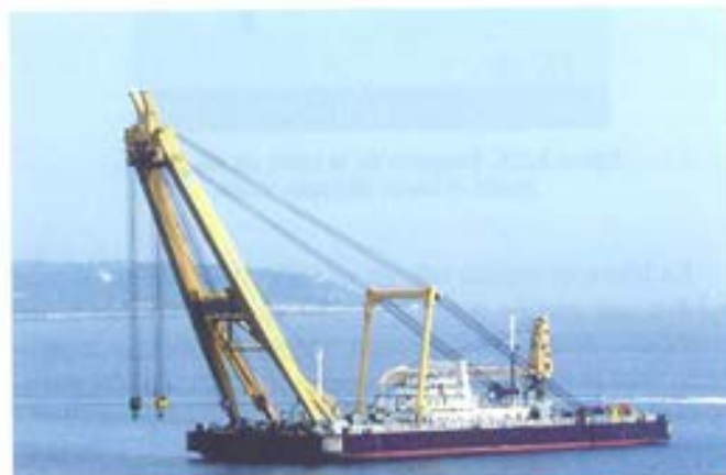
Figura 5.2.15. Vista de la pontona Taklift.
