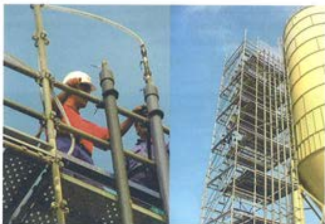
Figura 4.6. Ensayos tubo vertical.
