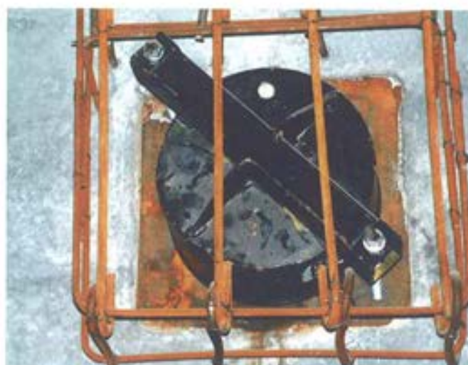
Figura 4.12. Anclaje preparado para el sellado.
