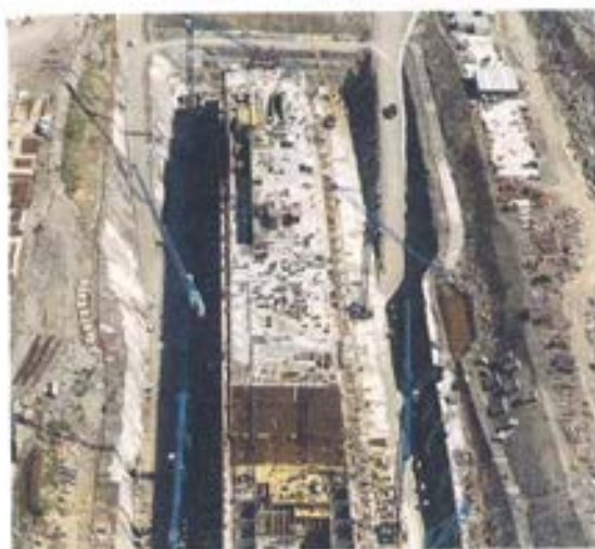
Figura 6.4.4. Evolución de los trabajos.
