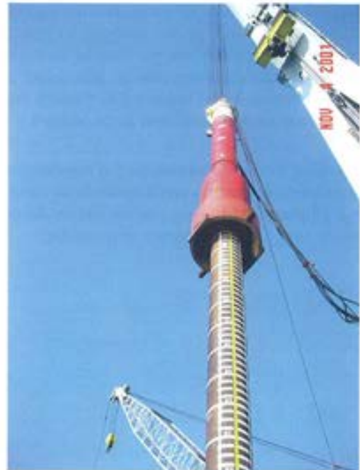
Figura 5.2.9. Detalle del martillo suspendido de la grúa durante la hincada de un pilote.
