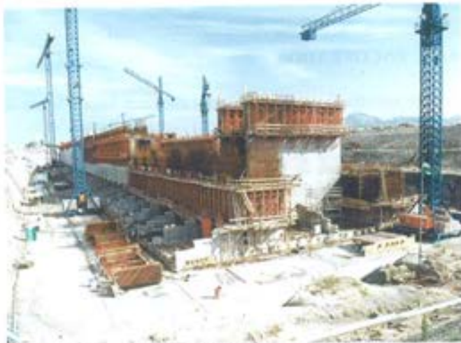
Figura 6.5.2. Encofrado trepante para los muros.
