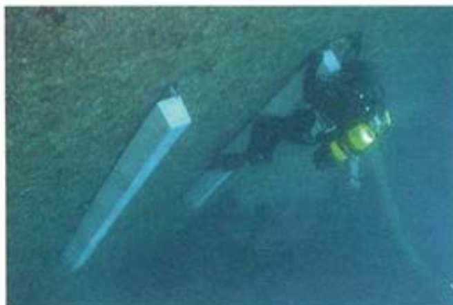
Figura 7.6.3. Instalación de los ánodos de sacrificio.
