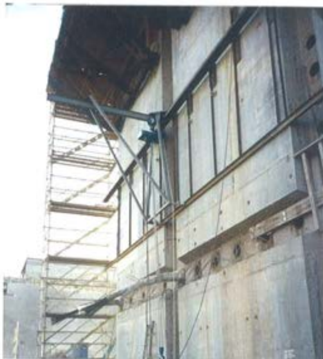
Figura 6.6.3.2. Utilaje para manipulación de gatos de tesado.
