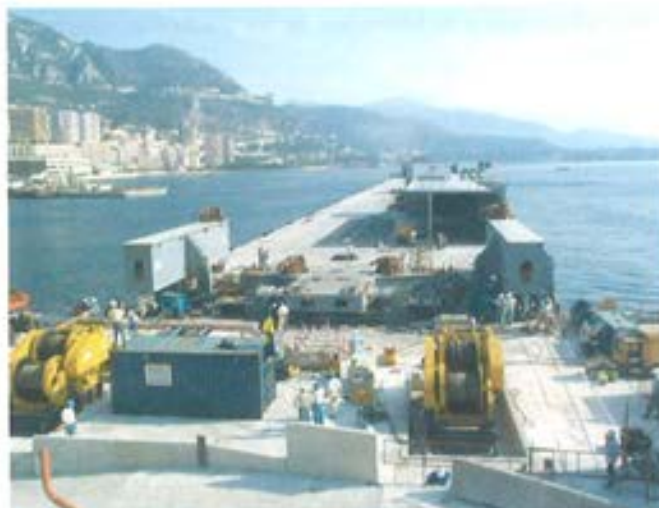
Figura 7.5.13. El dique en la fase final de aproximación para la conexión.
