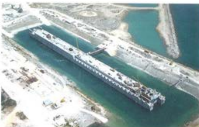
Figura 7.4.1 Dique en proceso de flotación.
