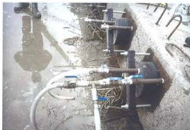
Figura 4.11. Anclaje preparado para la inyección al vacío.
