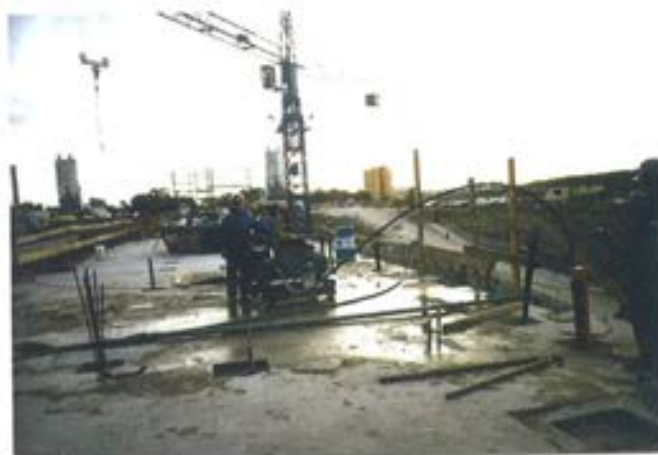
Figura 4.8. Enfilado cordón a cordón en bucles verticales.
