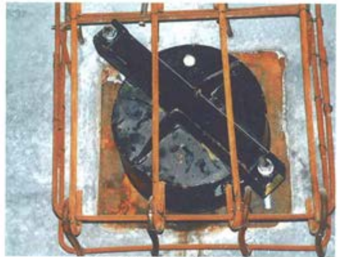
Figura 4.12. Anclaje preparado para el sellado.
