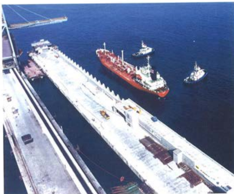
Figura 5.3.2. Lastrado con barco tanque en Algeciras.
