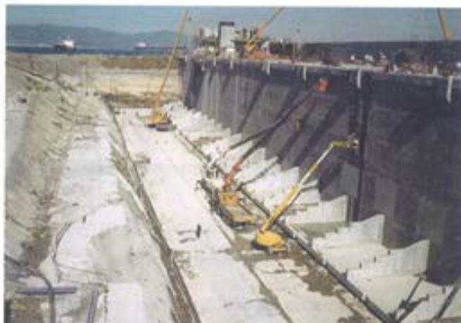
Figura 6.4.11. Inspección de paramentos.
