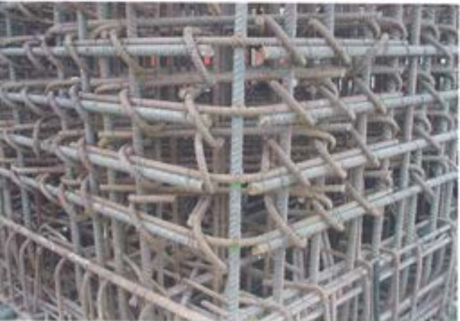
Figura 6.5.1. Disposición de las armaduras.
