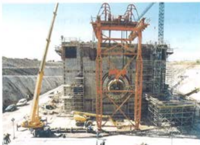
Figura 6.2.5. Rótula. Izado del resto de elementos.
