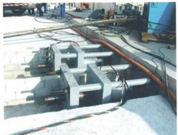
Figura 7.5.8. Dos mesas de un lado del sistema de retención.
