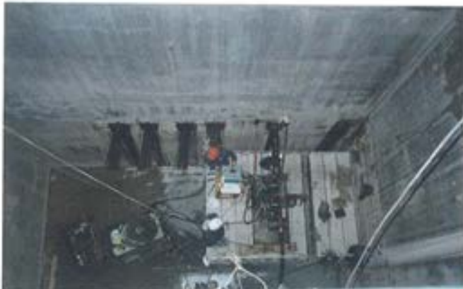
Figura 6.6.3.3 Enfilado tendones longitudinales 250 m
