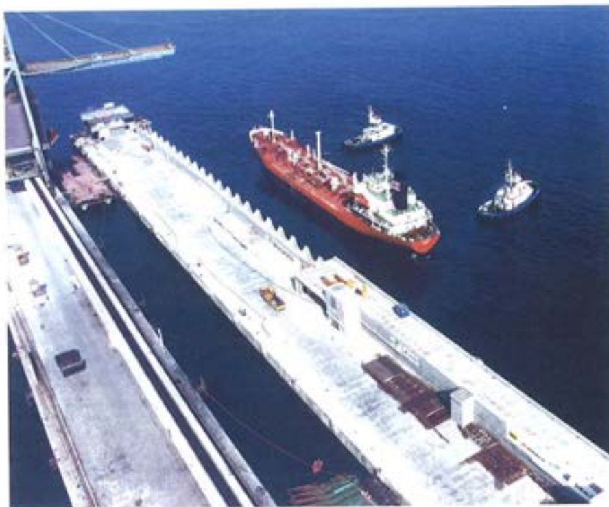
Figura 5.3.2. Lastrado con barco tanque en Algeciras.
