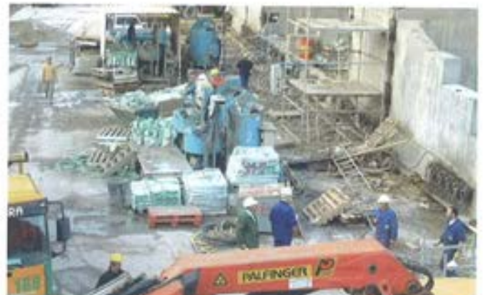
Figura 6.6.3.4. Equipos inyección cables longitudinales
