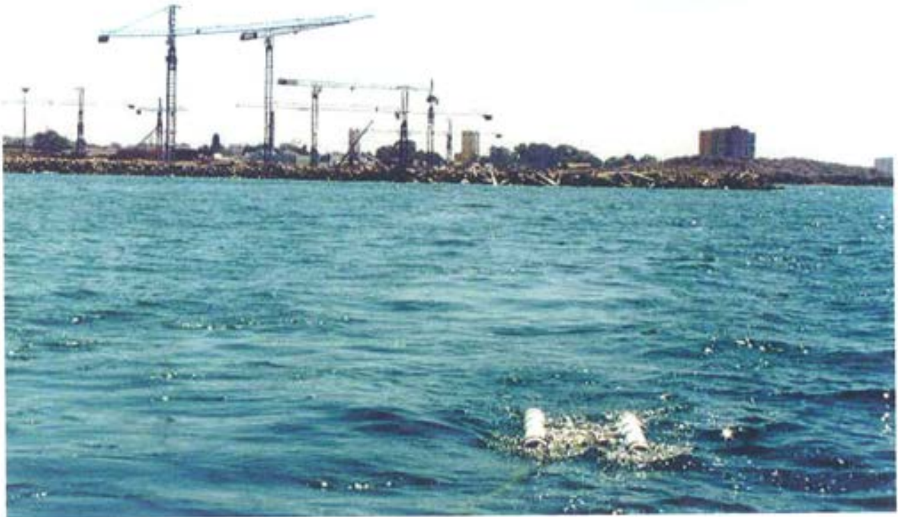
Figura 7.3.5. Zona de trabajo y catamarán del sistema GEOPULSE.
