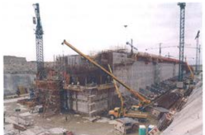
Figura 6.5.8. Ferralla y encofrado zona rótula.
