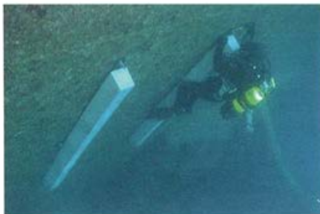
Figura 7.6.3. Instalación de los ánodos de sacrificio.
