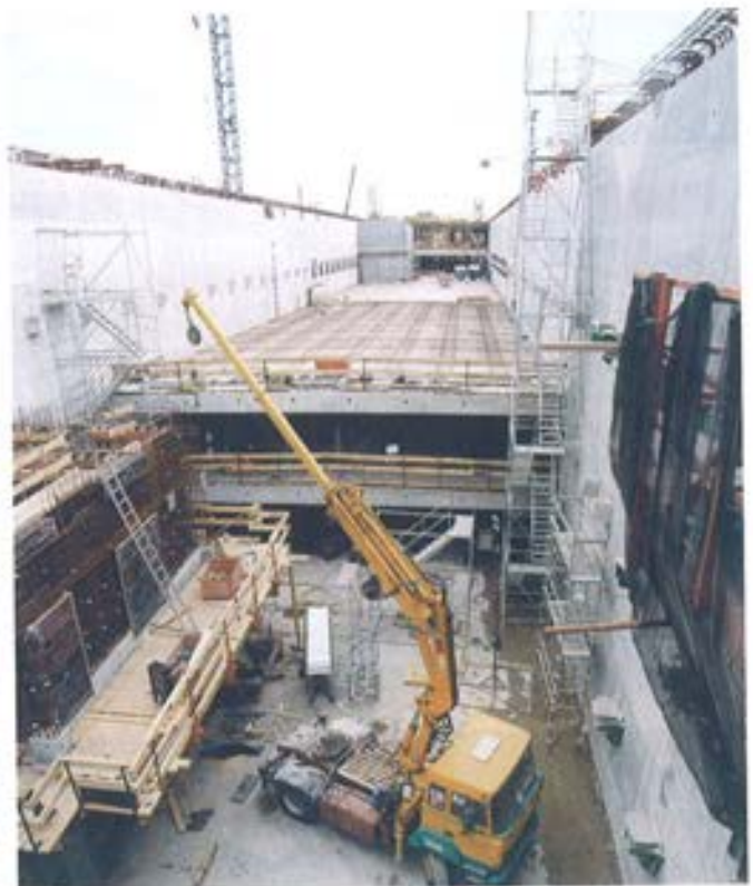
Figura 6.5.3. Encofrado de losas.
