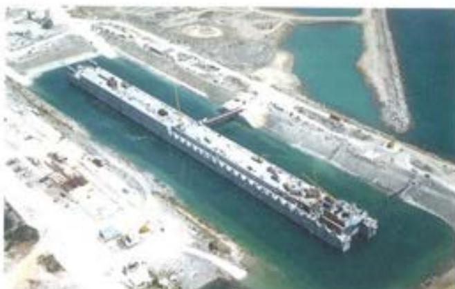
Figura 7.4.1 Dique en proceso de flotación.
