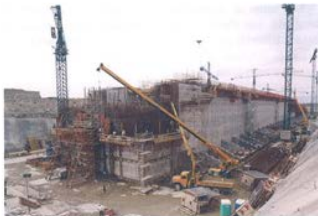
Figura 6.5.8. Ferralla y encofrado zona rótula.
