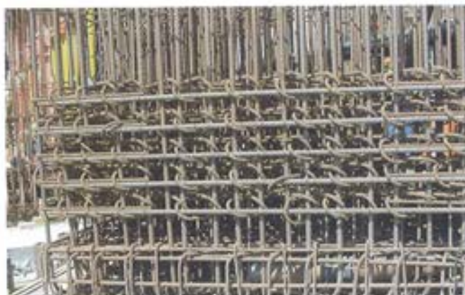
Figura 5.4.8. Armadura en volumen.
