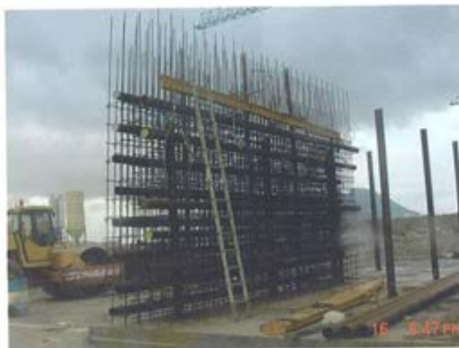
Figura 5.4.4. Prefabricación de cajas de armadura y tubos.
