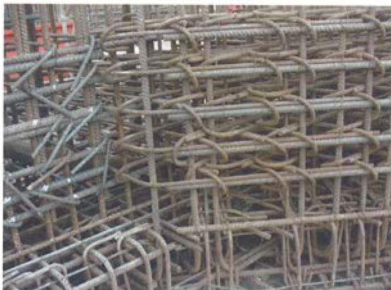
Figura 5.4.2. Horquillas y cercos de armado transversal.
