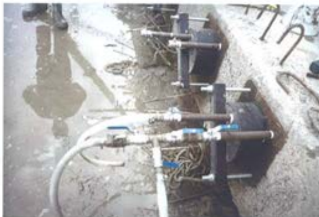
Figura 4.11. Anclaje preparado para la inyección al vacío.
