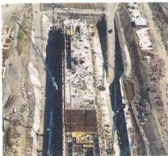
Figura 6.4.4. Evolución de los trabajos.
