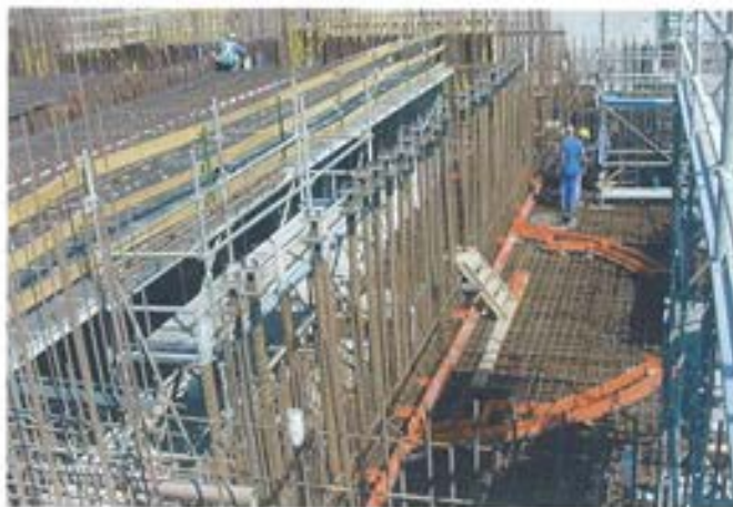
Figura 5.4.6. Pretensados en tres direcciones.
