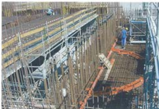
Figura 5.4.6. Pretensados en tres direcciones.
