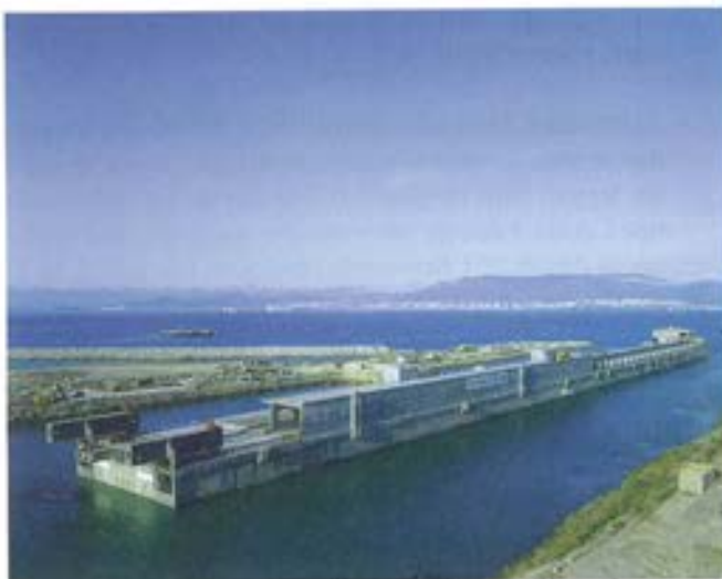
Figura 7.4.3. Operación de salida de la dársena.
