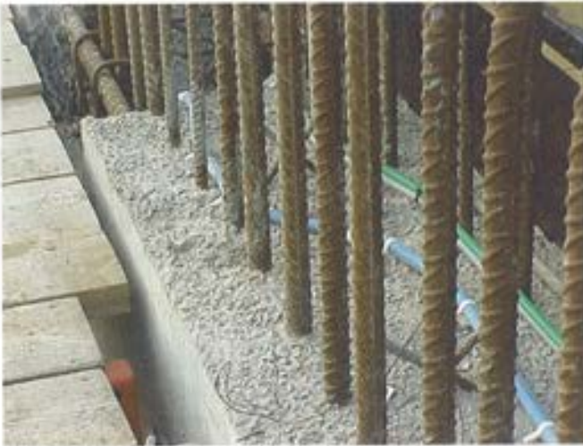
Figura 6.5.7. Junta de hormigonado.
