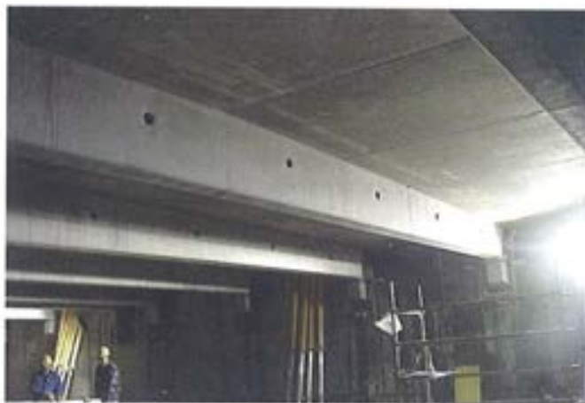
Figura 6.4.9. Vigas y prelosas prefabricadas.
