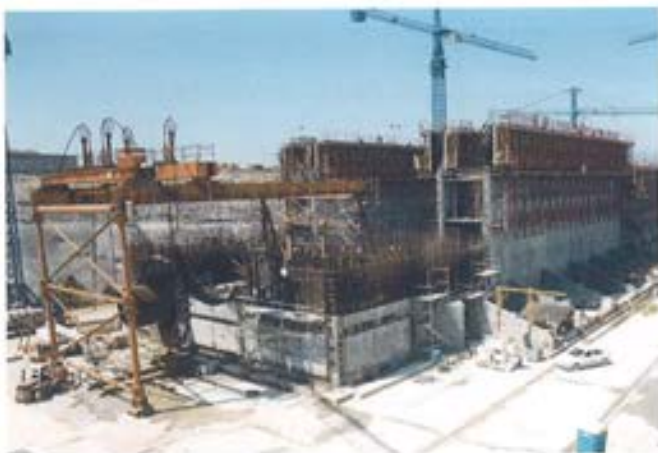
Figura 6.2.3. Rótula. Izado de elementos embebidos.
