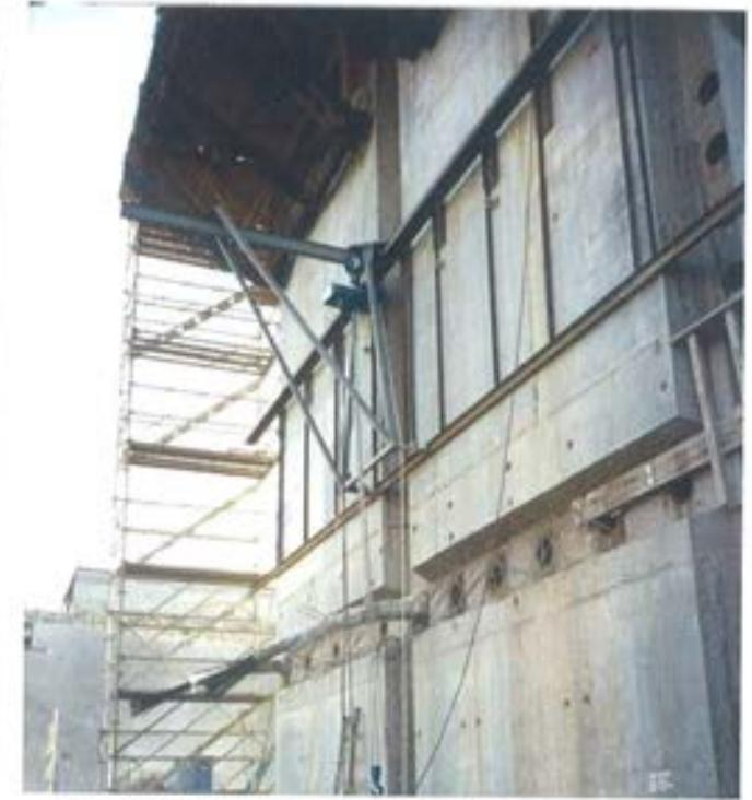
Figura 6.6.3.2. Utilaje para manipulación de gatos de tesado.
