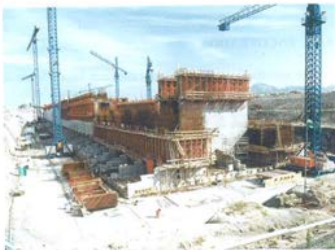
Figura 6.5.2. Encofrado trepante para los muros.
