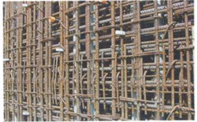
Figura 5.4.8. Armadura en volumen.
