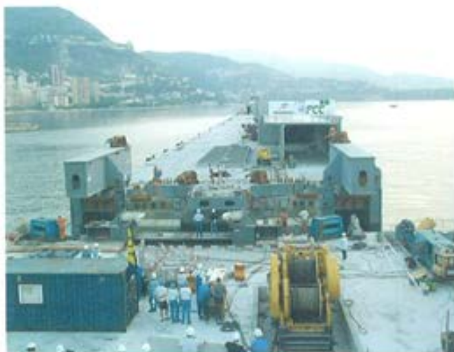
Figura 7.5.12. El dique en la fase de alineación a unos 10 m de distancia.
