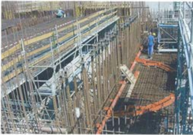
Figura 5.4.6. Pretensados en tres direcciones.
