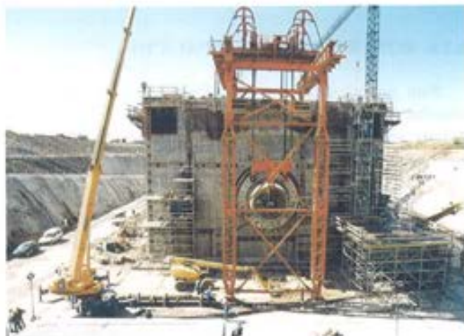
Figura 6.2.5. Rótula. Izado del resto de elementos.
