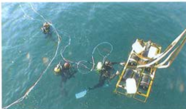
Figura 7.6.2. Flotador para la colocación de los ánodos de sacrificio.
