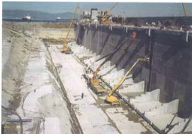
Figura 6.4.11. Inspección de paramentos.
