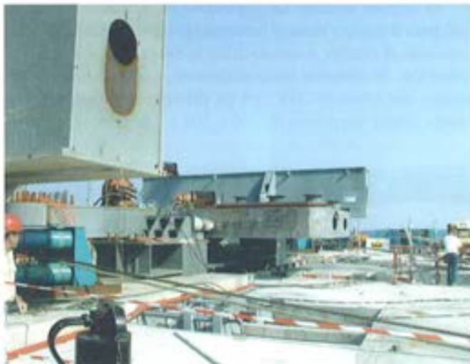
Figura 7.5.3. Vigas de posicionamiento (la viga lateral en primer término).
