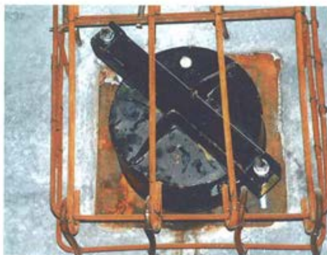
Figura 4.12. Anclaje preparado para el sellado.
