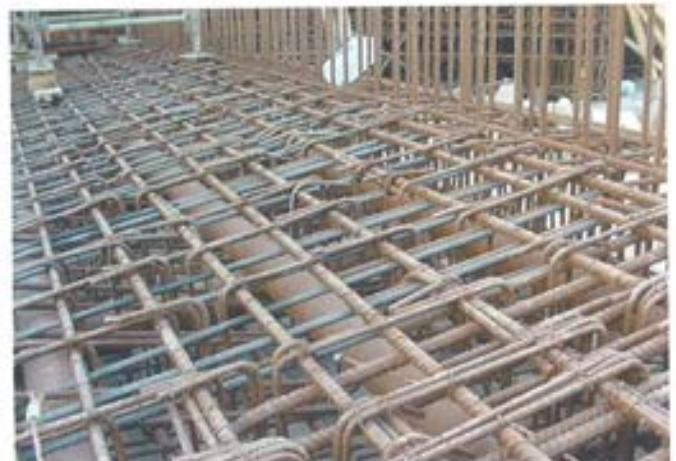
Figura 5.4.5. Vigas prefabricadas con sus tubos de pretensado.
