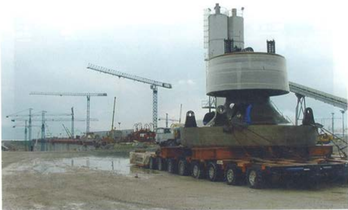
Figura 5.1.9. Transporte de la rótula.
