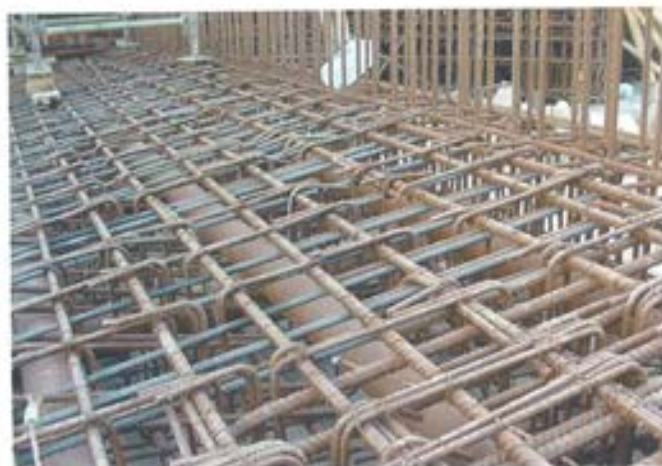
Figura 5.4.5. Vigas prefabricadas con sus tubos de pretensado.
