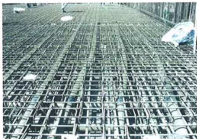
Figura 4.2. Vaina formada por tubos rígidos de acero.
