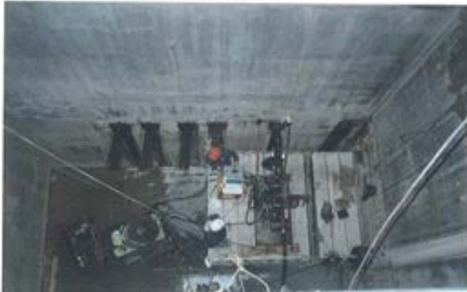
Figura 6.6.3.3 Enfilado tendones longitudinales 250 m
