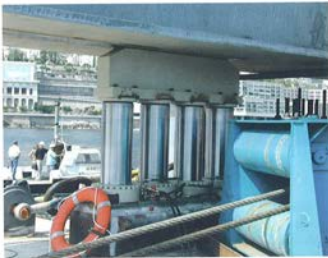
Figura 7.5.5. Cuatro gatos verticales actuando sobre una viga lateral.
