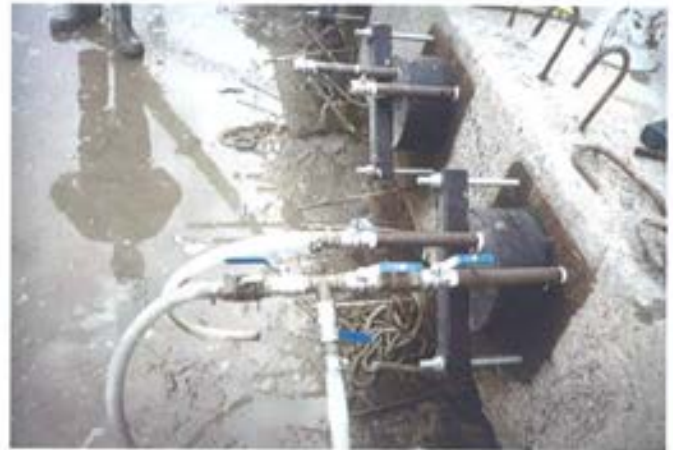
Figura 4.11. Anclaje preparado para la inyección al vacío.
