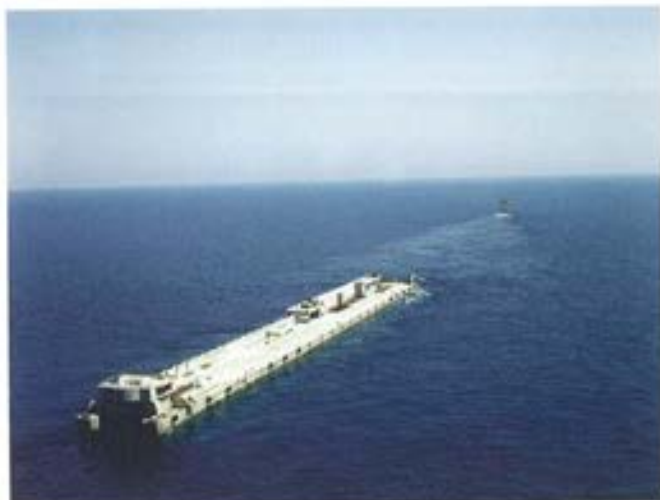
Figura 7.4.16. Transporte del dique.
