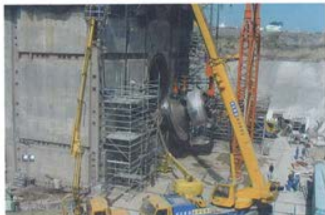
Figura 6.4.8. Montaje de la rótula.
