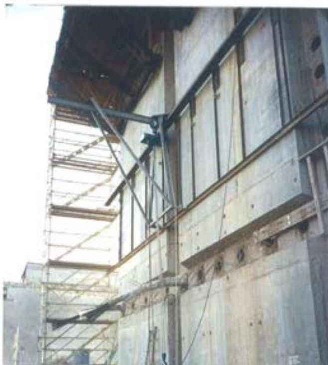
Figura 6.6.3.2. Utilaje para manipulación de gatos de tesado.
