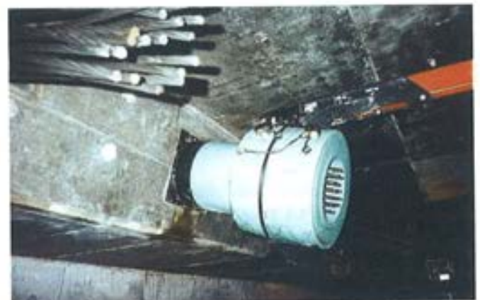
Figura 4.9. Tesado en el interior de las celdas estancas.
