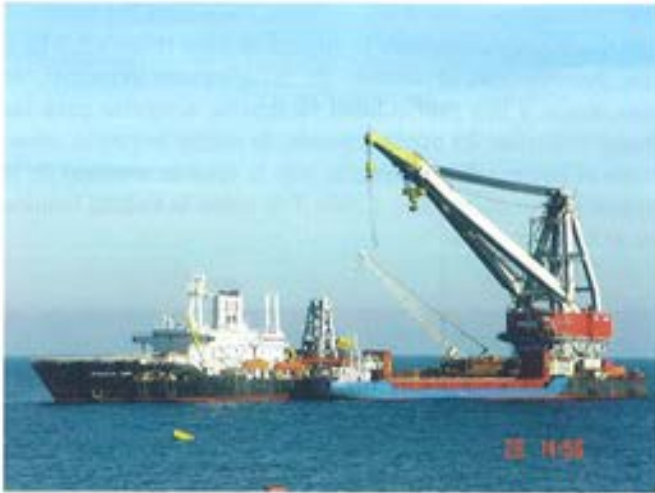
Figura 5.2.7. Vista del barco Stanislav Yudin desde donde se hincaron los pilotes.
