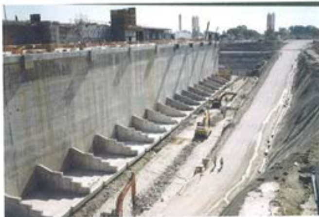
Figura 6.4.13. Retirada de instalaciones.
