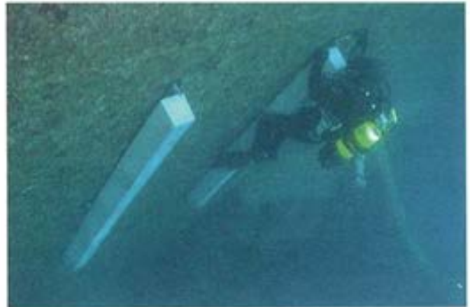
Figura 7.6.3. Instalación de los ánodos de sacrificio.
