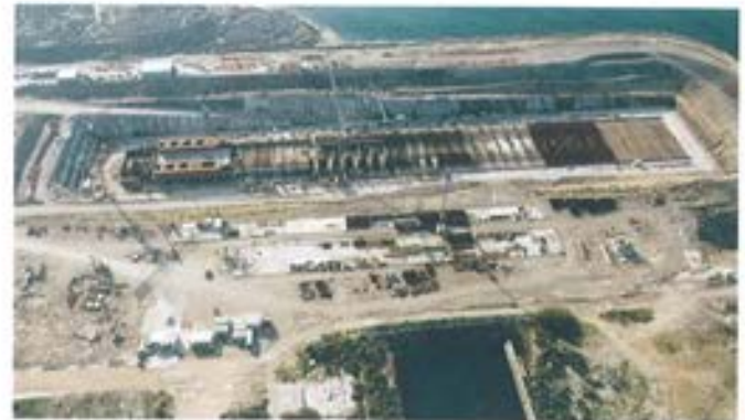
Figura 6.2.2. Parques de ferralla.
