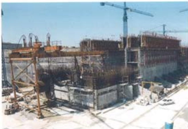
Figura 6.2.3. Rótula. Izado de elementos embebidos.
