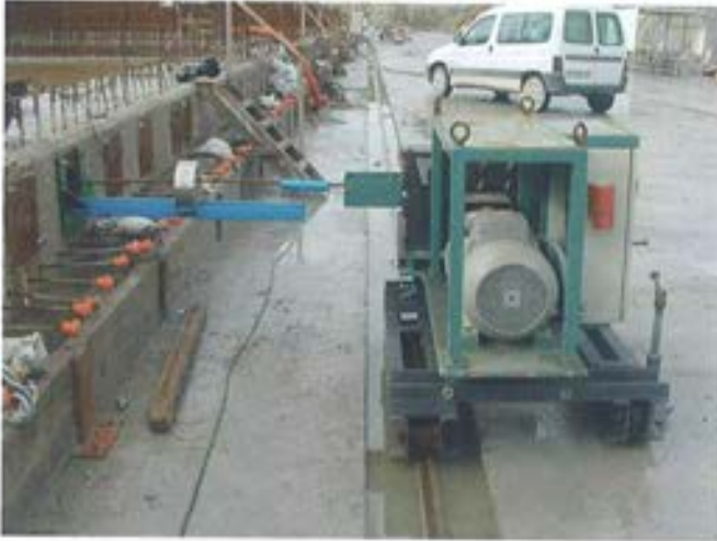
Figura 6.6.3.1. Enfiladora sobre carro de traslación.
