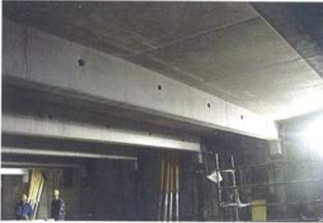
Figura 6.4.9. Vigas y prelosas prefabricadas.
