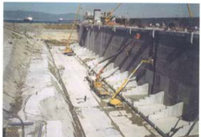
Figura 6.4.11. Inspección de paramentos.
