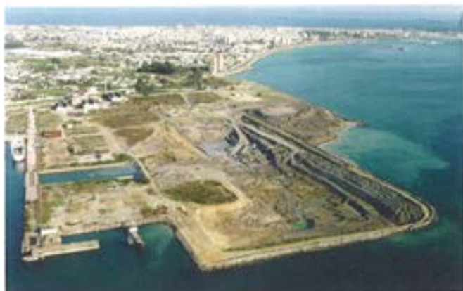
Figura 6.1.3. Excavación de la dársena.
