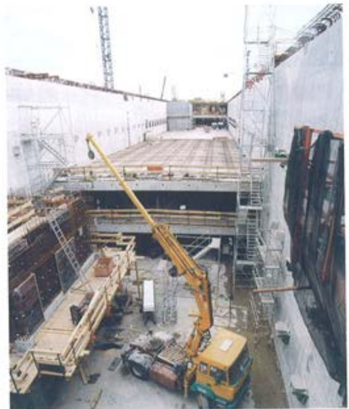
Figura 6.5.3. Encofrado de losas.
