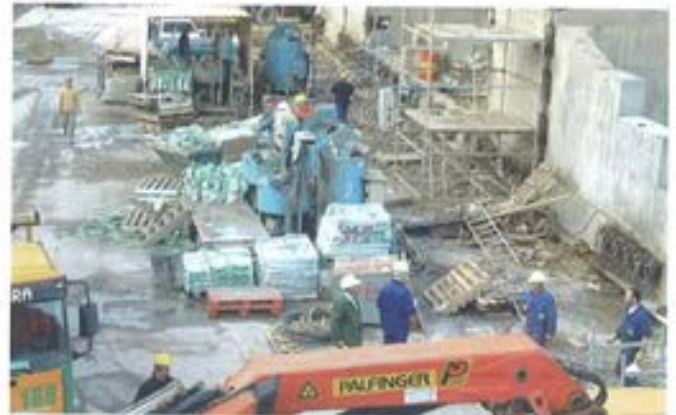
Figura 6.6.3.4. Equipos inyección cables longitudinales
