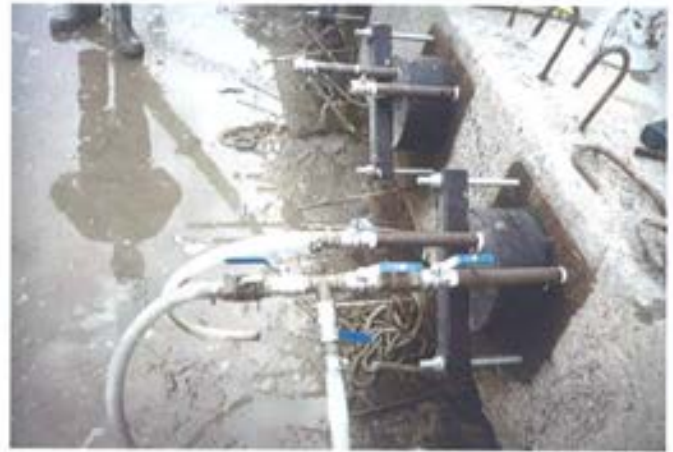
Figura 4.11. Anclaje preparado para la inyección al vacío.
