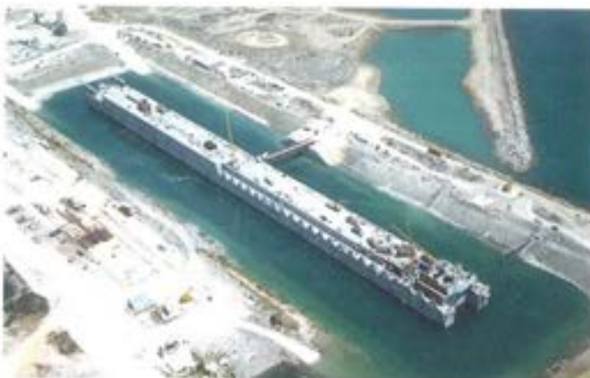
Figura 7.4.1 Dique en proceso de flotación.
