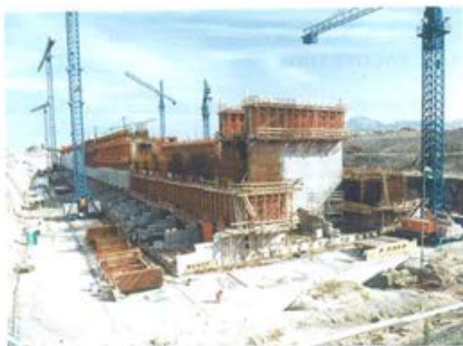
Figura 6.5.2. Encofrado trepante para los muros.
