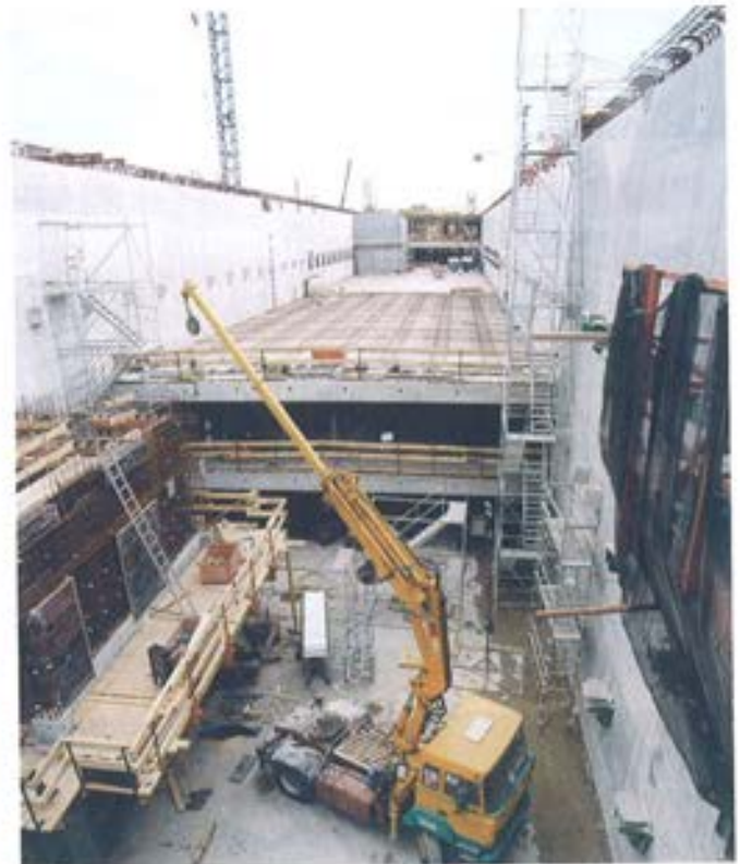
Figura 6.5.3. Encofrado de losas.
