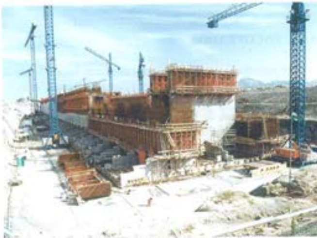
Figura 6.5.2. Encofrado trepante para los muros.
