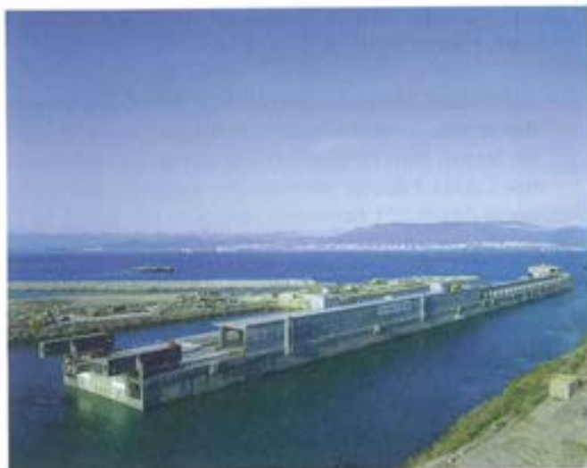
Figura 7.4.3. Operación de salida de la dársena.
