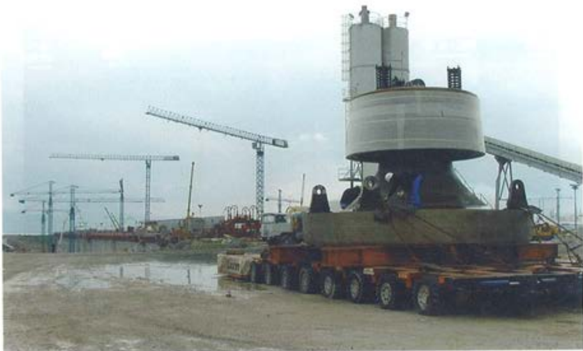
Figura 5.1.9. Transporte de la rótula.
