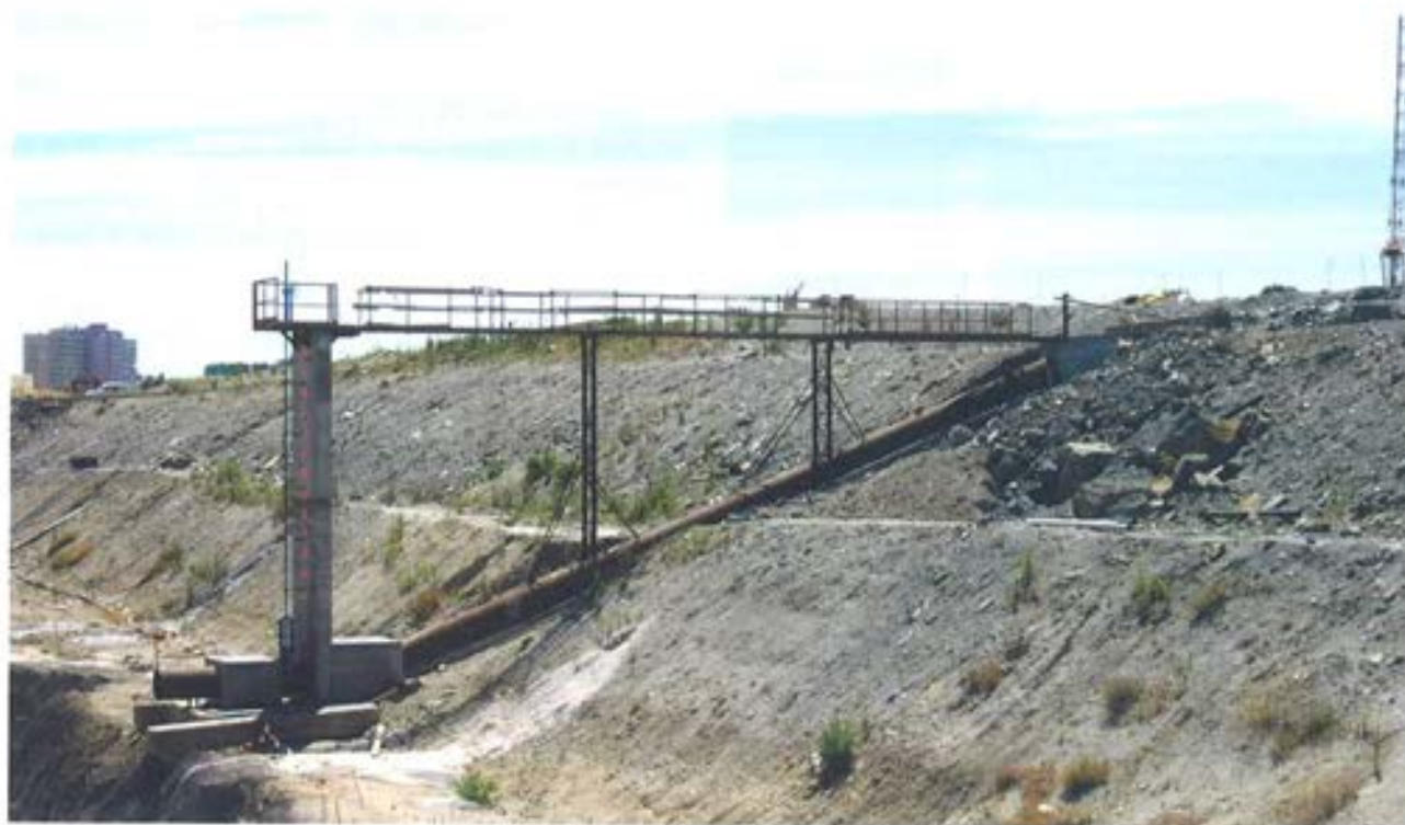
Figura 7.2.2 Sifón de llenado de la dársena.
