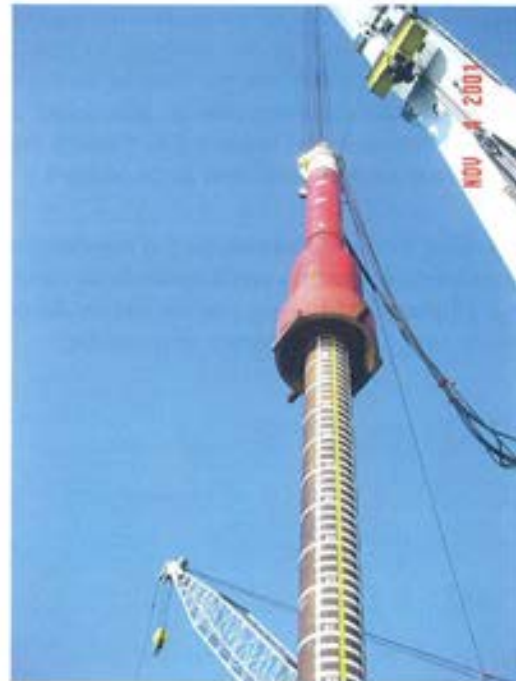
Figura 5.2.9. Detalle del martillo suspendido de la grúa durante la hincada de un pilote.
