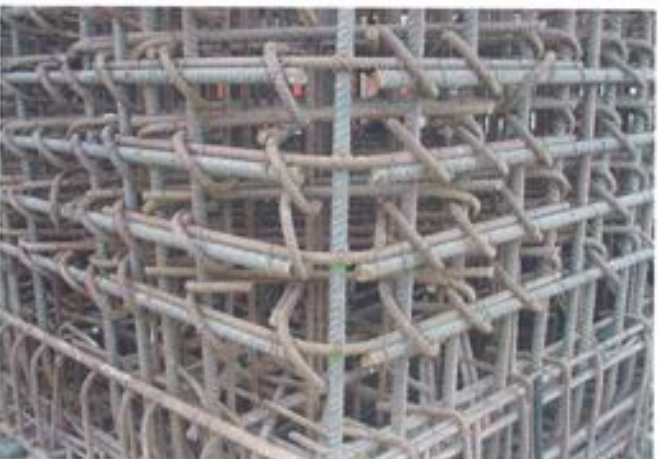
Figura 6.5.1. Disposición de las armaduras.
