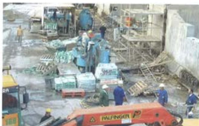
Figura 6.6.3.4. Equipos inyección cables longitudinales
