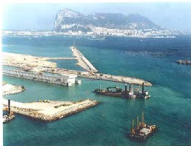
Figura 7.3.7. Draga Razende Bol y equipo de perforación.
