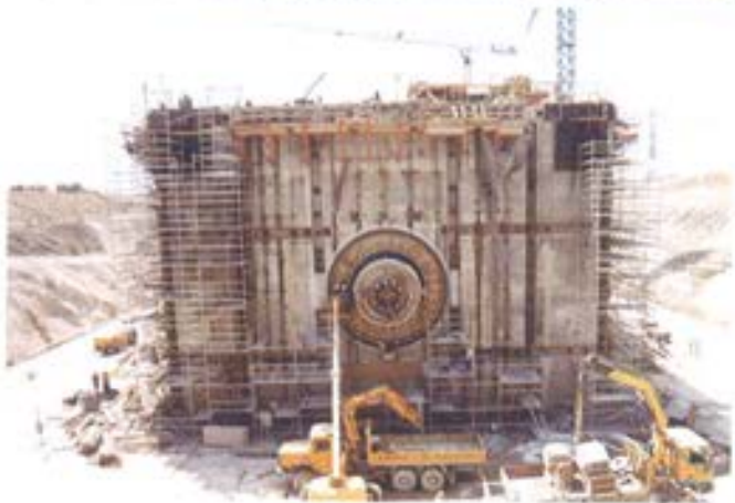
Figura 6.4.10. Sellado de anclajes de postesado.
