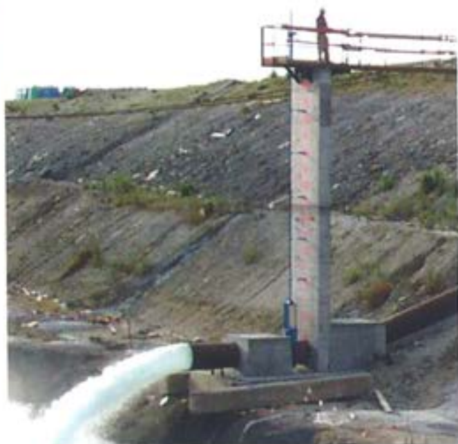
Figura 7.2.4. Sifón llenando la dársena.
