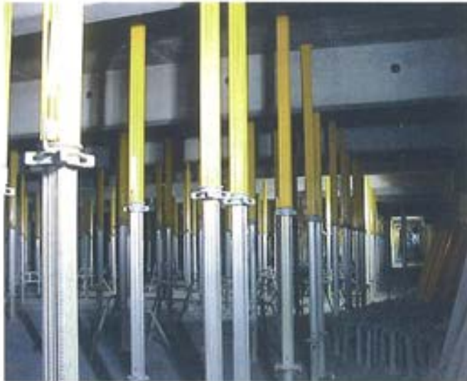
Figura 6.5.4. Apuntalamiento losa +3.
