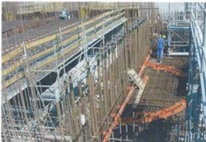
Figura 5.4.6. Pretensados en tres direcciones.
