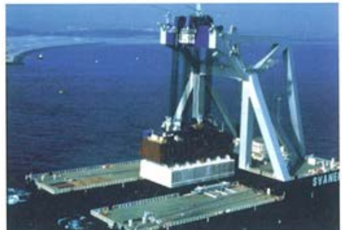
Figura .9.6. Grandes cajones para cimentación de puentes.
