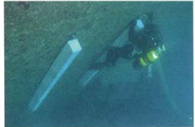
Figura 7.6.3. Instalación de los ánodos de sacrificio.
