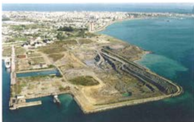
Figura 6.1.3. Excavación de la dársena.
