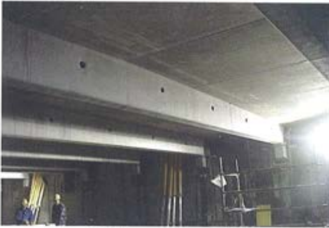
Figura 6.4.9. Vigas y prelosas prefabricadas.
