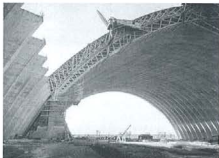
Foto de portada: Hangares de Orly en Construcción, 1923. Eugène Freyssinet
