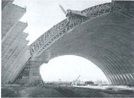
Foto de portada: Hangares de Orly en Construcción, 1923. Eugène Freyssinet
