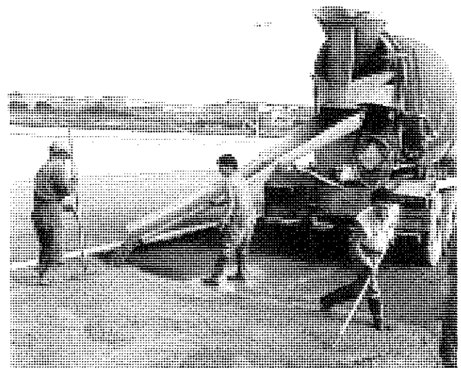
Figura 3. Puesta en obra de un hormigón con fibras de acero.
