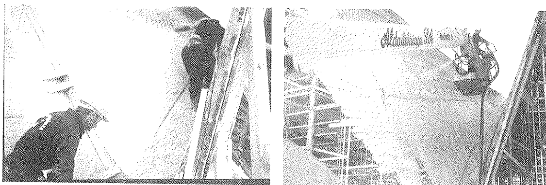
Figura 12. Hormigonado por calles de los lóbulos.
