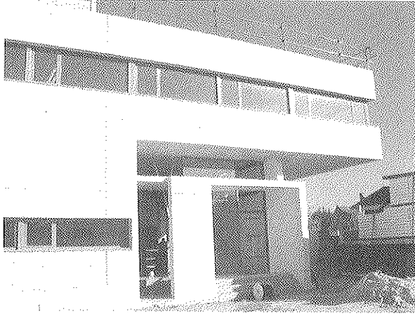
Foto 20. Estructuras cara vista terminadas.
