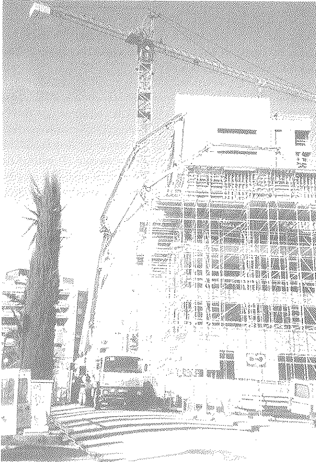
Foto 2. Vista general de la obra.
