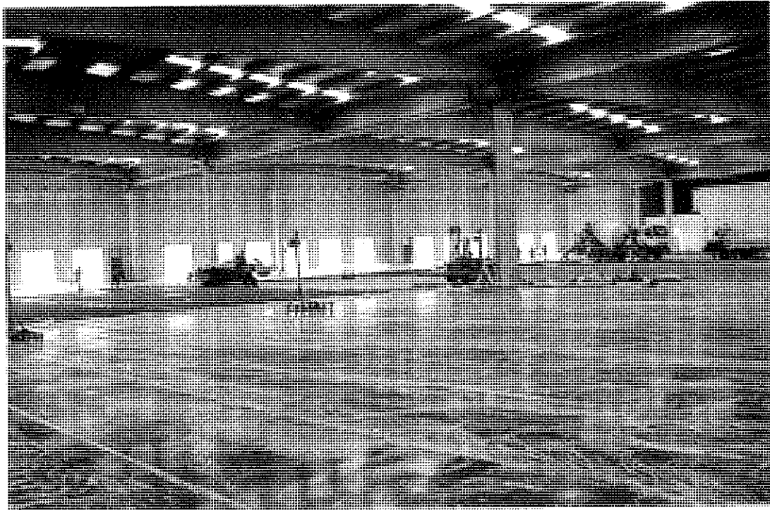
Foto 2. Pavimento sin juntas.
