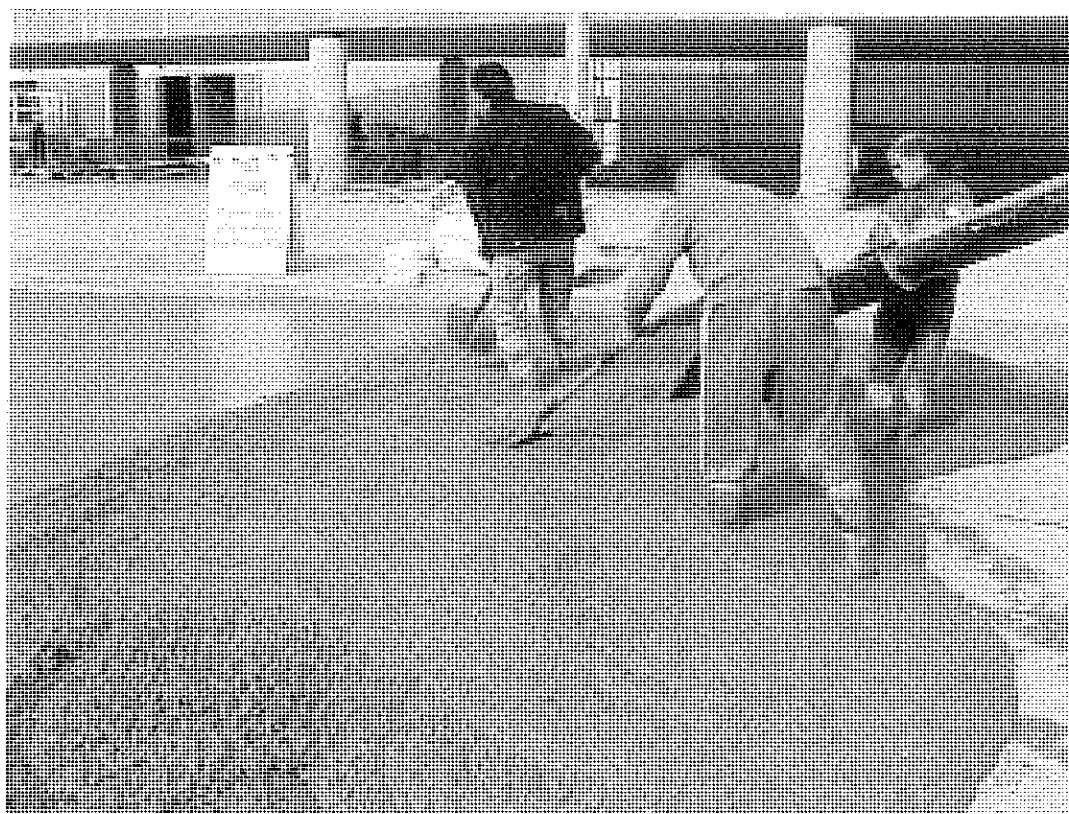
Foto1. Pavimento Tradicional armado con fibras de acero.
