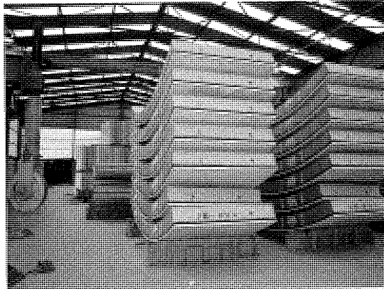
Foto 11. Túnel de Oenzberg. Apilado de dovelas.
