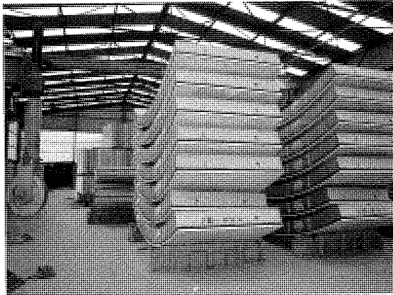
Foto 11. Túnel de Oenzberg. Apilado de dovelas.
