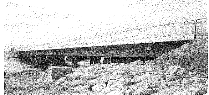
Figuras 11 y 12: Puente sobre el río Guadalete realizado con vigas de HAR tipo H-80.
