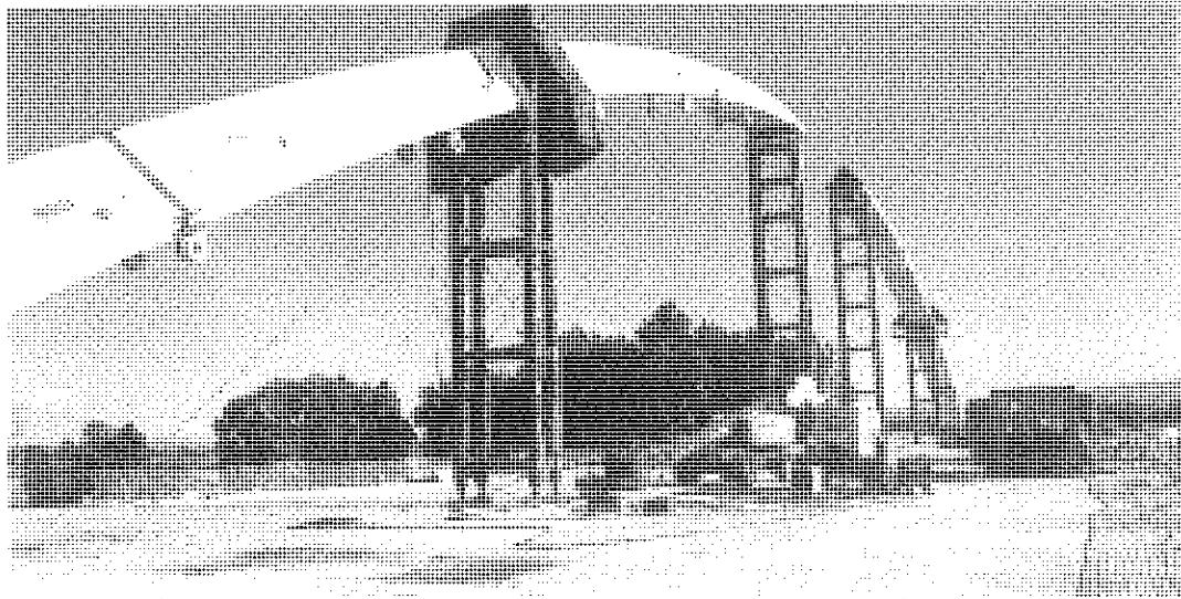
Foto 8. Arco atirantado del Puente del Barrio de las Fuentes.
