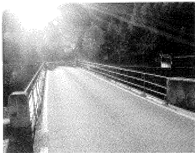
Figura 2. Entrada al puente de Bugia.
