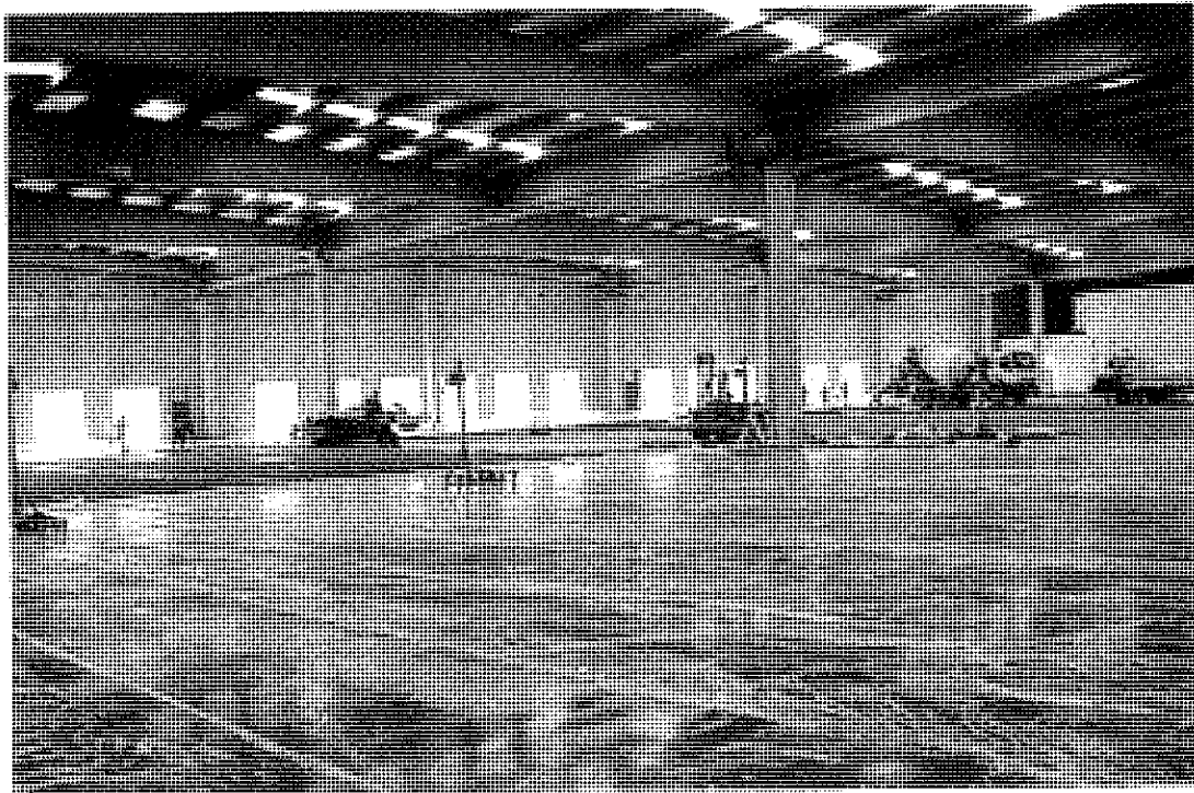
Foto 2. Pavimento sin juntas.
