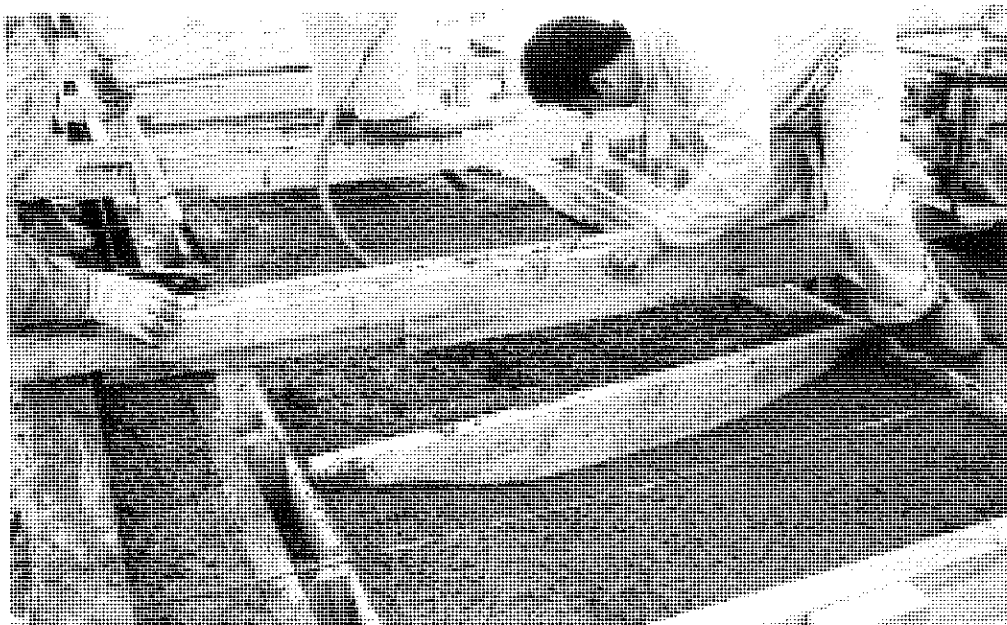
Foto 21. Ejecución Viga placa para paso de trenes. Medina del Campo.
