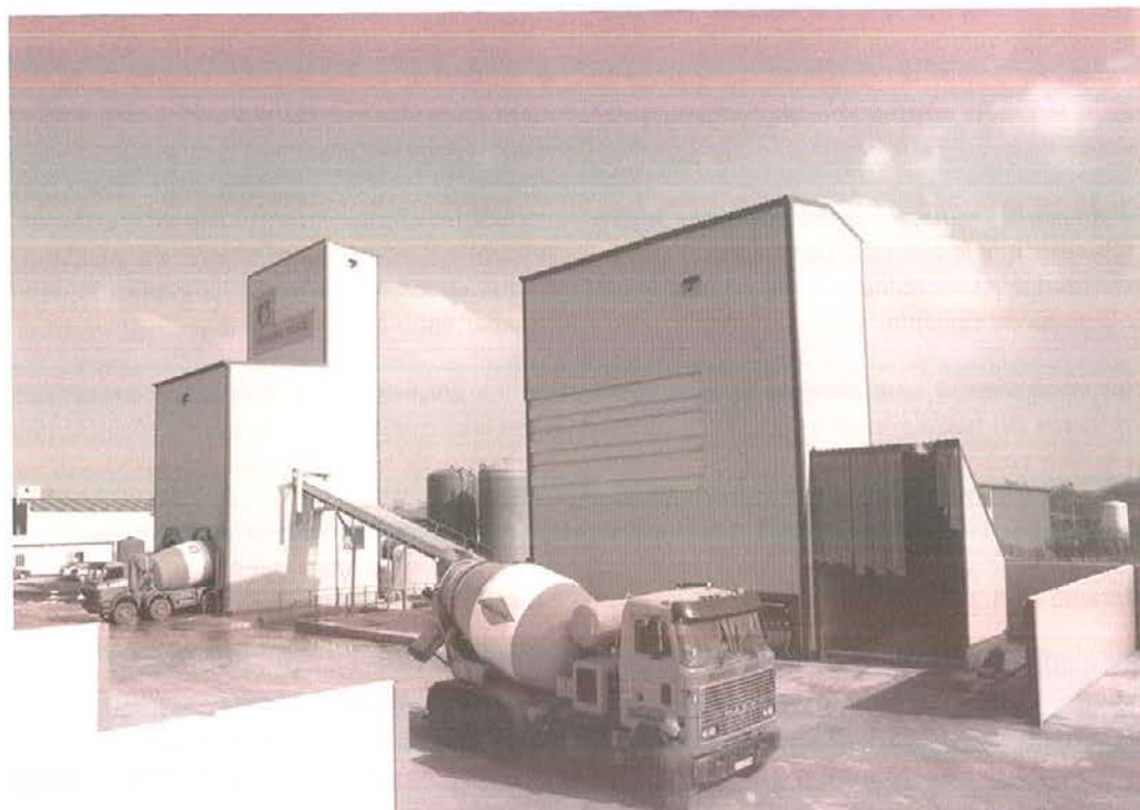
Foto 4: "Planta de fabricación de hormigón".
