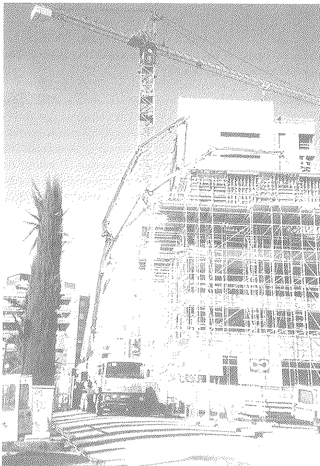
Foto 2. Vista general de la obra.
