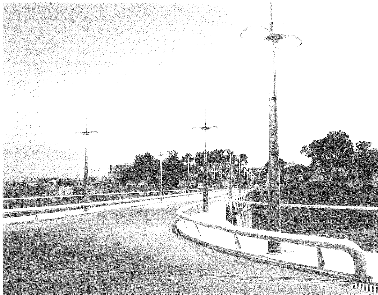
Figura 15. Aspecto final de la ampliación realizada en el puente sobre el barranco del Torrent.
