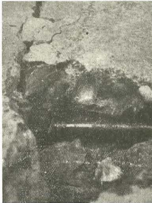
Fig. 11.—Un alambre de la placa S-3 roto después de haber sido sometida la pieza a 2.400.000 repeticiones de carga.
