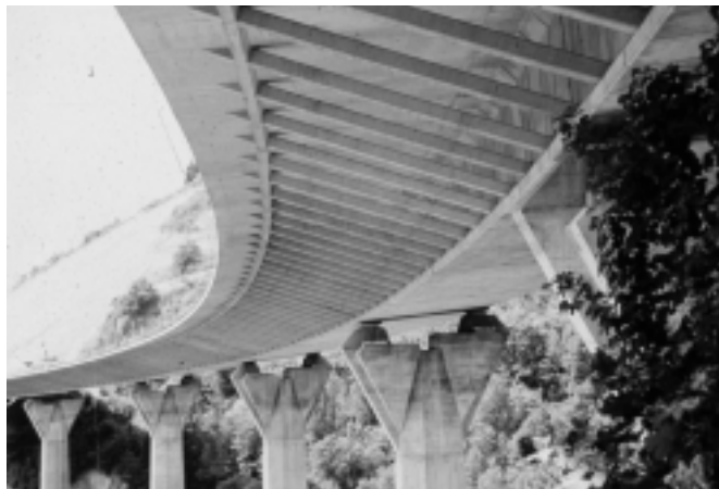
Figura 4. Aspecto final con puntales y vuelos.
