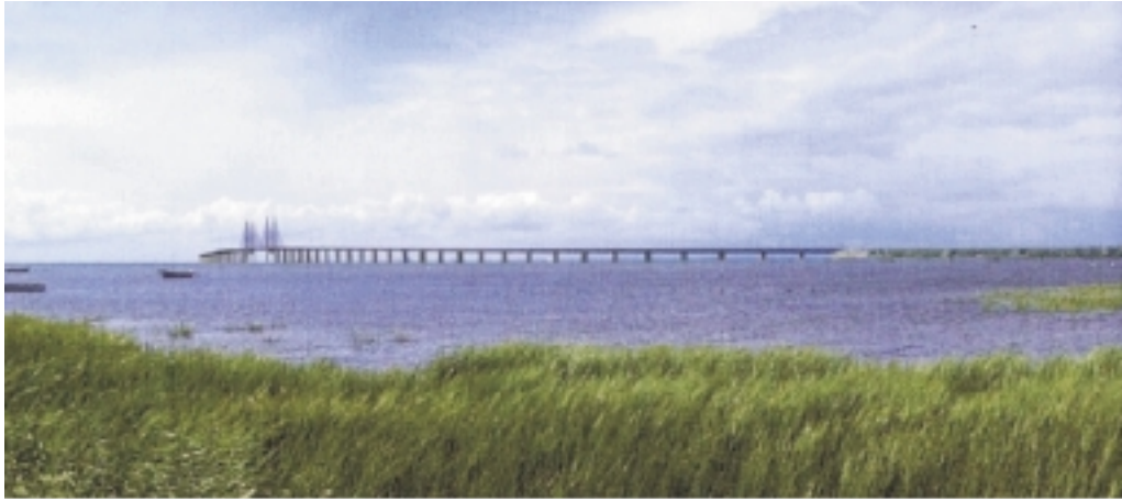
Fig. 5: Vista general del Puente de Öresund, puente principal y vanos de aproximación. Fig. 5: General view of the Öresund Link, main bridge and approach spans.
