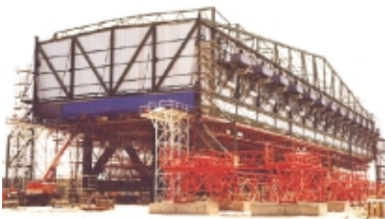
Fig. 11: Detalle de la nave de hormigonado y de las plantas de producción de hormigón. Fig. 11: Detail of the concrete-placing shed and concrete-production plants.
