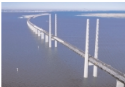
Foto de portada: Puente de Oresund. Vista general del puente central atirantado y del puente de aproximación oeste durante su pavimentación.
