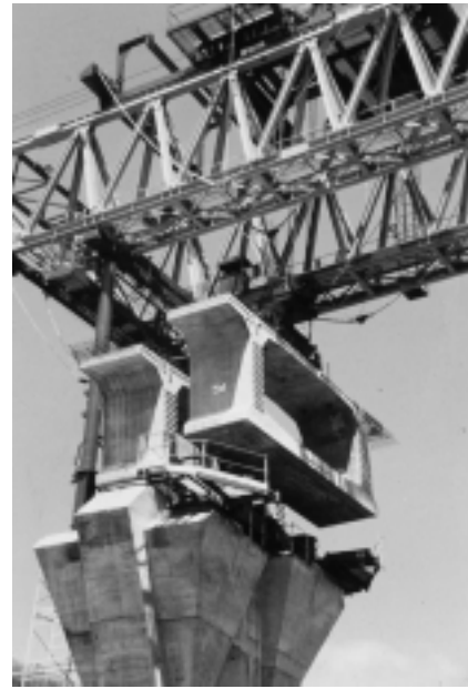
Figura 1. Detalle del montaje de la dovela 1.
