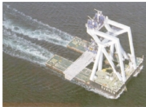
Fig. 31: Transporte de dos tramos sobre la pontona y uno con la grúa Svanen para montaje. Fig. 31: Shipping two sections on the pontoon and moving one with the Svanen crane for assembly.
