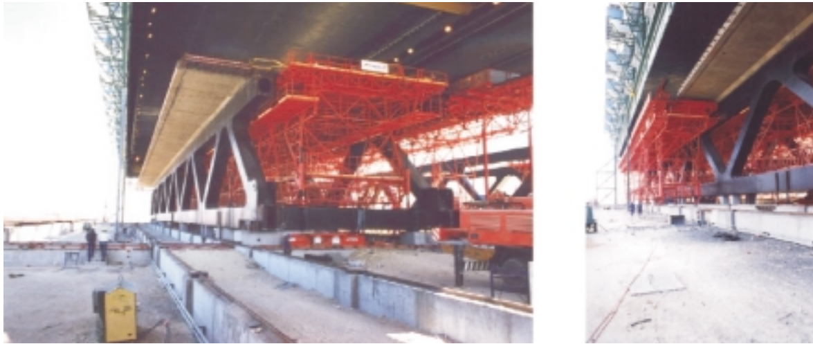
Fig. 12: Detalle de los encofrados interiores y exteriores en la nave de hormigonado. Fig. 12: Detail of the inner and outer formwork in the concrete-planting shed.
