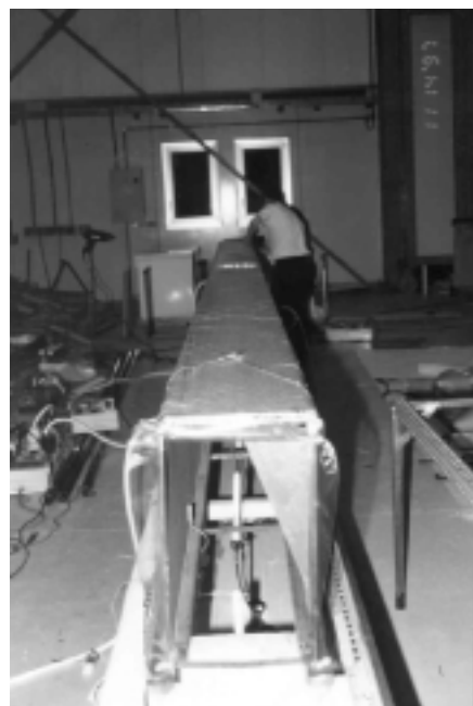
Foto 1. Proceso de curado del encofrado estructural.
