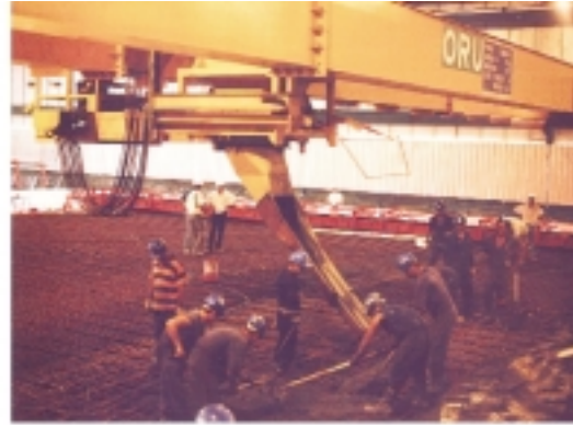
Fig 20: Vista general y de detalle del hormigonado de la losa mediante el puente repartidor. Fig 20: General view and detail of concreting of the slab using the distribution bridge.
