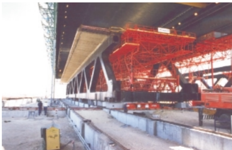
Fig. 12: Detalle de los encofrados interiores y exteriores en la nave de hormigonado. Fig. 12: Detail of the inner and outer formwork in the concrete-placing shed.
