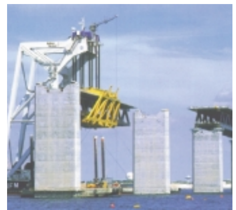
Fig. 32: Dos vistas del montaje de los tableros de aproximación con la grúa Svanen. Fig. 32: Two views of the assembly of the approach decks using the Svanen crane.
