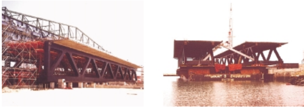
Fig 19: Vista del tramo hormigonado en posición 3 y dos tramos embarcados en la pontona. Fig 19: View of the concreted span at position 3 and two spans embarked on the pontoon.
