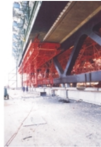
Fig. 12: Detalle de los encofrados interiores y exteriores en la nave de hormigonado. Fig. 12: Detail of the inner and outer formwork in the concrete-planting shed.
