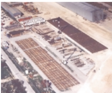
Fig 13: Vista de la zona de montaje de ferralla y pórtico sobre neumáticos para su traslado. Fig 13: View of the reinforcement assembly area and frame crane on tyres used to transport it.
