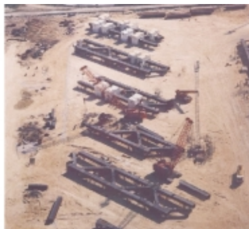
Fig 16: Vista general y detalle de la zona de montaje y ensamblaje de la estructura metálica. Fig 16: General view and detail of the steel-structure assembly area.
