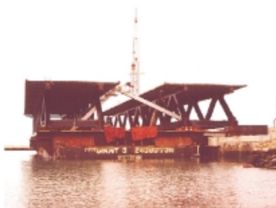
Fig 19: Vista del tramo hormigonado en posición 3 y dos tramos embarcados en la pontona. Fig 19: View of the concreted span at position 3 and two spans embarked on the pontoon.
