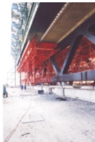
Fig. 12: Detalle de los encofrados interiores y exteriores en la nave de hormigonado. Fig. 12: Detail of the inner and outer formwork in the concrete-placing shed.
