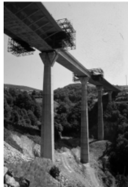
Figura 2. Hormigonado de vuelos.
