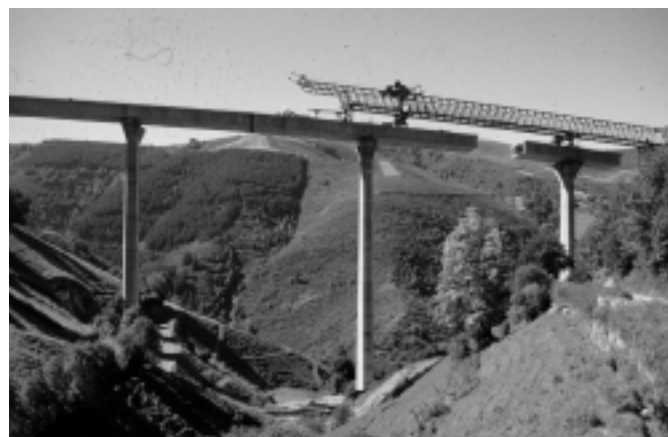
Figura 3. Montaje de dovelas en un voladizo.
