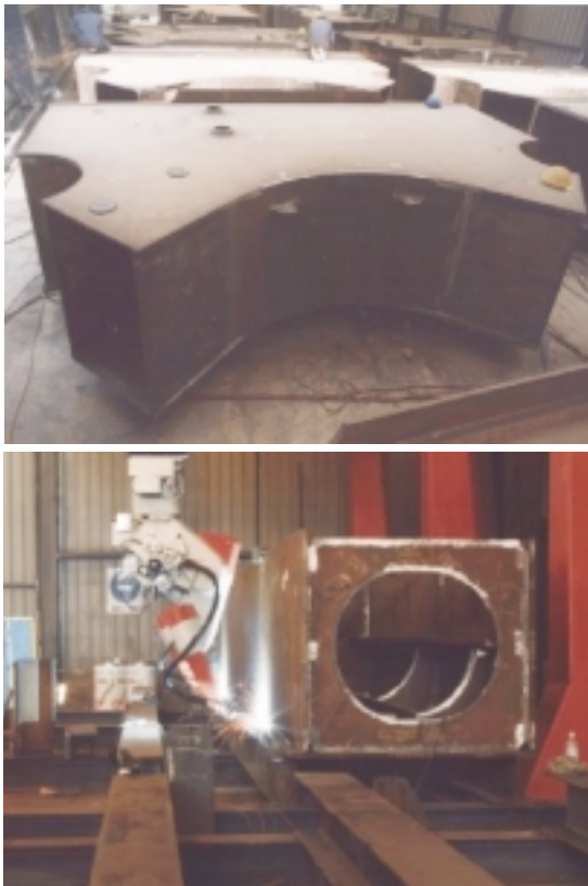
Fig. 15: Prefabricación en taller de componentes metálicos elementales: nudos y barras. Fig. 15: Workshop prefabrication of basic steel components: joints and bars.
