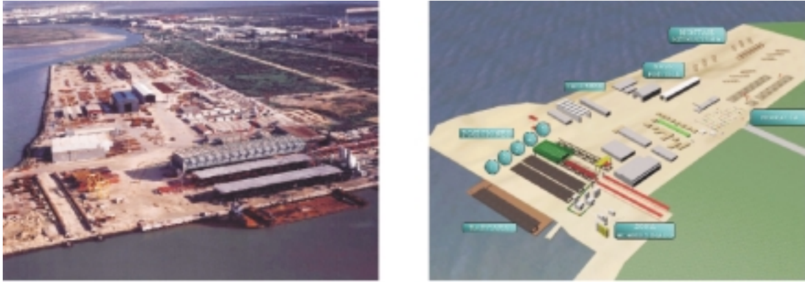
Fig. 9: Vista y esquema de las instalaciones de fabricación de los tableros de aproximación. Fig. 9: View and diagram of the approach-spans manufacturing facilities.
