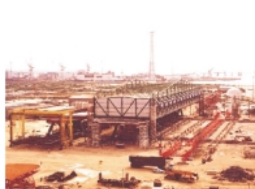
Fig 18: Vista de la estructura metálica en posición 5 y montaje de la ferralla sobre tablero. Fig 18: View of the steel structure at position 5 and assembly of reinforcement on the slab.
