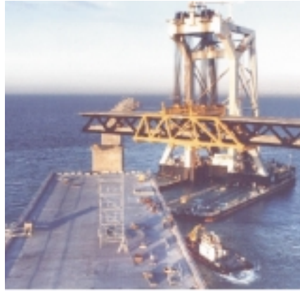
Fig. 32: Dos vistas del montaje de los tableros de aproximación con la grúa Svanen. Fig. 32: Two views of the assembly of the approach decks using the Svanen crane.
