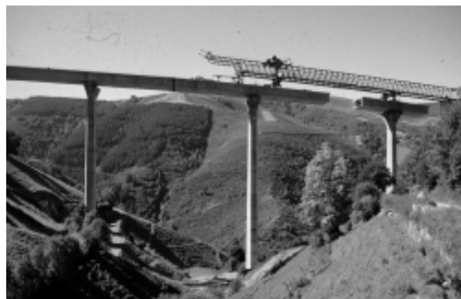
Figura 3. Montaje de dovelas en un voladizo.
