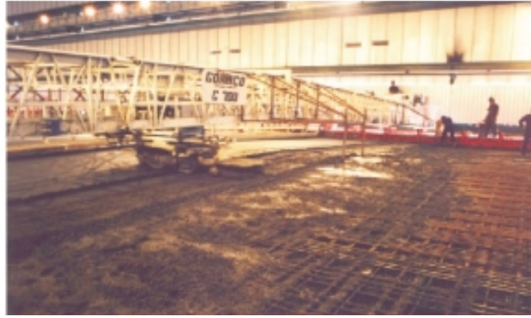
Fig. 14: Detalle de la vagoneta de hormigonado y de la máquina de acabado. Fig. 14: Detail of the concrete skip and finishing machine.
