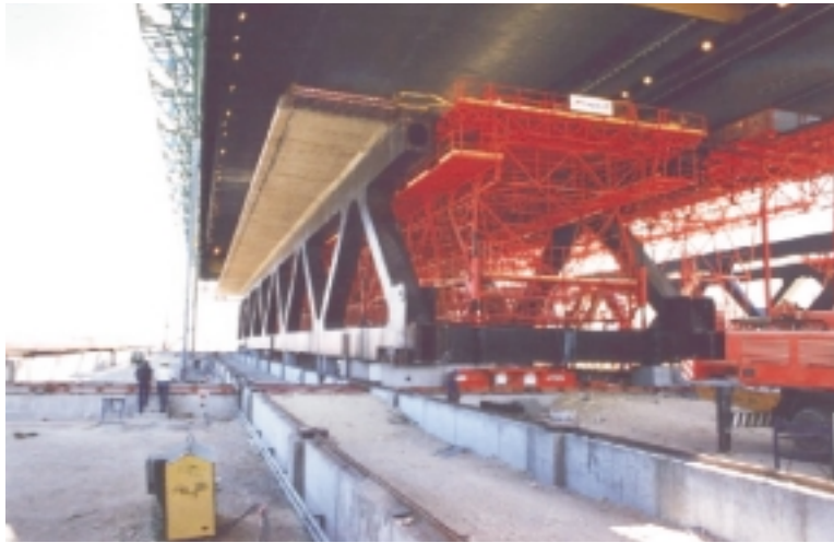
Fig. 12: Detalle de los encofrados interiores y exteriores en la nave de hormigonado. Fig. 12: Detail of the inner and outer formwork in the concrete-planting shed.
