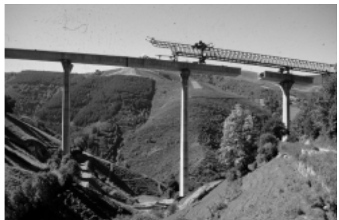
Figura 3. Montaje de dovelas en un voladizo.
