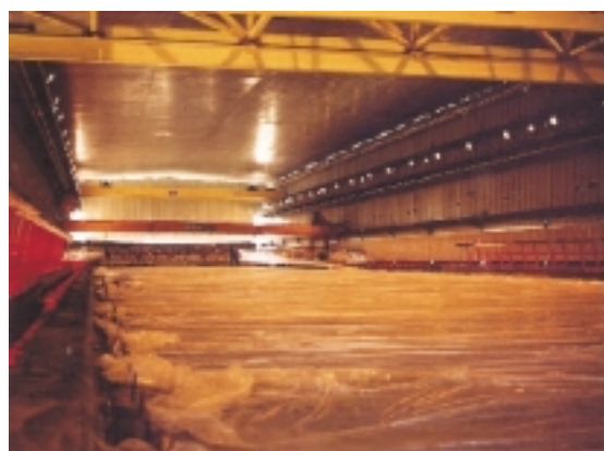
Fig 21: Vistas de la losa terminada después del hormigonado con y sin la protección. Fig 21: Views of the finished slab after concreting with and without protection.
