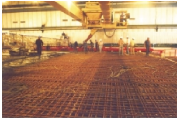
Fig 20: Vista general y de detalle del hormigonado de la losa mediante el puente repartidor. Fig 20: General view and detail of concreting of the slab using the distribution bridge.
