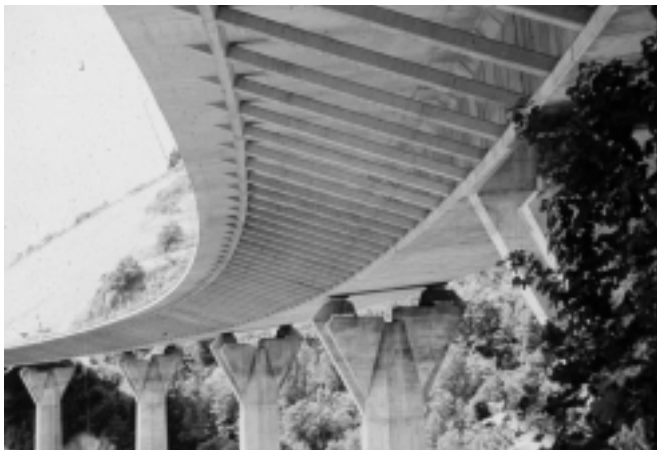
Figura 4. Aspecto final con puntales y vuelos.
