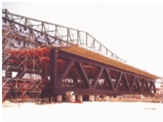
Fig 19: Vista del tramo hormigonado en posición 3 y dos tramos embarcados en la pontona. Fig 19: View of the concreted span at position 3 and two spans embarked on the pontoon.
