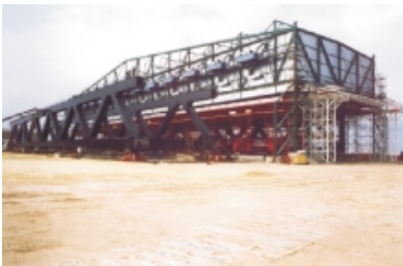
Fig 18: Vista de la estructura metálica en posición 5 y montaje de la ferralla sobre tablero. Fig 18: View of the steel structure at position 5 and assembly of reinforcement on the slab.
