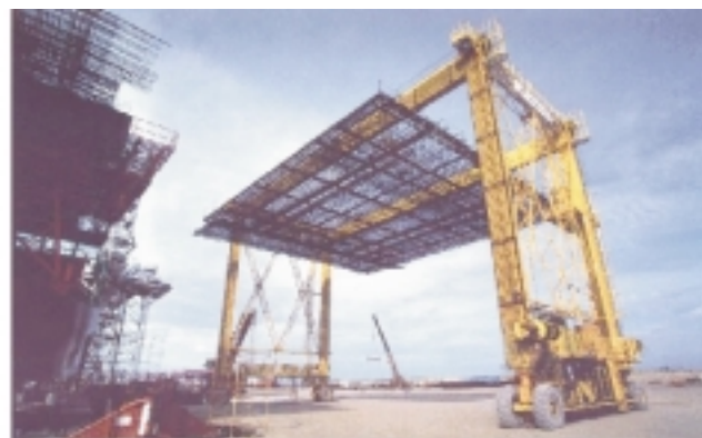
Fig 13: Vista de la zona de montaje de ferralla y pórtico sobre neumáticos para su traslado. Fig 13: View of the reinforcement assembly area and frame crane on tyres used to transport it.
