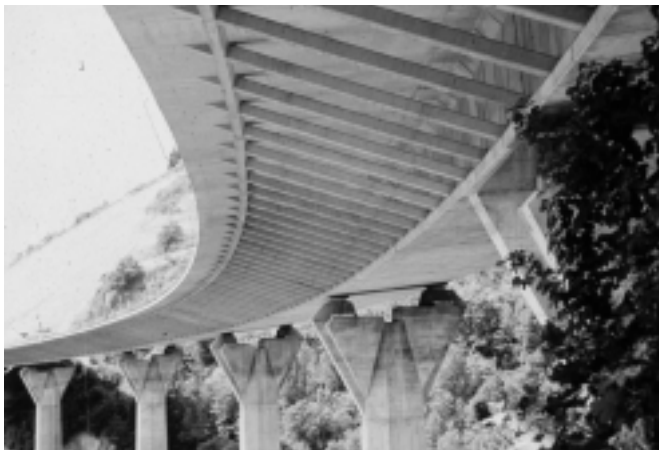
Figura 4. Aspecto final con puntales y vuelos.
