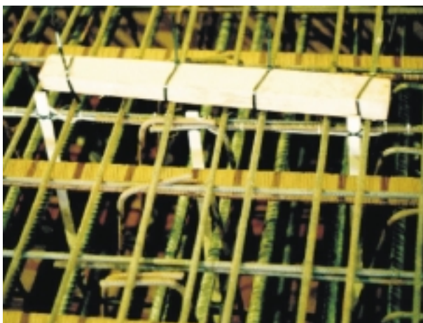
Fig. 30: Sensores de temperatura colocados en el tablero y pantalla de control de temperatura. Fig. 30: Temperature sensors placed on the deck slab and temperature-control display.
