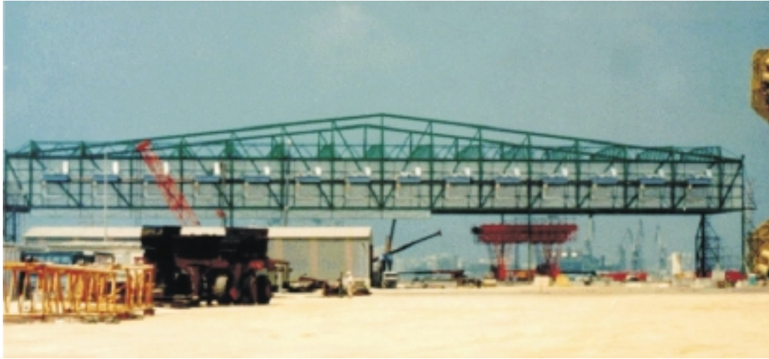
Fig. 28: Vista general de la nave de hormigonado con el sistema de aire acondicionado. Fig. 28: General view of the concrete-placing shed with the air-conditioning system.
