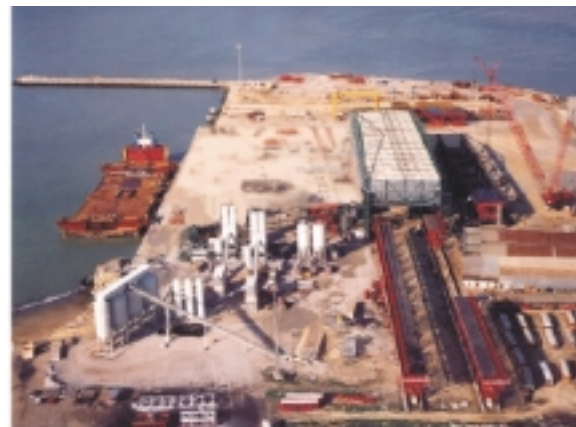
Fig. 10: Vistas generales de las instalaciones de hormigonado y embarque de los tableros. Fig. 10: General views of the concrete facilities and embarking of the spans.
