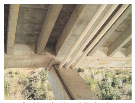
Figura 19. Detalle de la zona de apoyo del tablero sobre las pilas. Pueden apreciarse los tres tubos de atirantamiento transversal.
