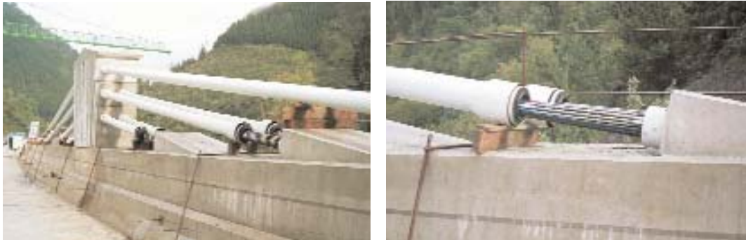
Figura 16. Abertura de los tendones de pretensado extradosado. En la imagen de la derecha puede observarse la zona en que se ha eliminado provisionalmente la protección individual de los cordones, a fin de situar las bandas extensométricas para control de tensiones durante el proceso de tesado.
