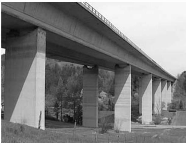
Figura 6. Vista del puente de Warth.
