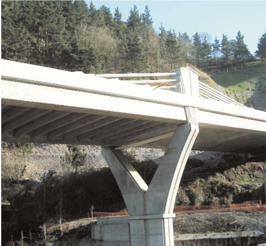
Figura 18. Aspecto de una de las pilas. Figure 18. Appearance of one of the piers.
