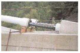
Figura 16. Abertura de los tendones de pretensado extradosado. En la imagen de la derecha puede observarse la zona en que se ha eliminado provisionalmente la protección individual de los cordones, a fin de situar las bandas extensométricas para control de tensiones durante el proceso de tesado.
