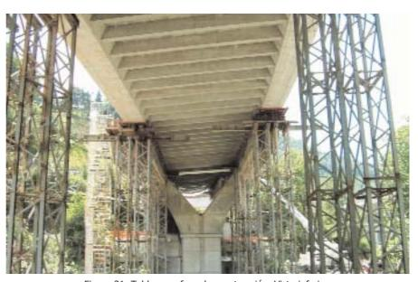
Figura 21. Tablero en fase de construcción. Vista inferior. Figure 21. Deck in the construction phase. Bottom view.
