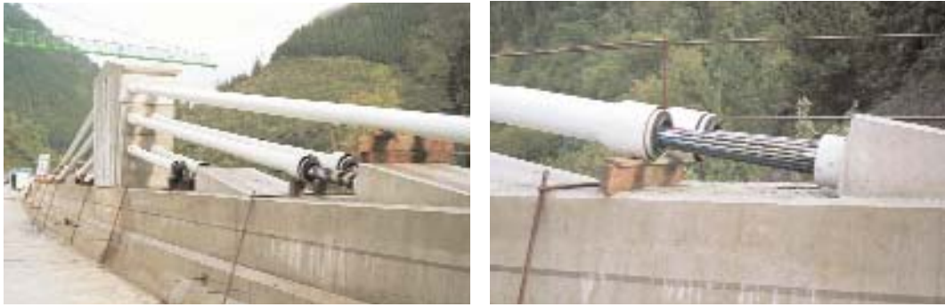
Figura 16. Abertura de los tendones de pretensado extradosado. En la imagen de la derecha puede observarse la zona en que se ha eliminado provisionalmente la protección individual de los cordones, a fin de situar las bandas extensométricas para control de tensiones durante el proceso de tesado.
