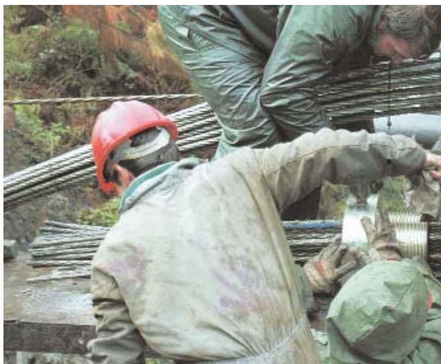
Figura 17. Anclajes de pretensado provistos de rosca. Montaje de una cabeza de anclaje, tras el enfilado de cordones. Figure 17. Threaded prestressing anchorages. Fitting an anchor head behind the strand run.
