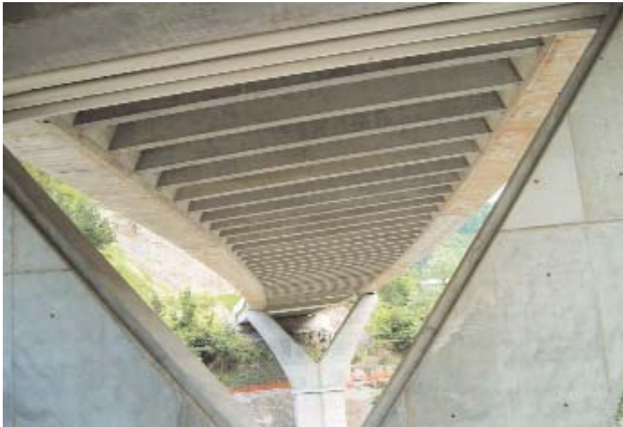
Figura 12. Aspecto del tablero, visto por la parte inferior. Figure 12. Appearance of the deck, seen from underneath.
