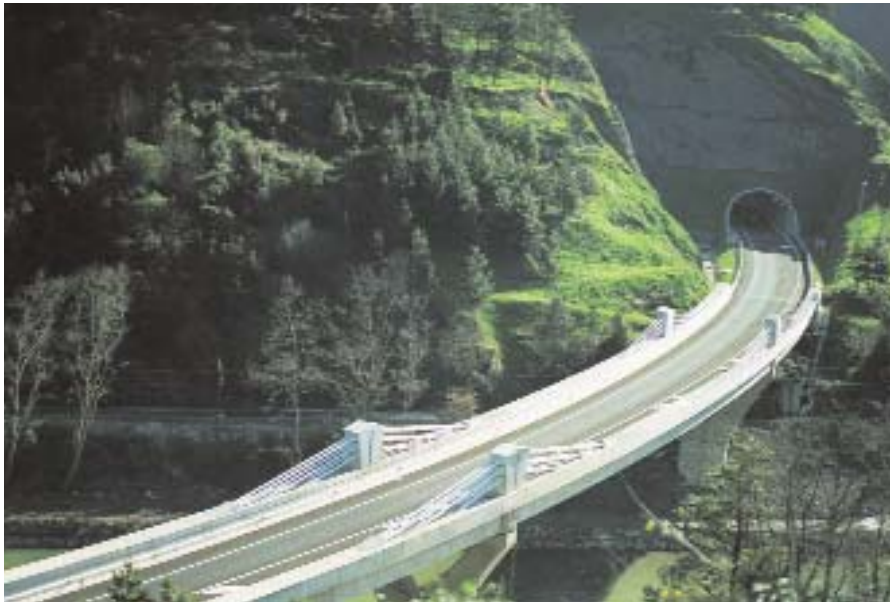
Figura 8. Tablero del Puente sobre el río Deba. Vista superior. Puede apreciarse la disposición de los pilonos, que soportan el pretensado extradosado y la forma de los nervios longitudinales, que sirven de protección exterior de la calzada.
