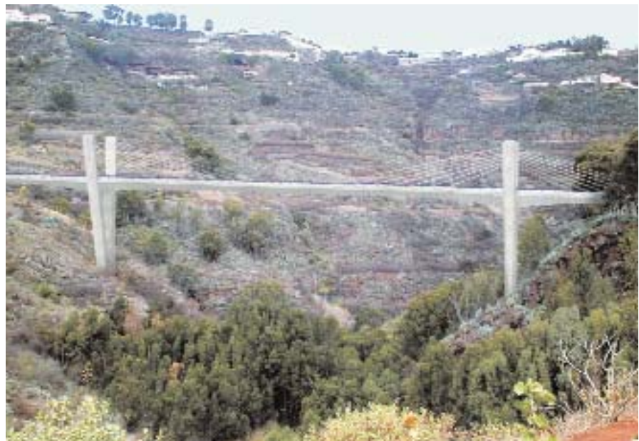
Figura 6. Puente de Teror. Atirantado extradosado. Figura 6. Teror Bridge. Extradosed cable stayed bridge.
