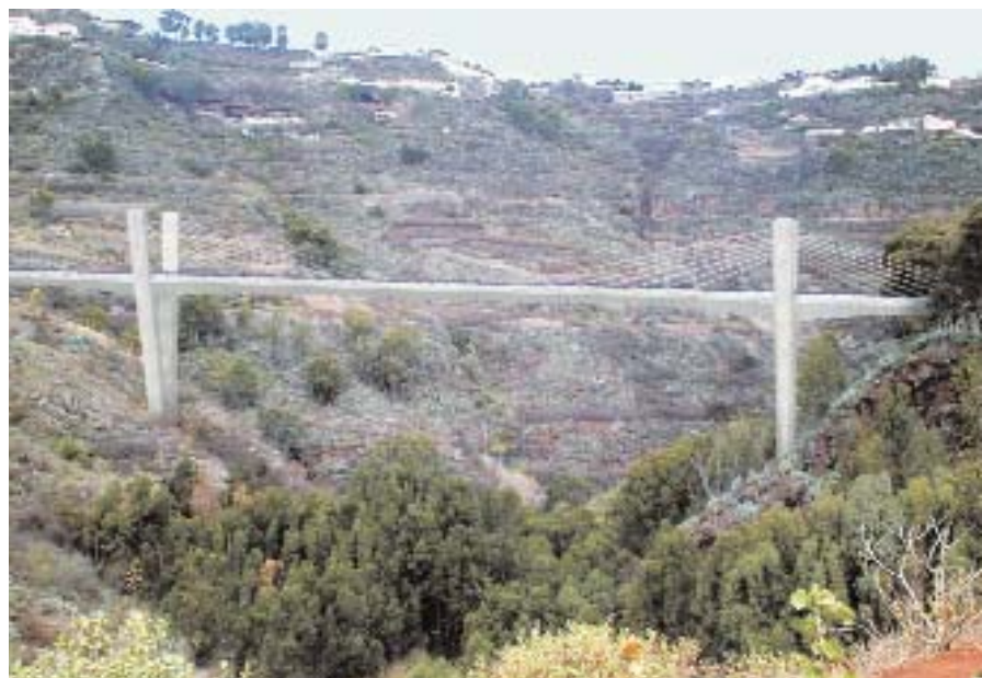
Figura 6. Puente de Teror. Atirantado extradosado. Figura 6. Teror Bridge. Extradosed cable stayed bridge.
