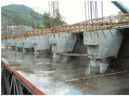
Figura 10. Vigas prefabricadas transversales, colocadas sobre el encofrado inferior de los nervios longitudinales. En una fase de construcción posterior, el extremo de las vigas quedará en el interior de la masa de hormigón de los nervios longitudinales.
