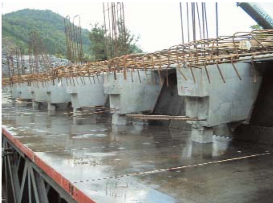
Figura 10. Vigas prefabricadas transversales, colocadas sobre el encofrado inferior de los nervios longitudinales. En una fase de construcción posterior, el extremo de las vigas quedará en el interior de la masa de hormigón de los nervios longitudinales. Figure 10. Prefabricated cross beams placed on the bottom formwork of the longitudinal ribs. The end of the beams will remain inside the longitudinal ribs' concrete mass in a subsequent construction phase.
