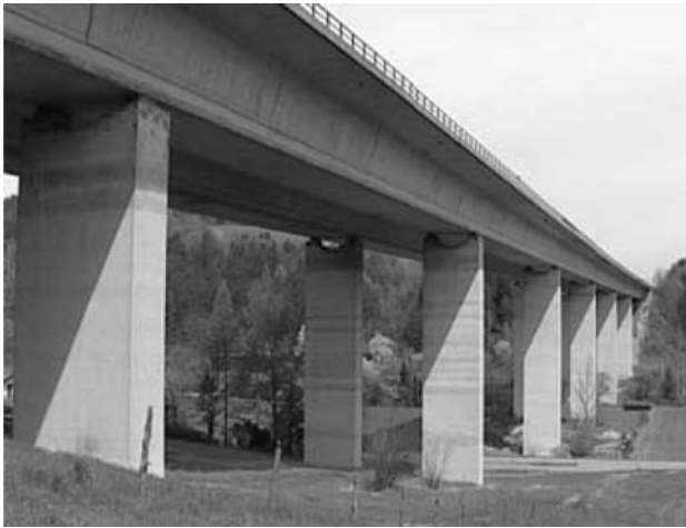
Figura 6. Vista del puente de Warth.
