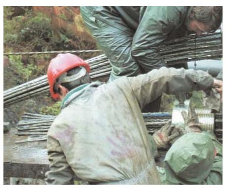
Figura 17. Anclajes de pretensado provistos de rosca.
