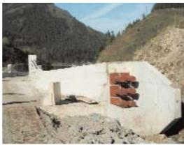
Figura 13. Anclajes de pretensado en un extremo del tablero. En la imagen de la izquierda, con el conjunto de tendones en fase de tesado. En la imagen de la derecha, protección exterior de los anclajes de pretensado extradosado.
