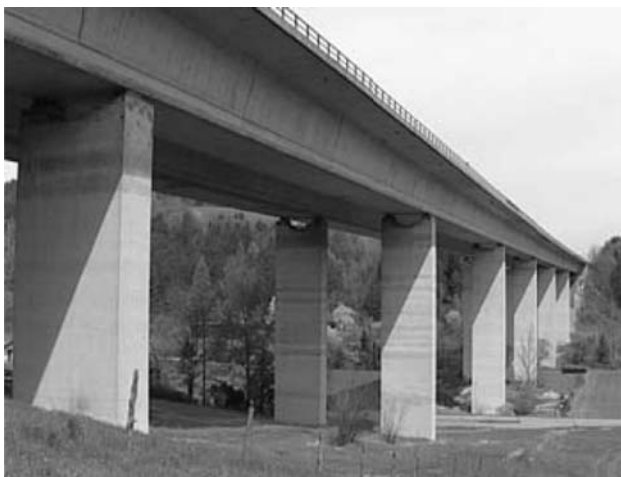
Figura 6. Vista del puente de Warth.
