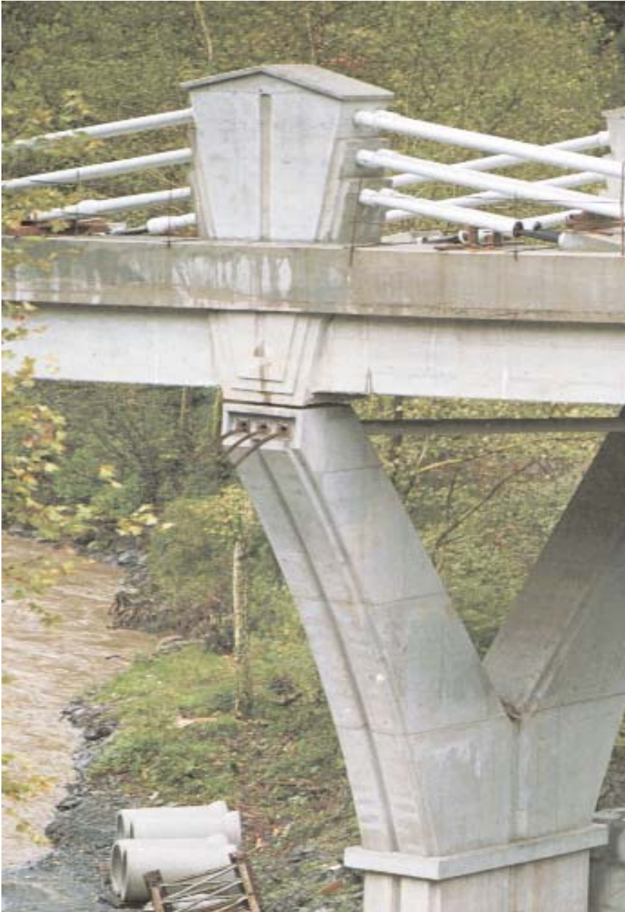
Figura 20. Detalle de la zona superior de una pila en proceso de construcción. Pueden apreciarse los extremos salientes de los tendones, que discurren por el interior de los tubos metálicos
