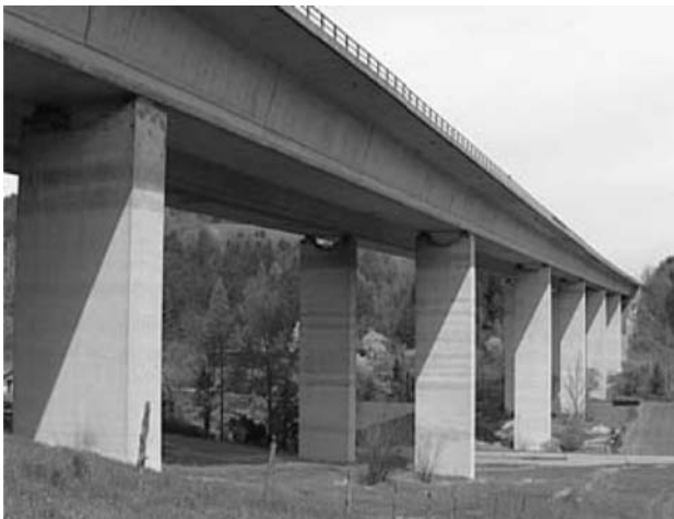
Figura 6. Vista del puente de Warth.
